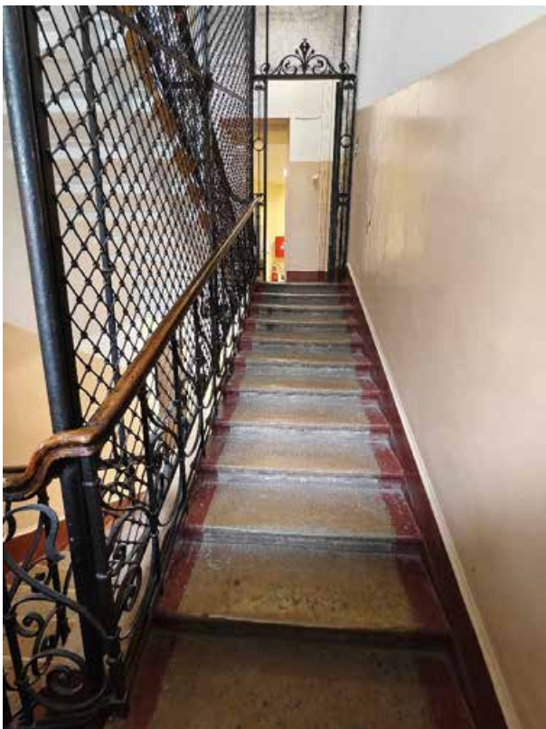
49. «Дом Жилой» (в составе «Дом фан Гильзе фан дер Пальса Г.Г.»), Английский пр., д. 8-10. Лестница восточной части. Общий вид. Фото 05.05.2025г.
