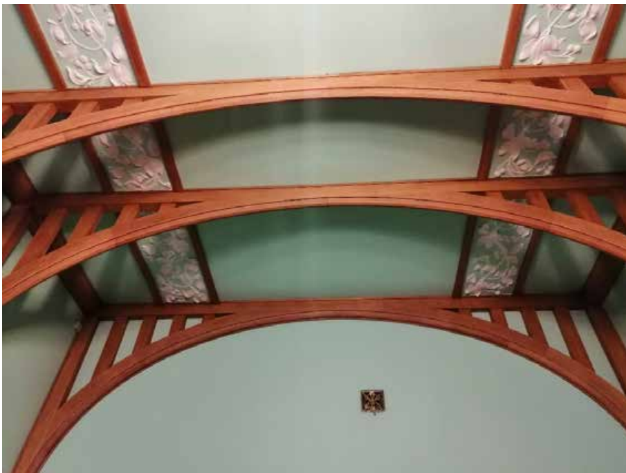
151. «Дом Жилой» (в составе «Дом фан Гильзе фан дер Пальса Г.Г.»), Английский пр., д. 8-10. Второй этаж. Помещение №58. Фрагмент. Фото 05.05.2025г.
