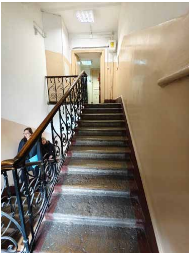
64. «Дом Жилой» (в составе «Дом фан Гильзе фан дер Пальса Г.Г.»), Английский пр., д. 8-10. Лестница восточной части. Общий вид. Фото 05.05.2025г.
