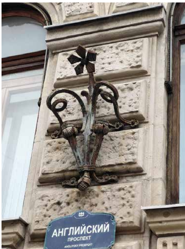
15. «Дом Жилой» (в составе «Дом фан Гильзе фан дер Пальса Г.Г.»), Английский пр., д. 8-10. Западный фасад. Фрагмент. Фото 05.05.2025г.
