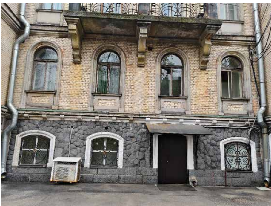
20. «Дом Жилой» (в составе «Дом фан Гильзе фан дер Пальса Г.Г.»), Английский пр., д. 8-10. Северный фасад. Фрагмент. Фото 05.05.2025г.
