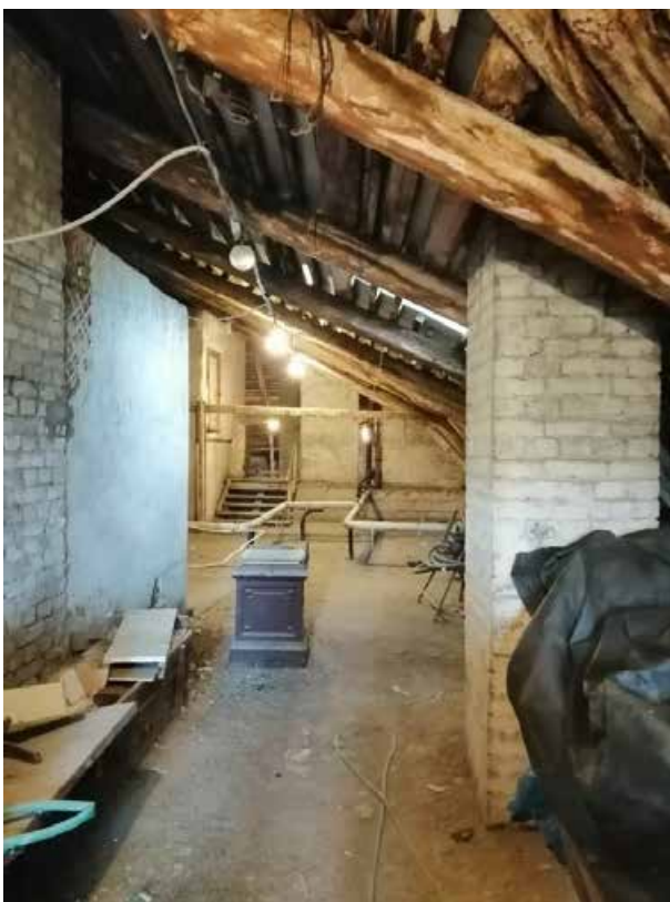
210. «Дом Жилой» (в составе «Дом фан Гильзе фан дер Пальса Г.Г.»), Английский пр., д. 8-10. Третий этаж. Чердак. Общий вид. Фото 05.05.2025г.
