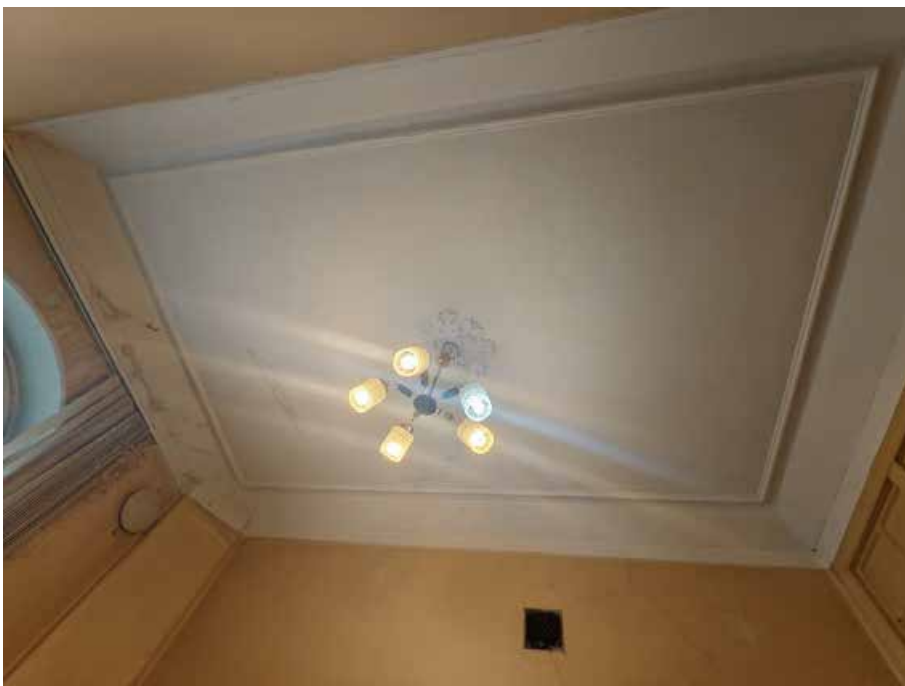
186. «Дом Жилой» (в составе «Дом фан Гильзе фан дер Пальса Г.Г.»), Английский пр., д. 8-10. Третий этаж. Помещение №96. Фрагмент. Фото 05.05.2025г.
