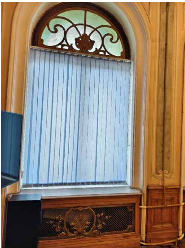
117. «Дом Жилой» (в составе «Дом фан Гильзе фан дер Пальса Г.Г.»), Английский пр., д. 8-10. Второй этаж. Помещение №56. Фрагмент. Фото 05.05.2025г.
