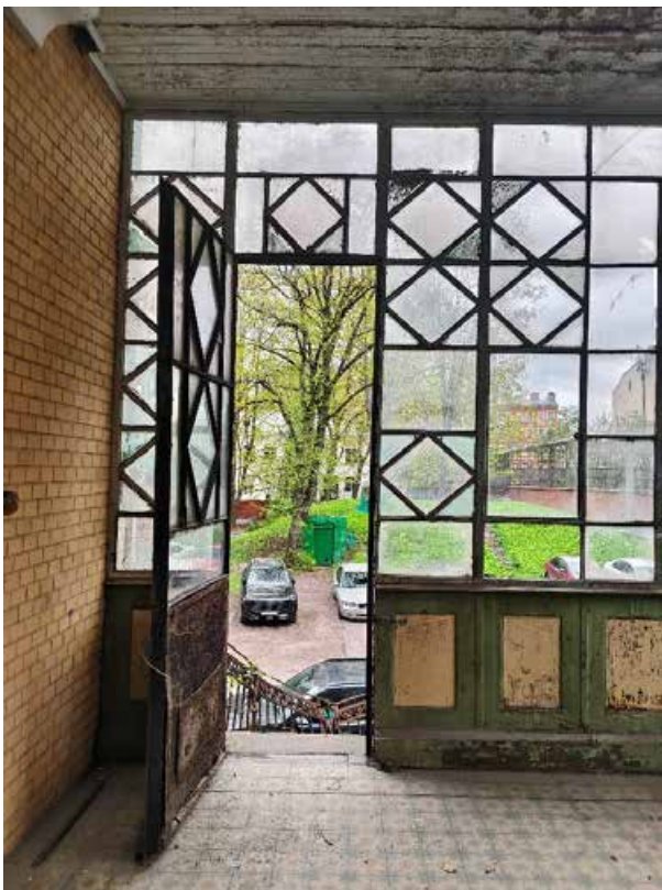
144. «Дом Жилой» (в составе «Дом фан Гильзе фан дер Пальса Г.Г.»), Английский пр., д. 8-10. Зимний сад. Помещение №68. Фрагмент. Фото 05.05.2025г.
