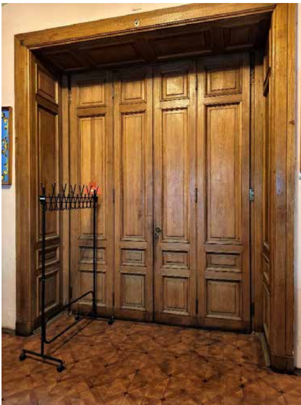
108. «Дом Жилой» (в составе «Дом фан Гильзе фан дер Пальса Г.Г.»), Английский пр., д. 8-10. Второй этаж. Помещение №64. Фрагмент. Фото 05.05.2025г.
