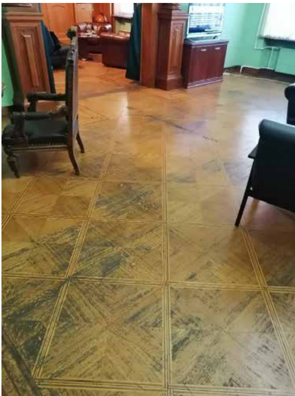
162. «Дом Жилой» (в составе «Дом фан Гильзе фан дер Пальса Г.Г.»), Английский пр., д. 8-10. Второй этаж. Помещение №57. Фрагмент. Фото 05.05.2025г.
