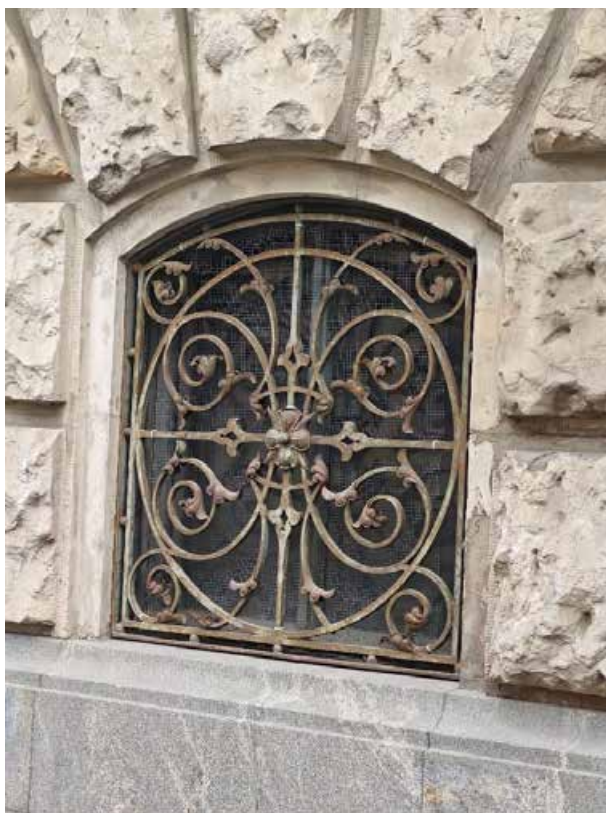
16. «Дом Жилой» (в составе «Дом фан Гильзе фан дер Пальса Г.Г.»), Английский пр., д. 8-10. Западный фасад. Фрагмент. Фото 05.05.2025г.
