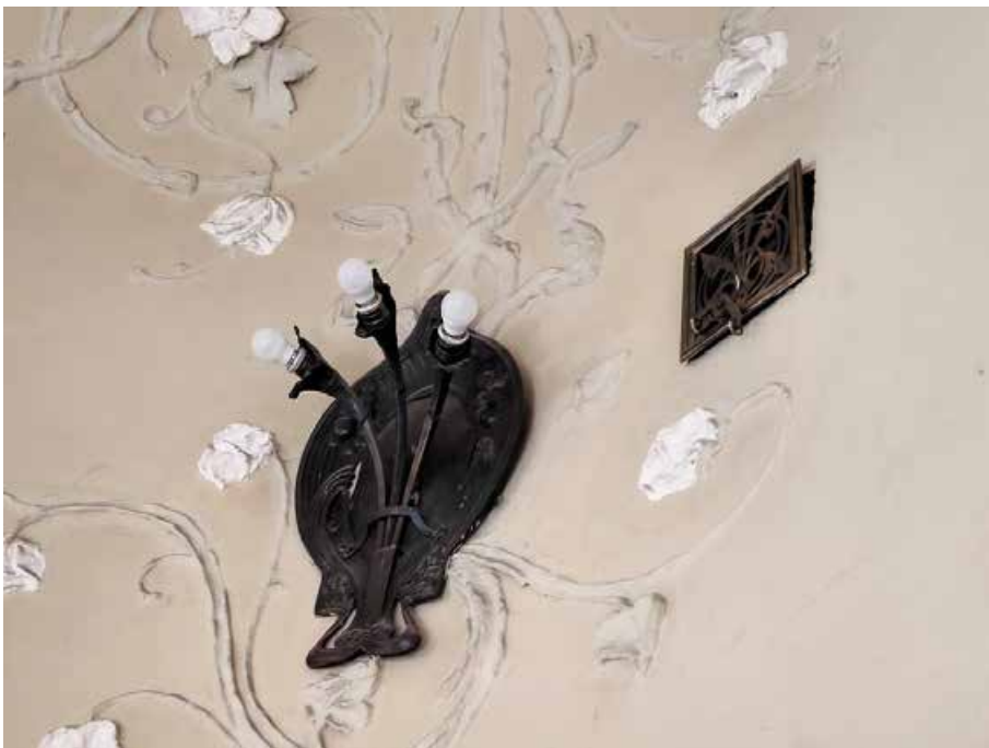
93. «Дом Жилой» (в составе «Дом фан Гильзе фан дер Пальса Г.Г.»), Английский пр., д. 8-10. Второй этаж. Помещение №55. Фрагмент. Фото 05.05.2025г.
