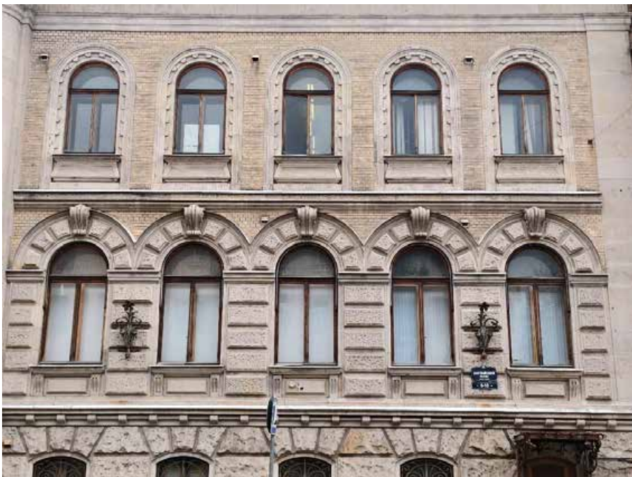
13. «Дом Жилой» (в составе «Дом фан Гильзе фан дер Пальса Г.Г.»), Английский пр., д. 8-10. Западный фасад. Фрагмент. Фото 05.05.2025г.
