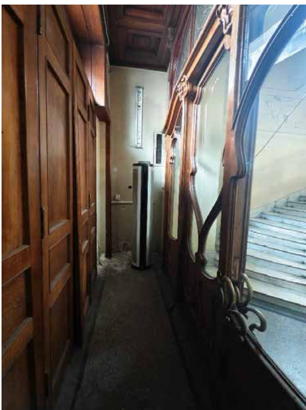
100. «Дом Жилой» (в составе «Дом фан Гильзе фан дер Пальса Г.Г.»), Английский пр., д. 8-10. Второй этаж. Помещение №55. Фрагмент. Фото 05.05.2025г.
