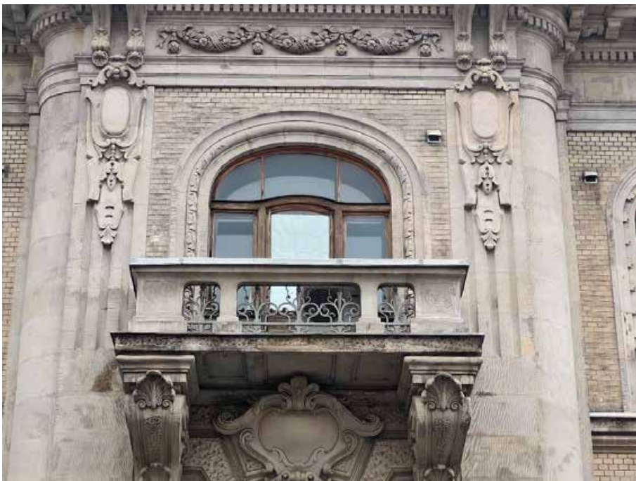
9. «Дом Жилой» (в составе «Дом фан Гильзе фан дер Пальса Г.Г.»), Английский пр., д. 8-10. Западный фасад. Фрагмент. Фото 05.05.2025г.
