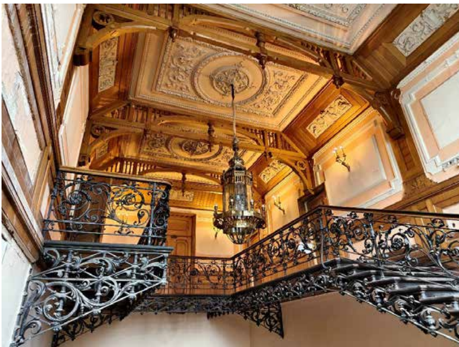
74. «Дом Жилой» (в составе «Дом фан Гильзе фан дер Пальса Г.Г.»), Английский пр., д. 8-10. Второй этаж. Помещение №65. Фрагмент. Фото 05.05.2025г.
