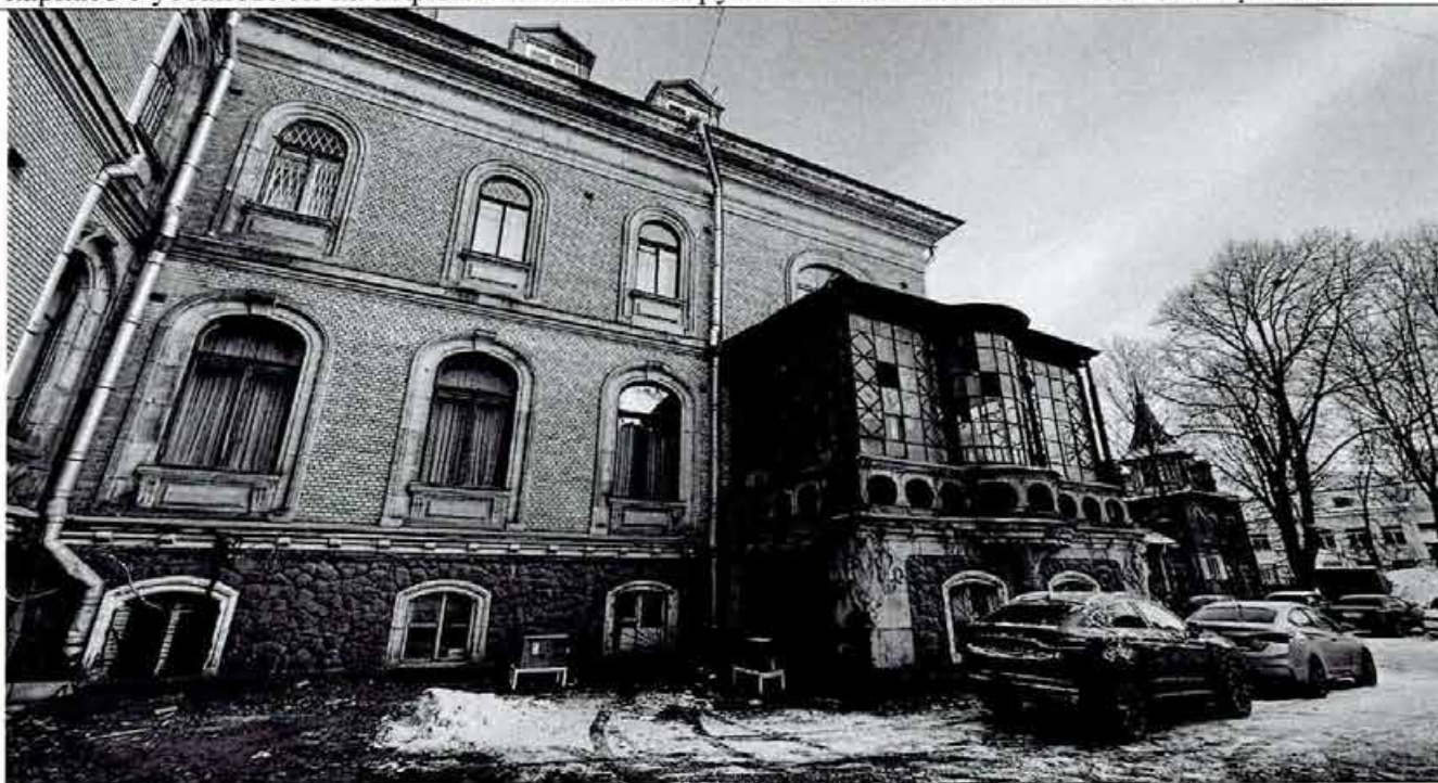
9. Фрагмент дворового фасада. На дворовом фасаде в уровне цокольного - 1-го этажей и на каркасе с установкой на асфальт имеются 4 наружных блока системы кондиционирования
