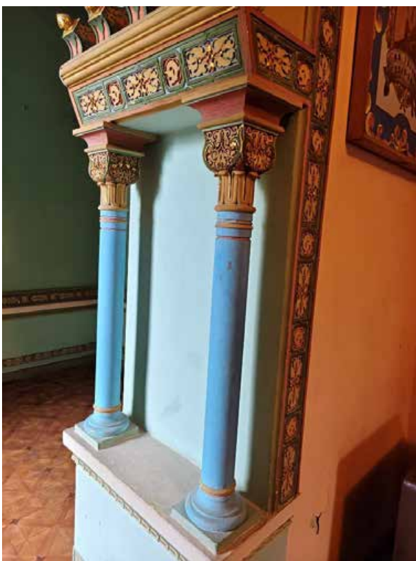
106. «Дом Жилой» (в составе «Дом фан Гильзе фан дер Пальса Г.Г.»), Английский пр., д. 8-10. Второй этаж. Помещение №64. Фрагмент. Фото 05.05.2025г.
