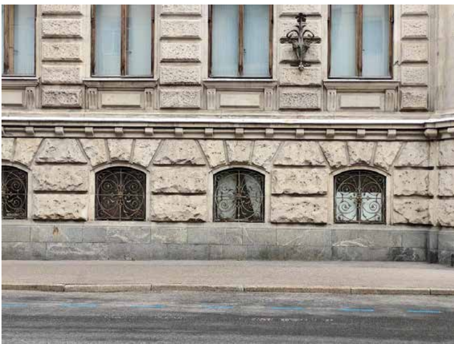
6. «Дом Жилой» (в составе «Дом фан Гильзе фан дер Пальса Г.Г.»), Английский пр., д. 8-10. Западный фасад. Фрагмент. Фото 05.05.2025г.
