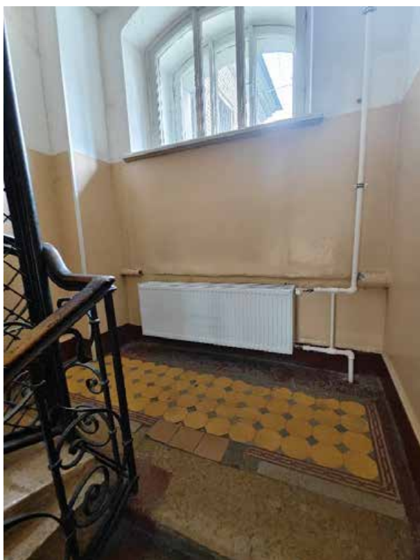
48. «Дом Жилой» (в составе «Дом фан Гильзе фан дер Пальса Г.Г.»), Английский пр., д. 8-10. Лестница восточной части. Общий вид. Фото 05.05.2025г.
