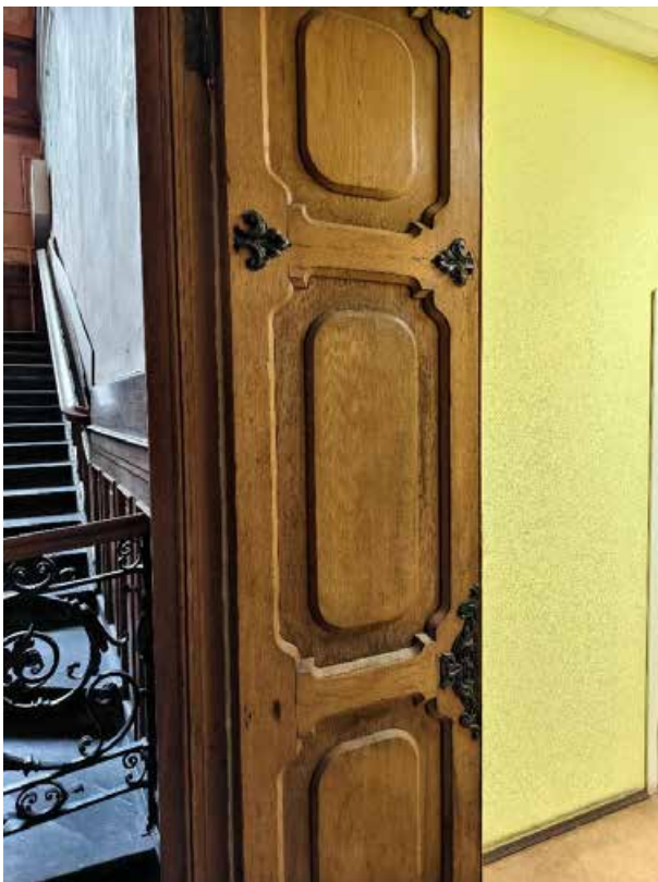
83. «Дом Жилой» (в составе «Дом фан Гильзе фан дер Пальса Г.Г.»), Английский пр., д. 8-10. Второй этаж. Помещение №65. Фрагмент. Фото 05.05.2025г.
