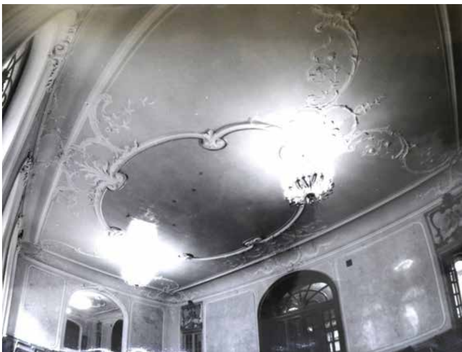
112. То же. Актный зал (ранее - Зал). Общий вид. Фото С.А. Шмидта. 1991 г. Сектор хранения документированной информации КГИОП (инв. №529/11).
