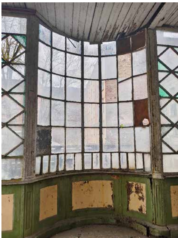
141. «Дом Жилой» (в составе «Дом фан Гильзе фан дер Пальса Г.Г.»), Английский пр., д. 8-10. Зимний сад. Помещение №68. Фрагмент. Фото 05.05.2025г.
