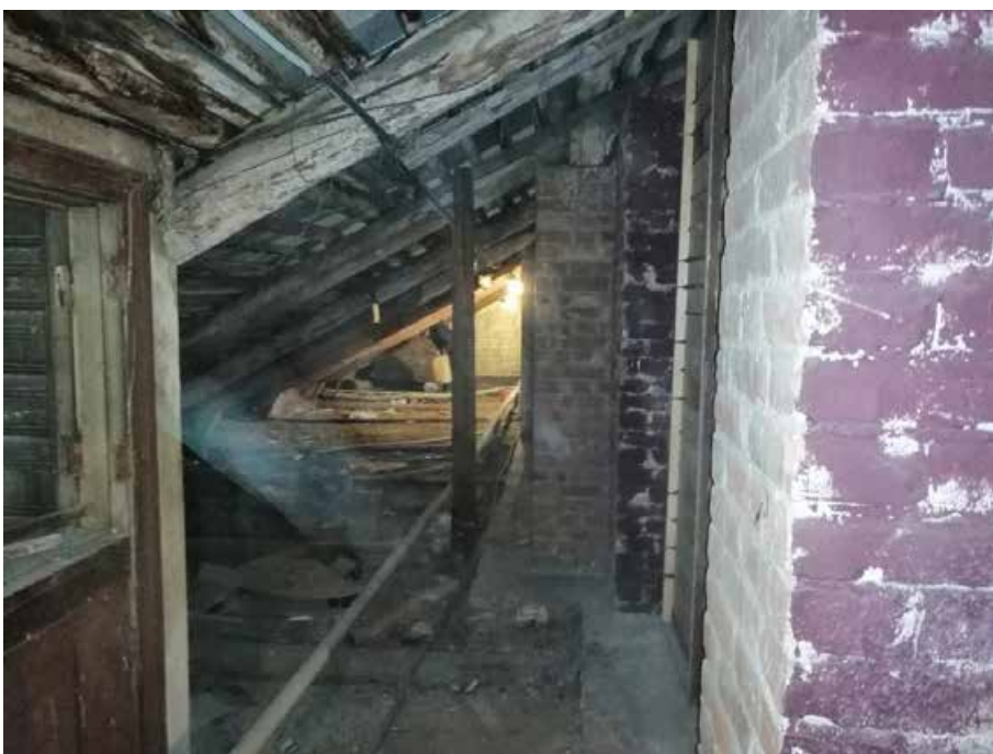
208. «Дом Жилой» (в составе «Дом фан Гильзе фан дер Пальса Г.Г.»), Английский пр., д. 8-10. Третий этаж. Чердак. Общий вид. Фото 05.05.2025г.
