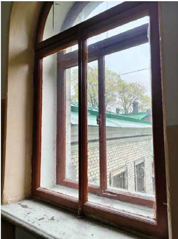
55. «Дом Жилой» (в составе «Дом фан Гильзе фан дер Пальса Г.Г.»), Английский пр., д. 8-10. Лестница восточной части. Фрагмент. Фото 05.05.2025г.
