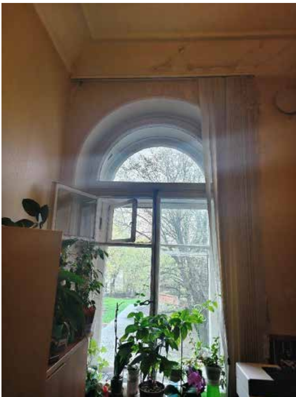
185. «Дом Жилой» (в составе «Дом фан Гильзе фан дер Пальса Г.Г.»), Английский пр., д. 8-10. Третий этаж. Помещение №96. Общий вид. Фото 05.05.2025г.
