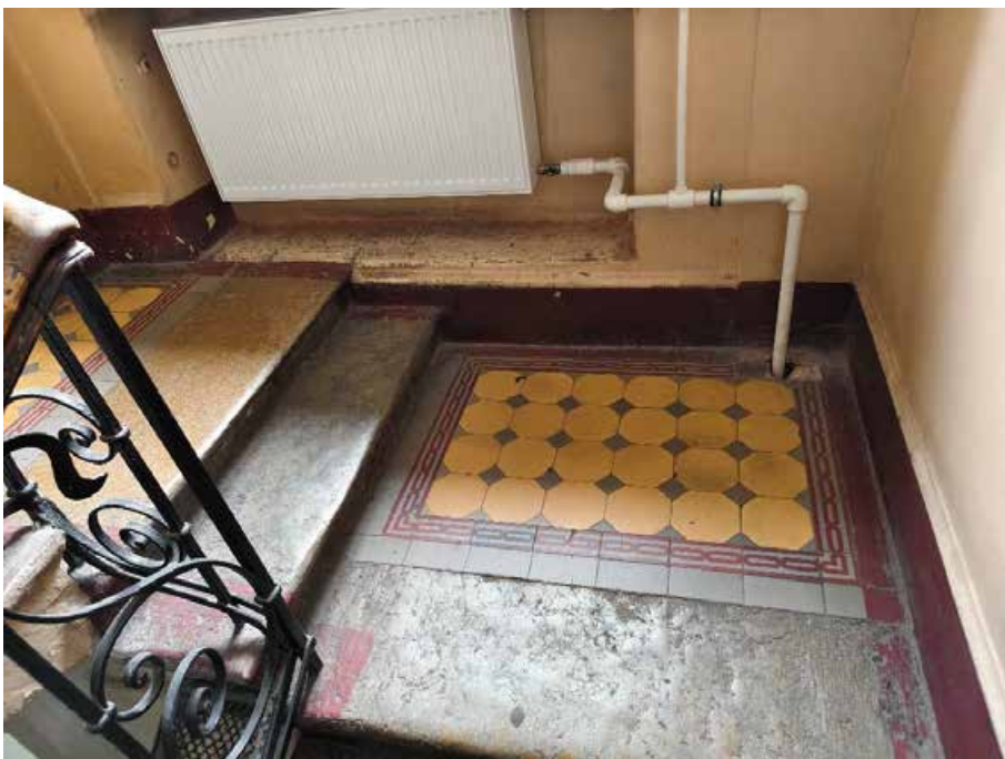
54. «Дом Жилой» (в составе «Дом фан Гильзе фан дер Пальса Г.Г.»), Английский пр., д. 8-10. Лестница восточной части. Фрагмент. Фото 05.05.2025г.
