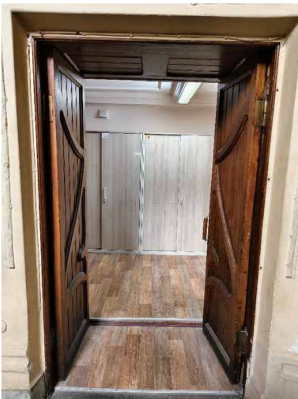
102. «Дом Жилой» (в составе «Дом фан Гильзе фан дер Пальса Г.Г.»), Английский пр., д. 8-10. Второй этаж. Помещение №55. Фрагмент. Фото 05.05.2025г.
