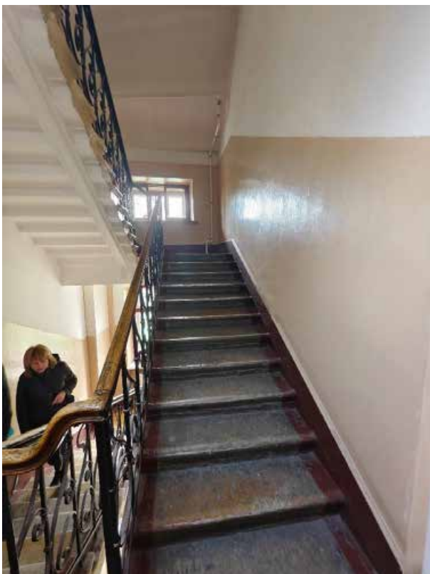
62. «Дом Жилой» (в составе «Дом фан Гильзе фан дер Пальса Г.Г.»), Английский пр., д. 8-10. Лестница восточной части. Общий вид. Фото 05.05.2025г.
