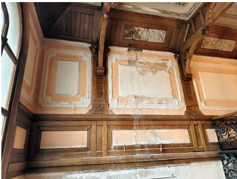
77. «Дом Жилой» (в составе «Дом фан Гильзе фан дер Пальса Г.Г.»), Английский пр., д. 8-10. Второй этаж. Помещение №65. Фрагмент. Фото 05.05.2025г.
