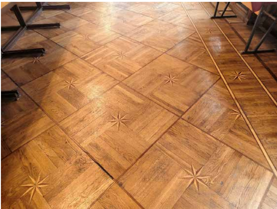
139. «Дом Жилой» (в составе «Дом фан Гильзе фан дер Пальса Г.Г.»), Английский пр., д. 8-10. Второй этаж. Помещение №67. Фрагмент. Фото 05.05.2025г.
