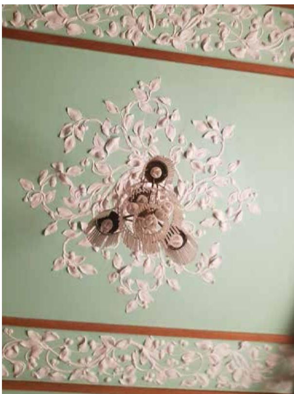
152. «Дом Жилой» (в составе «Дом фан Гильзе фан дер Пальса Г.Г.»), Английский пр., д. 8-10. Второй этаж. Помещение №58. Фрагмент. Фото 05.05.2025г.
