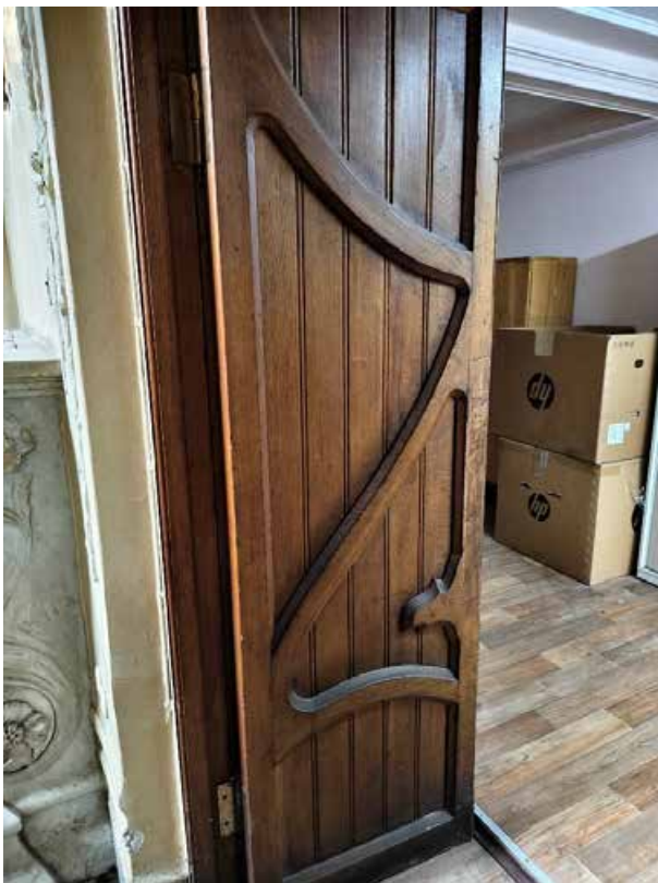
103. «Дом Жилой» (в составе «Дом фан Гильзе фан дер Пальса Г.Г.»), Английский пр., д. 8-10. Второй этаж. Помещение №55. Фрагмент. Фото 05.05.2025г.
