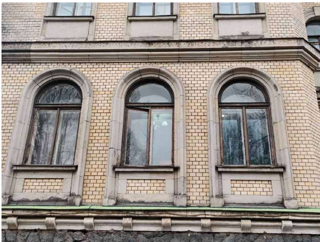
23. «Дом Жилой» (в составе «Дом фан Гильзе фан дер Пальса Г.Г.»), Английский пр., д. 8-10. Северный фасад. Фрагмент. Фото 05.05.2025г.
