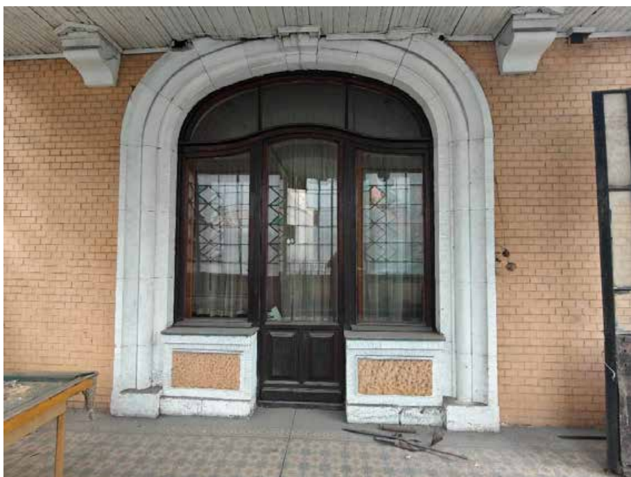
142. «Дом Жилой» (в составе «Дом фан Гильзе фан дер Пальса Г.Г.»), Английский пр., д. 8-10. Зимний сад. Помещение №68. Фрагмент. Фото 05.05.2025г.
