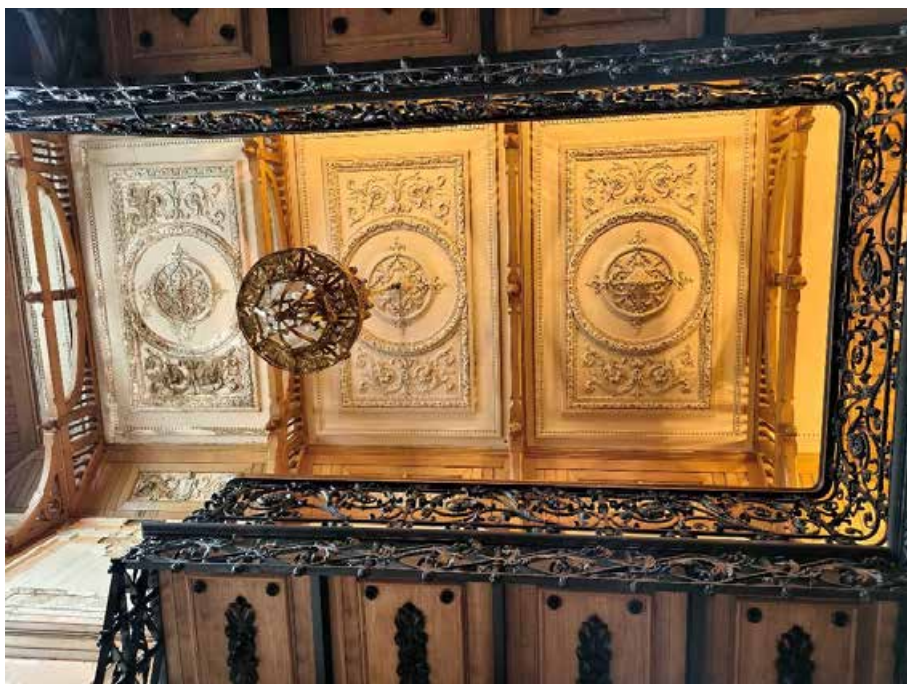
81. «Дом Жилой» (в составе «Дом фан Гильзе фан дер Пальса Г.Г.»), Английский пр., д. 8-10. Второй этаж. Помещение №65. Фрагмент. Фото 05.05.2025г.
