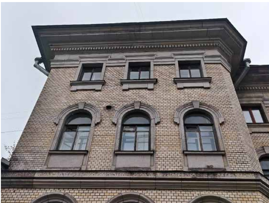
22. «Дом Жилой» (в составе «Дом фан Гильзе фан дер Пальса Г.Г.»), Английский пр., д. 8-10. Северный фасад. Фрагмент. Фото 05.05.2025г.
