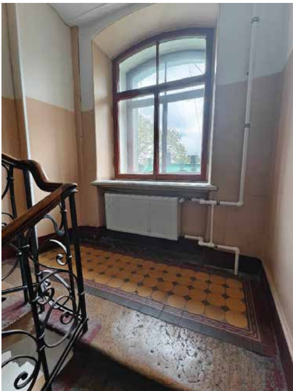
59. «Дом Жилой» (в составе «Дом фан Гильзе фан дер Пальса Г.Г.»), Английский пр., д. 8-10. Лестница восточной части. Общий вид. Фото 05.05.2025г.
