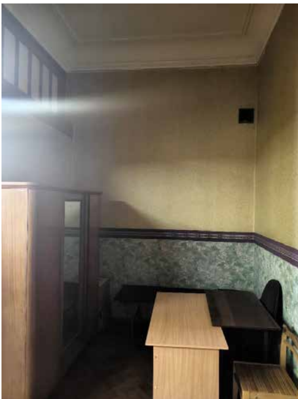
174. «Дом Жилой» (в составе «Дом фан Гильзе фан дер Пальса Г.Г.»), Английский пр., д. 8-10. Третий этаж. Помещение №90. Общий вид. Фото 05.05.2025г.
