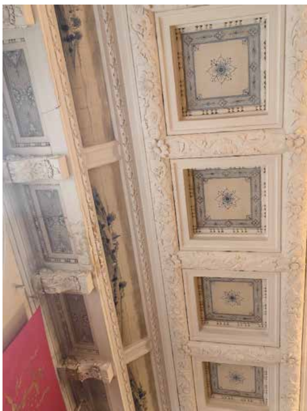
138. «Дом Жилой» (в составе «Дом фан Гильзе фан дер Пальса Г.Г.»), Английский пр., д. 8-10. Второй этаж. Помещение №67. Фрагмент. Фото 05.05.2025г.
