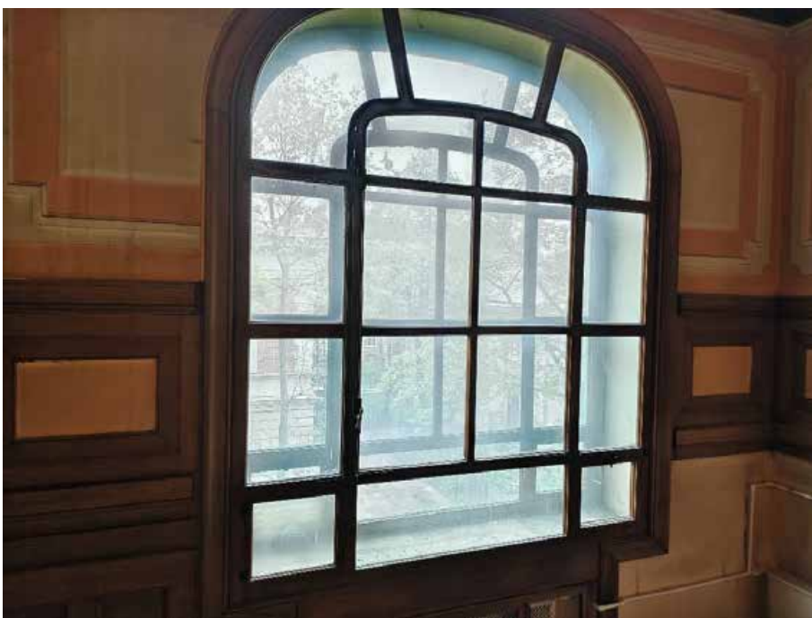
76. «Дом Жилой» (в составе «Дом фан Гильзе фан дер Пальса Г.Г.»), Английский пр., д. 8-10. Второй этаж. Помещение №65. Фрагмент. Фото 05.05.2025г.
