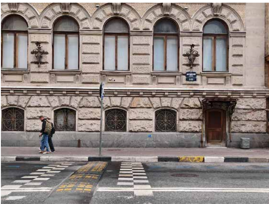
14. «Дом Жилой» (в составе «Дом фан Гильзе фан дер Пальса Г.Г.»), Английский пр., д. 8-10. Западный фасад. Фрагмент. Фото 05.05.2025г.
