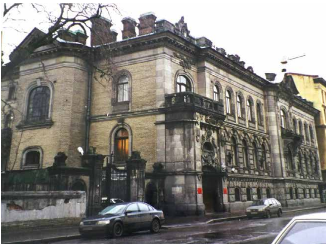
126. Здание Военного комиссариата на Английском пр., 8-10. Общий вид с северо-западной стороны. Фотография. 1997 г. Паспорт «Усадьба фан Гильзе фан дер Пальса». Сост. М.Л. Макагонова. Сектор хранения документированной информации КГИОП (п. 529, инв. № 1022п).
