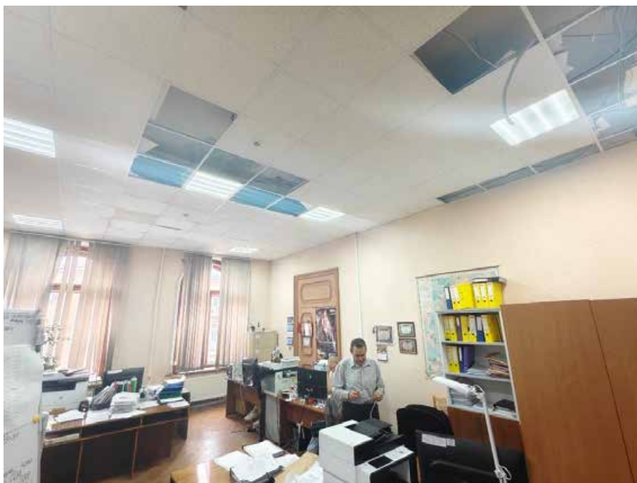
167. «Дом Жилой» (в составе «Дом фан Гильзе фан дер Пальса Г.Г.»), Английский пр., д. 8-10. Третий этаж. Помещение №89. Общий вид. Фото 05.05.2025г.
