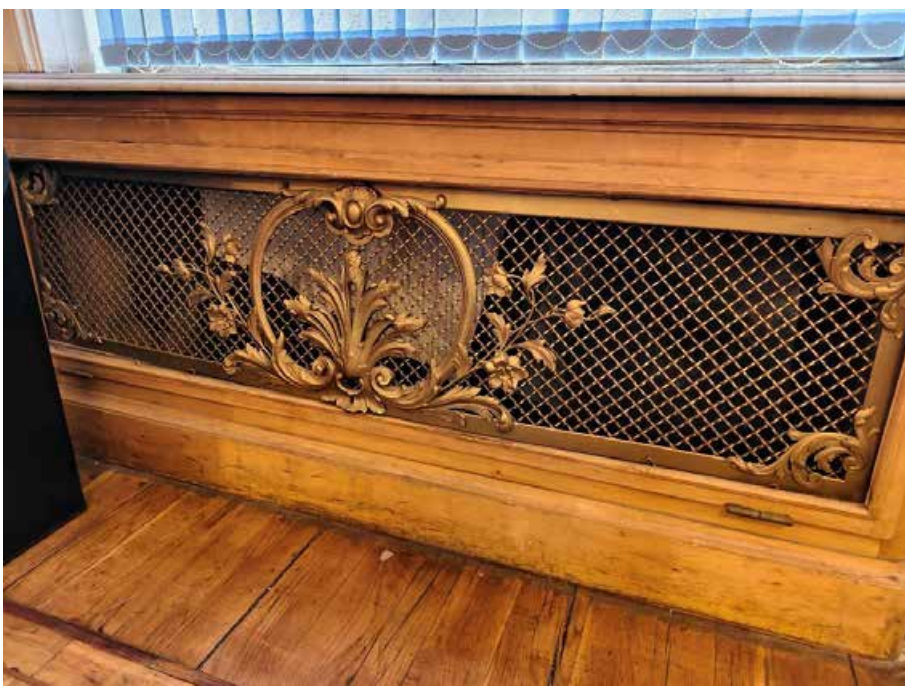
118. «Дом Жилой» (в составе «Дом фан Гильзе фан дер Пальса Г.Г.»), Английский пр., д. 8-10. Второй этаж. Помещение №56. Фрагмент. Фото 05.05.2025г.
