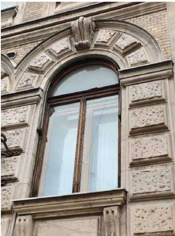
17. «Дом Жилой» (в составе «Дом фан Гильзе фан дер Пальса Г.Г.»), Английский пр., д. 8-10. Западный фасад. Фрагмент. Фото 05.05.2025г.
