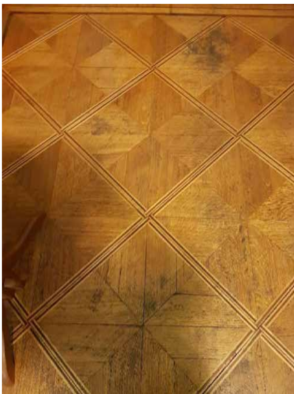
153. «Дом Жилой» (в составе «Дом фан Гильзе фан дер Пальса Г.Г.»), Английский пр., д. 8-10. Второй этаж. Помещение №58. Фрагмент. Фото 05.05.2025г.
