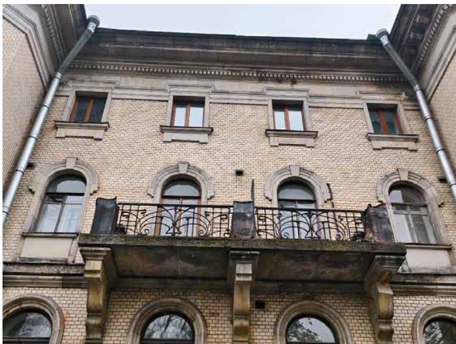
19. «Дом Жилой» (в составе «Дом фан Гильзе фан дер Пальса Г.Г.»), Английский пр., д. 8-10. Северный фасад. Фрагмент. Фото 05.05.2025г.
