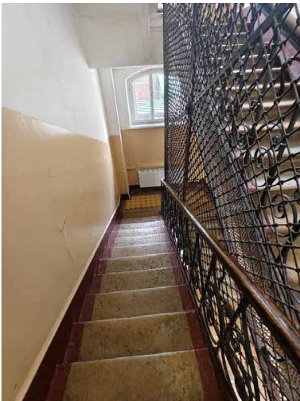
53. «Дом Жилой» (в составе «Дом фан Гильзе фан дер Пальса Г.Г.»), Английский пр., д. 8-10. Лестница восточной части. Общий вид. Фото 05.05.2025г.
