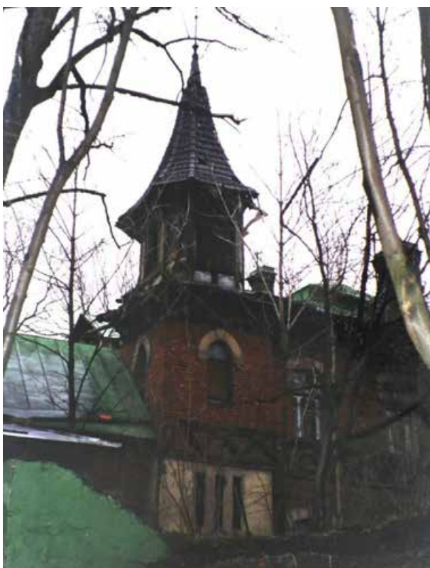
154. Здание Военного комиссариата на Английском пр., 8-10. Комплекс хозяйственных построек. Вид с юго-западной стороны на башню. Фотография. 1997 г. Паспорт «Усадьба фан Гильзе фан дер Пальса». Сост. М.Л. Макагонова. Сектор хранения документированной информации КГИОП (п. 529, инв. № 1022п).
