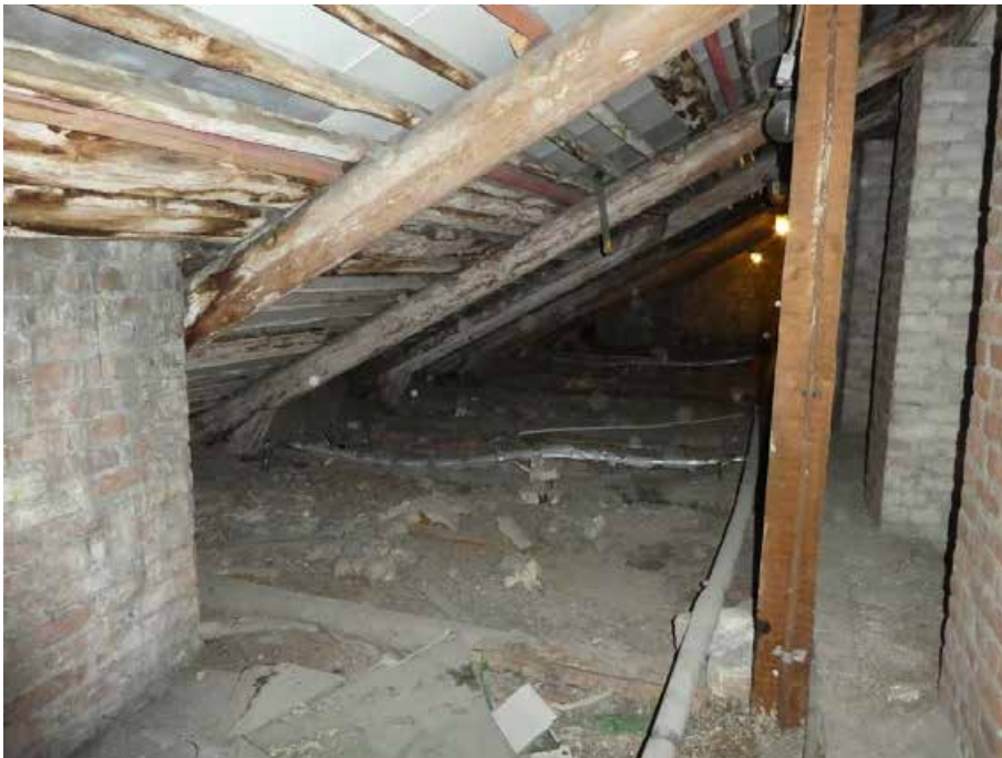
211. «Дом Жилой» (в составе «Дом фан Гильзе фан дер Пальса Г.Г.»), Английский пр., д. 8-10. Третий этаж. Чердак. Общий вид. Фото 05.05.2025г.
