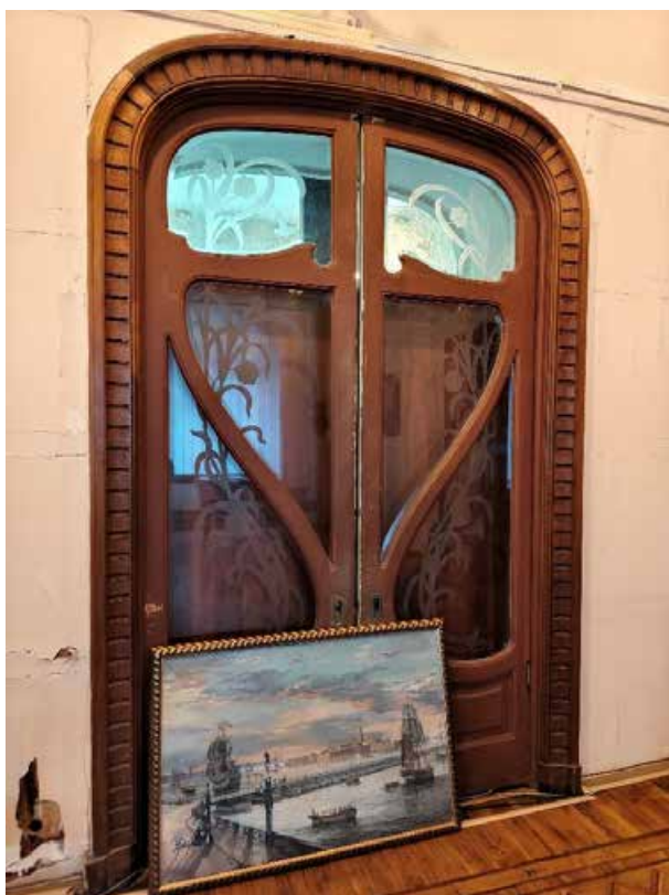
126. «Дом Жилой» (в составе «Дом фан Гильзе фан дер Пальса Г.Г.»), Английский пр., д. 8-10. Второй этаж. Помещение №56. Фрагмент. Фото 05.05.2025г.
