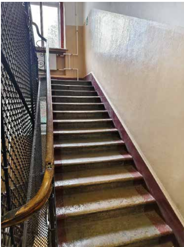
52. «Дом Жилой» (в составе «Дом фан Гильзе фан дер Пальса Г.Г.»), Английский пр., д. 8-10. Лестница восточной части. Общий вид. Фото 05.05.2025г.
