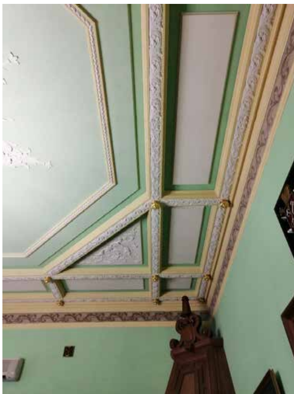
164. «Дом Жилой» (в составе «Дом фан Гильзе фан дер Пальса Г.Г.»), Английский пр., д. 8-10. Второй этаж. Помещение №57. Фрагмент. Фото 05.05.2025г.
