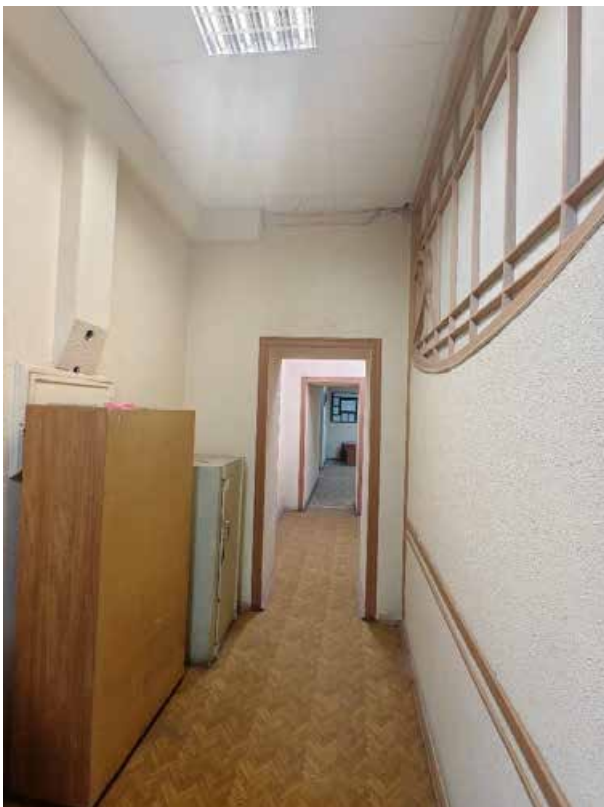
171. «Дом Жилой» (в составе «Дом фан Гильзе фан дер Пальса Г.Г.»), Английский пр., д. 8-10. Третий этаж. Помещение №101. Общий вид. Фото 05.05.2025г.
