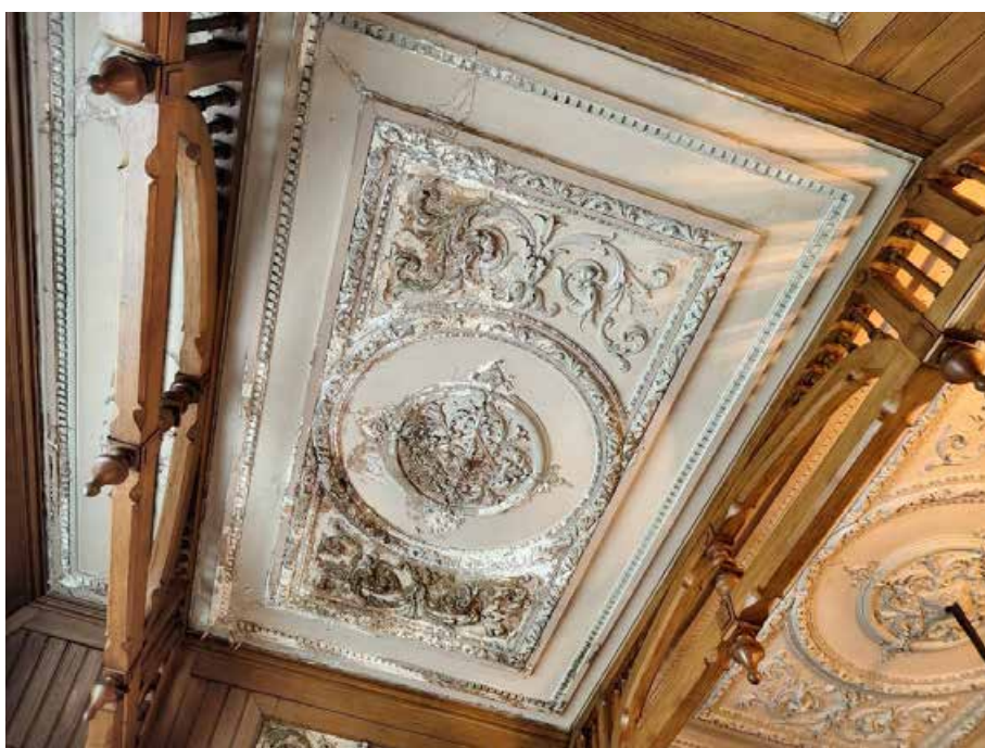
78. «Дом Жилой» (в составе «Дом фан Гильзе фан дер Пальса Г.Г.»), Английский пр., д. 8-10. Второй этаж. Помещение №65. Фрагмент. Фото 05.05.2025г.
