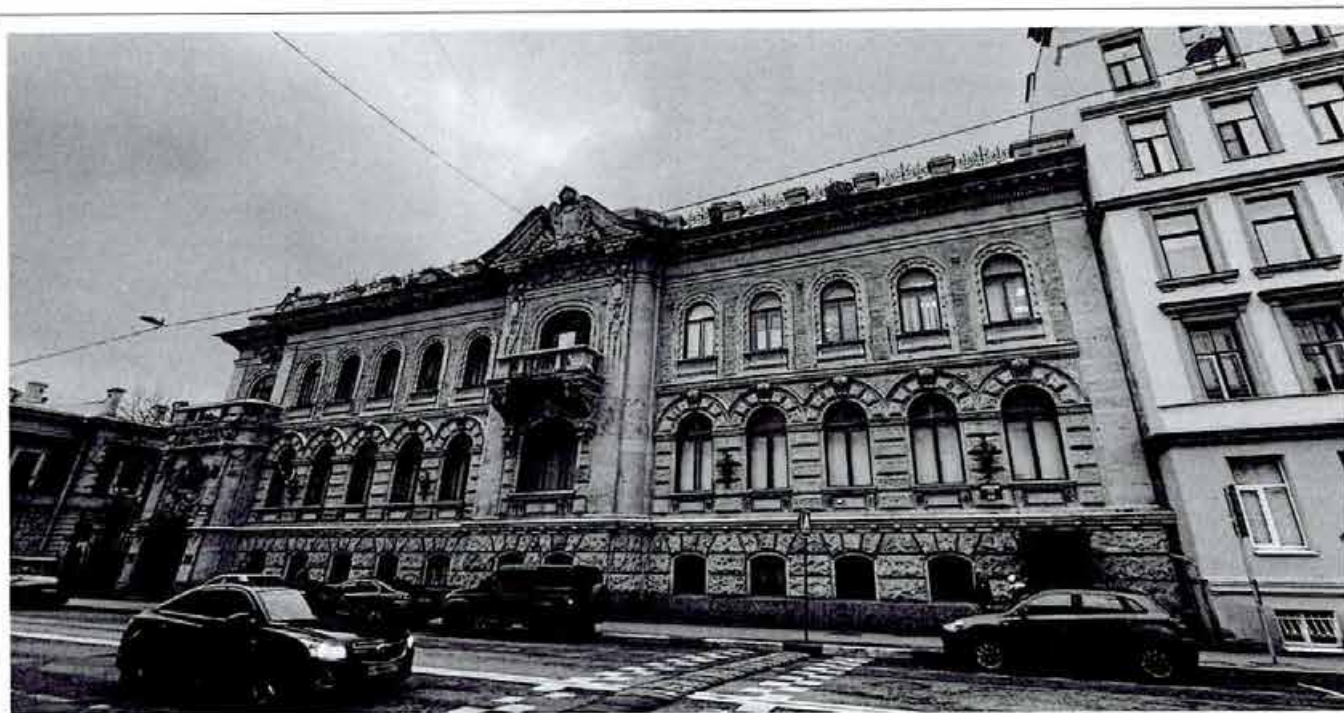
1. Общий вид. Лицевой фасад по Английскому проспекту.
