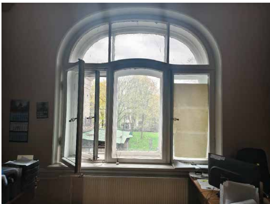
178. «Дом Жилой» (в составе «Дом фан Гильзе фан дер Пальса Г.Г.»), Английский пр., д. 8-10. Третий этаж. Помещение №102. Общий вид. Фото 05.05.2025г.
