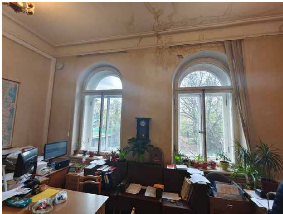
183. «Дом Жилой» (в составе «Дом фан Гильзе фан дер Пальса Г.Г.»), Английский пр., д. 8-10. Третий этаж. Помещение №97. Общий вид. Фото 05.05.2025г.
