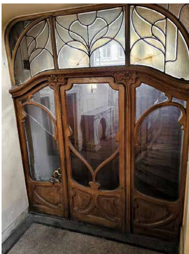
96. «Дом Жилой» (в составе «Дом фан Гильзе фан дер Пальса Г.Г.»), Английский пр., д. 8-10. Второй этаж. Помещение №55. Фрагмент. Фото 05.05.2025г.
