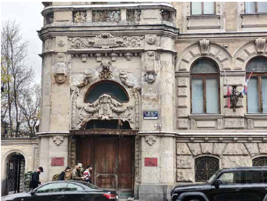
3. «Дом Жилой» (в составе «Дом фан Гильзе фан дер Пальса Г.Г.»), Английский пр., д. 8-10. Западный фасад. Фрагмент. Фото 05.05.2025г.
