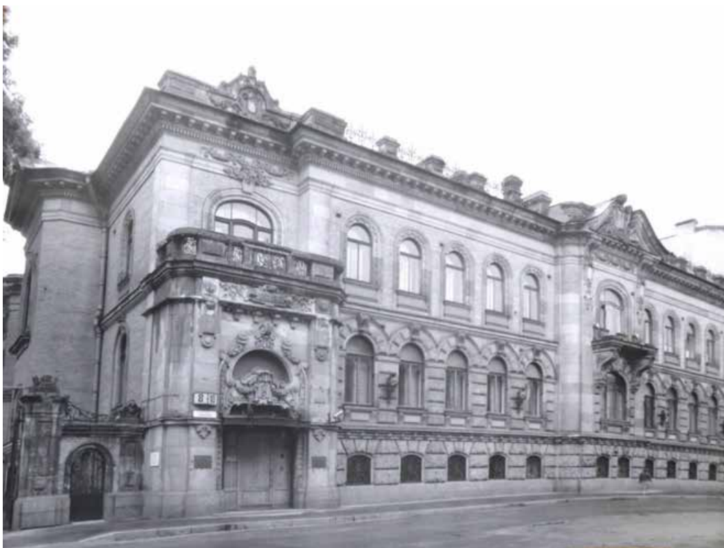
107. Здание Горвоенкомата на пр. Маклина. Общий вид. Фото С.А. Шмидта. 1991 г. Сектор хранения документированной информации КГИОП (инв. №529/1).
