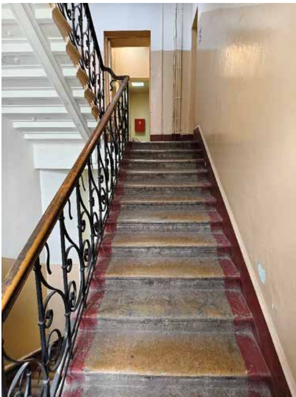
56. «Дом Жилой» (в составе «Дом фан Гильзе фан дер Пальса Г.Г.»), Английский пр., д. 8-10. Лестница восточной части. Общий вид. Фото 05.05.2025г.
