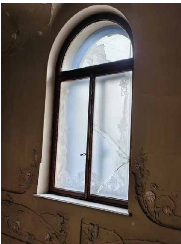
92. «Дом Жилой» (в составе «Дом фан Гильзе фан дер Пальса Г.Г.»), Английский пр., д. 8-10. Второй этаж. Помещение №55. Фрагмент. Фото 05.05.2025г.
