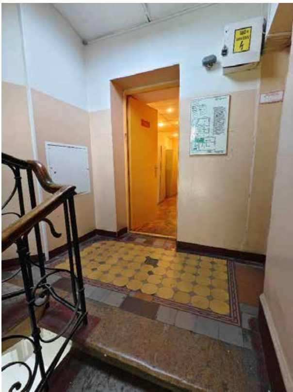
61. «Дом Жилой» (в составе «Дом фан Гильзе фан дер Пальса Г.Г.»), Английский пр., д. 8-10. Лестница восточной части. Общий вид. Фото 05.05.2025г.
