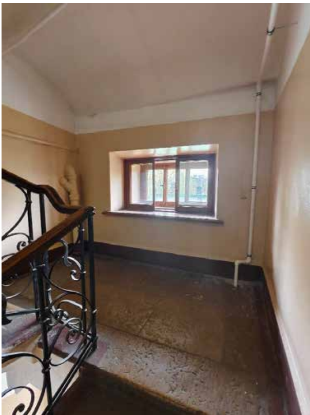
63. «Дом Жилой» (в составе «Дом фан Гильзе фан дер Пальса Г.Г.»), Английский пр., д. 8-10. Лестница восточной части. Общий вид. Фото 05.05.2025г.
