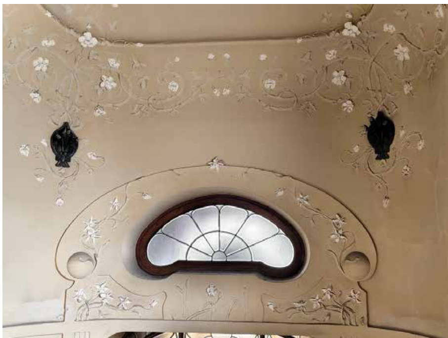
95. «Дом Жилой» (в составе «Дом фан Гильзе фан дер Пальса Г.Г.»), Английский пр., д. 8-10. Второй этаж. Помещение №55. Фрагмент. Фото 05.05.2025г.
