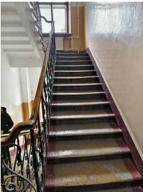
58. «Дом Жилой» (в составе «Дом фан Гильзе фан дер Пальса Г.Г.»), Английский пр., д. 8-10. Лестница восточной части. Общий вид. Фото 05.05.2025г.
