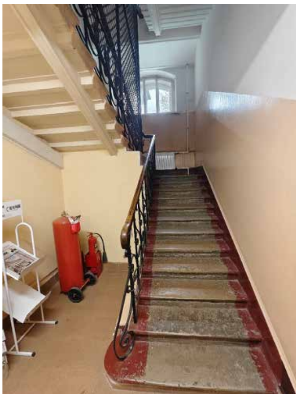
47. «Дом Жилой» (в составе «Дом фан Гильзе фан дер Пальса Г.Г.»), Английский пр., д. 8-10. Лестница восточной части. Общий вид. Фото 05.05.2025г.
