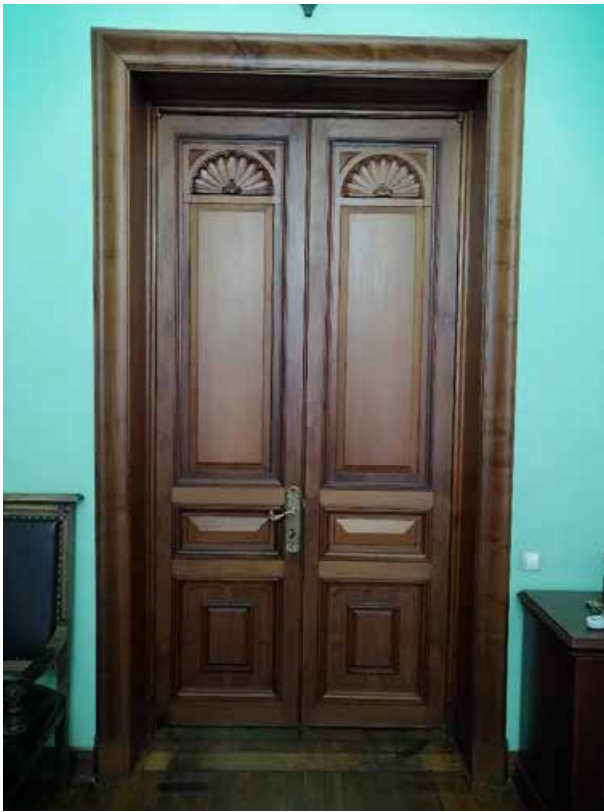
159. «Дом Жилой» (в составе «Дом фан Гильзе фан дер Пальса Г.Г.»), Английский пр., д. 8-10. Второй этаж. Помещение №57. Фрагмент. Фото 05.05.2025г.
