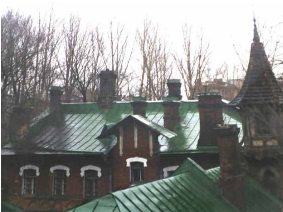
153. Здание Военного комиссариата на Английском пр., 8-10. Комплекс хозяйственных построек. Вид с юго-западной стороны. Фотография. 1997 г. Паспорт «Усадьба фан Гильзе фан дер Пальса». Сост. М.Л. Макагонова. Сектор хранения документированной информации КГИОП (п. 529, инв. № 1022п).
