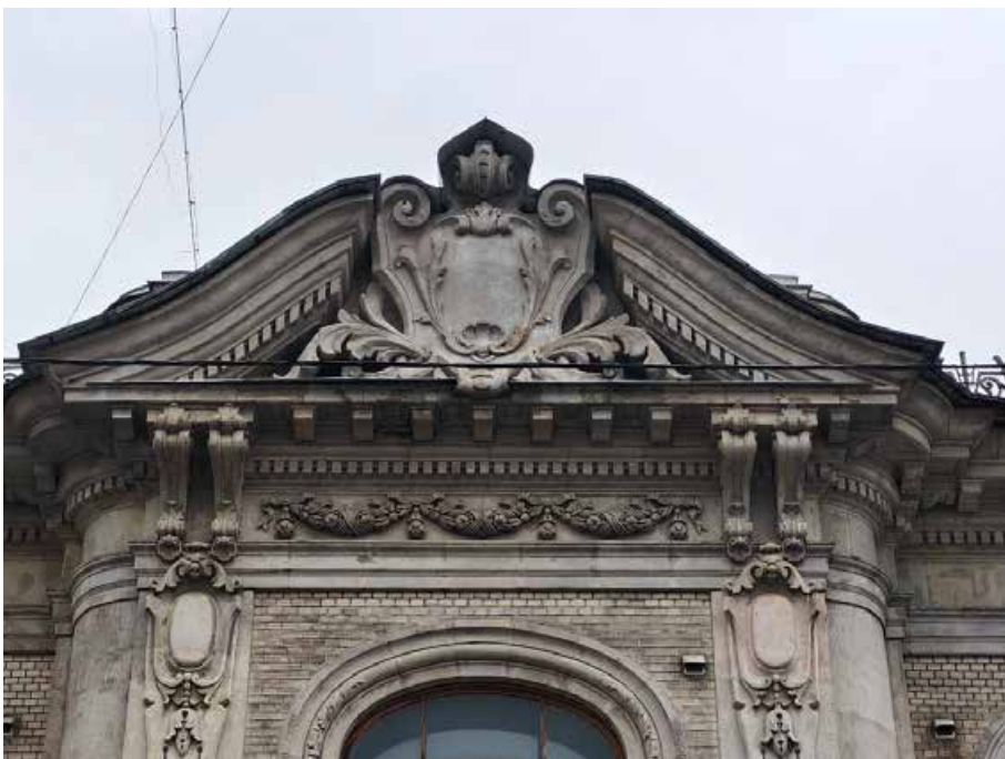
8. «Дом Жилой» (в составе «Дом фан Гильзе фан дер Пальса Г.Г.»), Английский пр., д. 8-10. Западный фасад. Фрагмент. Фото 05.05.2025г.
