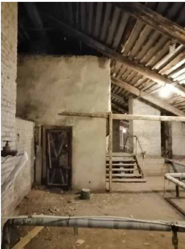
209. «Дом Жилой» (в составе «Дом фан Гильзе фан дер Пальса Г.Г.»), Английский пр., д. 8-10. Третий этаж. Чердак. Общий вид. Фото 05.05.2025г.
