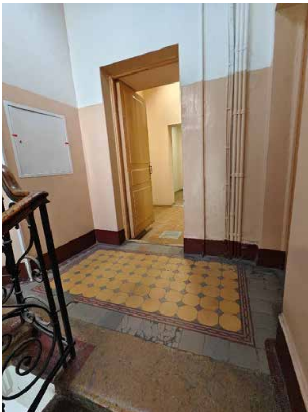
57. «Дом Жилой» (в составе «Дом фан Гильзе фан дер Пальса Г.Г.»), Английский пр., д. 8-10. Лестница восточной части. Общий вид. Фото 05.05.2025г.
