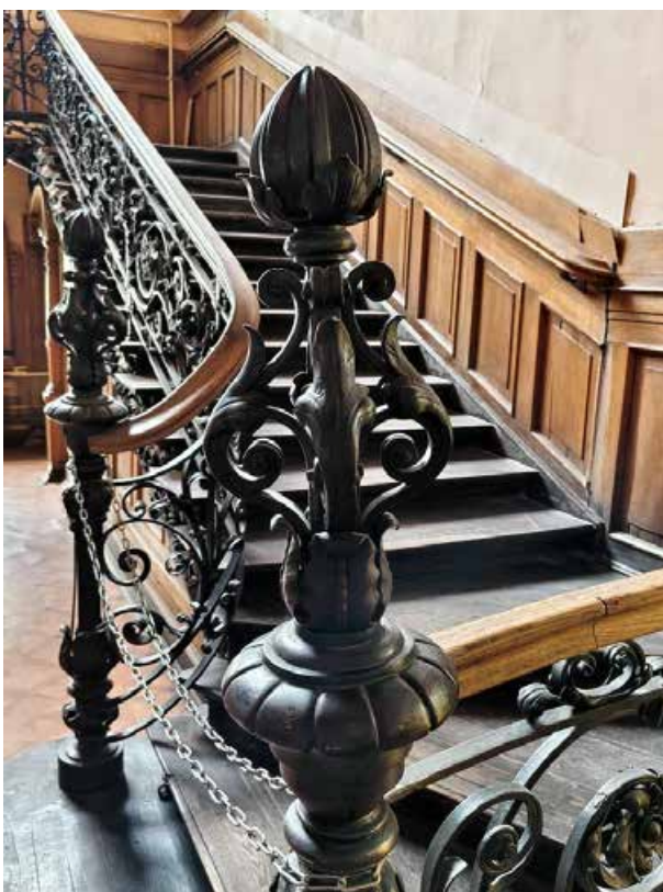
72. «Дом Жилой» (в составе «Дом фан Гильзе фан дер Пальса Г.Г.»), Английский пр., д. 8-10. Второй этаж. Помещение №65. Фрагмент. Фото 05.05.2025г.
