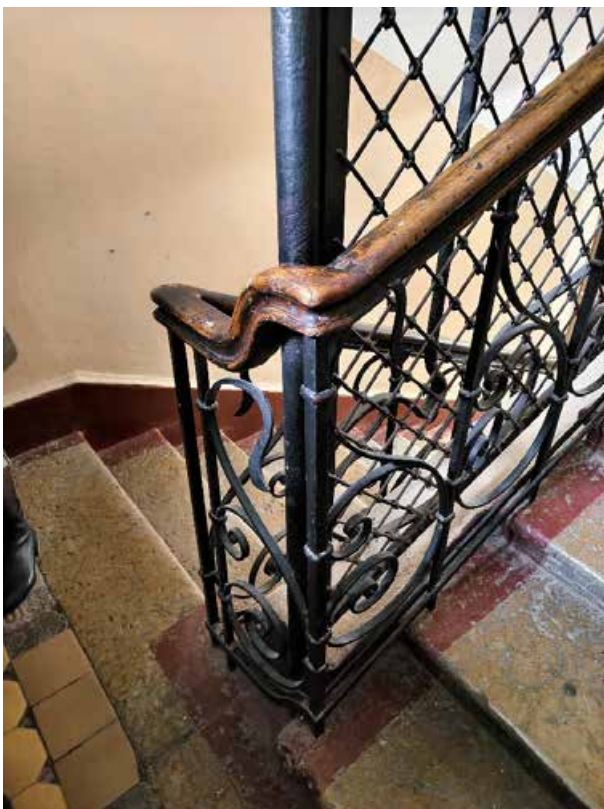
50. «Дом Жилой» (в составе «Дом фан Гильзе фан дер Пальса Г.Г.»), Английский пр., д. 8-10. Лестница восточной части. Фрагмент. Фото 05.05.2025г.
