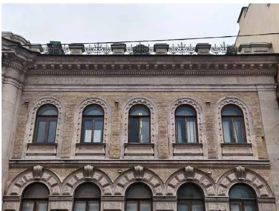
12. «Дом Жилой» (в составе «Дом фан Гильзе фан дер Пальса Г.Г.»), Английский пр., д. 8-10. Западный фасад. Фрагмент. Фото 05.05.2025г.
