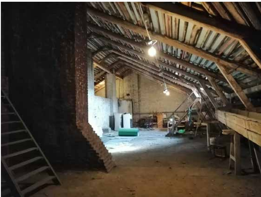
207. «Дом Жилой» (в составе «Дом фан Гильзе фан дер Пальса Г.Г.»), Английский пр., д. 8-10. Третий этаж. Чердак. Общий вид. Фото 05.05.2025г.
