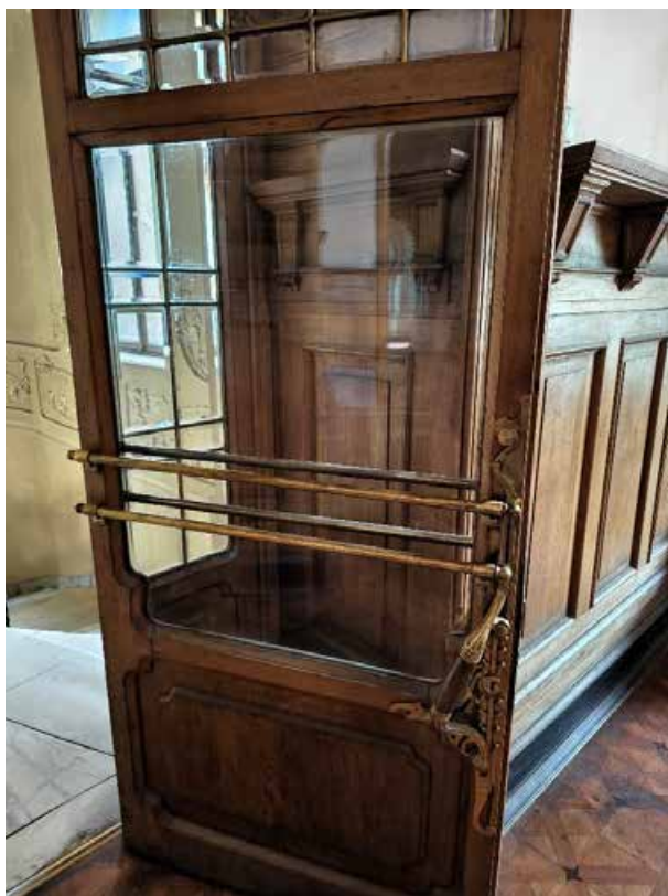
89. «Дом Жилой» (в составе «Дом фан Гильзе фан дер Пальса Г.Г.»), Английский пр., д. 8-10. Второй этаж. Помещение №65. Фрагмент. Фото 05.05.2025г.
