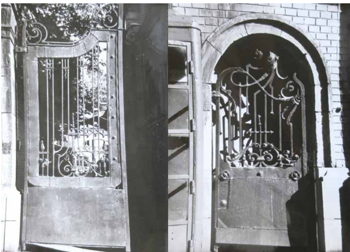
90. То же. Детали. Створка въездных ворот. Сектор хранения документированной информации КГИОП (инв. № 83548) Левая калитка входа. Сектор хранения документированной информации КГИОП (инв. № 83561).
