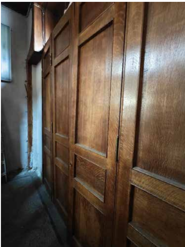
101. «Дом Жилой» (в составе «Дом фан Гильзе фан дер Пальса Г.Г.»), Английский пр., д. 8-10. Второй этаж. Помещение №55. Фрагмент. Фото 05.05.2025г.
