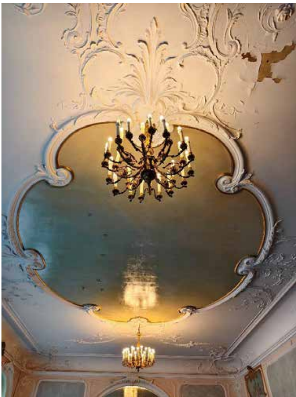
115. «Дом Жилой» (в составе «Дом фан Гильзе фан дер Пальса Г.Г.»), Английский пр., д. 8-10. Второй этаж. Помещение №56. Фрагмент. Фото 05.05.2025г.
