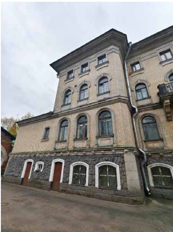
21. «Дом Жилой» (в составе «Дом фан Гильзе фан дер Пальса Г.Г.»), Английский пр., д. 8-10. Северный фасад. Фрагмент. Фото 05.05.2025г.
