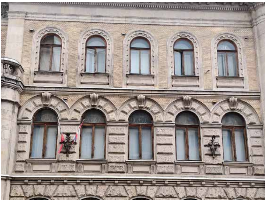
5. «Дом Жилой» (в составе «Дом фан Гильзе фан дер Пальса Г.Г.»), Английский пр., д. 8-10. Западный фасад. Фрагмент. Фото 05.05.2025г.
