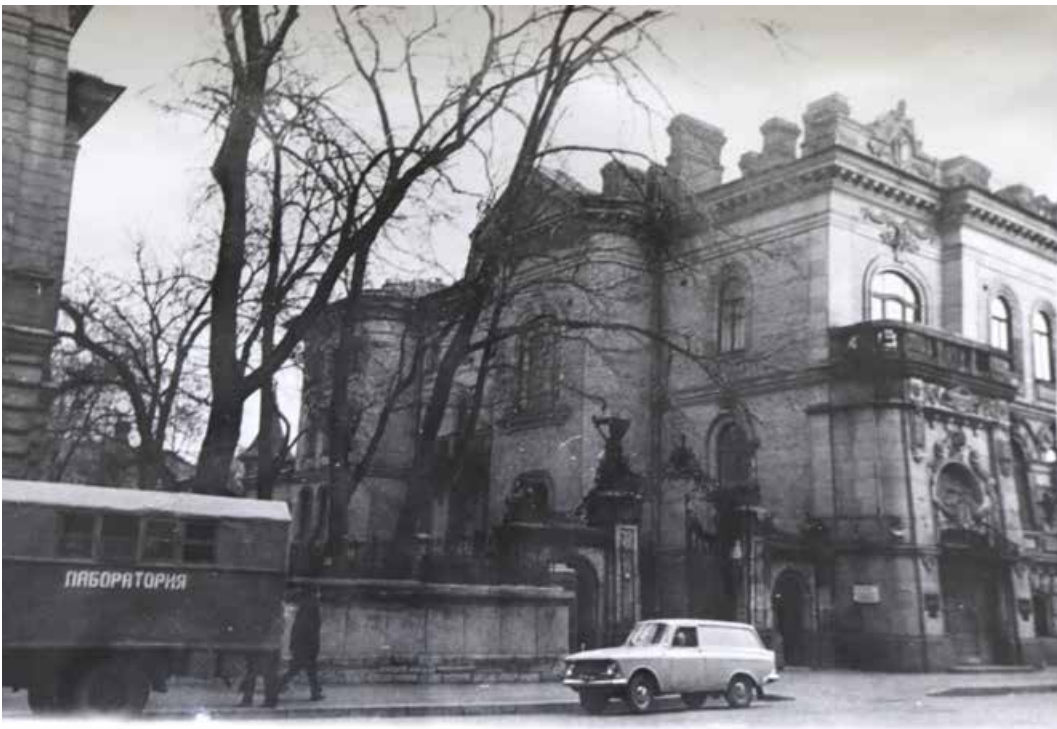
124. Здание Горвоенкомата на пр. Маклина. Вид с северо-запада. Фотография В.Ф. Егоровского. 1994 г. Сектор хранения документированной информации КГИОП (инв. №529/7).
