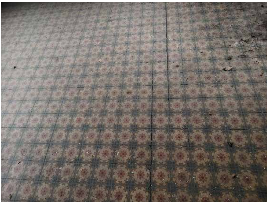
145. «Дом Жилой» (в составе «Дом фан Гильзе фан дер Пальса Г.Г.»), Английский пр., д. 8-10. Зимний сад. Помещение №68. Фрагмент. Фото 05.05.2025г.
