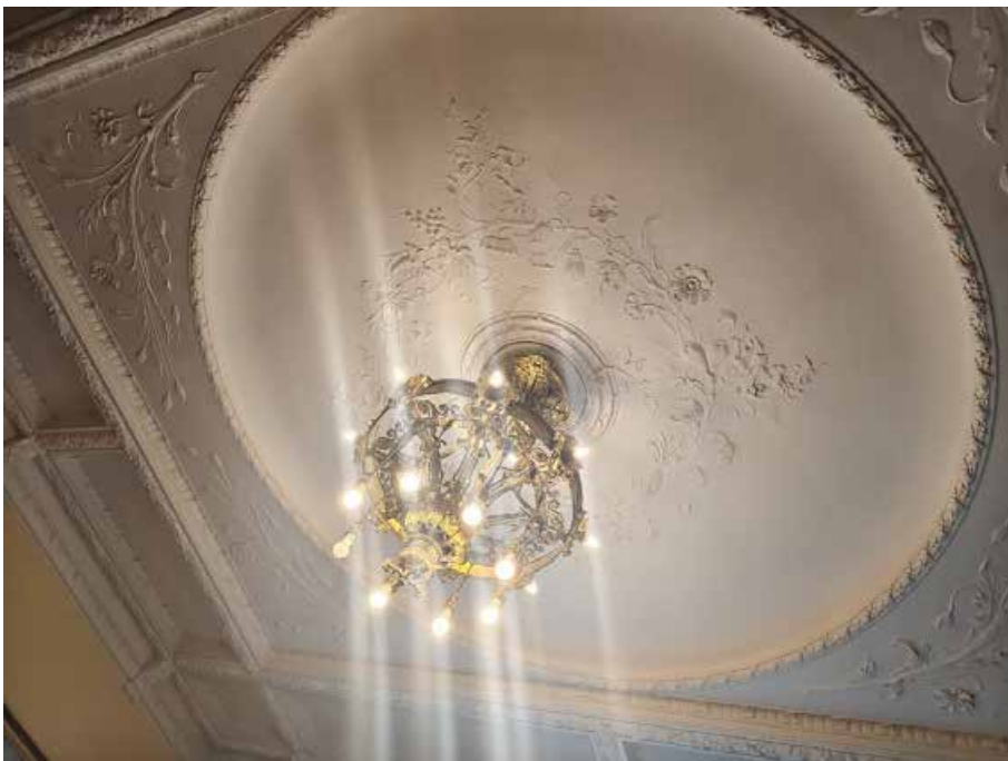
131. «Дом Жилой» (в составе «Дом фан Гильзе фан дер Пальса Г.Г.»), Английский пр., д. 8-10. Второй этаж. Помещение №67. Фрагмент. Фото 05.05.2025г.
