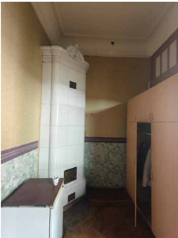
173. «Дом Жилой» (в составе «Дом фан Гильзе фан дер Пальса Г.Г.»), Английский пр., д. 8-10. Третий этаж. Помещение №90. Общий вид. Фото 05.05.2025г.
