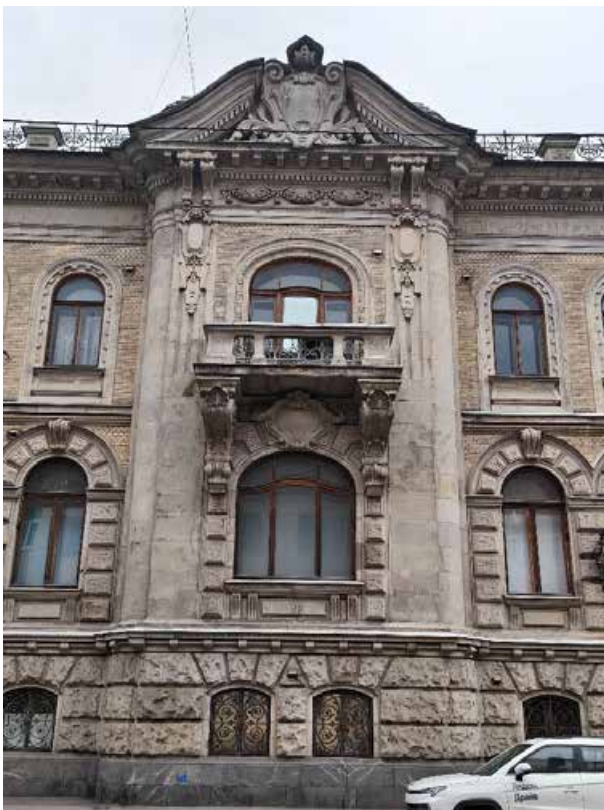
7. «Дом Жилой» (в составе «Дом фан Гильзе фан дер Пальса Г.Г.»), Английский пр., д. 8-10. Западный фасад. Фрагмент. Фото 05.05.2025г.
