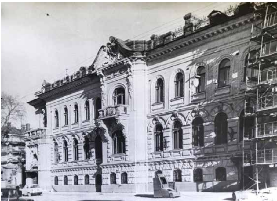
83. Здание Горвоенкомата на пр. Маклина. Общий вид с юго-западной стороны. Фотография. 1962. Сектор хранения документированной информации КГИОП (инв. № 71123) Проводятся ремонтные работы на фасаде соседнего здания.
