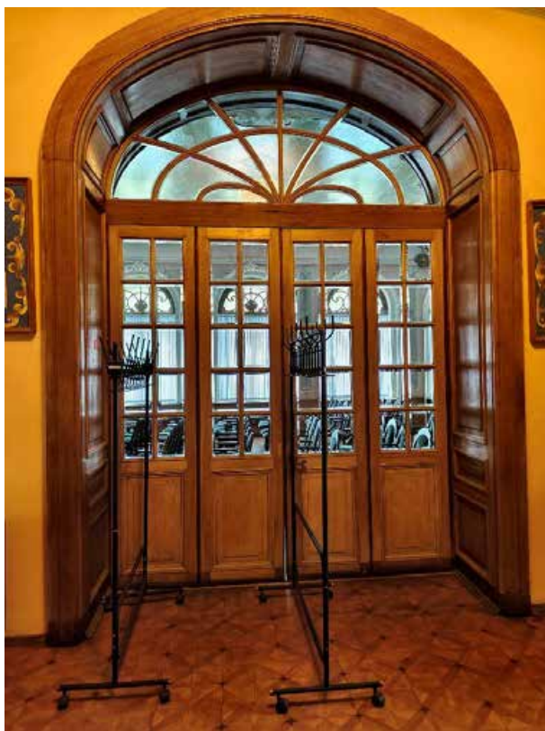
109. «Дом Жилой» (в составе «Дом фан Гильзе фан дер Пальса Г.Г.»), Английский пр., д. 8-10. Второй этаж. Помещение №64. Фрагмент. Фото 05.05.2025г.
