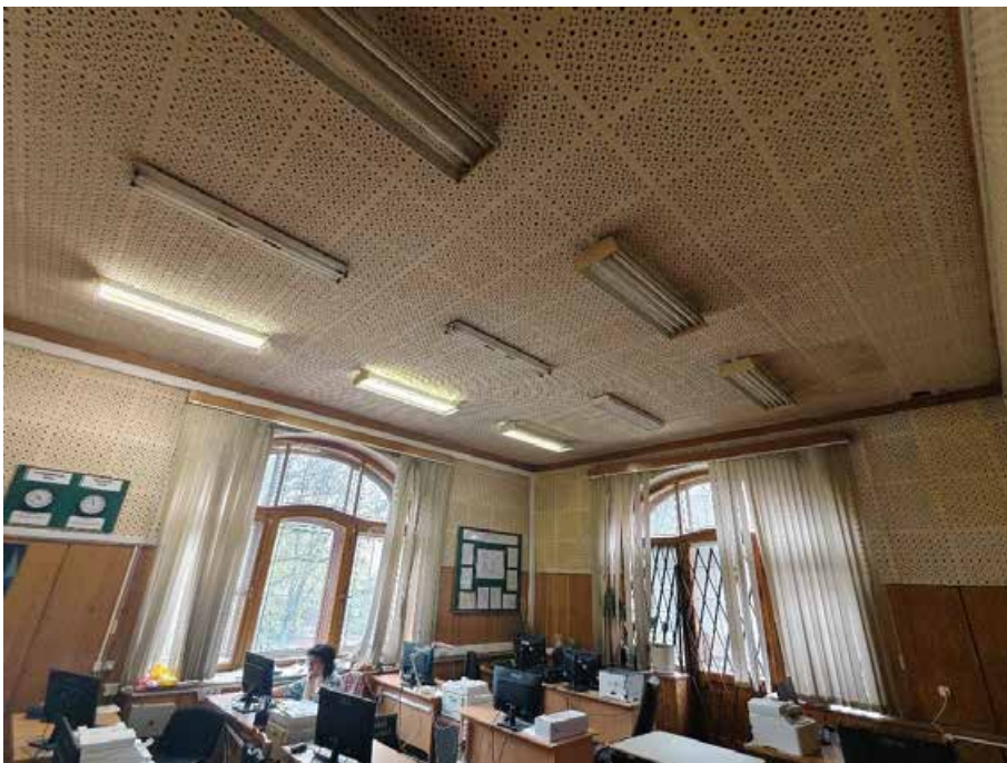
193. «Дом Жилой» (в составе «Дом фан Гильзе фан дер Пальса Г.Г.»), Английский пр., д. 8-10. Третий этаж. Помещение №110. Общий вид. Фото 05.05.2025г.
