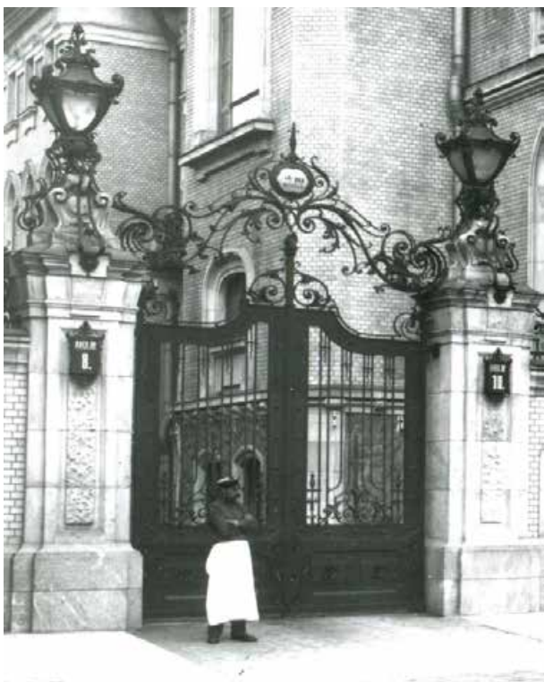
61. Особняк фан Гильзе фан дер Пальса Г.Г. на Английском проспекте. Общий вид с северо-западной стороны. Деталь с въездными воротами. Фотография ателье К. Буллы. 1900-е гг. ЦГАКФФД СПб (инв. № Е 5079).
