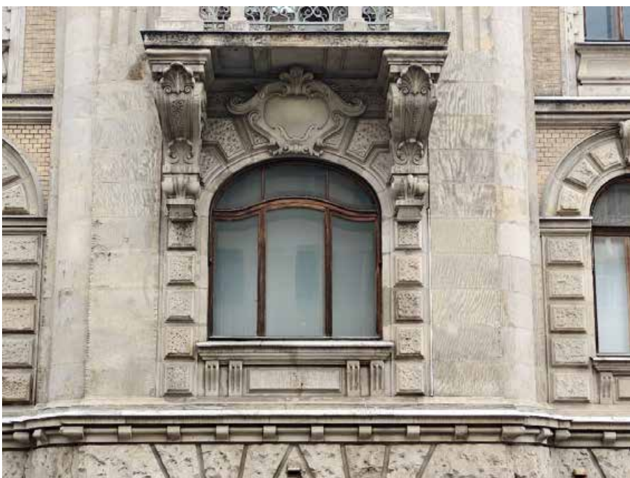
10. «Дом Жилой» (в составе «Дом фан Гильзе фан дер Пальса Г.Г.»), Английский пр., д. 8-10. Западный фасад. Фрагмент. Фото 05.05.2025г.
