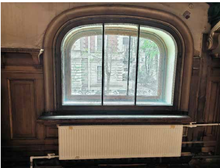
86. «Дом Жилой» (в составе «Дом фан Гильзе фан дер Пальса Г.Г.»), Английский пр., д. 8-10. Второй этаж. Помещение №65. Фрагмент. Фото 05.05.2025г.
