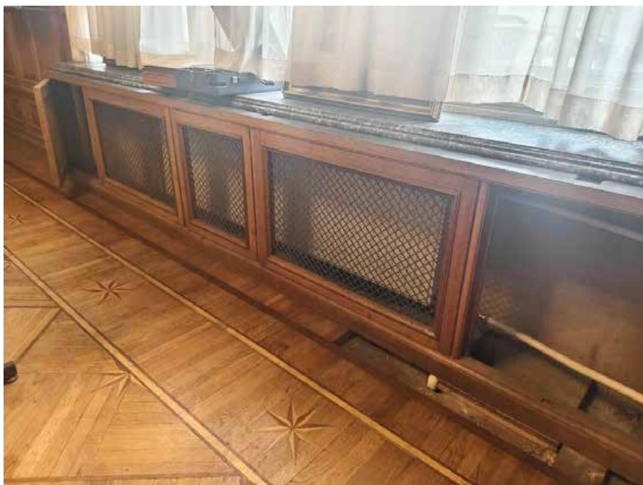
133. «Дом Жилой» (в составе «Дом фан Гильзе фан дер Пальса Г.Г.»), Английский пр., д. 8-10. Второй этаж. Помещение №67. Фрагмент. Фото 05.05.2025г.
