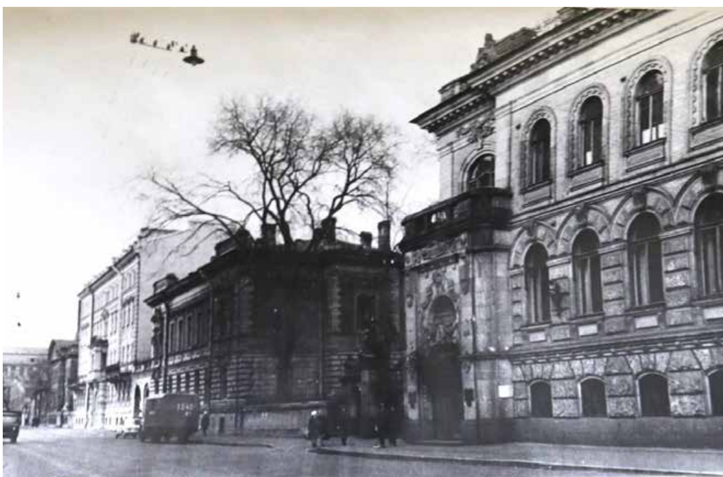
120. Здание Горвоенкомата на пр. Маклина. Общий вид с юго-запада. Фотография В.Ф. Егоровского. 1994 г. Сектор хранения документированной информации КГИОП (инв. №529/2).
