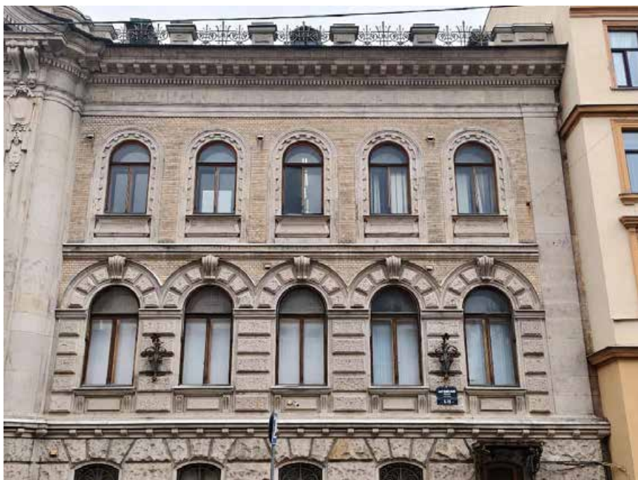
11. «Дом Жилой» (в составе «Дом фан Гильзе фан дер Пальса Г.Г.»), Английский пр., д. 8-10. Западный фасад. Фрагмент. Фото 05.05.2025г.
