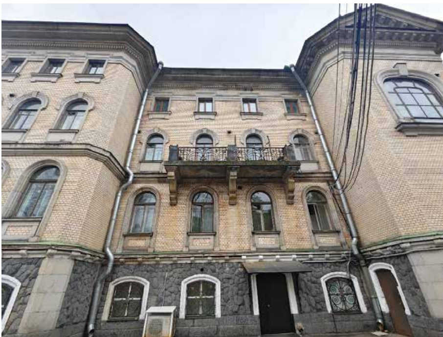
18. «Дом Жилой» (в составе «Дом фан Гильзе фан дер Пальса Г.Г.»), Английский пр., д. 8-10. Северный фасад. Общий вид. Фото 05.05.2025г.
