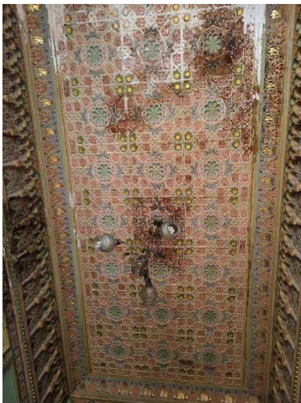
113. «Дом Жилой» (в составе «Дом фан Гильзе фан дер Пальса Г.Г.»), Английский пр., д. 8-10. Второй этаж. Помещение №63. Фрагмент. Фото 05.05.2025г.
