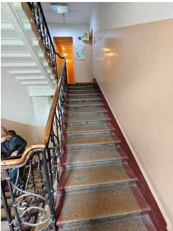
60. «Дом Жилой» (в составе «Дом фан Гильзе фан дер Пальса Г.Г.»), Английский пр., д. 8-10. Лестница восточной части. Общий вид. Фото 05.05.2025г.
