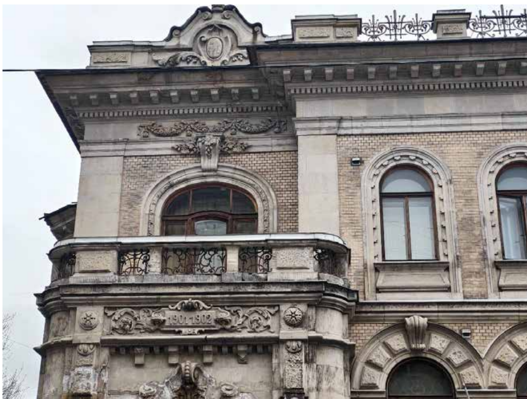
2. «Дом Жилой» (в составе «Дом фан Гильзе фан дер Пальса Г.Г.»), Английский пр., д. 8-10. Западный фасад. Фрагмент. Фото 05.05.2025г.
