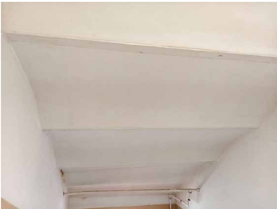
65. «Дом Жилой» (в составе «Дом фан Гильзе фан дер Пальса Г.Г.»), Английский пр., д. 8-10. Лестница восточной части. Общий вид. Фото 05.05.2025г.
