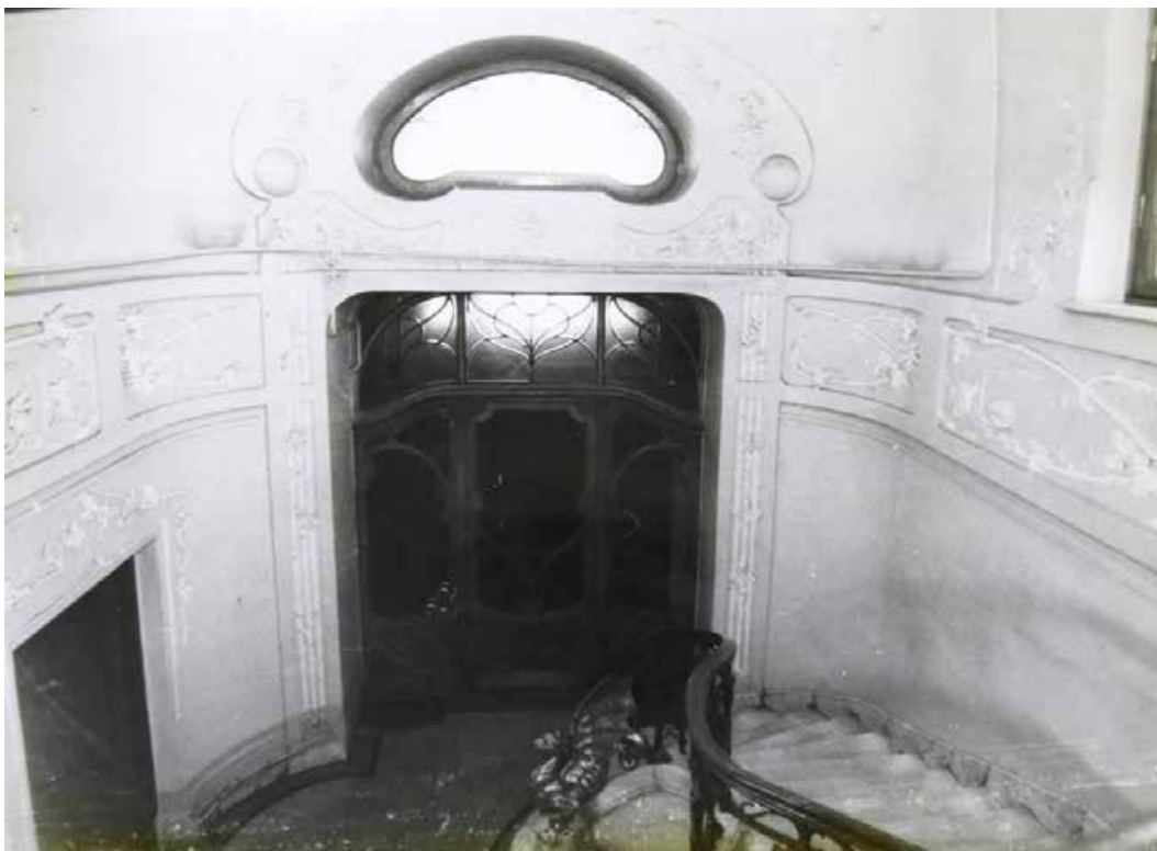
131. Здание Военного комиссариата на Английском пр., 8-10. Вестибюль с мраморной лестницей. Вид на входную дверь и тамбур. Фотография. 1997 г. Паспорт «Усадьба фан Гильзе фан дер Пальса». Сост. М.Л. Макагонова. Сектор хранения документированной информации КГИОП (п. 529, инв. № 1022п).
