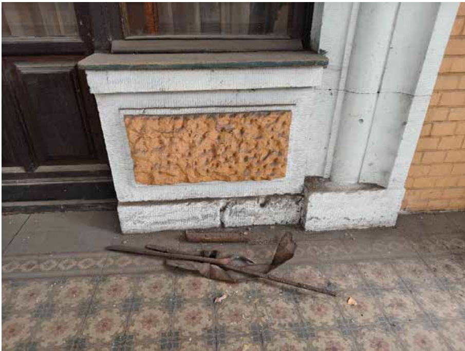
143. «Дом Жилой» (в составе «Дом фан Гильзе фан дер Пальса Г.Г.»), Английский пр., д. 8-10. Зимний сад. Помещение №68. Фрагмент. Фото 05.05.2025г.
