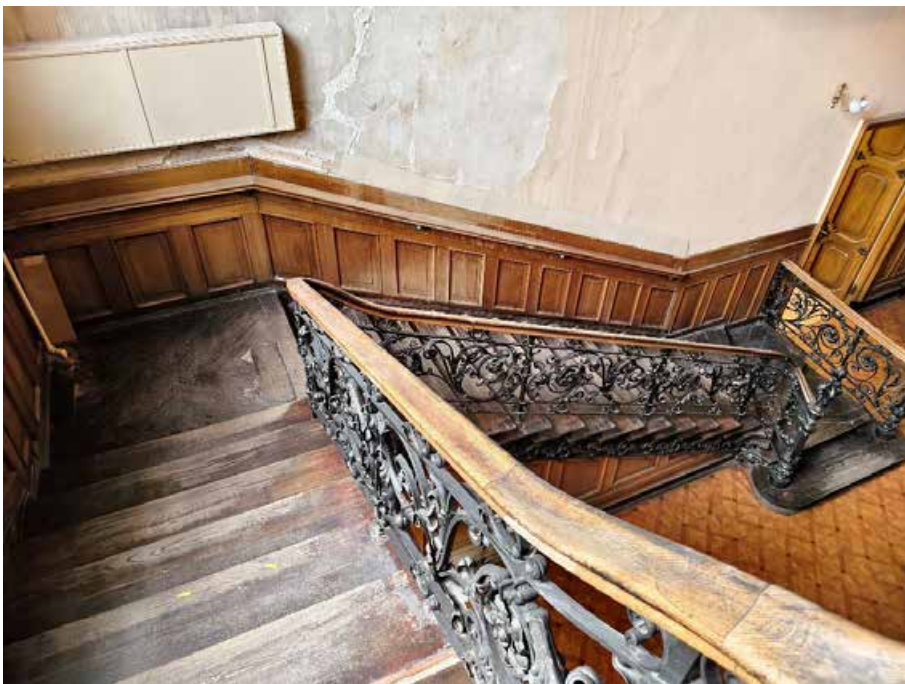
75. «Дом Жилой» (в составе «Дом фан Гильзе фан дер Пальса Г.Г.»), Английский пр., д. 8-10. Второй этаж. Помещение №65. Фрагмент. Фото 05.05.2025г.
