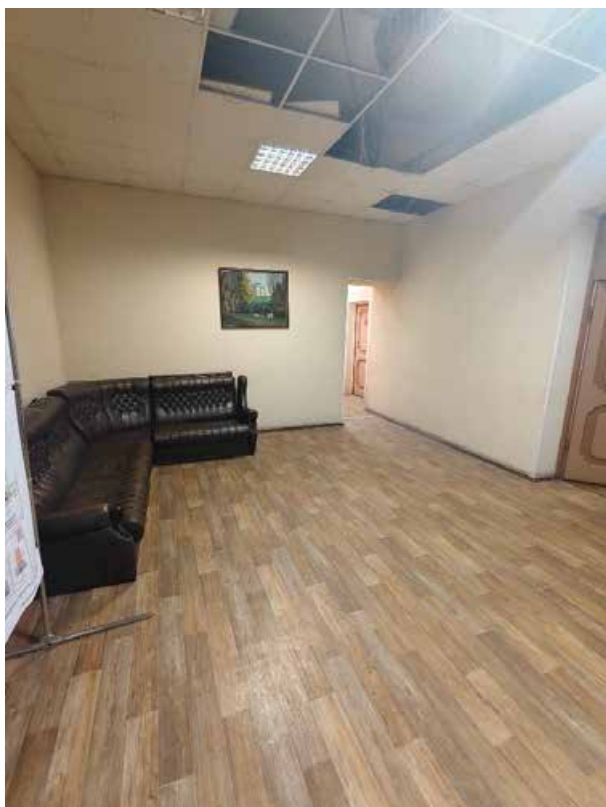
165. «Дом Жилой» (в составе «Дом фан Гильзе фан дер Пальса Г.Г.»), Английский пр., д. 8-10. Третий этаж. Помещение №105. Общий вид. Фото 05.05.2025г.
