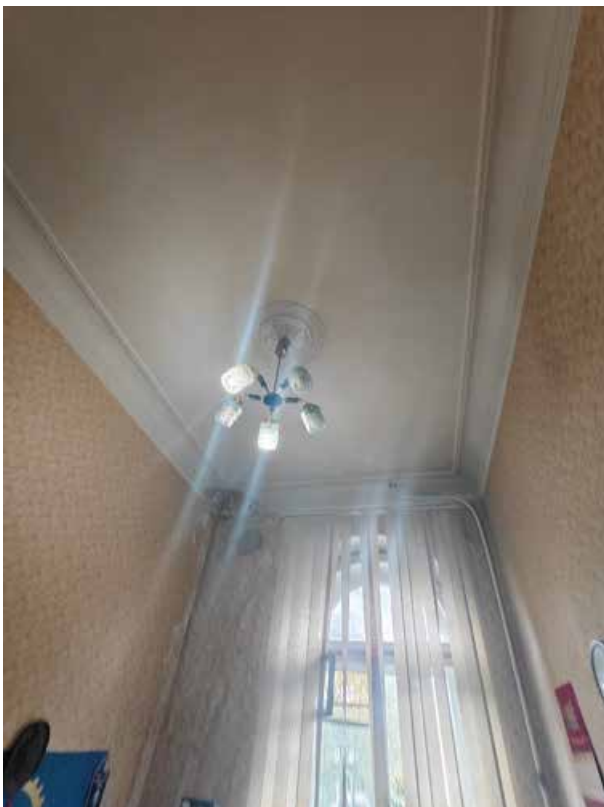
181. «Дом Жилой» (в составе «Дом фан Гильзе фан дер Пальса Г.Г.»), Английский пр., д. 8-10. Третий этаж. Помещение №100. Общий вид. Фото 05.05.2025г.
