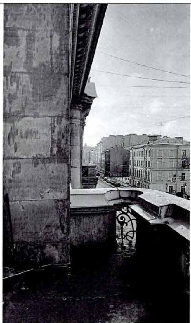
23. фрагмент лицевого фасада и балкона над входным порталом
