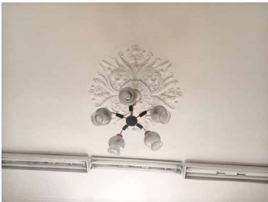
179. «Дом Жилой» (в составе «Дом фан Гильзе фан дер Пальса Г.Г.»), Английский пр., д. 8-10. Третий этаж. Помещение №102. Фрагмент. Фото 05.05.2025г.
