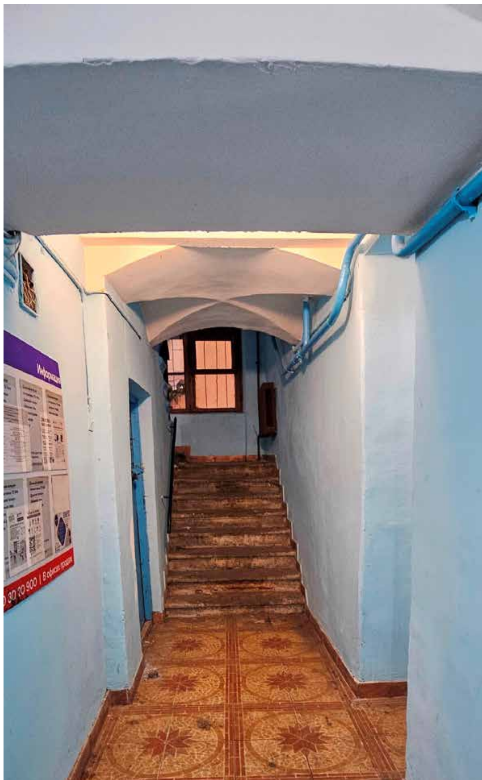
21. Выявленный объект культурного наследия «Дом П.И. Лихачева», Владимирский пр., д.3. Южная лестница западного дворового флигеля. Вестибюль.
