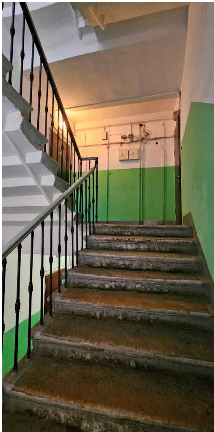
24. Выявленный объект культурного наследия «Дом П.И. Лихачева», Владимирский пр., д.3. Северная лестница западного дворового флигеля. Общий вид лестничных конструкций.
