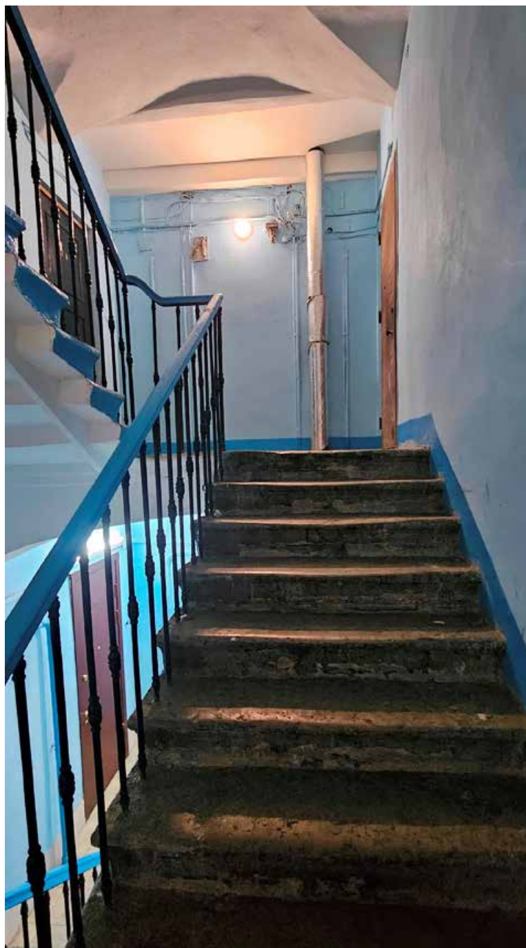
22. Выявленный объект культурного наследия «Дом П.И. Лихачева», Владимирский пр., д.3. Южная лестница западного дворового флигеля. Общий вид конструкций.
