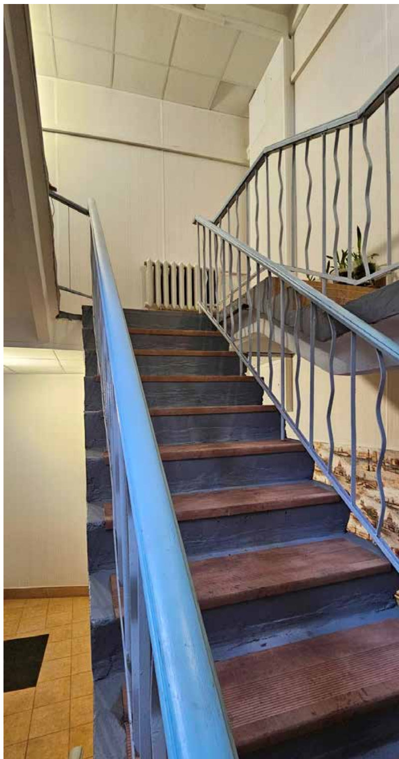
26. Выявленный объект культурного наследия «Дом П.И. Лихачева», Владимирский пр., д.3. Восточная лестница северного дворового флигеля. Вид лестничных конструкций.
