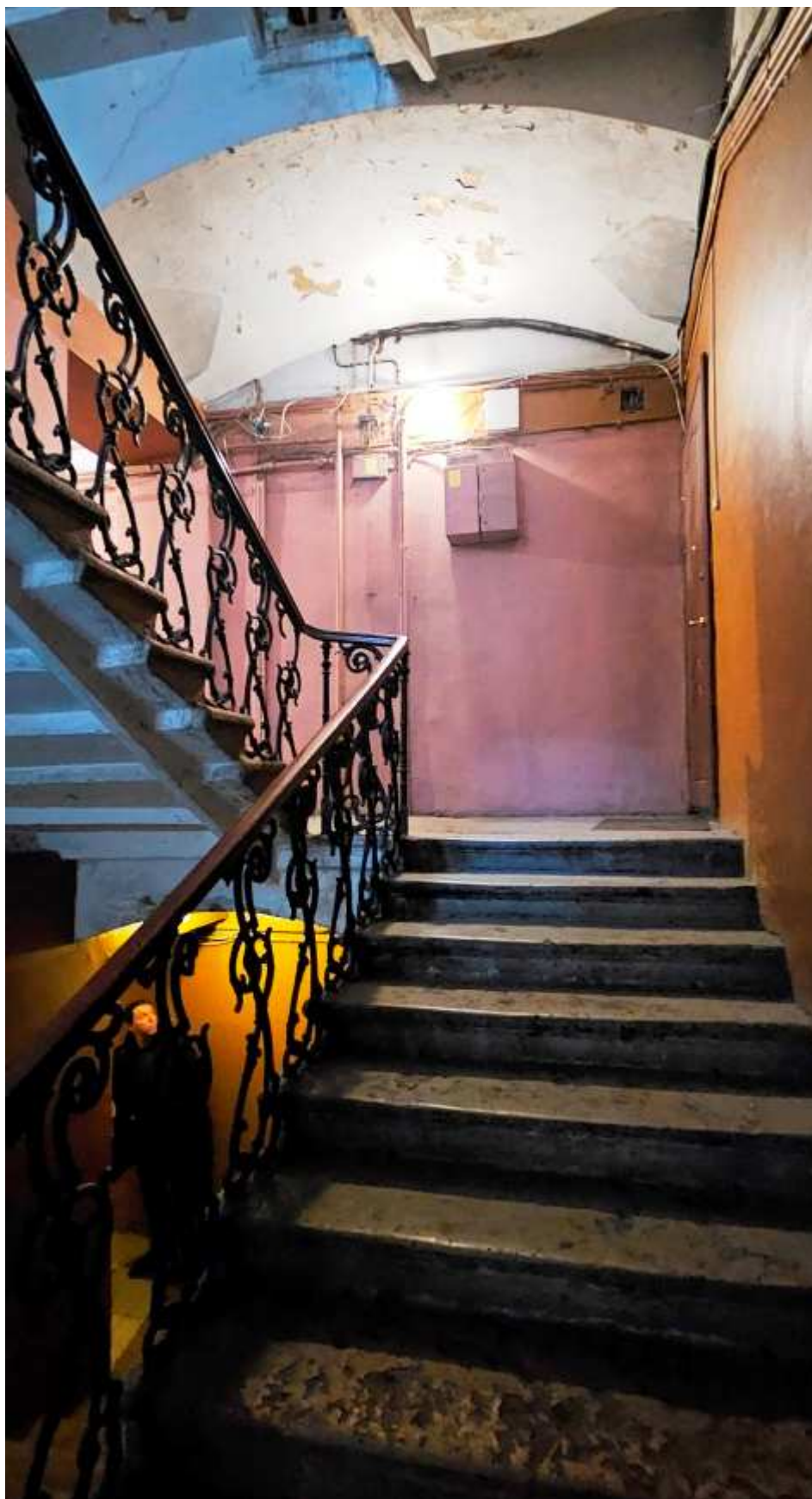
17. Выявленный объект культурного наследия «Дом П.И. Лихачева», Владимирский пр., д.3. Южная лестница лицевого дома. Лестничные конструкции.
