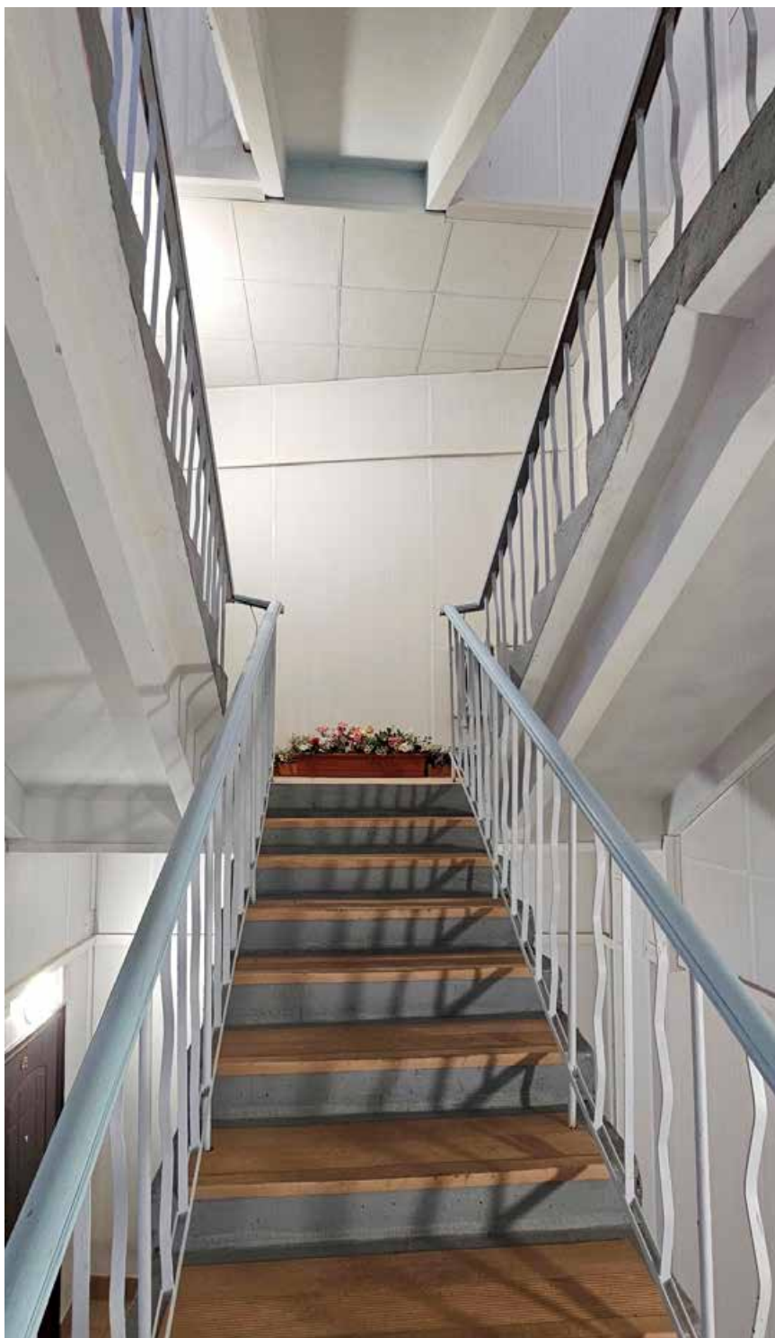
27. Выявленный объект культурного наследия «Дом П.И. Лихачева», Владимирский пр., д.3. Восточная лестница северного дворового флигеля. Общий вид лестничных конструкций.
