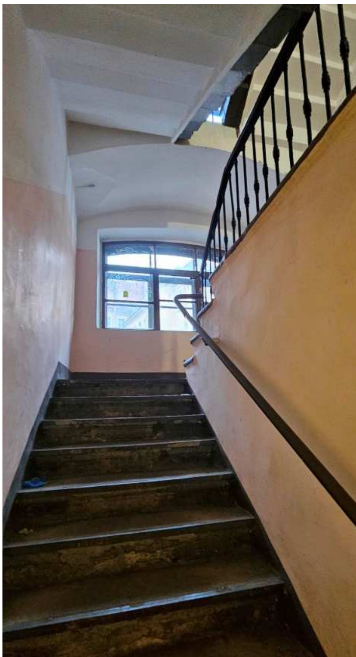
15. Выявленный объект культурного наследия «Дом П.И. Лихачева», Владимирский пр., д.3. Лестница южного дворового флигеля. Общий вид конструкций в уровне 1-го этажа.
