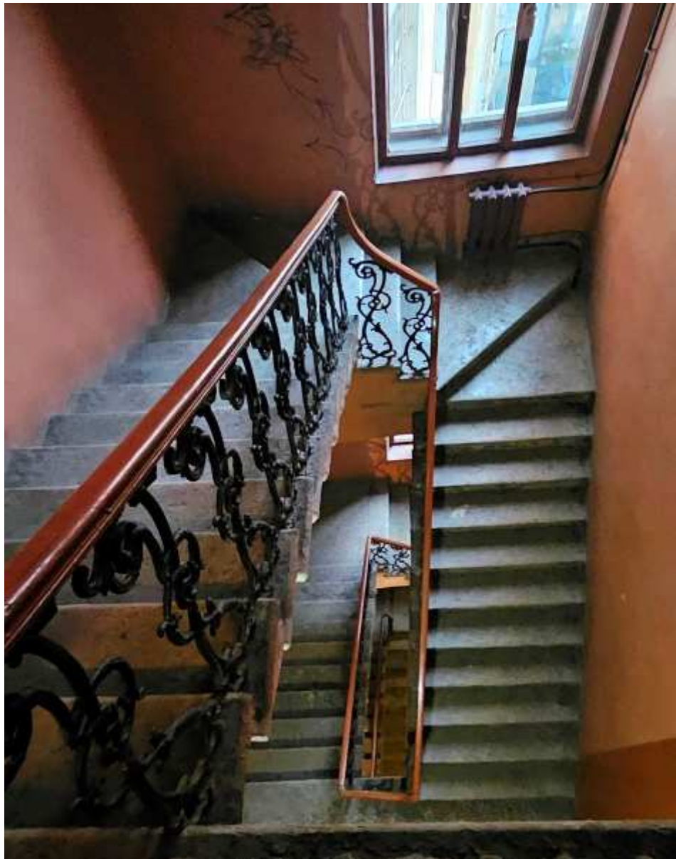
18. Выявленный объект культурного наследия «Дом П.И. Лихачева», Владимирский пр., д.3. Южная лестница лицевого дома. Общий вид лестничной клетки.
