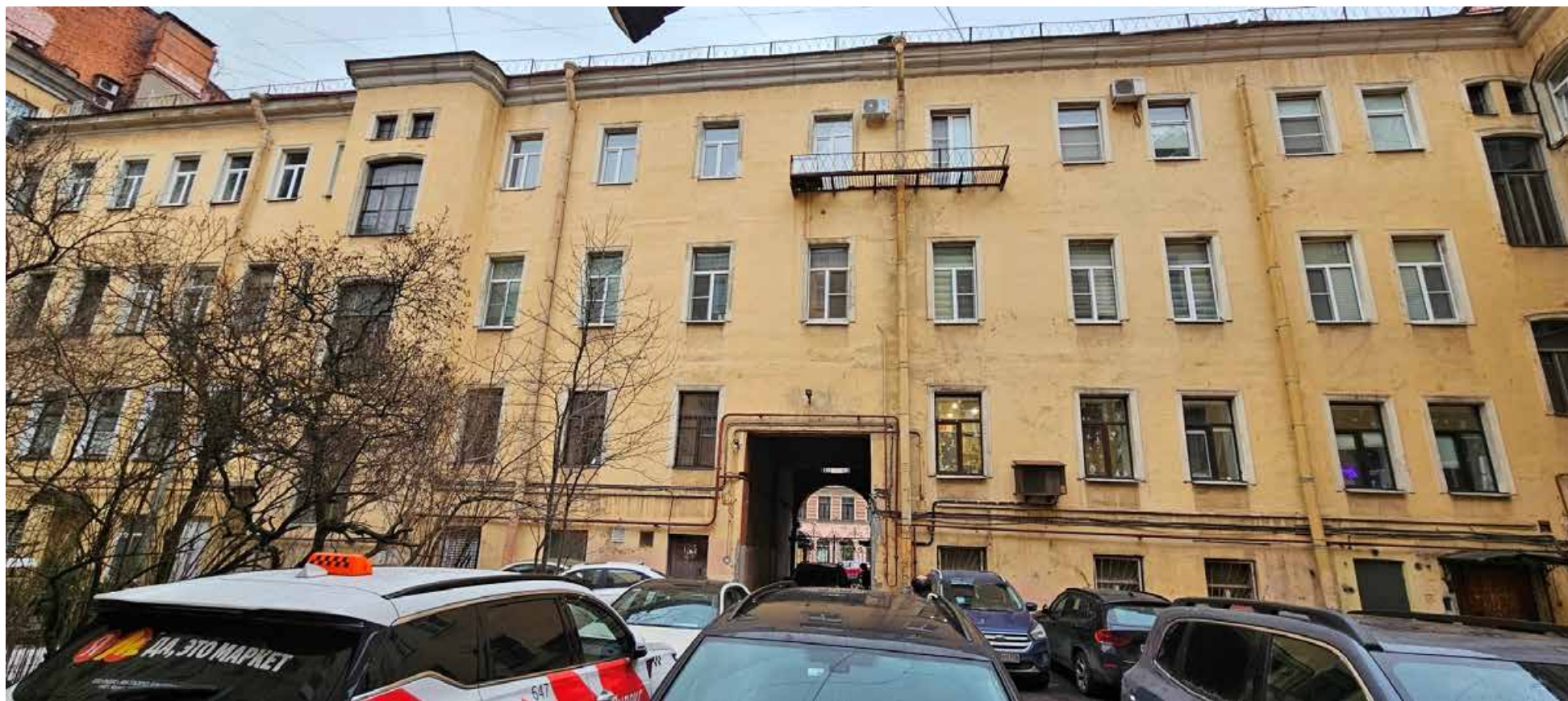
7. Выявленный объект культурного наследия «Дом П.И. Лихачева», Владимирский пр., д.3. Дворовый фасад лицевого дома.
