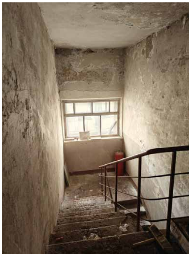
Фото 17. Интерьер помещений 3-го этажа здания на территории объекта культурного наследия регионального значения «Круглая баня»
