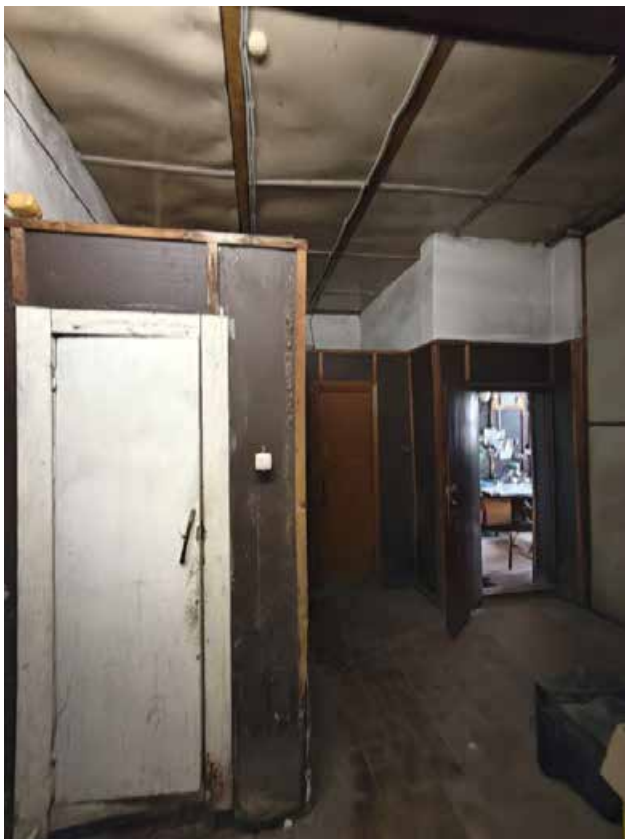
Фото 13. Интерьер помещений 1-го этажа здания на территории объекта культурного наследия регионального значения «Круглая баня»
