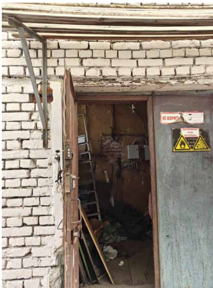
Фото 8. Интерьер помещений 1-го этажа здания на территории объекта культурного наследия регионального значения «Круглая баня»
