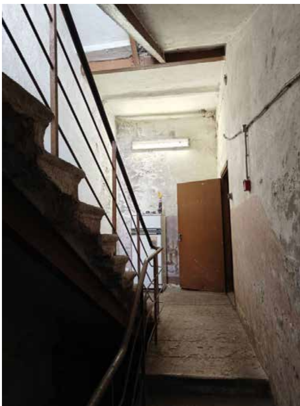
Фото 14. Интерьер помещений 1-го этажа здания на территории объекта культурного наследия регионального значения «Круглая баня»
