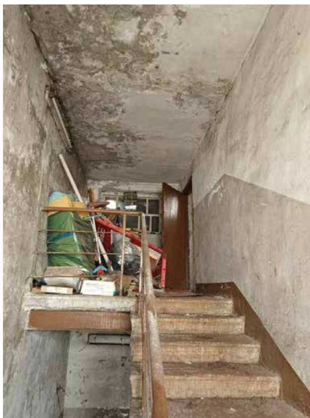
Фото 16. Интерьер помещений 3-го этажа здания на территории объекта культурного наследия регионального значения «Круглая баня»
