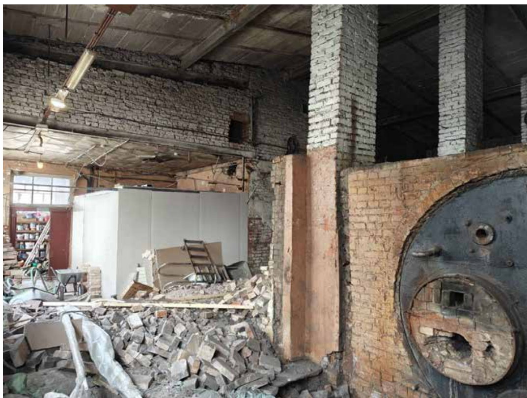
Фото 10. Интерьер помещений 1-го этажа здания на территории объекта культурного наследия регионального значения «Круглая баня»
