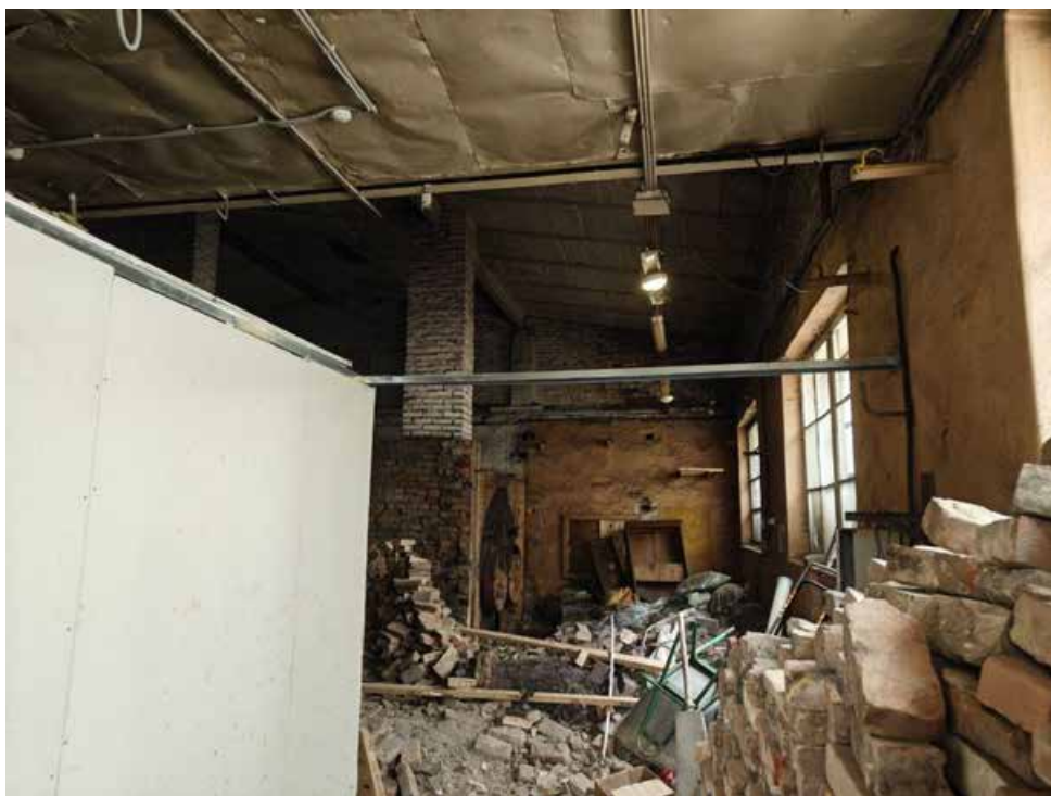
Фото 9. Интерьер помещений 1-го этажа здания на территории объекта культурного наследия регионального значения «Круглая баня»
