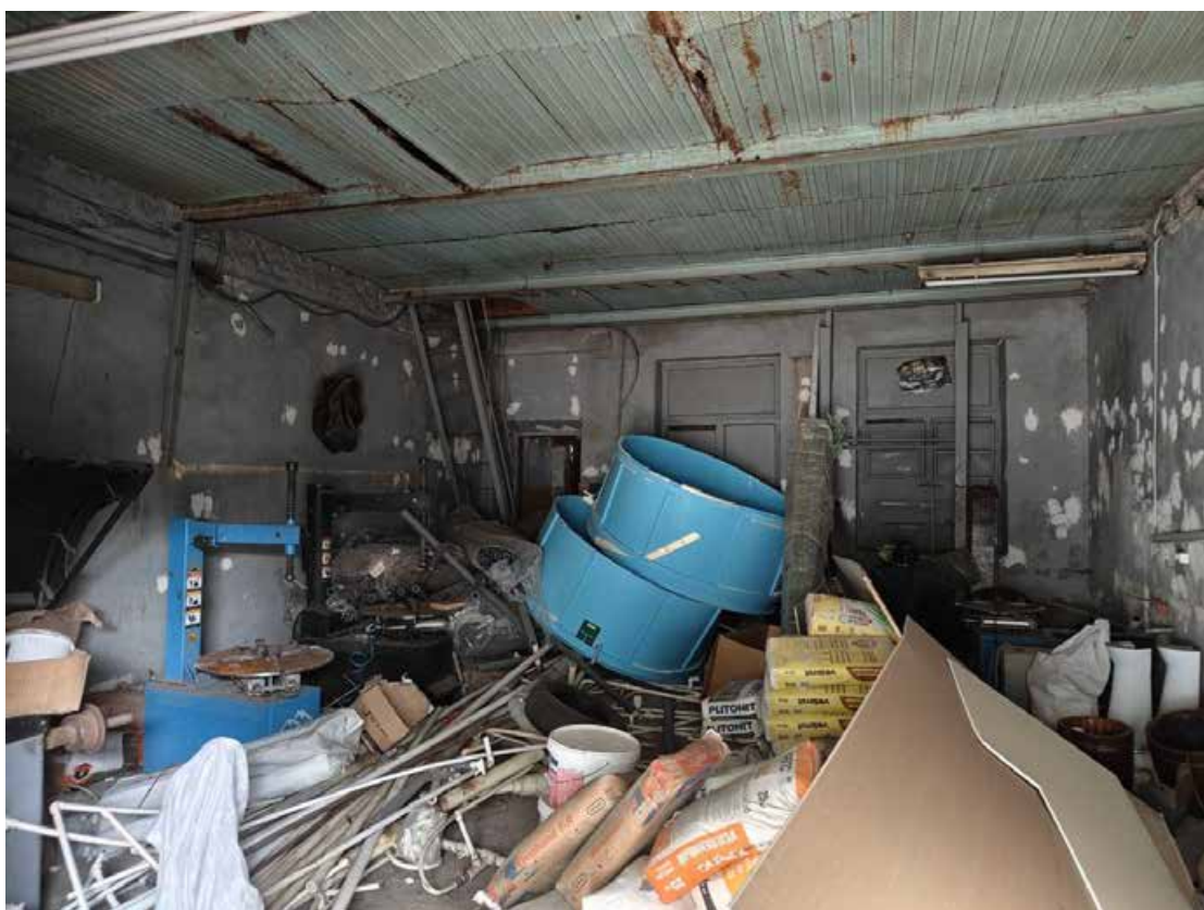
Фото 12. Интерьер помещений 1-го этажа здания на территории объекта культурного наследия регионального значения «Круглая баня»
