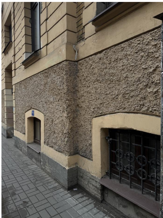
Фот. 7. Фрагмент лицевого юго-западного фасадов по ул. Большая Зеленина
