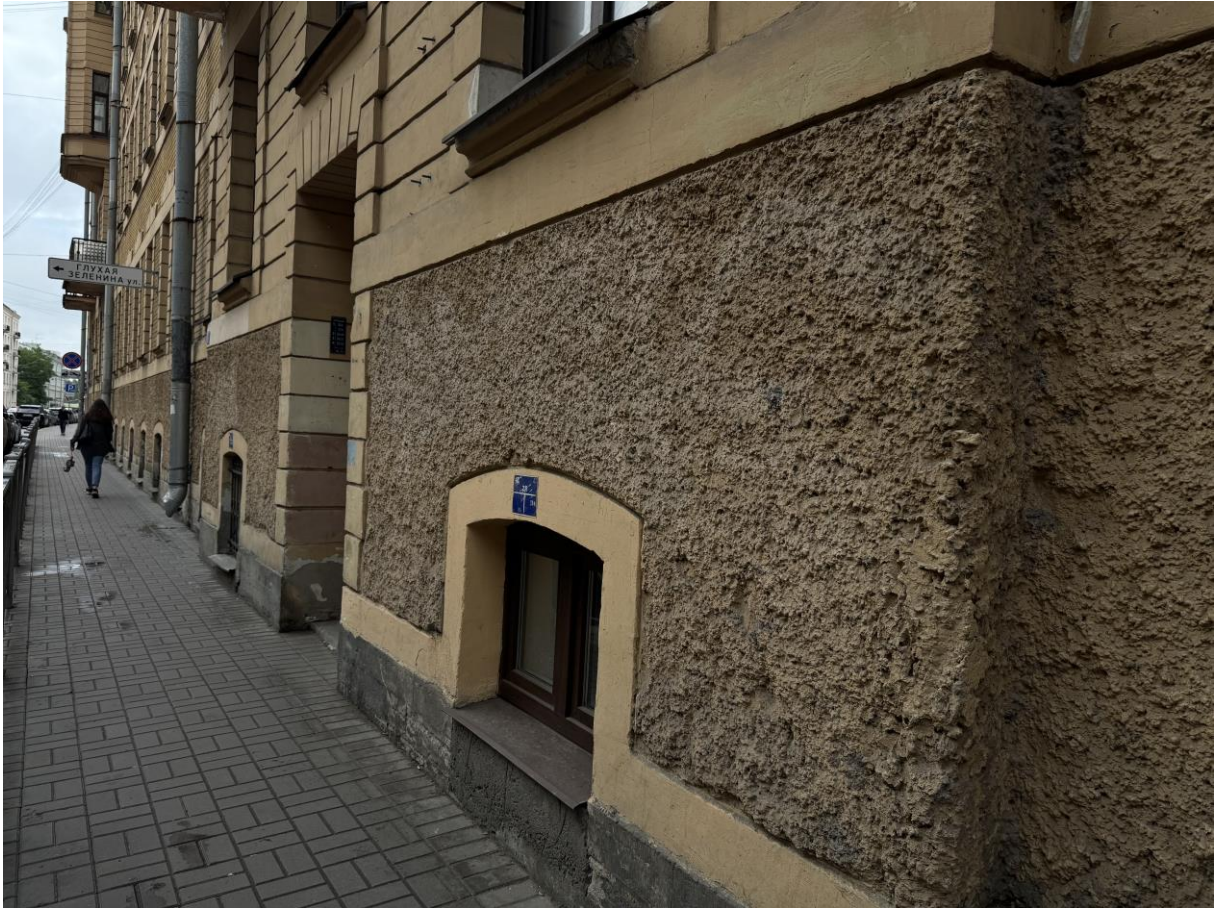
Фот. 9. Фрагмент лицевого юго-западного фасада по ул. Большой Зеленина
