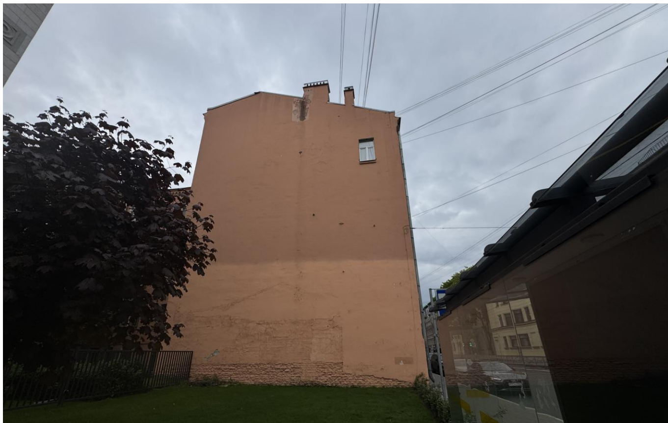
Фот. 6. Вид на торцевой фасад выявленного объекта культурного наследия «Дом А.Ю. Кейбеля»
