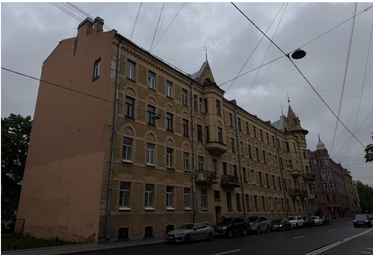
Фот. 4. Вид на лицевой юго-западный фасад по ул. Большая Зеленина выявленного объекта культурного наследия «Дом А.Ю. Кейбеля» и участок производства работ по реконструкции водопроводных сетей
