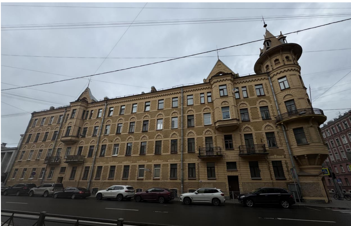
Фот. 5. Вид на лицевой юго-западный фасад по ул. Большая Зеленина выявленного объекта культурного наследия «Дом А.Ю. Кейбеля»
