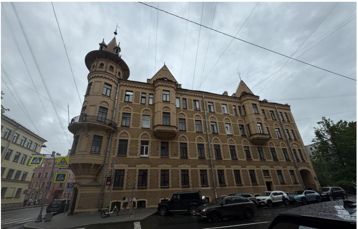
Фот. 3 Вид на лицевой юго-восточный фасад по ул. Барочной выявленного объекта культурного наследия «Дом А.Ю. Кейбеля»
