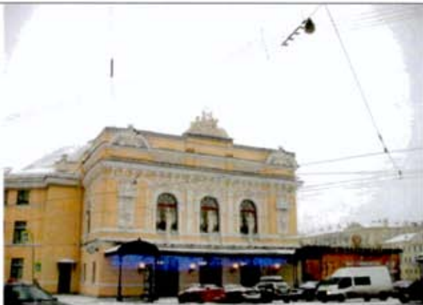
1. Лицевой фасад. Общий вид.
