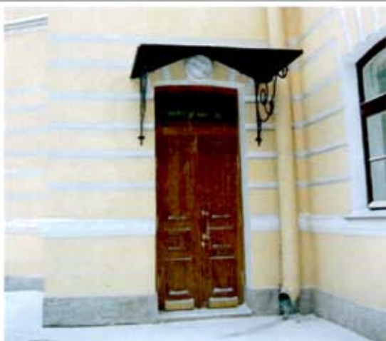
11. Юго-западный фасад полуциркульного объема. Дверной проем.
