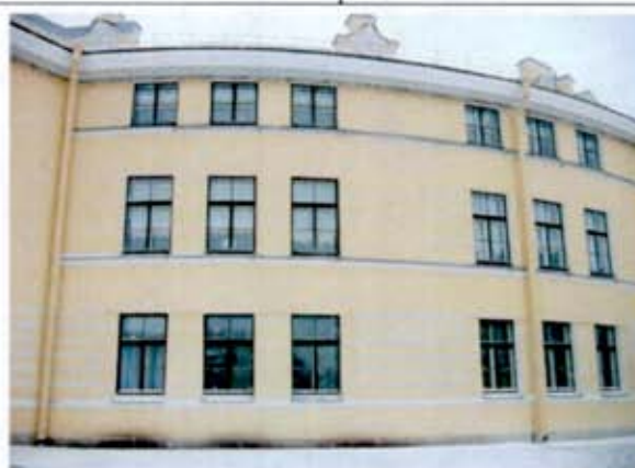
16. Юго-восточный фасад полуциркульного объема. Общий вид
