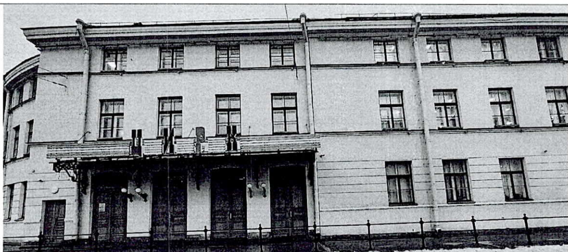
Фото 2. Фрагмент лицевого фасада
