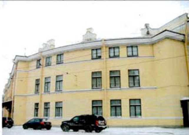
10. Юго-западный фасад полуциркульного объема. Общий вид.
