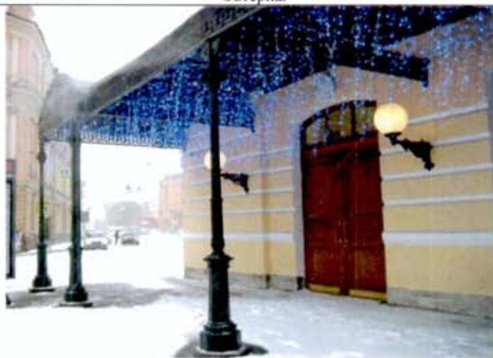
5. Лицевой фасад. Металлические опорные колонки, «зонтик» над главным входом в здание.
