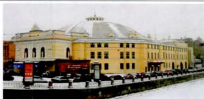
15. Лицевой фасад, юго-восточный фасад полуциркульного объема, восточный фасад. Общий вид.
