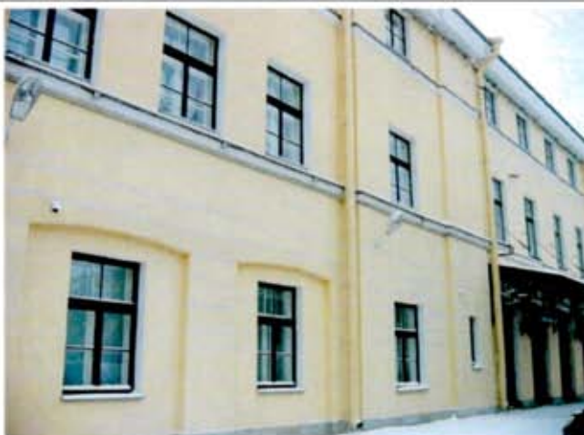
12. Фрагмент западного фасада.
