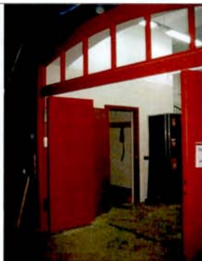
22. Помещения 1-го этажа. Дверные проемы в помещении форганга.
