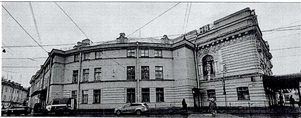
Фото 3. Фрагмент лицевого фасада
