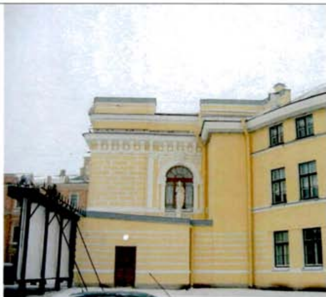
8. Юго-восточный фасад центрального ризалита. Общий вид
