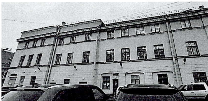
Фото 3. Фрагмент лицевого фасада
