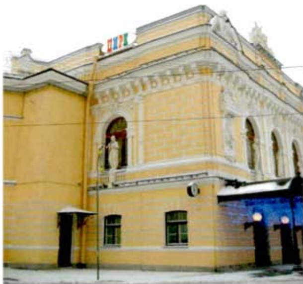
7. Юго-западный фасад центрального ризалита. Общий вид
