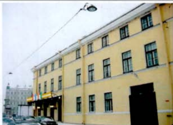
17. Фрагмент восточного фасада.
