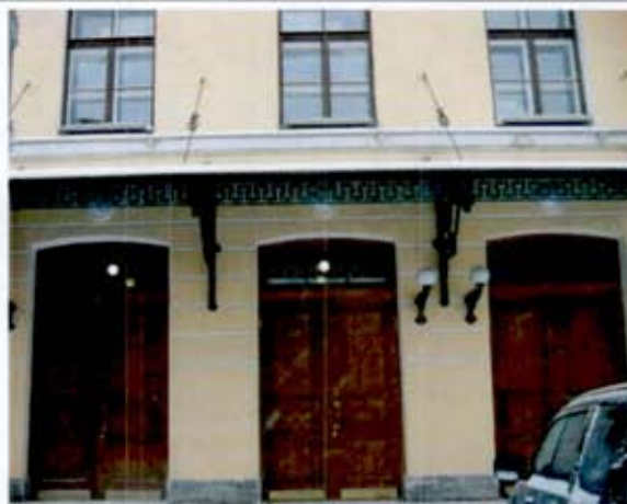
14. Западный фасад. Дверные проемы, металлический козырек
