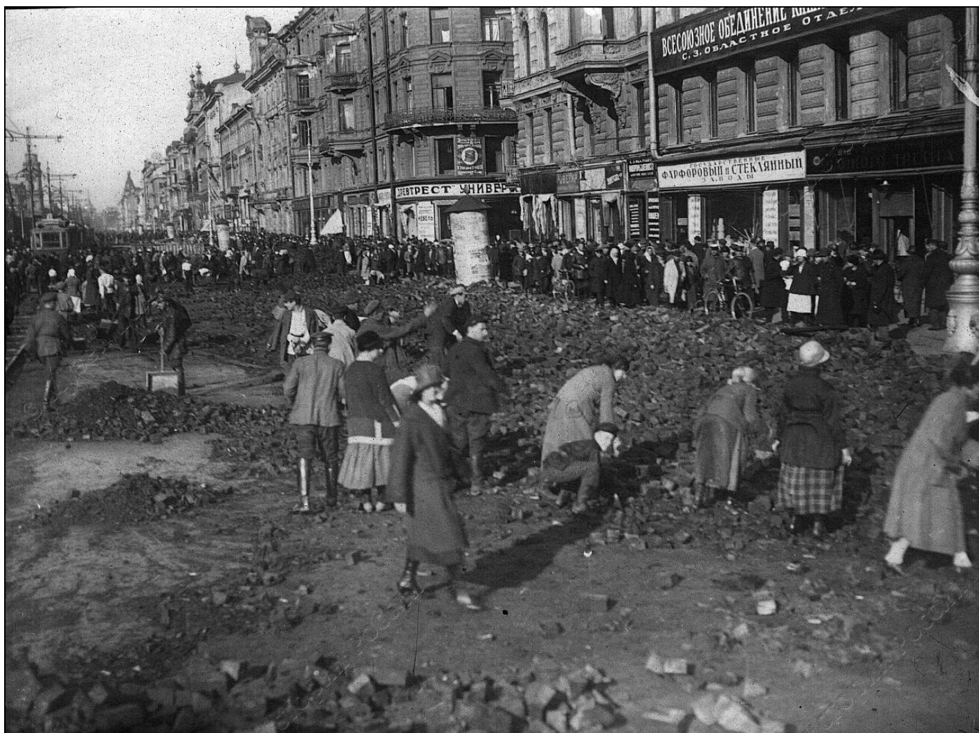
Илл. 39. Работы по восстановлению мостовой проспекта 25 Октября, разрушенной во время наводнения. Фотография. 1924 г. Автор съемки: неизвестен.
