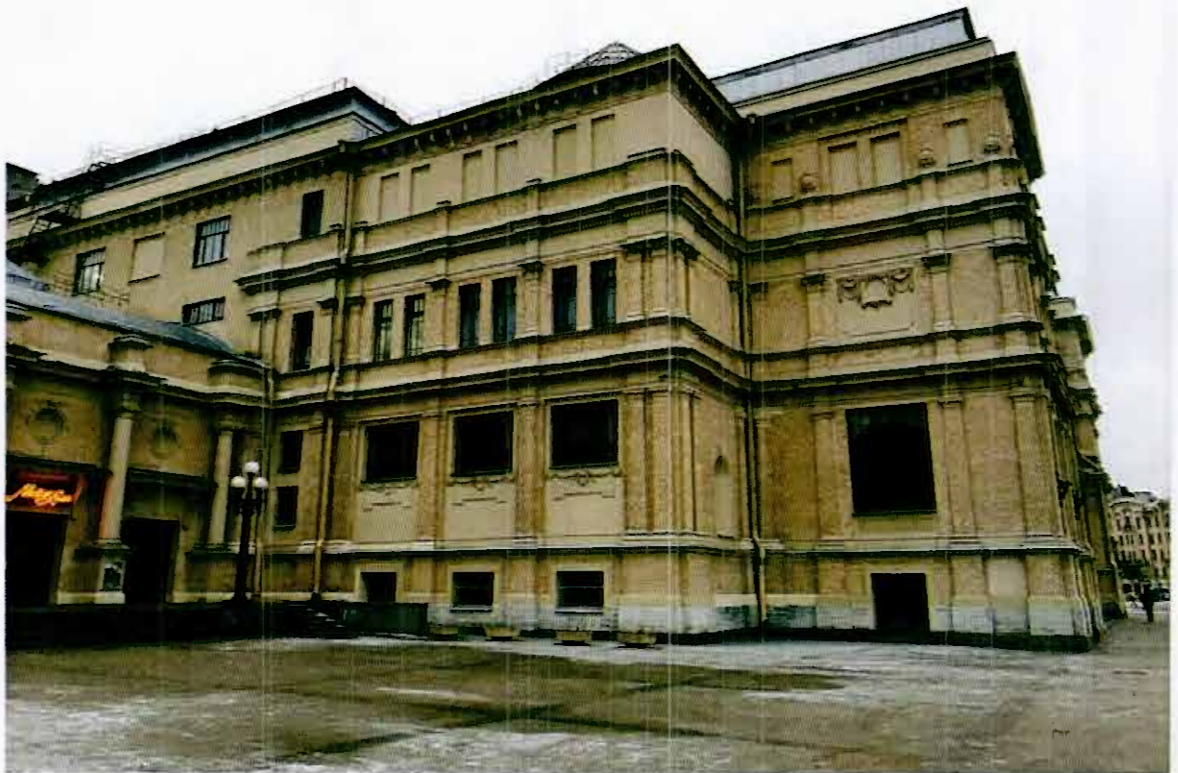
Фото 3. Восточный фасад (лицевой фасад).
