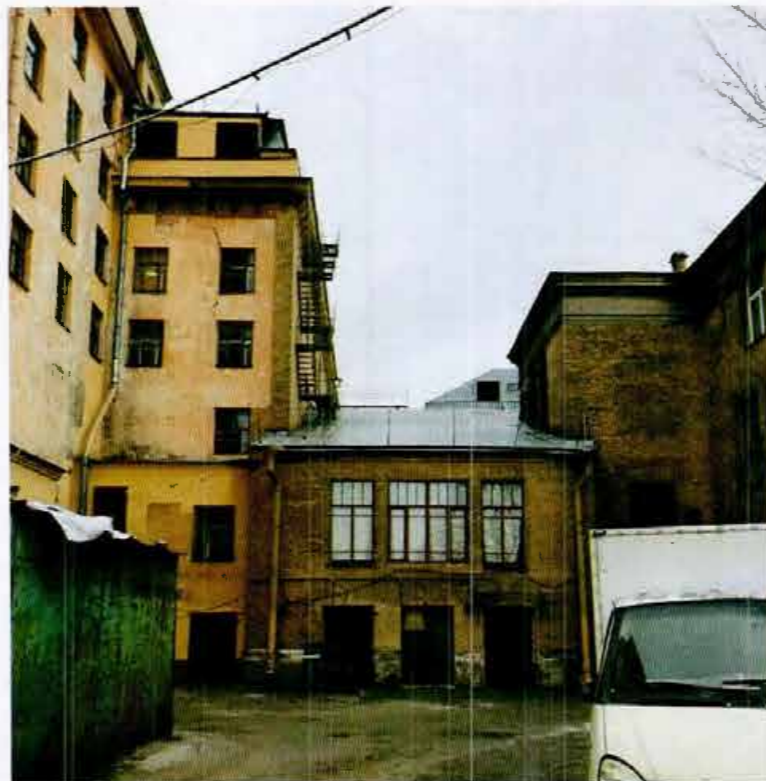
Фото 6. Фрагмент южного (дворового) фасада.
