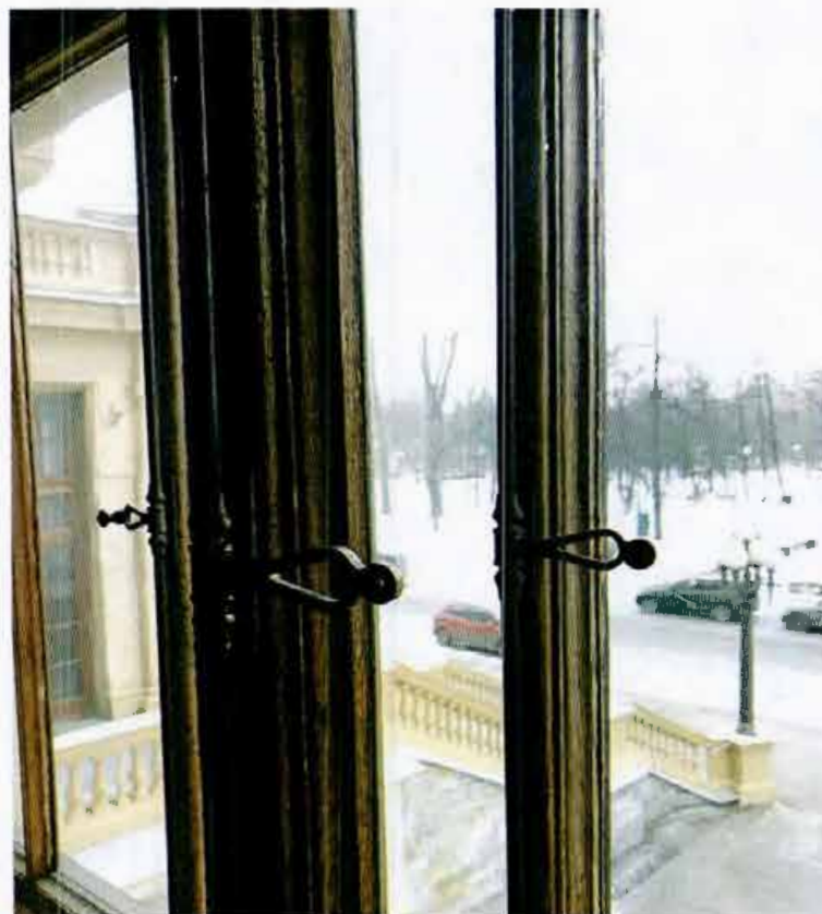
Фото 10. Шпингалеты оконного проема парадной лестницы.
