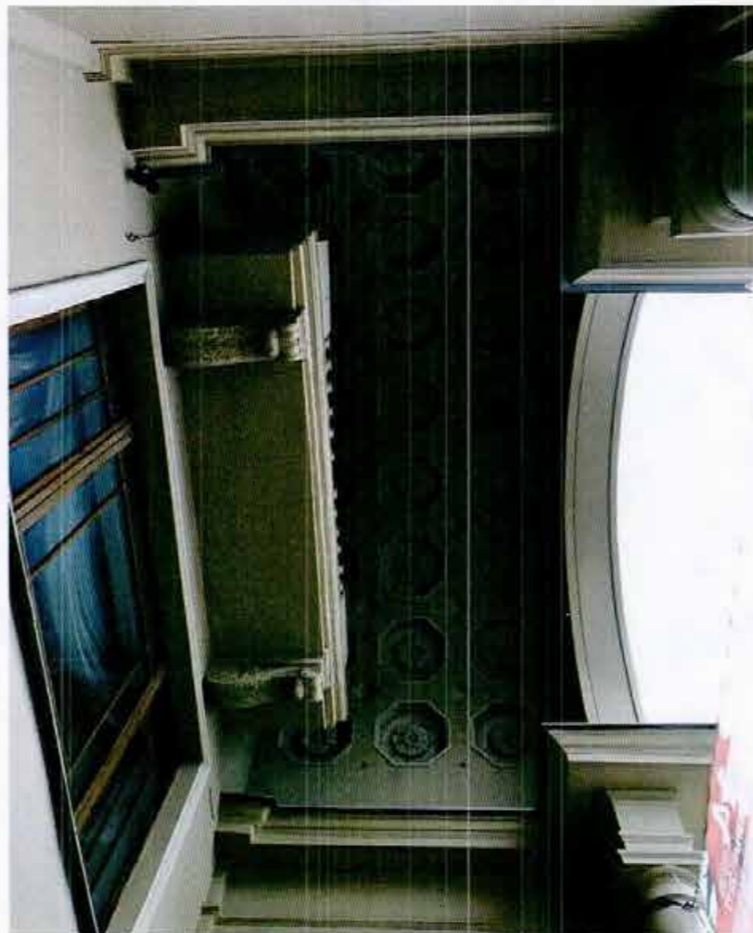
Фото 7. Северный фасад. Своды лоджий. Фрагмент.
