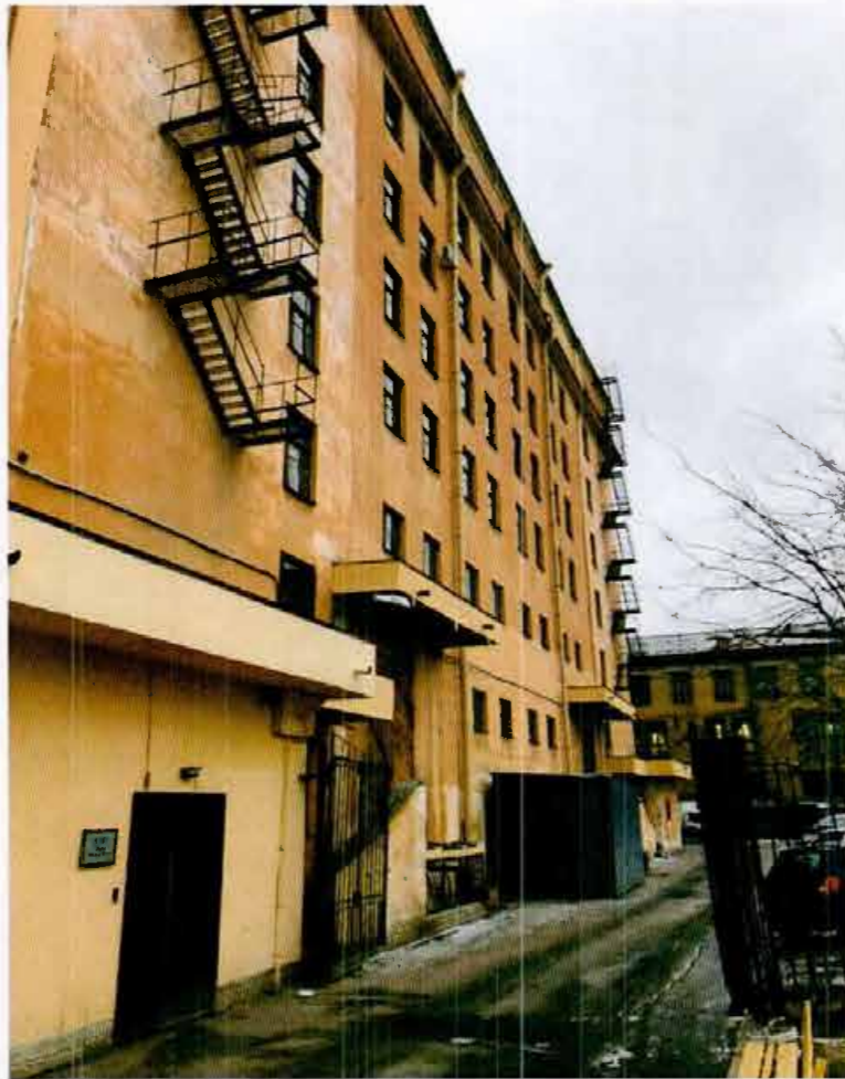
Фото 5. Фрагмент южного (дворового) фасада.
