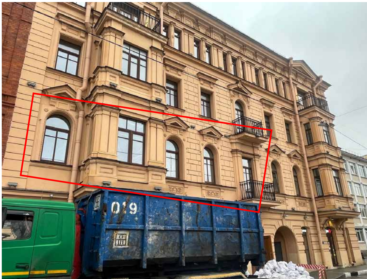
5. Общий вид лицевого фасада по набережной Адмиралтейского канала. Красной линией выделены оконные проемы помещений 96-Н и 97-Н.
