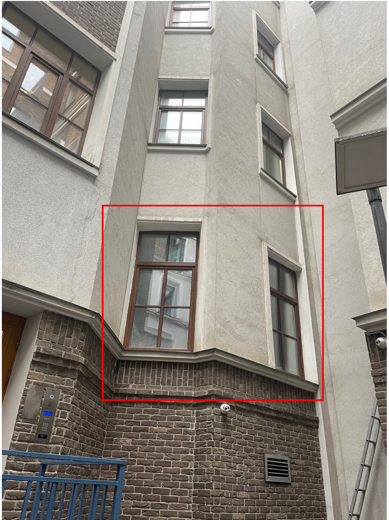
3. Фрагмент дворового фасада со стороны. Красной линией выделены оконные проемы помещения 97-Н.
