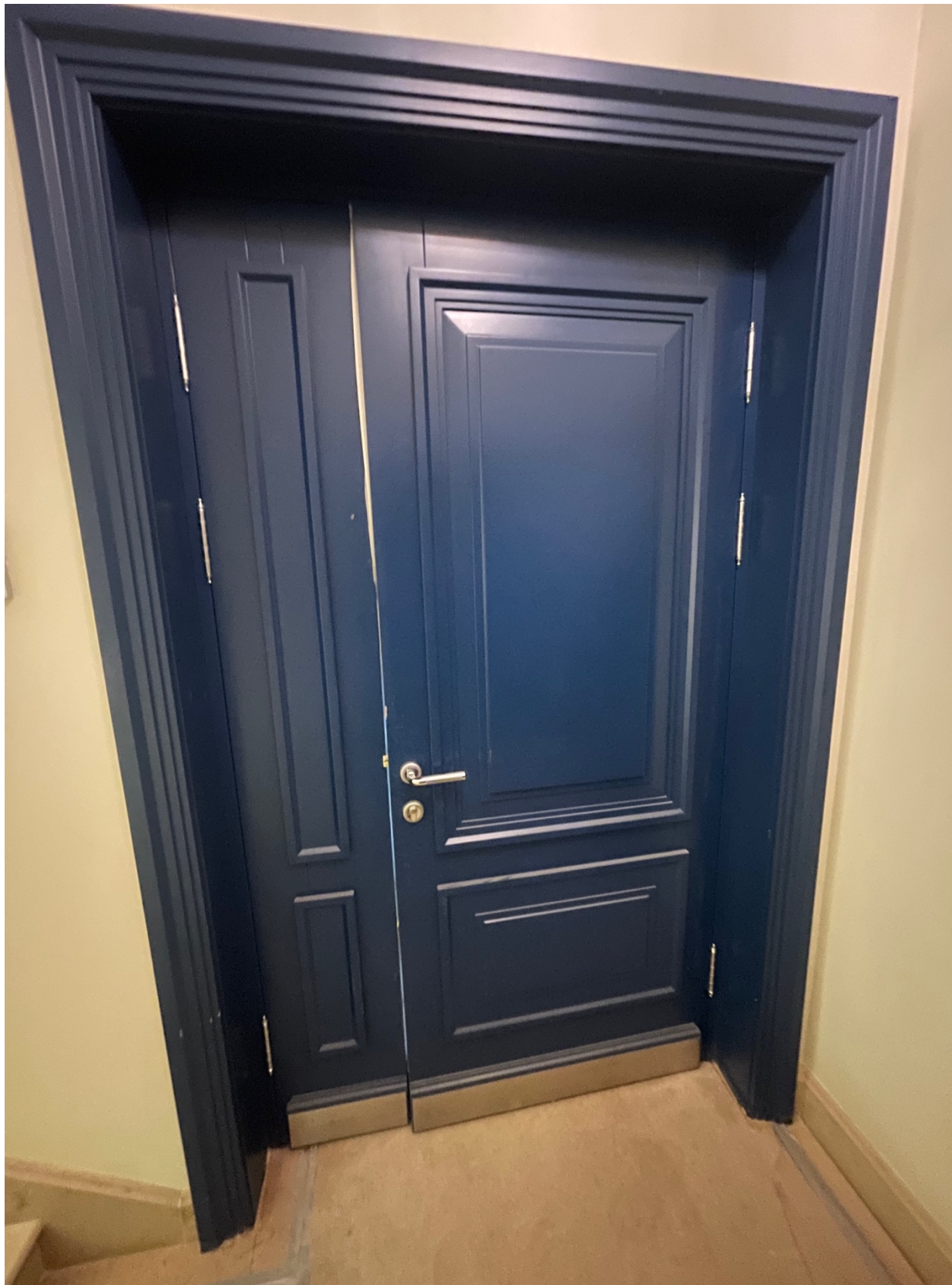
7. Входная дверь в помещение 96-Н.
