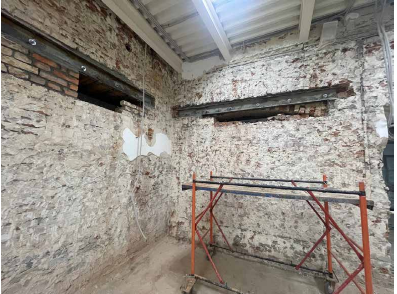
14. Помещение 96-Н(2) (согласно техническому паспорту). Дверные проемы в капитальных стенах с усилением металлоконструкциями (швеллерами).
