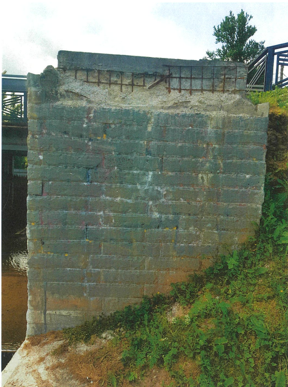
4. Выщелачивание шовного раствора. Утрата отдельных блоков облицовки
