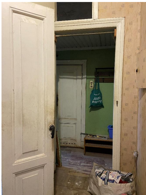
Фото 2. Вид на коридор.
