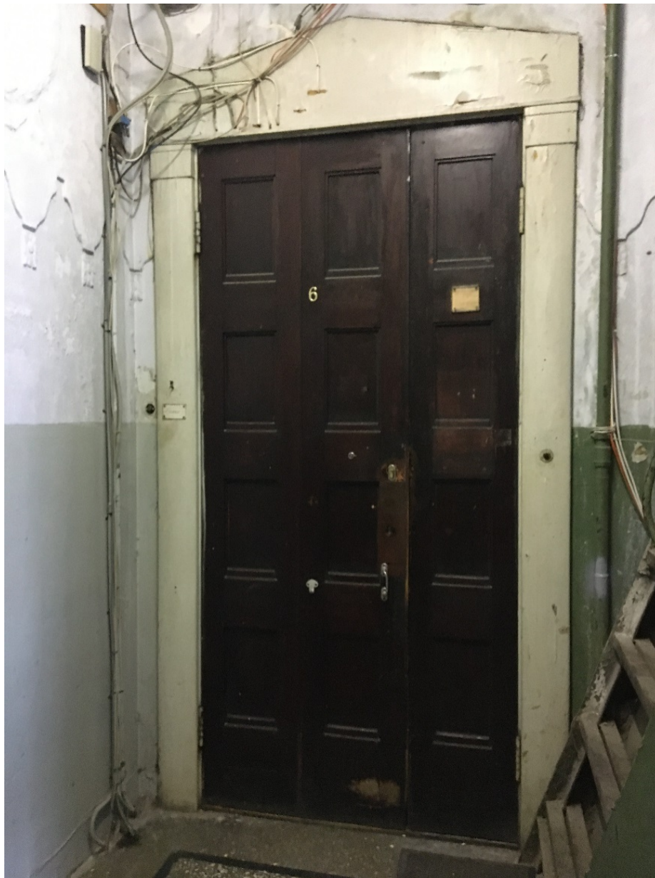
22. Парадная лестница 1ЛК. Оформление дверного проема квартиры № 6.
