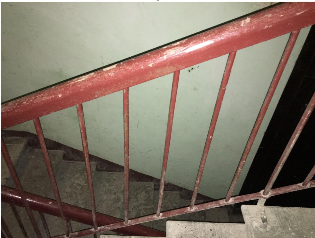
26. Лестница 2ЛК. Ограждения лестницы.
