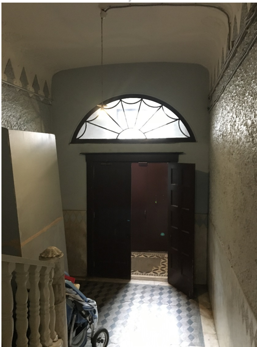
14. Парадная лестница 1ЛК. Вестибюль. Общий вид.
