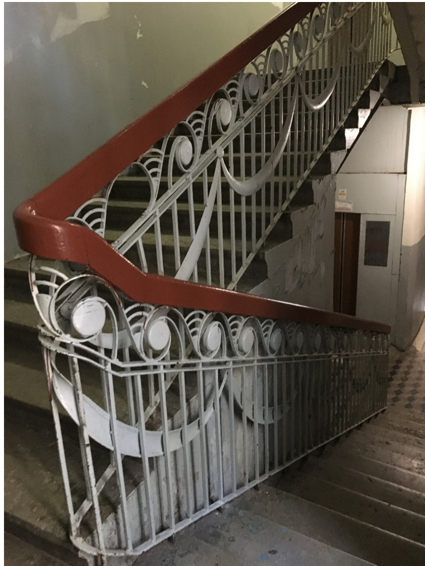
18. Парадная лестница 1ЛК. Ограждения лестницы.
