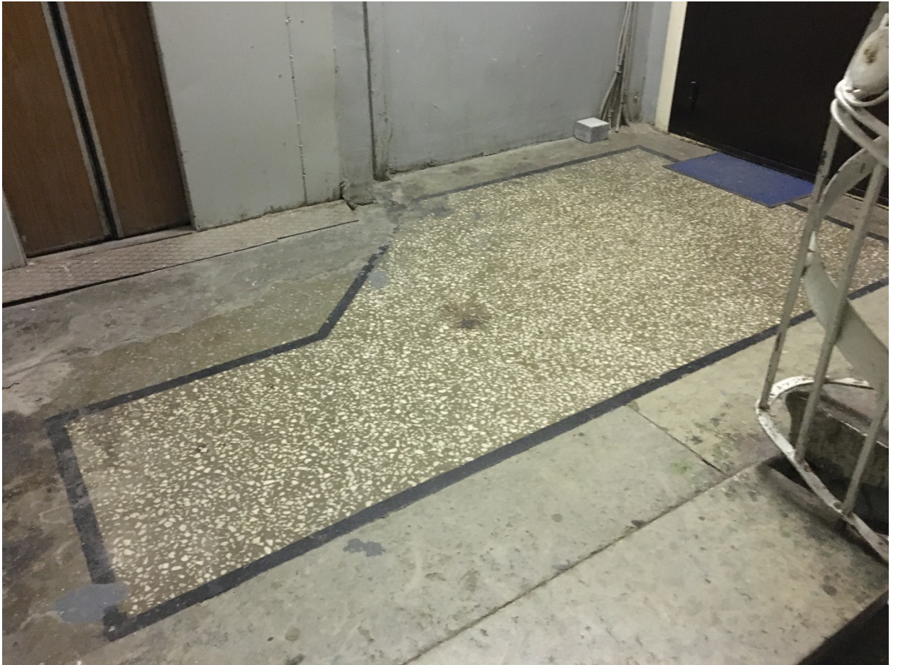
19. Парадная лестница 1ЛК. Площадка 2 этажа. Покрытие пола.
