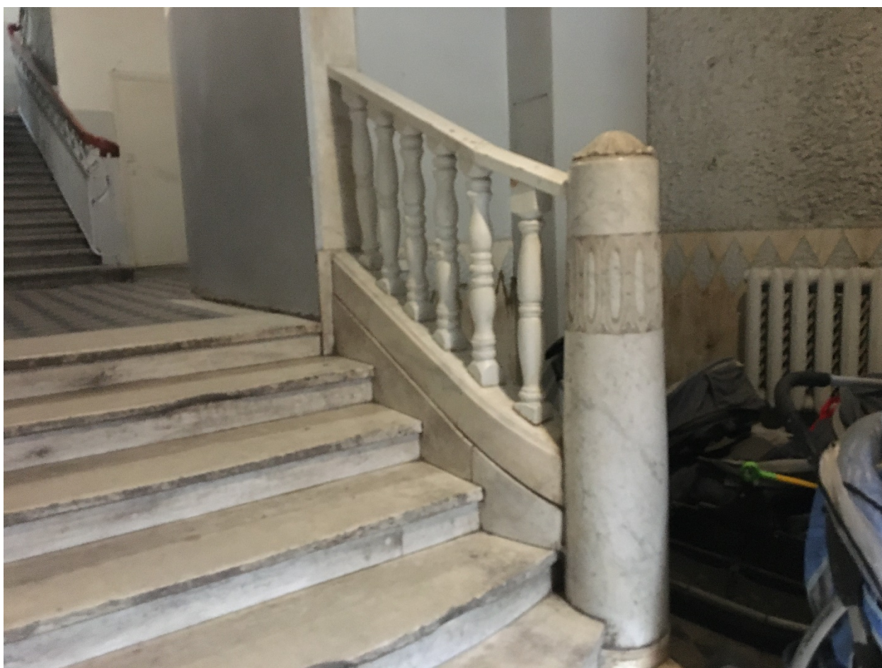
15. Парадная лестница 1ЛК. Ограждение лестницы вестибюля.
