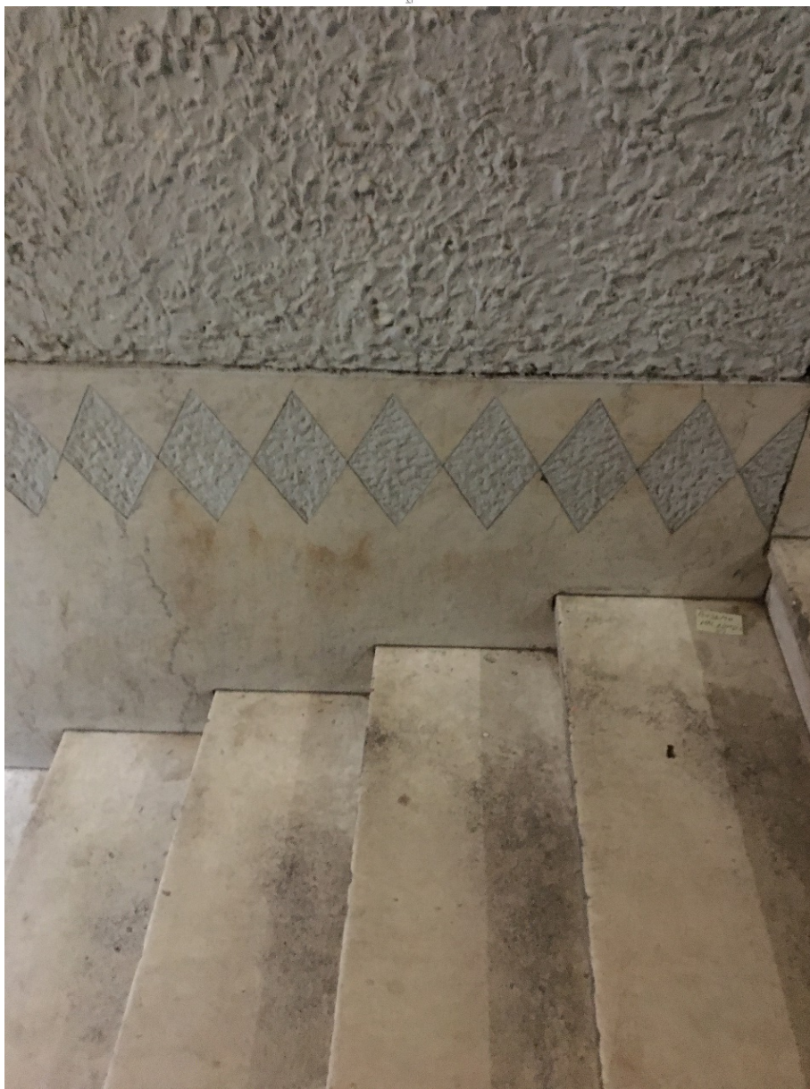
16. Парадная лестница 1ЛК. Оформление стен.
