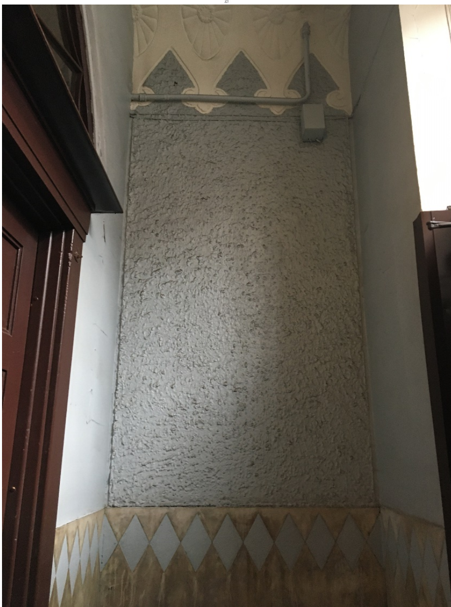
13. Парадная лестница 1ЛК. Тамбур. Оформление стен.
