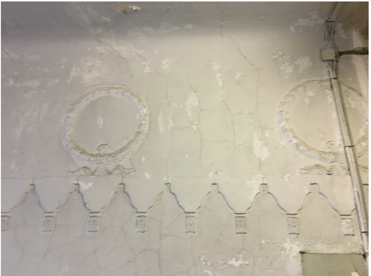
24. Парадная лестница 1JK. Оформление стен в уровне 5 этажа.
