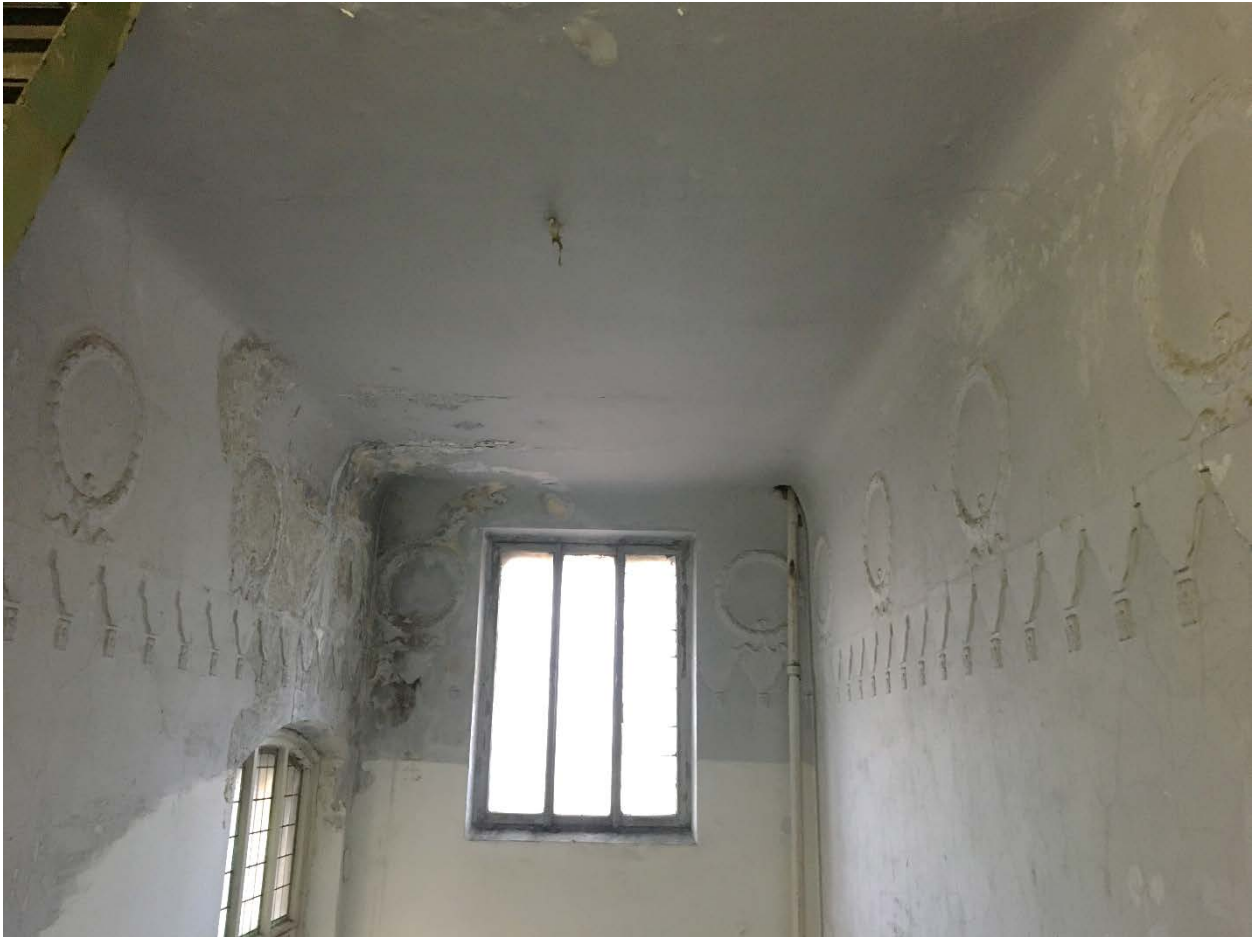
23. Парадная лестница 1ЛК. Перекрытие объема лестницы.
