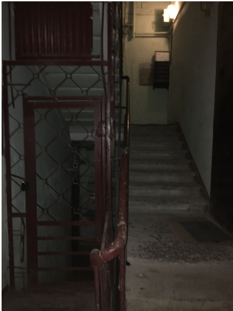
25. Лестница 2ЛК. Площадка 1 этажа.
