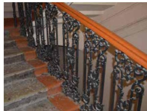
лестница ЛК3 - местоположение, габариты, тип (средистенная), конструкция (на косоурах) и конфигурация лестницы (трехмаршевая с поворотом), материал ступеней (лещадная плита);
