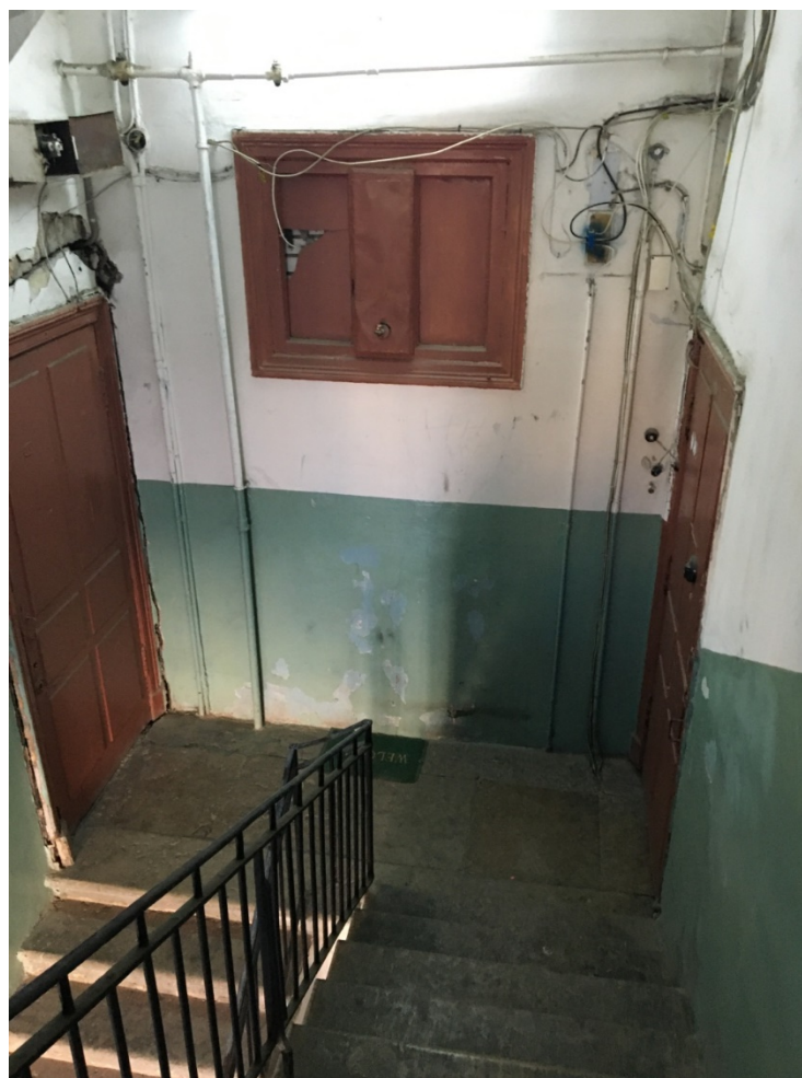
41. Лестница Л-4. Площадка 4 этажа.
