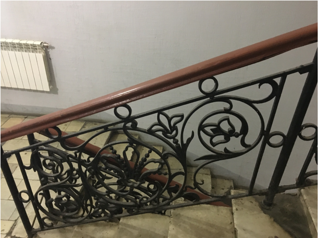
25. Парадная лестница Л-1. Ограждение лестницы.
