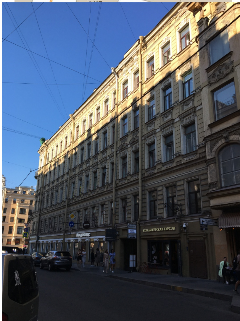
13. Лицевой фасад по улице Рубинштейна выявленного объекта культурного наследия «Дом И.И. Ростовцева», расположенного по адресу: г. Санкт-Петербург, Невский пр., 45; Рубинштейна ул., 2. Фрагмент.
