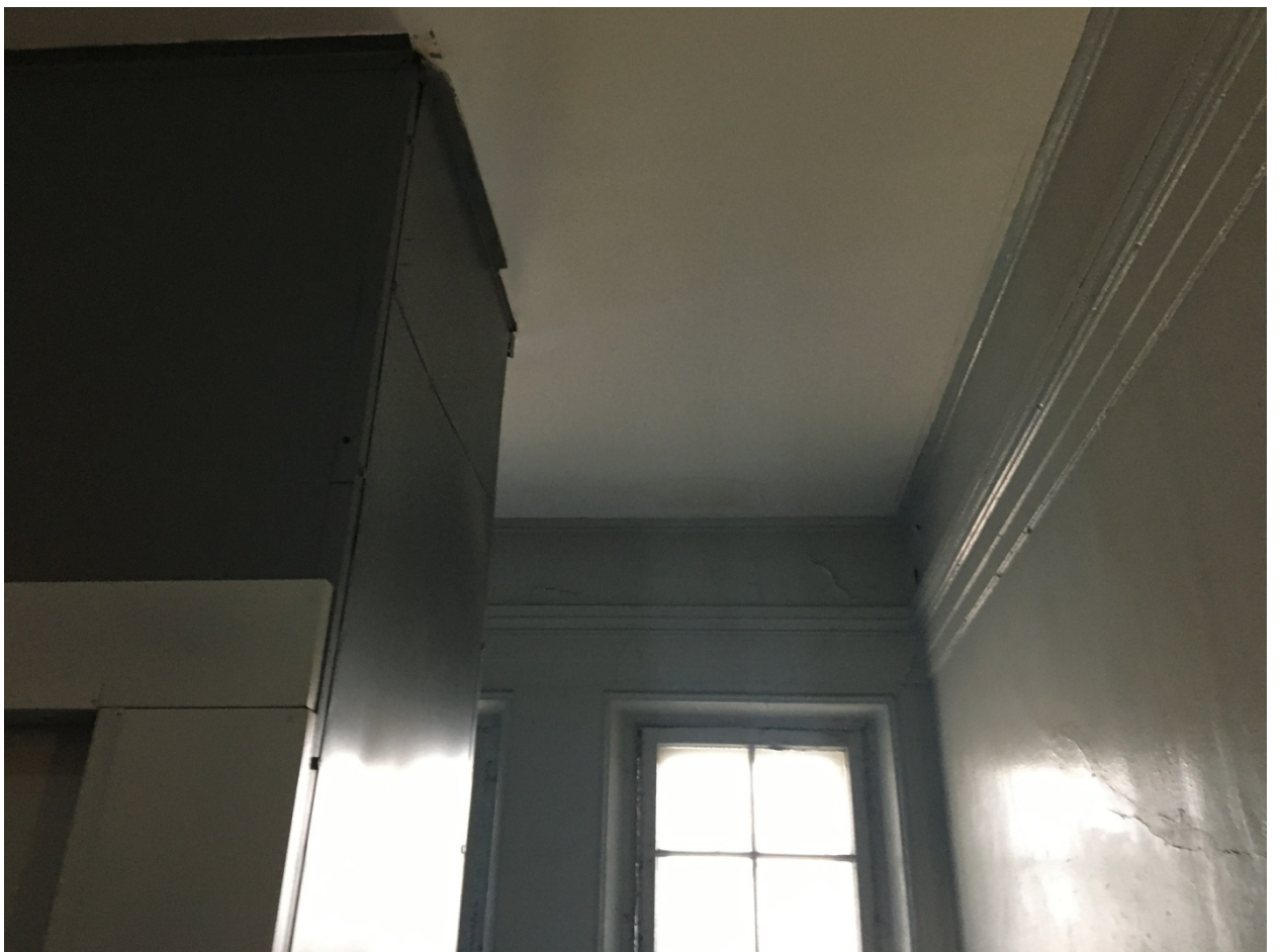
38. Парадная лестница Л-2. Оформление перекрытия лестничного объема.
