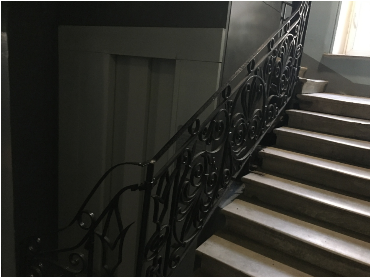
34. Парадная лестница Л-2. Ограждение лестницы.
