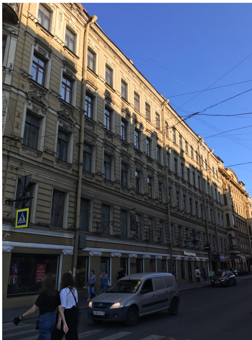
12. Лицевой фасад по улице Рубинштейна выявленного объекта культурного наследия «Дом И.И. Ростовцева», расположенного по адресу: г. Санкт-Петербург, Невский пр., 45; Рубинштейна ул., 2..
