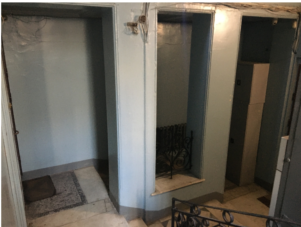
36. Парадная лестница Л-2. Площадка 2 этажа.
