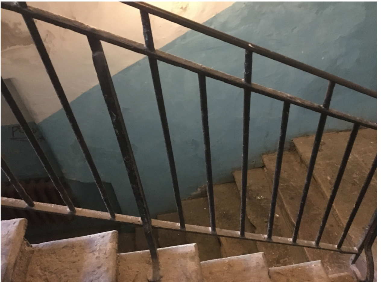
40. Лестница Л-4. Ограждение лестницы.
