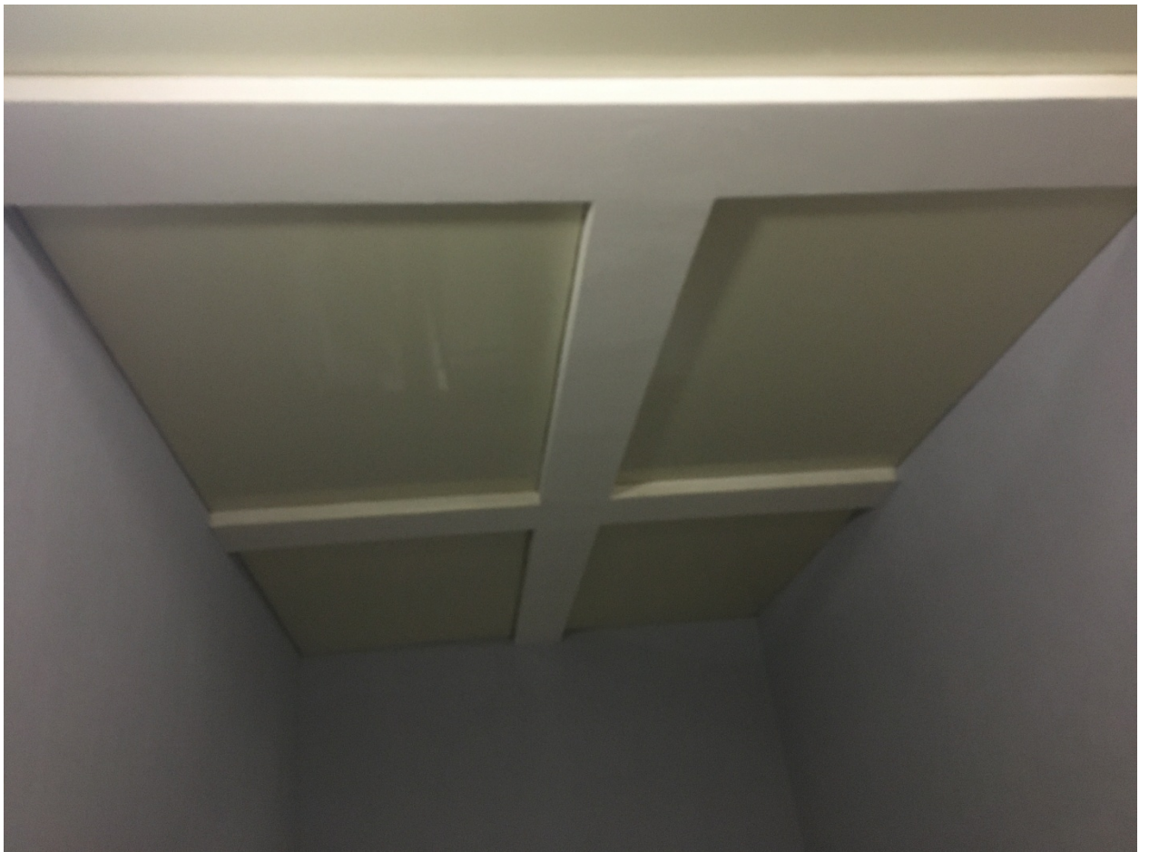
31. Парадная лестница Л-1. Перекрытие объема лестницы.
