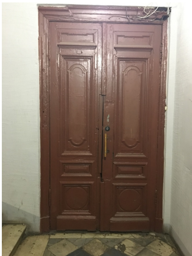
27. Парадная лестница Л-1. Дверное заполнение квартиры № 9.
