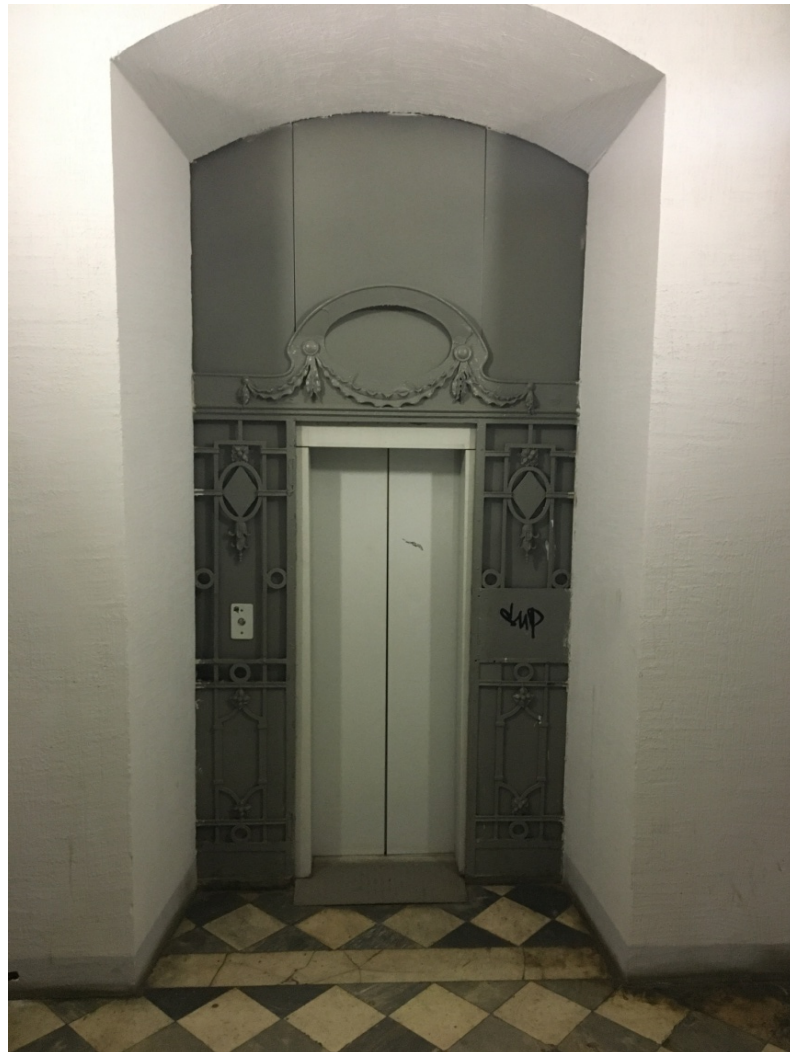
28. Парадная лестница Л-1. Площадка между 3 и 4 этажами.
