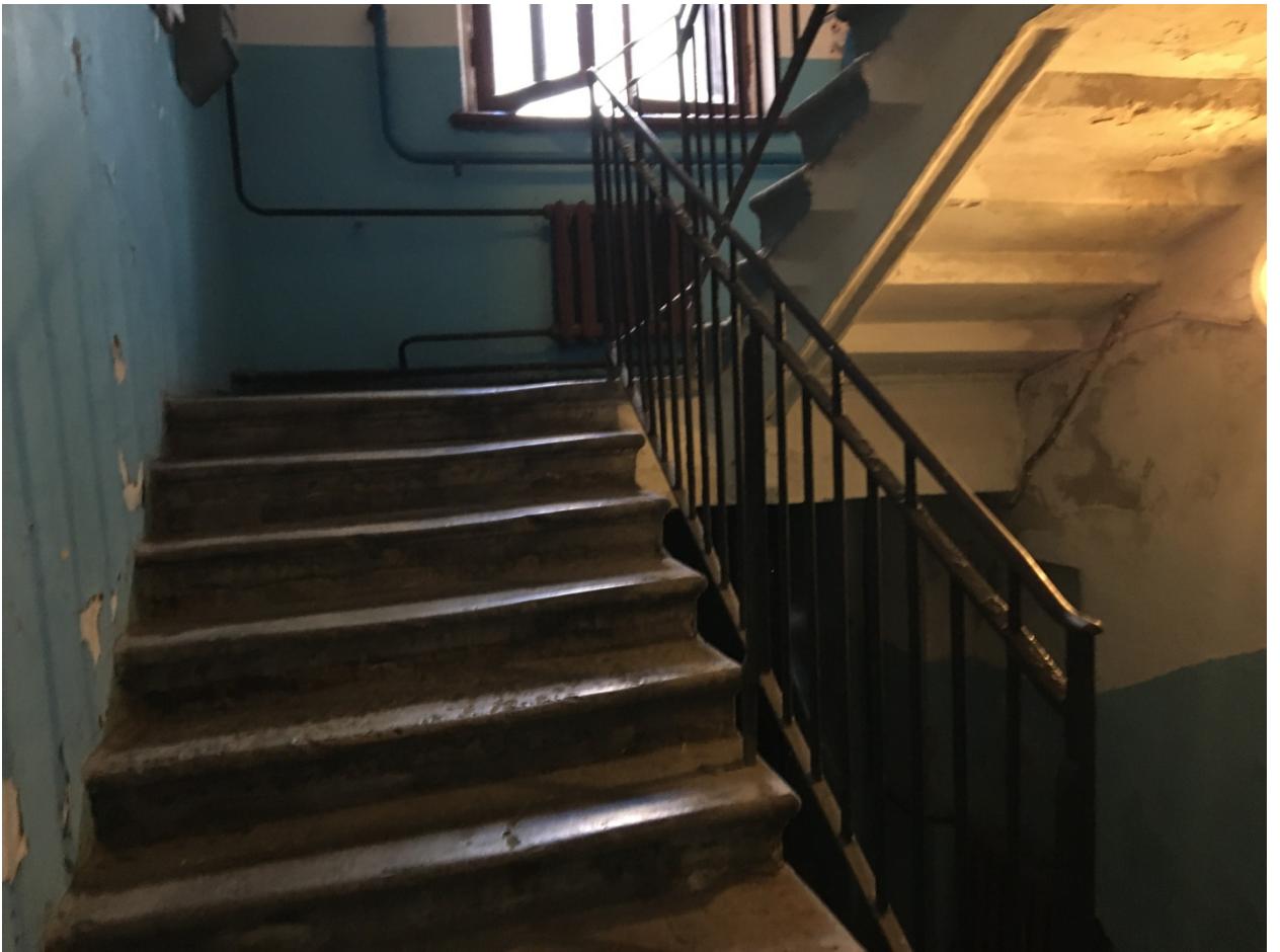
39. Лестница Л-4. Площадка между 1 и 2 этажами.
