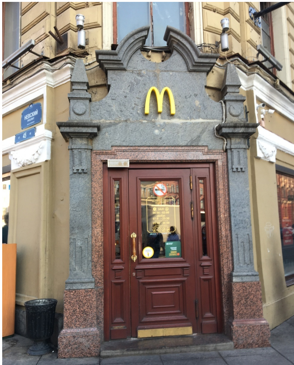
11. Лицевой фасад по улице Рубинштейна. Общий вид.
