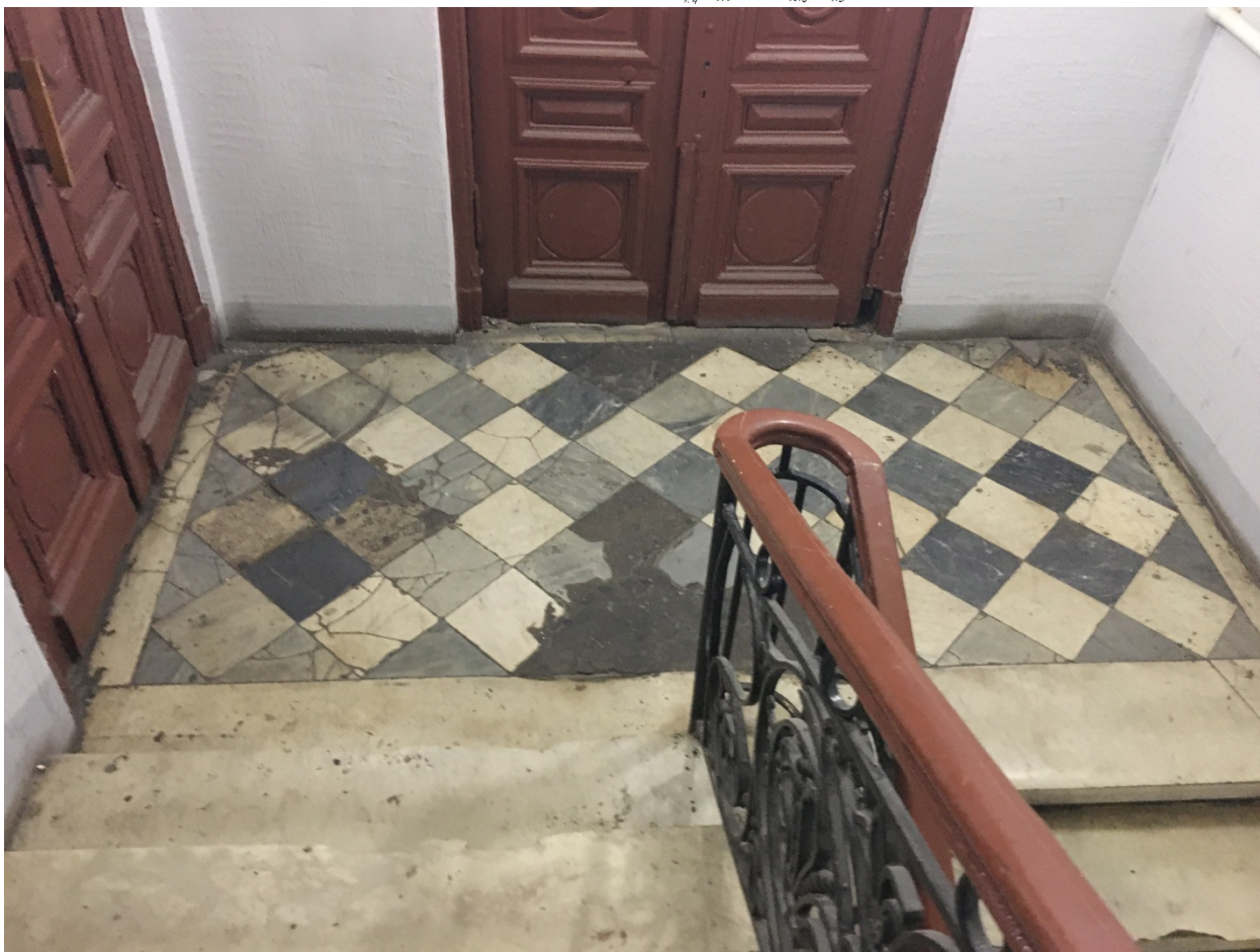
26. Парадная лестница Л-1. Площадка 2 этажа.
