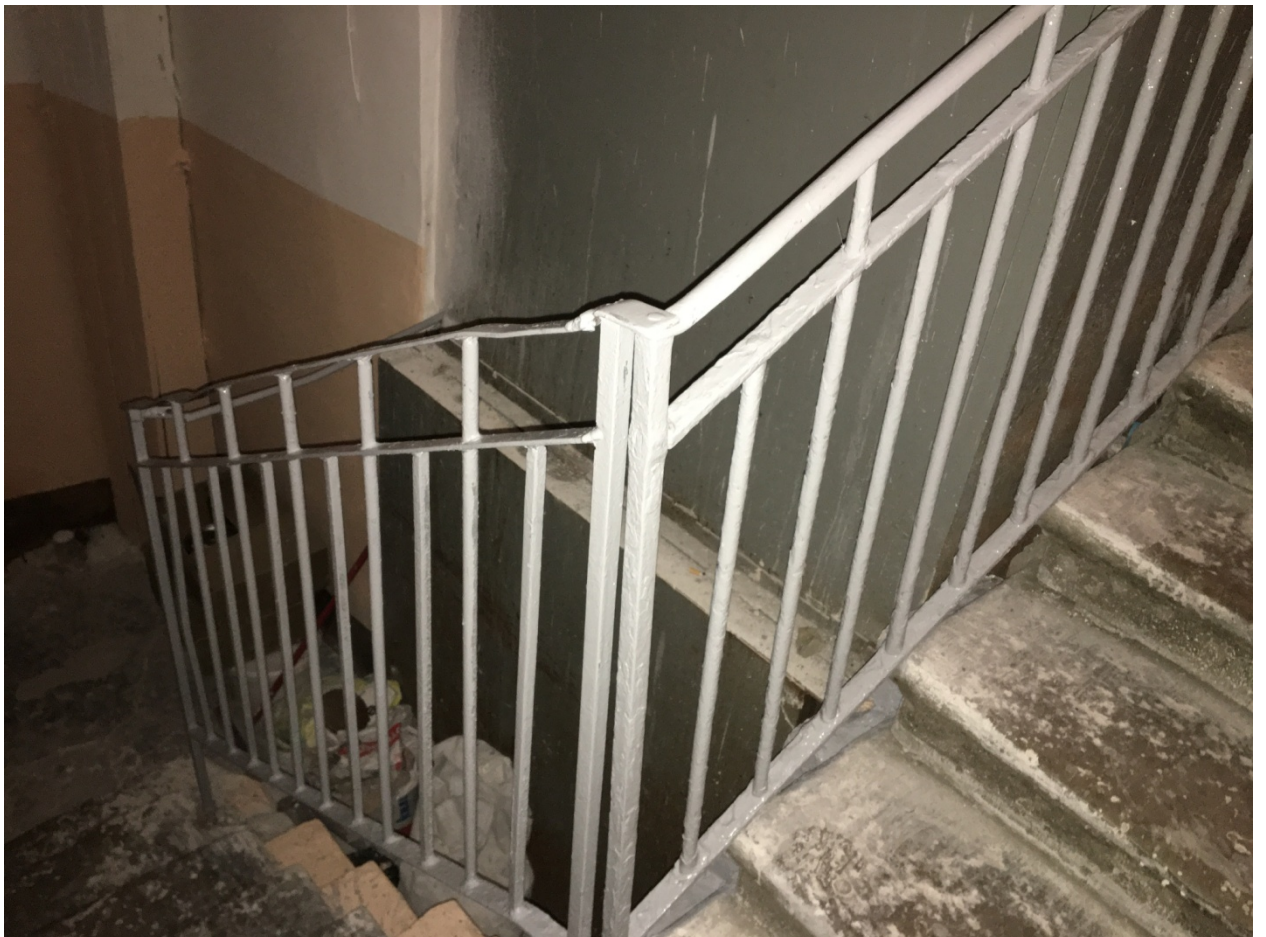
42. Лестница Л-5. Ограждение лестницы.
