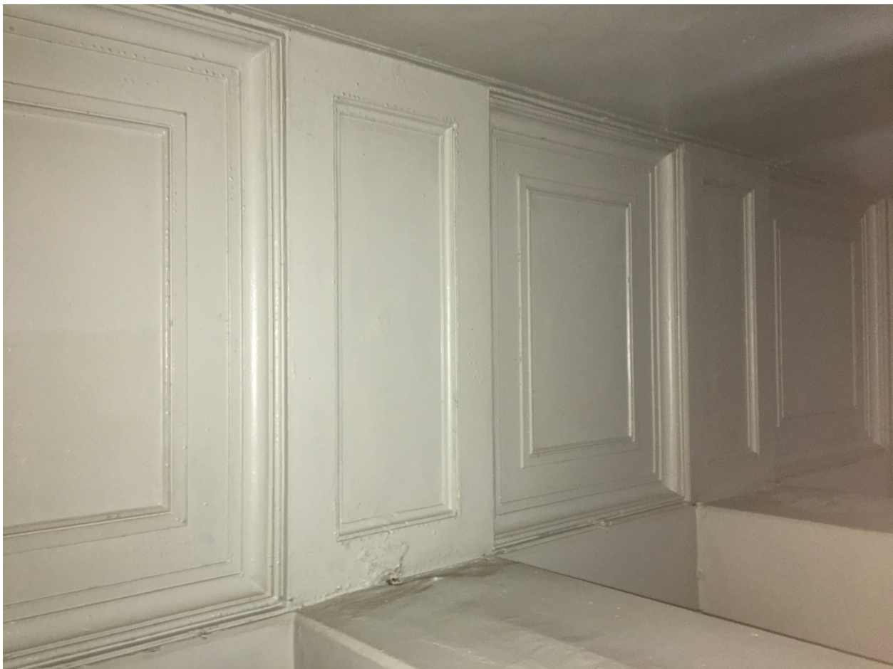
37. Парадная лестница Л-2. Площадка 3 этажа. Оформление потолка.
