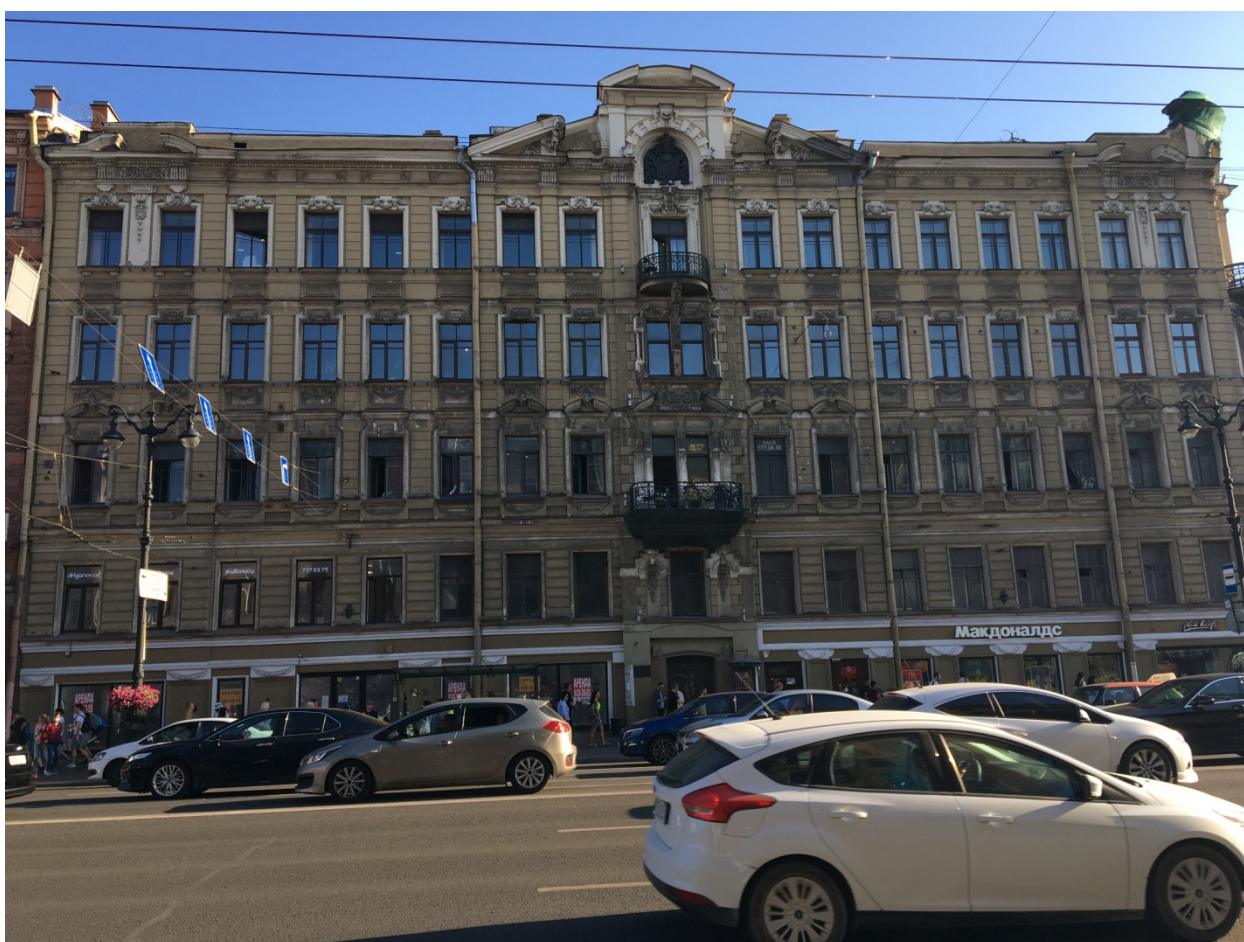
2. Лицевой фасад по Невскому проспекту выявленного объекта культурного наследия «Дом И.И. Ростовцева», расположенного по адресу: г. Санкт-Петербург, Невский пр., 45; Рубинштейна ул., 2. Общий вид.
