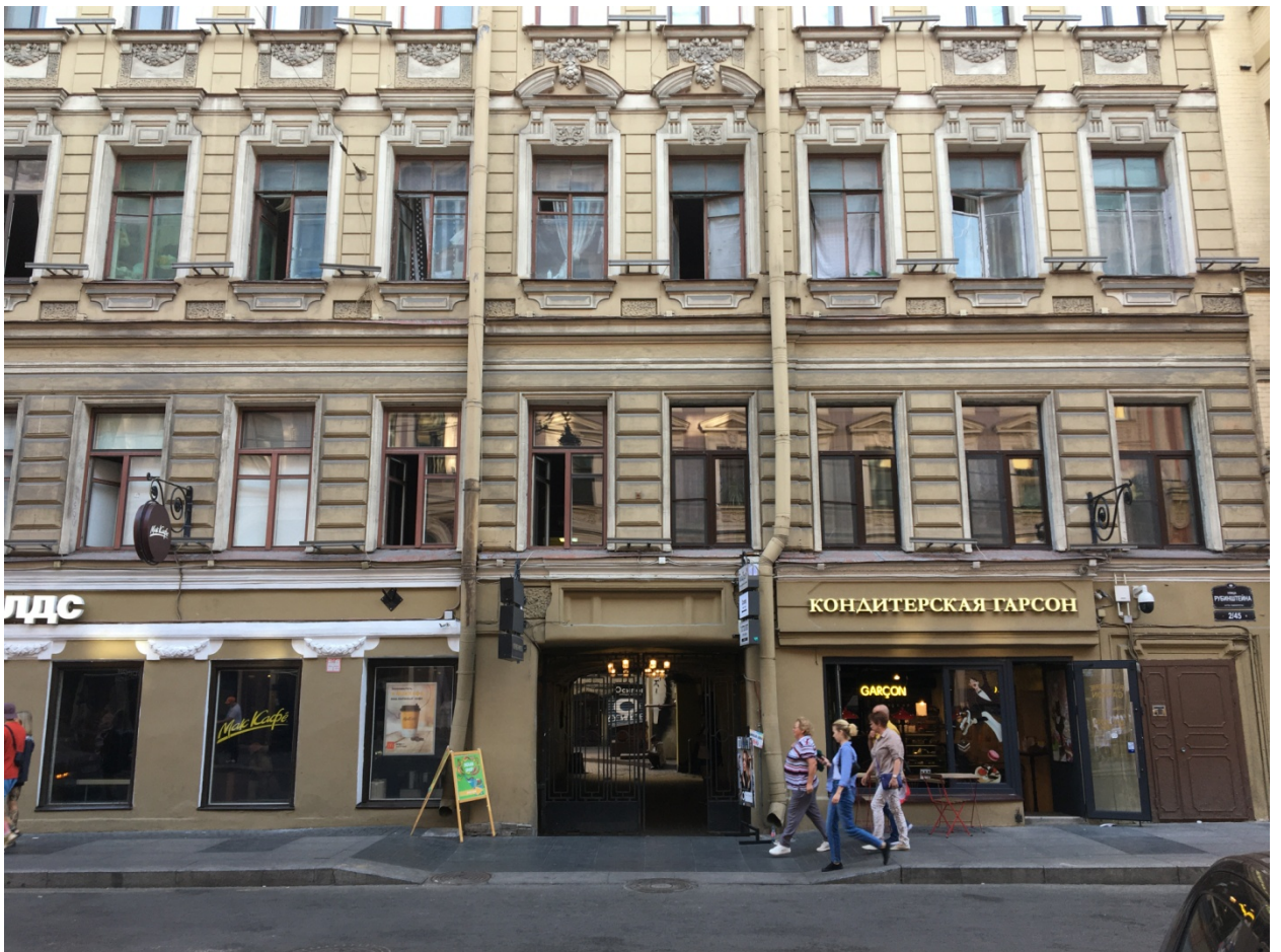
14. Лицевой фасад по улице Рубинштейна. Общий вид.
