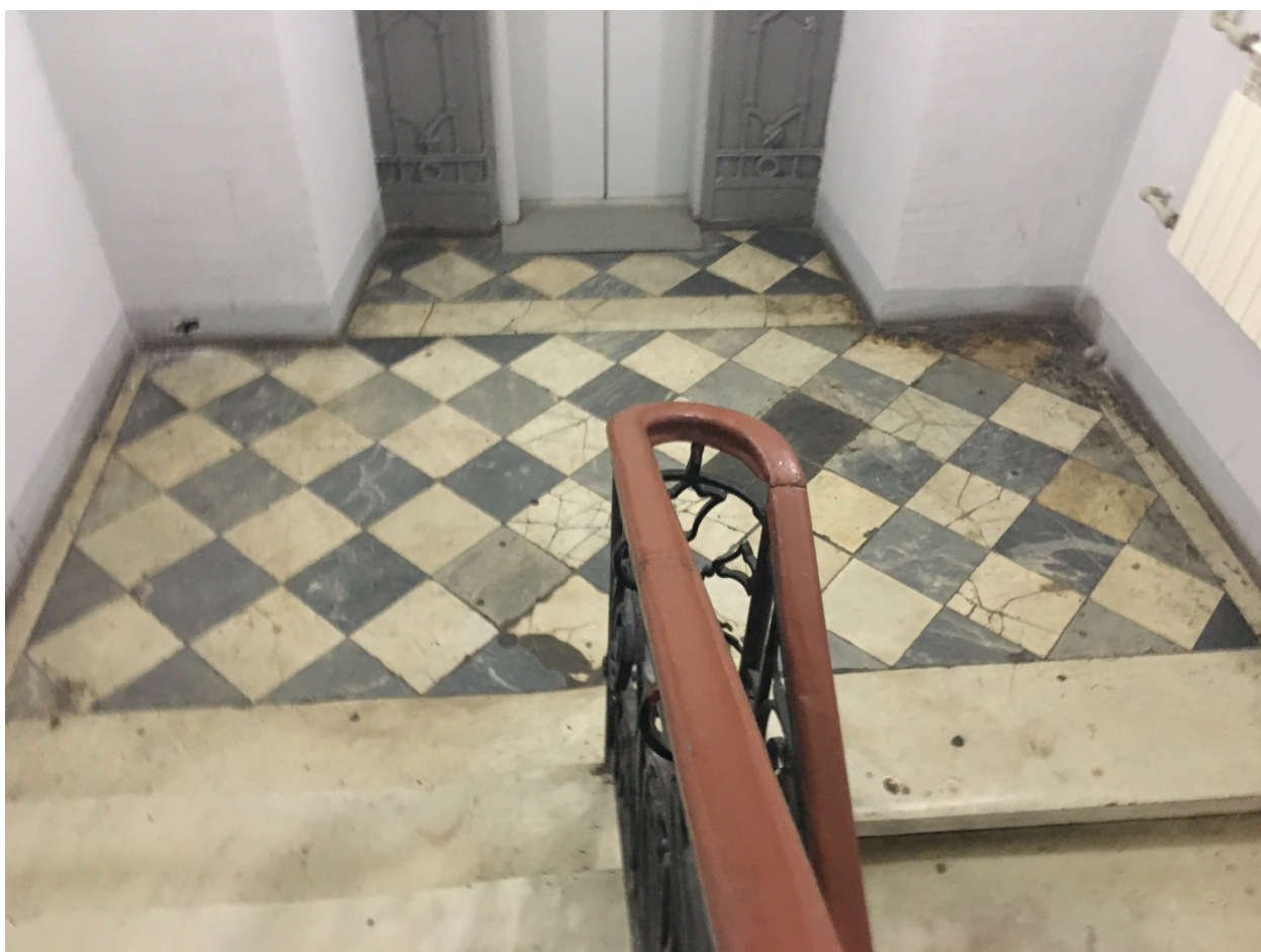
29. Парадная лестница Л-1. Площадка между 3 и 4 этажами.
