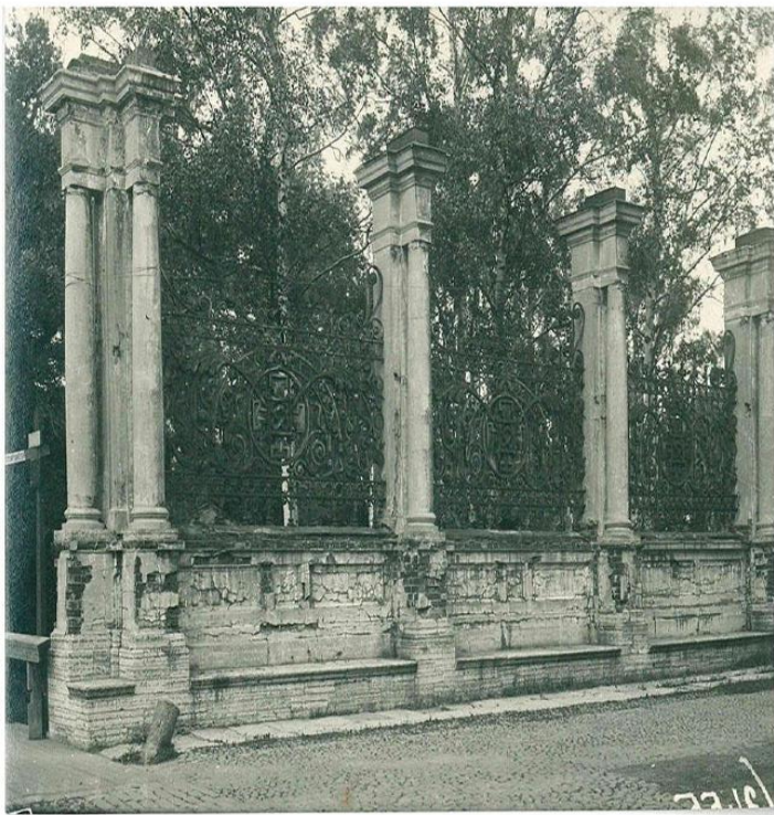
37. Вид на Восточные ворота с западной стороны. Фотография 1944 г. Архив КГИОП (№ инв. 3455)
