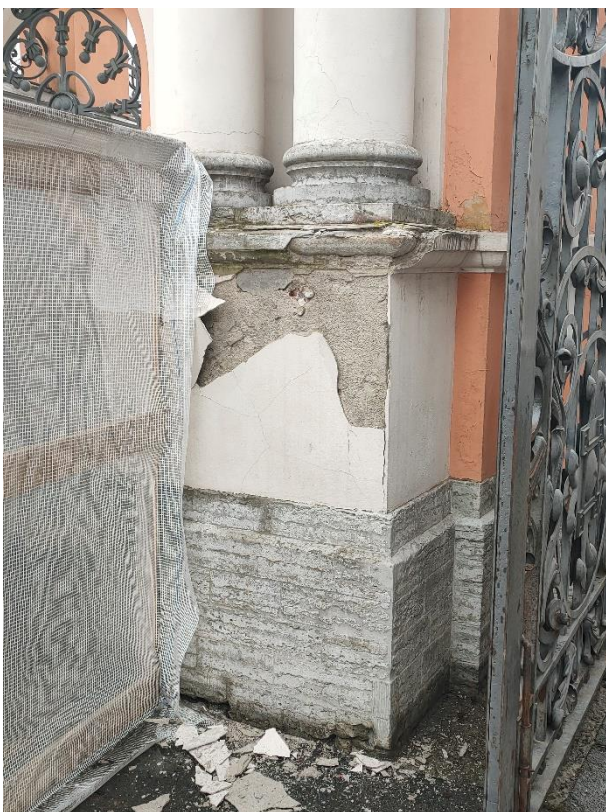
19. «Ворота восточного двора с двумя оградами по набережной реки Монастырки», входящие в состав объекта «Александрo-Невская Лавра», наб. р. Монастырки. Фрагмент ворот. Фото 15.03.2021 г.
