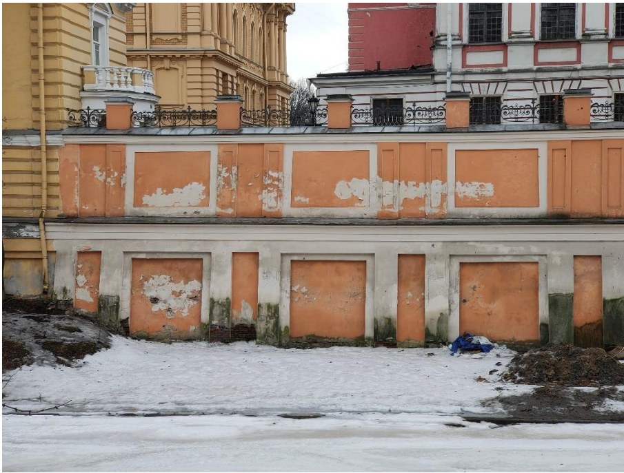
45. «Ворота восточного двора с двумя оградами по набережной реки Монастырки», входящие в состав объекта «Алекса́ндро-Невская Лавра», наб. р. Монастырки. Фрагмент ограды со стороны р. Монастырки. Фото 15.03.2021 г.
