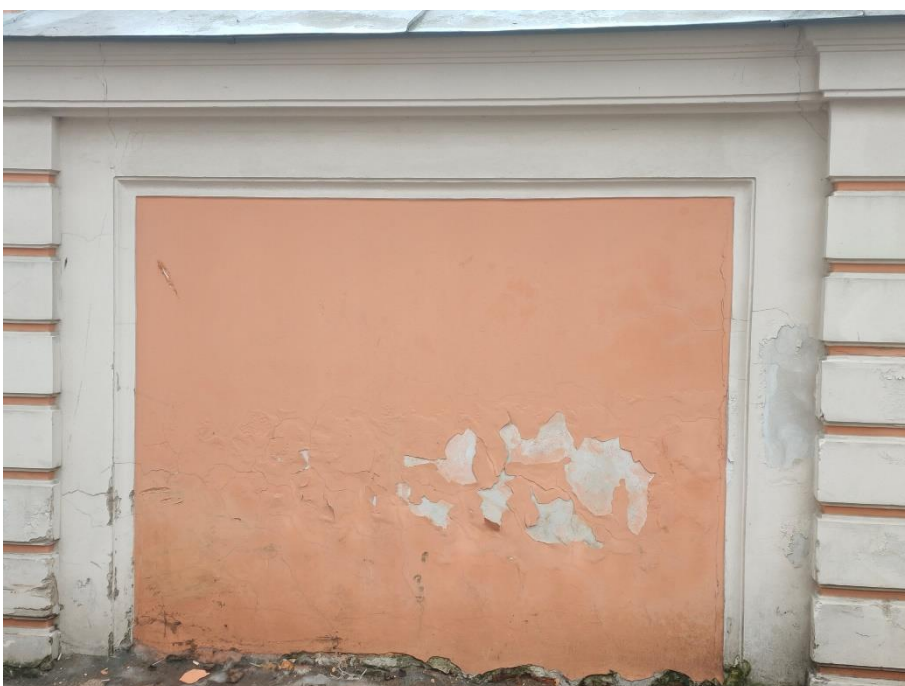
8. «Ворота восточного двора с двумя оградами по набережной реки Монастырки», входящие в состав объекта «Алекса́ндро-Невская Лавра», наб. р. Монастырки. Фрагмент ограды с внутренней стороны. Фото 15.03.2021 г.
