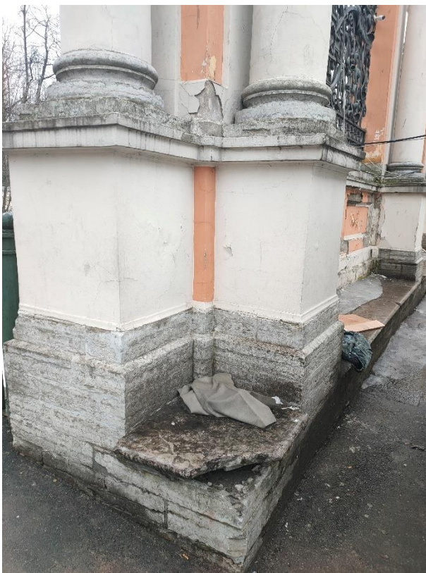
40. «Ворота восточного двора с двумя оградами по набережной реки Монастырки», входящие в состав объекта «Алекса́ндро-Невская Ла́вра», наб. р. Монастырки. Фрагмент ограды с внутренней стороны. Фото 15.03.2021 г.
