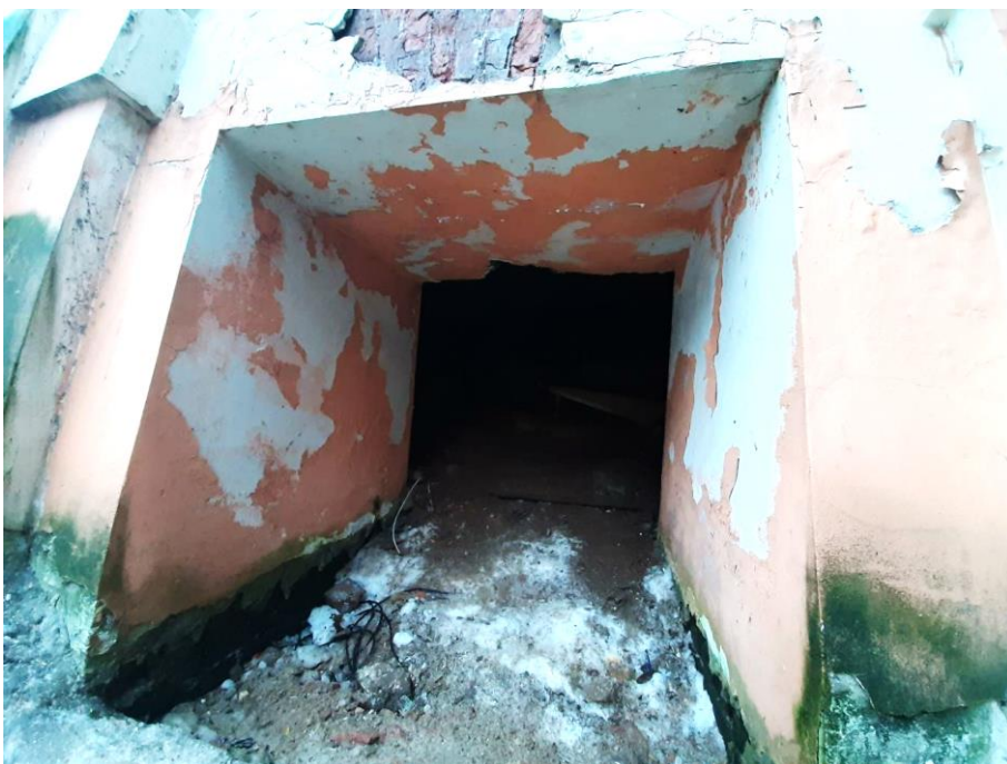
56. «Ворота восточного двора с двумя оградами по набережной реки Монастырки», входящие в состав объекта «Алекса́ндро-Невская Лавра», наб. р. Монастырки. Подземный ход. Фрагмент. Фото 15.03.2021 г.
