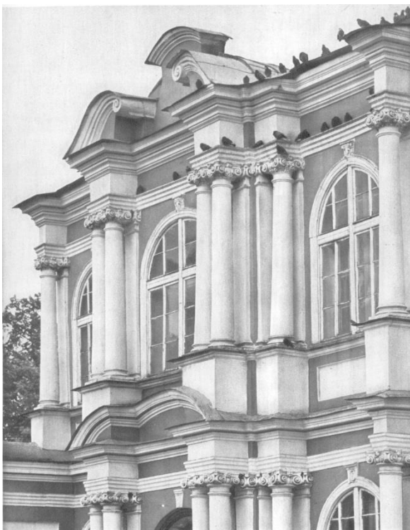
58. Александрo-Невская лавра. Лестничный корпус Благовещенской церкви 1982-1984 гг., Источник: А.Н. Кудрявцев, Г.Н. Шкода Александрo-Невская Лавра. Архитектурный ансамбль и памятники некрополей. Л., Художник РСФСР, 1986 г.
