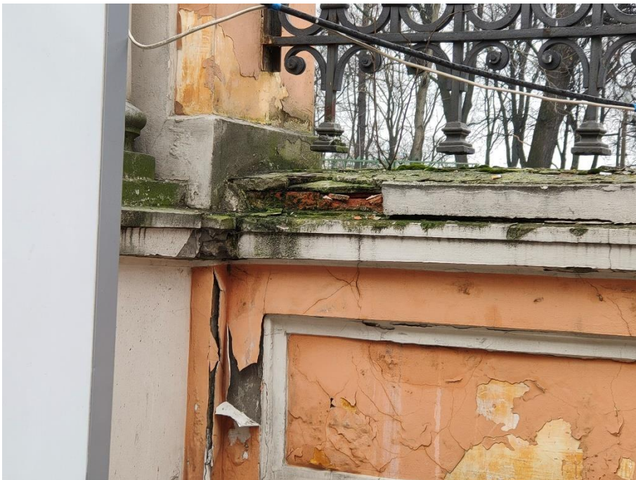
38. «Ворота восточного двора с двумя оградами по набережной реки Монастырки», входящие в состав объекта «Алекса́ндро-Невская Лавра», наб. р. Монастырки. Фрагмент ограды с внутренней стороны. Фото 15.03.2021 г.
