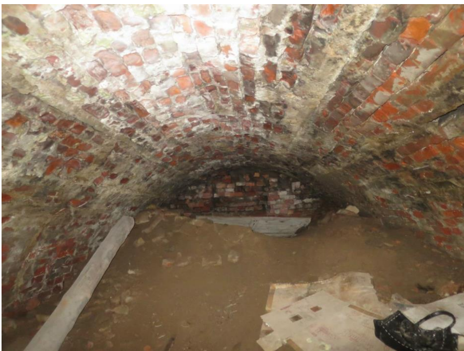
57. «Ворота восточного двора с двумя оградами по набережной реки Монастырки», входящие в состав объекта «Алекса́ндро-Невская Ла́вра», наб. р. Монастырки. Подземный ход. Фрагмент. Фото 15.03.2021 г.
