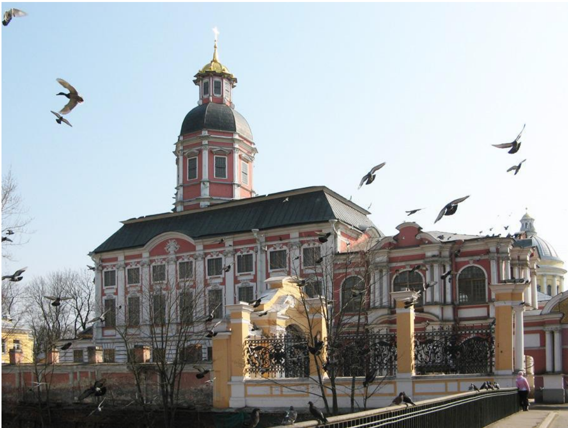
66. Неизвестный автор. Общий вид Благовещенской церкви с воротами и оградой (до ремонта подпорной стенки). Фотография. 2010 г.
