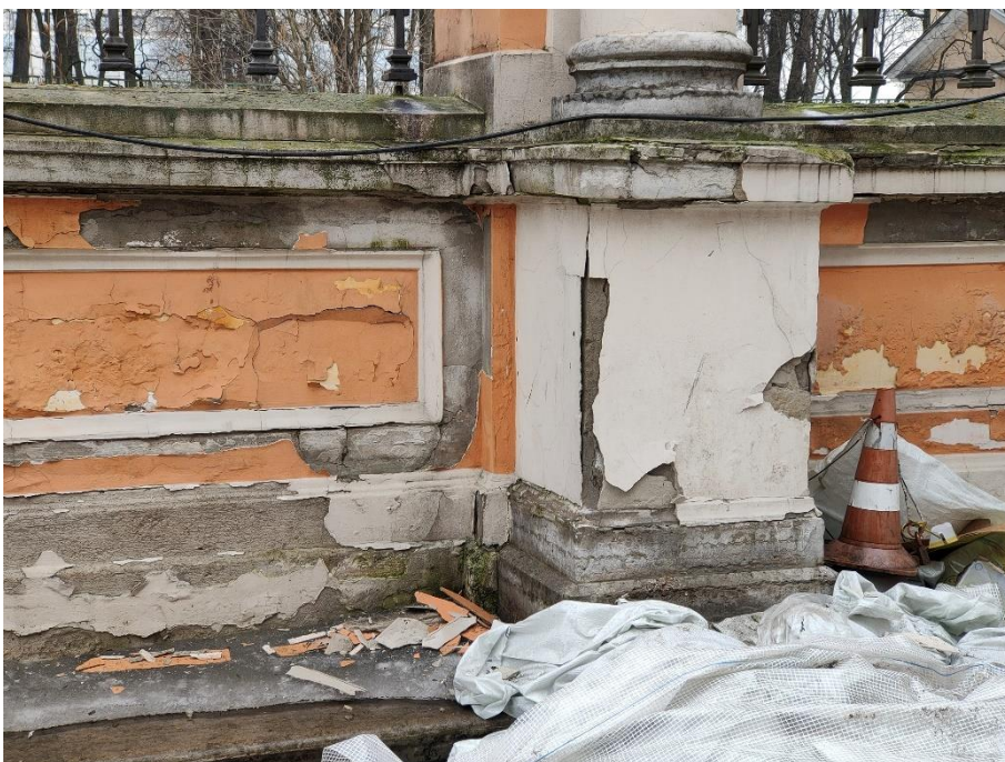
31. «Ворота восточного двора с двумя оградами по набережной реки Монастырки», входящие в состав объекта «Алекса́ндро-Невская Лавра», наб. р. Монастырки. Фрагмент ограды с внутренней стороны. Фото 15.03.2021 г.
