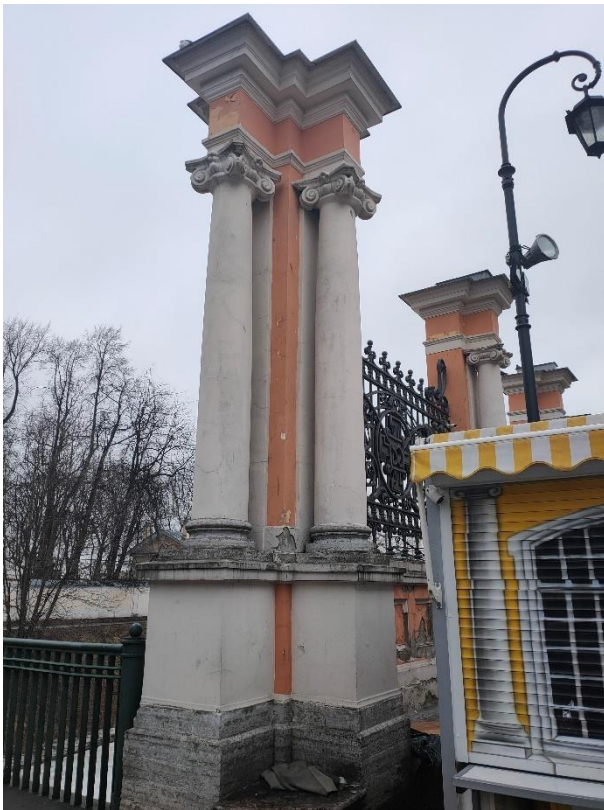
39. «Ворота восточного двора с двумя оградами по набережной реки Монастырки», входящие в состав объекта «Алекса́ндро-Невская Ла́вра», наб. р. Монастырки. Фрагмент ограды с внутренней стороны. Фото 15.03.2021 г.
