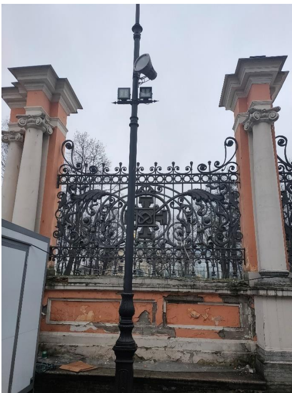
34. «Ворота восточного двора с двумя оградами по набережной реки Монастырки», входящие в состав объекта «Алекса́ндро-Невская Ла́вра», наб. р. Монастырки. Фрагмент ограды с внутренней стороны. Фото 15.03.2021 г.
