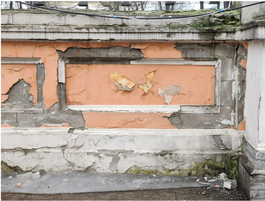
37. «Ворота восточного двора с двумя оградами по набережной реки Монастырки», входящие в состав объекта «Алекса́ндро-Невская Лавра», наб. р. Монастырки. Фрагмент ограды с внутренней стороны. Фото 15.03.2021 г.
