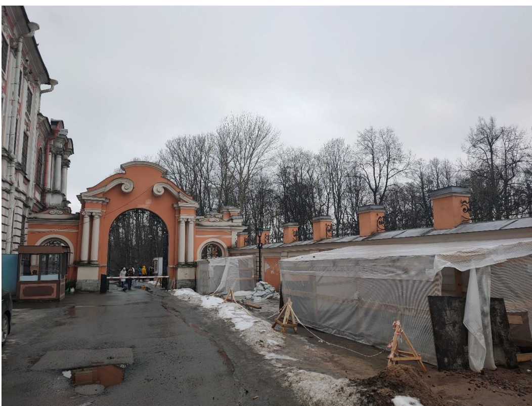
4. «Ворота восточного двора с двумя оградами по набережной реки Монастырки», входящие в состав объекта «Александро-Невская Лавра», наб. р. Монастырки. Общий вид с востока. Фото 15.03.2021 г.
