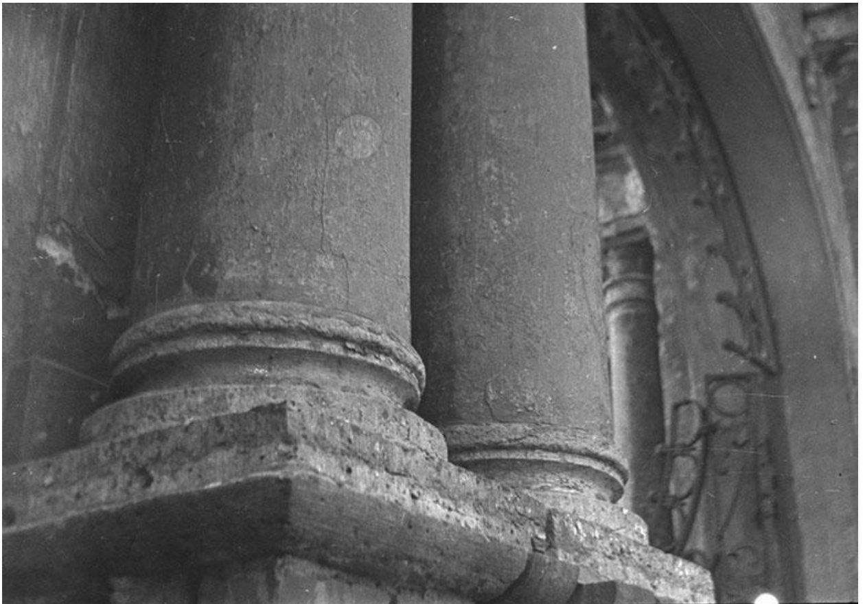
42. Вид на каменные базы и плинты колонн Восточных ворот. Фотография. 1950 г. Архив КГИОП (№ инв. 18667).
