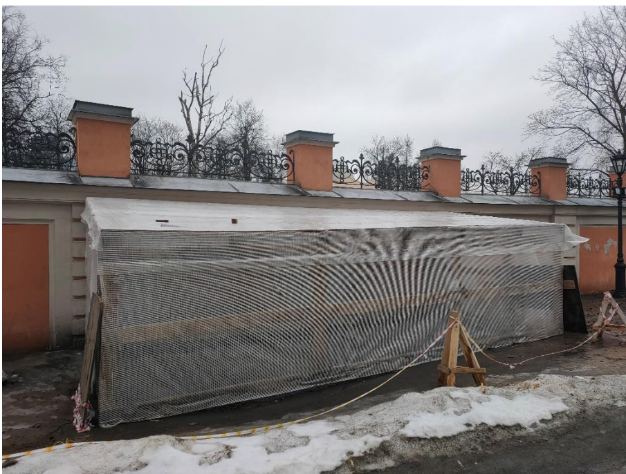
9. «Ворота восточного двора с двумя оградами по набережной реки Монастырки», входящие в состав объекта «Алекса́ндро-Невская Лавра», наб. р. Монастырки. Фрагмент ограды с внутренней стороны. Фото 15.03.2021 г.
