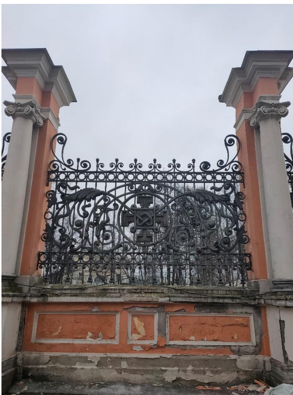
28. «Ворота восточного двора с двумя оградами по набережной реки Монастырки», входящие в состав объекта «Алекса́ндро-Невская Лавра», наб. р. Монастырки. Фрагмент ограды с внутренней стороны. Фото 15.03.2021 г.
