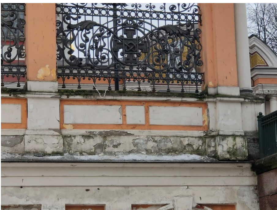
54. «Ворота восточного двора с двумя оградами по набережной реки Монастырки», входящие в состав объекта «Алекса́ндро-Невская Лавра», наб. р. Монастырки. Фрагмент ограды со стороны р. Монастырки. Фото 15.03.2021 г.
