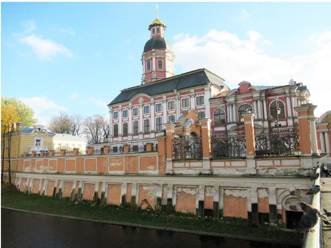
69. П.Г. Щедрин. Общий вид Благовещенской церкви с оградой и подпорной стенкой со стороны набережной р. Монастырки. Фотография. 2020 г.
