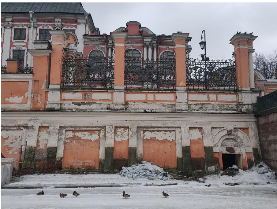
49. «Ворота восточного двора с двумя оградами по набережной реки Монастырки», входящие в состав объекта «Александровская Лавра», наб. р. Монастырки. Фрагмент ограды со стороны р. Монастырки. Фото 15.03.2021 г.
