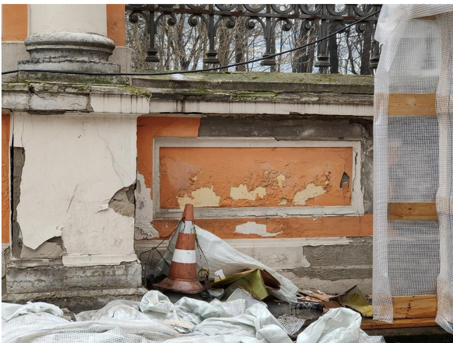
27. «Ворота восточного двора с двумя оградами по набережной реки Монастырки», входящие в состав объекта «Алекса́ндро-Невская Лавра», наб. р. Монастырки. Фрагмент ограды с внутренней стороны. Фото 15.03.2021 г.
