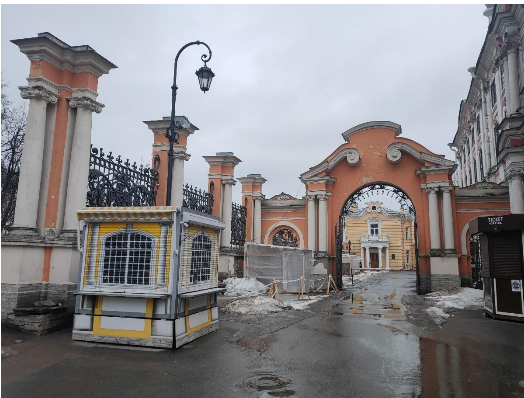
3. «Ворота восточного двора с двумя оградами по набережной реки Монастырки», входящие в состав объекта «Александро-Невская Лавра», наб. р. Монастырки. Общий вид с юга. Фото 15.03.2021 г.
