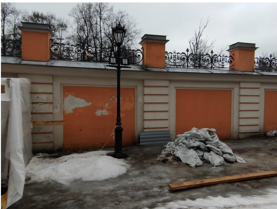
10. «Ворота восточного двора с двумя оградами по набережной реки Монастырки», входящие в состав объекта «Алекса́ндро-Невская Лавра», наб. р. Монастырки. Фрагмент ограды с внутренней стороны. Фото 15.03.2021 г.
