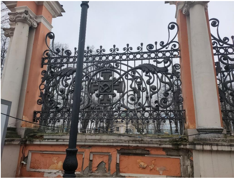
35. «Ворота восточного двора с двумя оградами по набережной реки Монастырки», входящие в состав объекта «Алекса́ндро-Невская Лавра», наб. р. Монастырки. Фрагмент ограды с внутренней стороны. Фото 15.03.2021 г.
