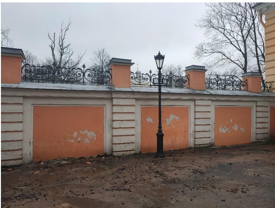
5. «Ворота восточного двора с двумя оградами по набережной реки Монастырки», входящие в состав объекта «Алекса́ндро-Невская Лавра», наб. р. Монастырки. Фрагмент ограды с внутренней стороны. Фото 15.03.2021 г.
