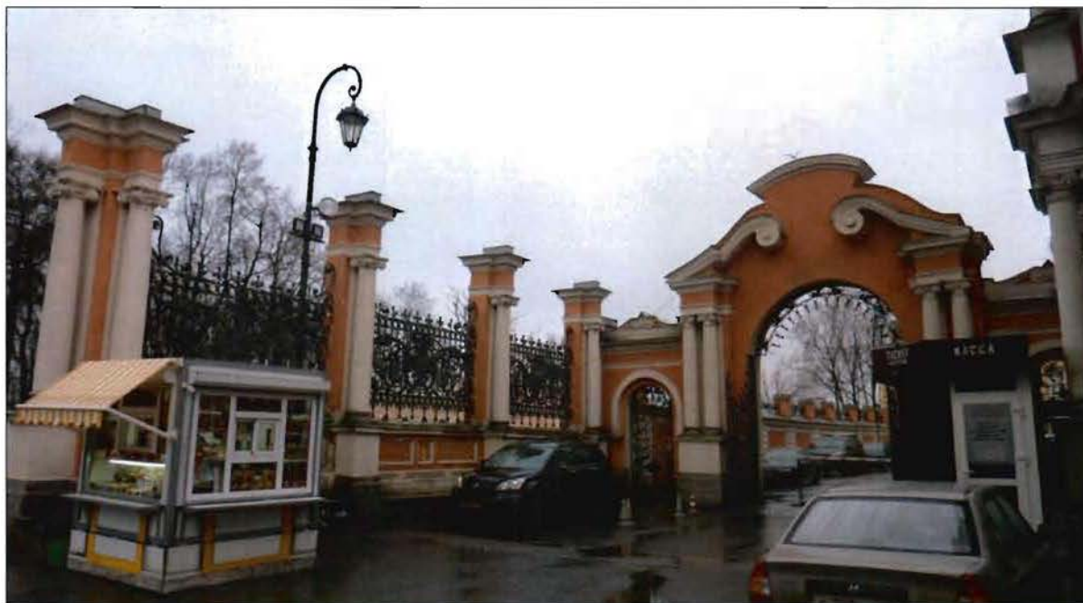
1. Общий вид с юго-запада.
