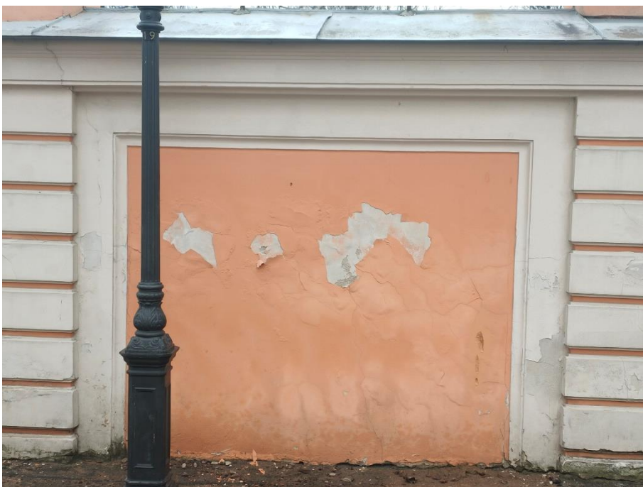
7. «Ворота восточного двора с двумя оградами по набережной реки Монастырки», входящие в состав объекта «Алекса́ндро-Невская Лавра», наб. р. Монастырки. Фрагмент ограды с внутренней стороны. Фото 15.03.2021 г.
