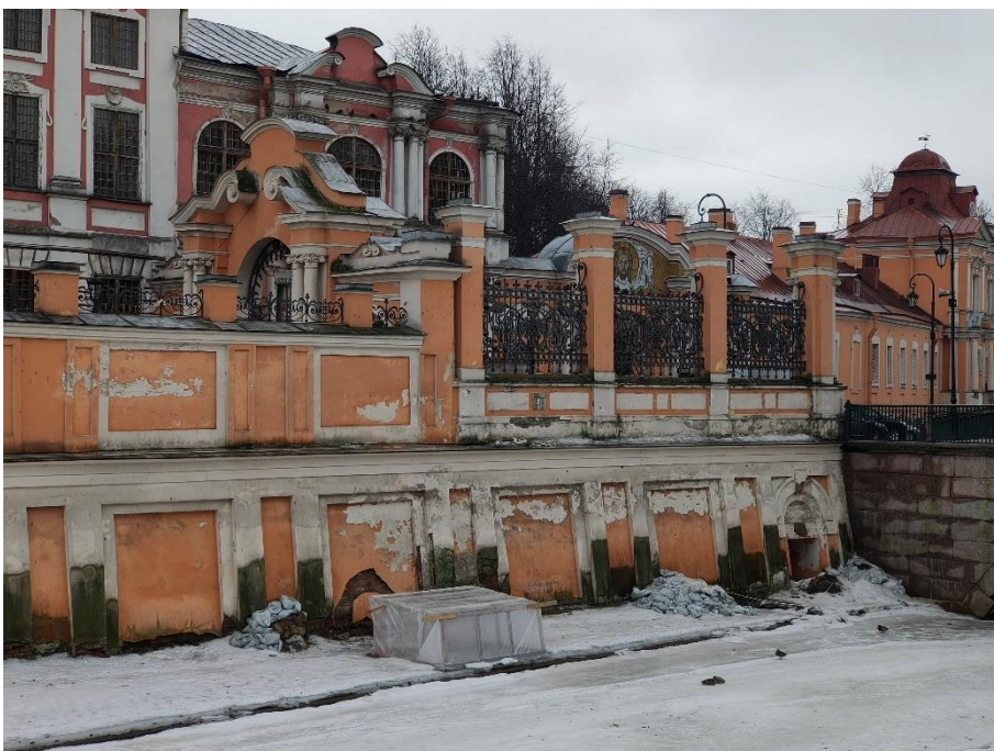
44. «Ворота восточного двора с двумя оградами по набережной реки Монастырки», входящие в состав объекта «Алекса́ндро-Невская Лавра», наб. р. Монастырки. Фрагмент ограды со стороны р. Монастырки. Фото 15.03.2021 г.
