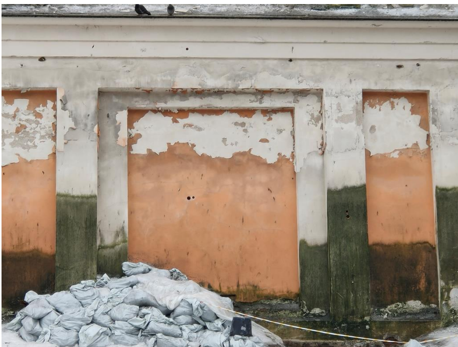
53. «Ворота восточного двора с двумя оградами по набережной реки Монастырки», входящие в состав объекта «Алекса́ндро-Невская Лавра», наб. р. Монастырки. Фрагмент ограды со стороны р. Монастырки. Фото 15.03.2021 г.
