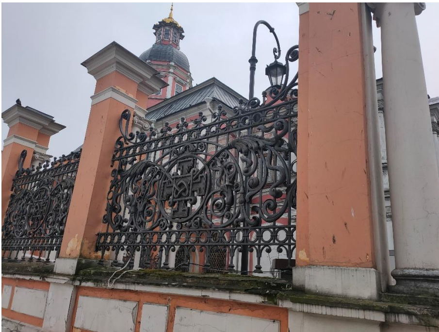
42. «Ворота восточного двора с двумя оградами по набережной реки Монастырки», входящие в состав объекта «Александровская Лавра», наб. р. Монастырки. Фрагмент ограды со стороны р. Монастырки. Фото 15.03.2021 г.
