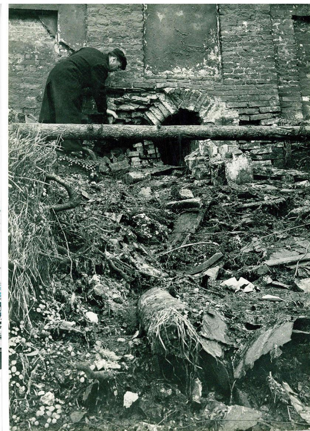
41. Вид на отверстие канала дождевого коллектора (?) в кладке подпорной стены. Фотография. Фотосъемка АПУ. 1950 г. Архив КГИОП (№ инв. 13871)
