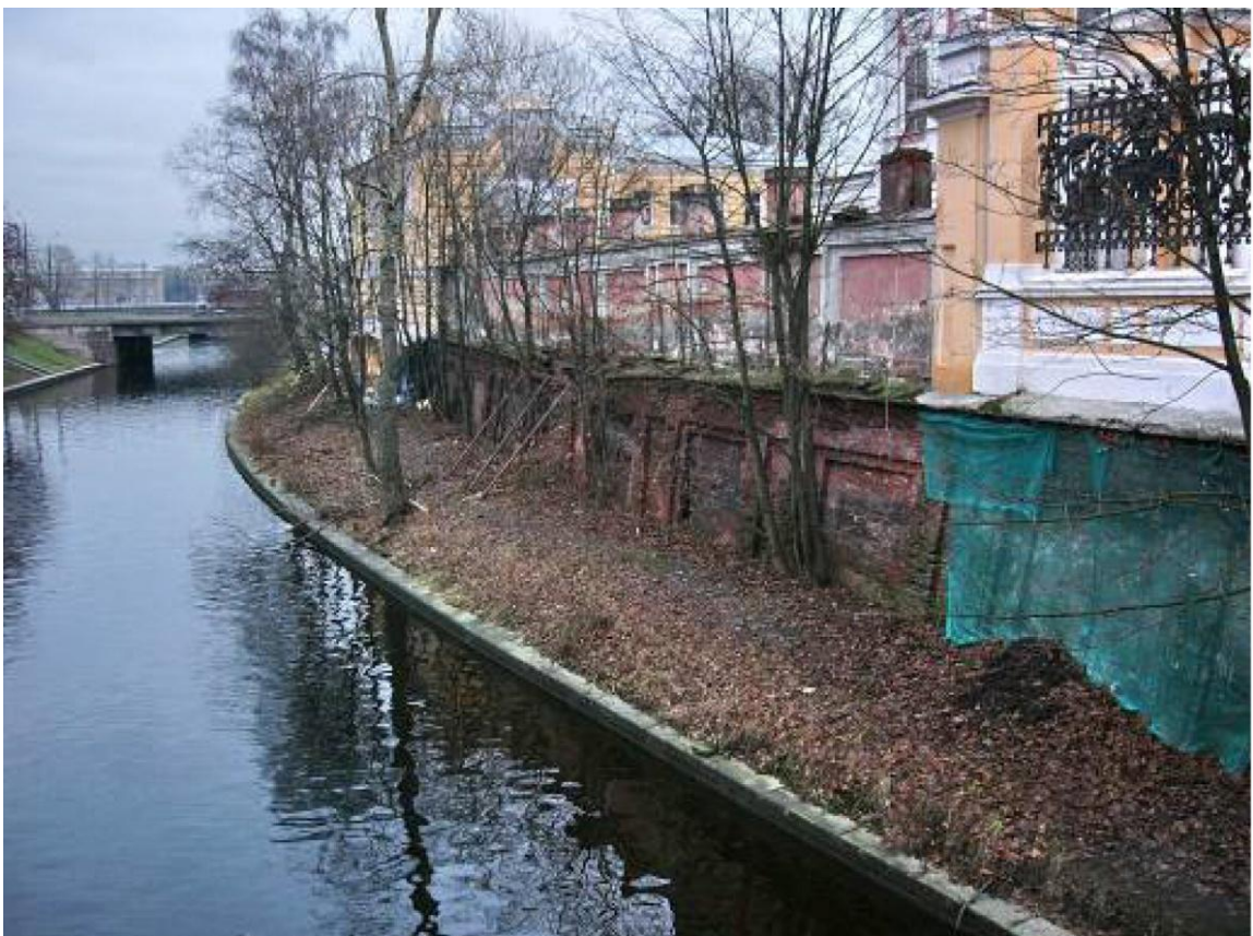
67. Подпорная стенка восточного двора. Фотография. 2009 г.
