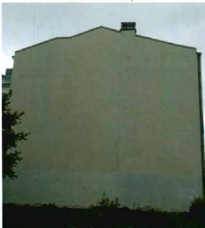
2. Вид на южный фасад.
