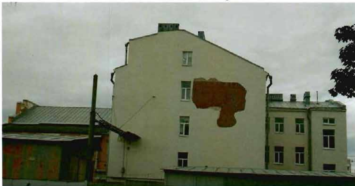
4. Общий вид на западный фасад.
