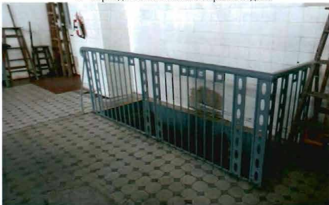
7. Ограждение лестничного марша в подвал.
