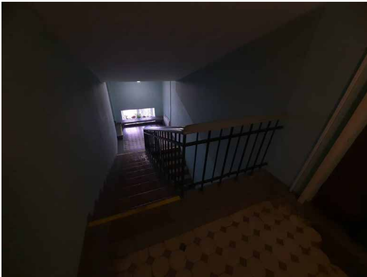
Фото 39. Интерьер 3 этажа объекта культурного наследия регионального значения «Здание Выборгской понижающей подстанции городского трамвая»
