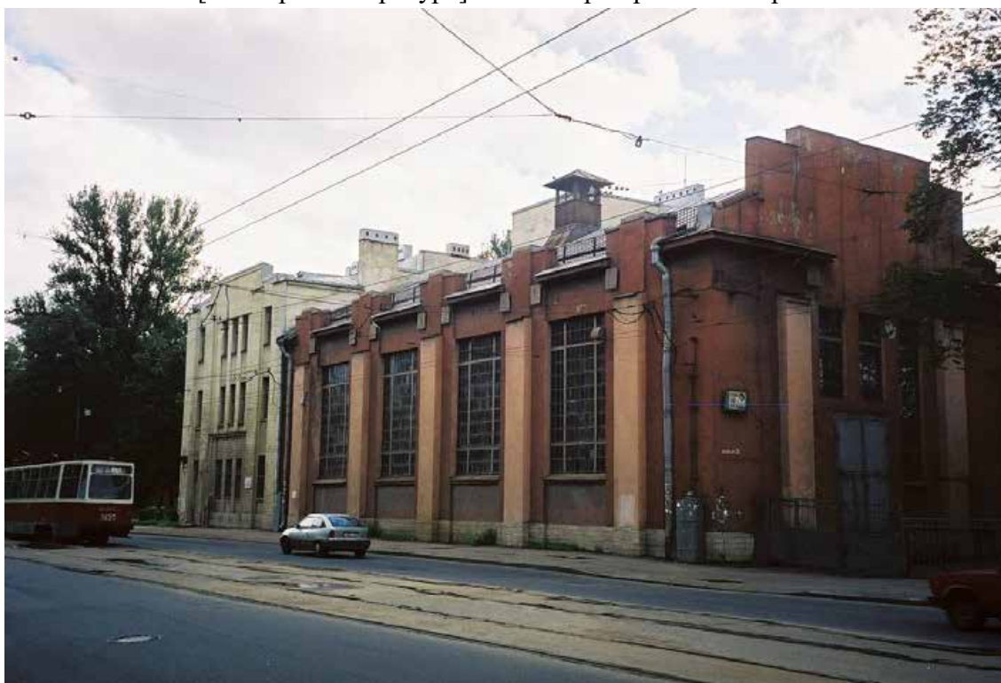
19. Выборгская трансформаторная подстанции городского трамвая. 2000 г. — «PastVu» – ретро-фотографии стран и городов [Электронный ресурс]. URL: https://pastvu.com/p/129847 .
