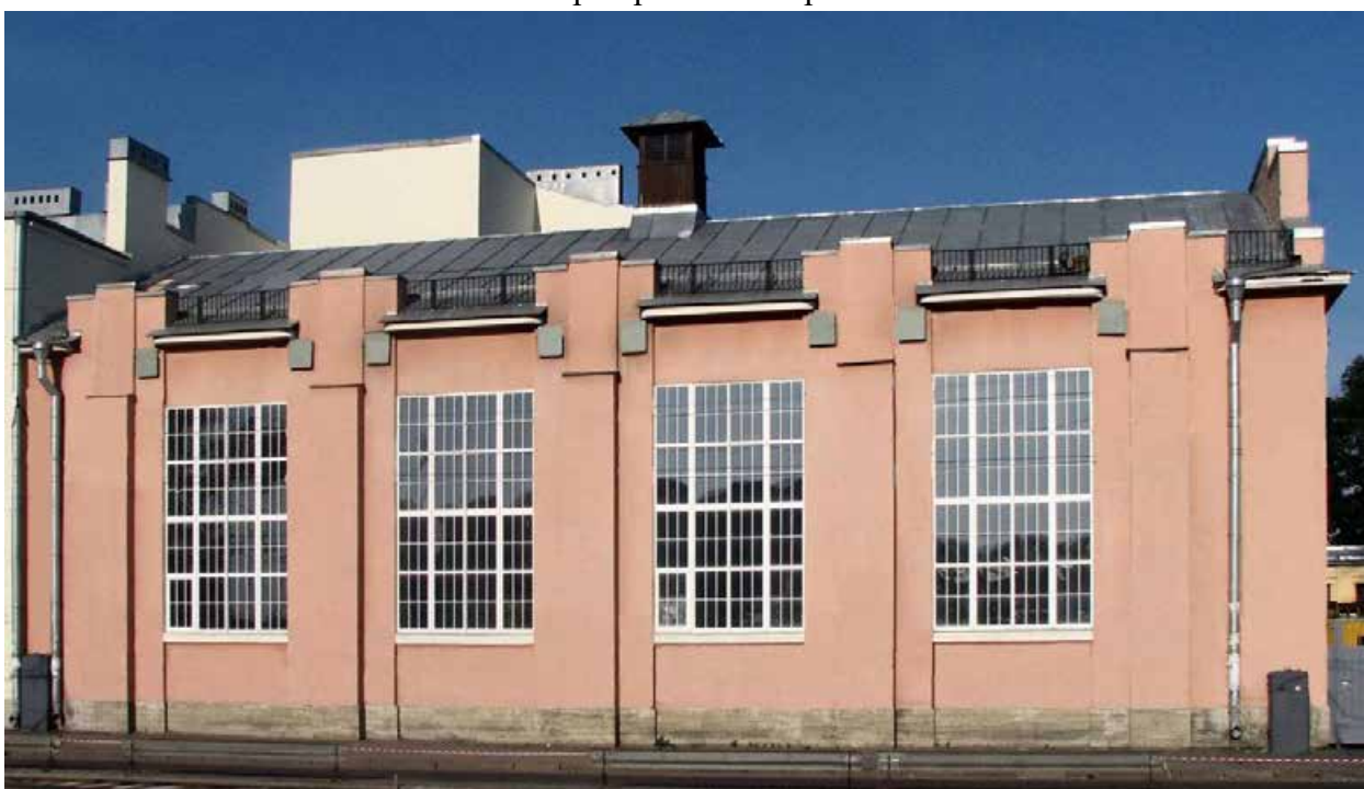
21. 2010 г. — Здание Выборгской понижающей подстанции городского трамвая // Citywalls.ru – архитектурный сайт Петербурга [Электронный ресурс]. URL: https://www.citywalls.ru/house12899.html
