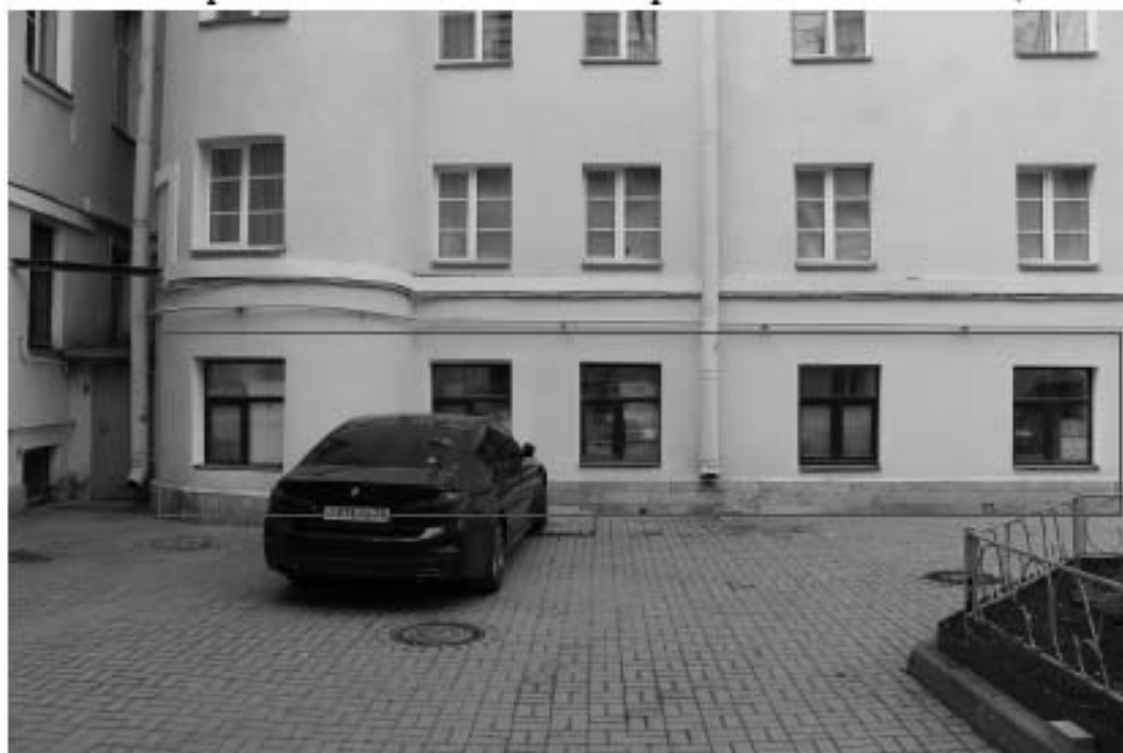
Фото 8. Вид на фасад западного дворового корпуса объекта культурного наследия регионального значения «Дом, где жили в 1872-1875 гг. композитор Мусоргский Модест Петрович и в 1867-1868 гг. композитор Кюи Цезарь Антонович». Красным отмечены оконные проемы нежилого помещения 6-Н.
