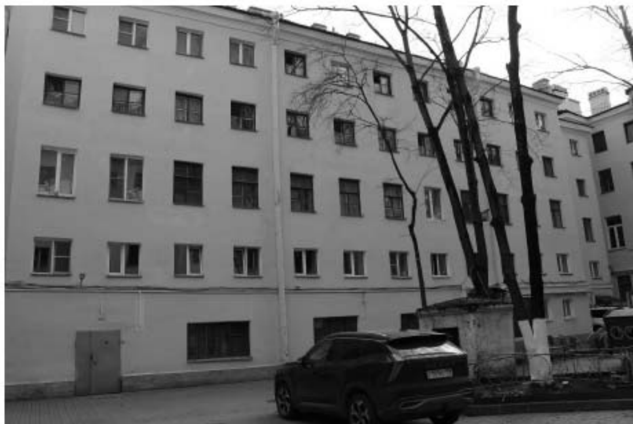
Фото 5. Вид на фасад восточного дворового корпуса объекта культурного наследия регионального значения «Дом, где жили в 1872-1875 гг. композитор Мусоргский Модест Петрович и в 1867-1868 гг. композитор Кюн Цезарь Антонович».
