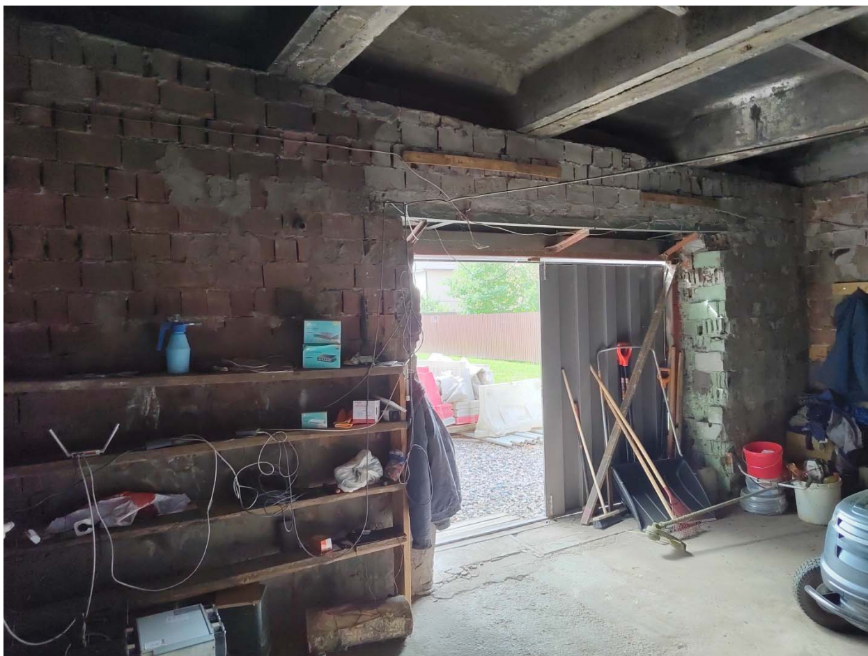
Фото 40. Кирпичная современная пристройка. Внутреннее помещение.
