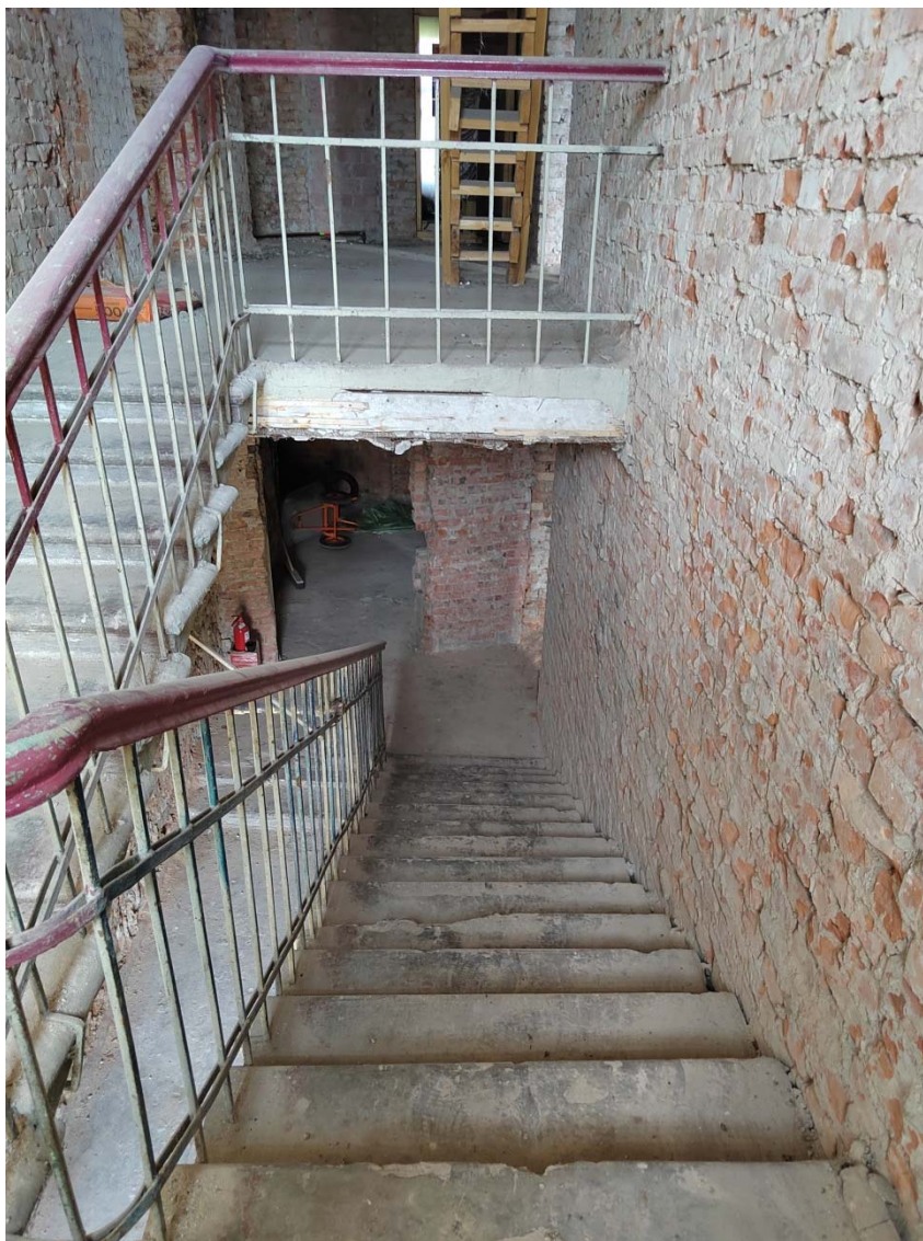
Фото 29. Лестница. Вид с площадки.
