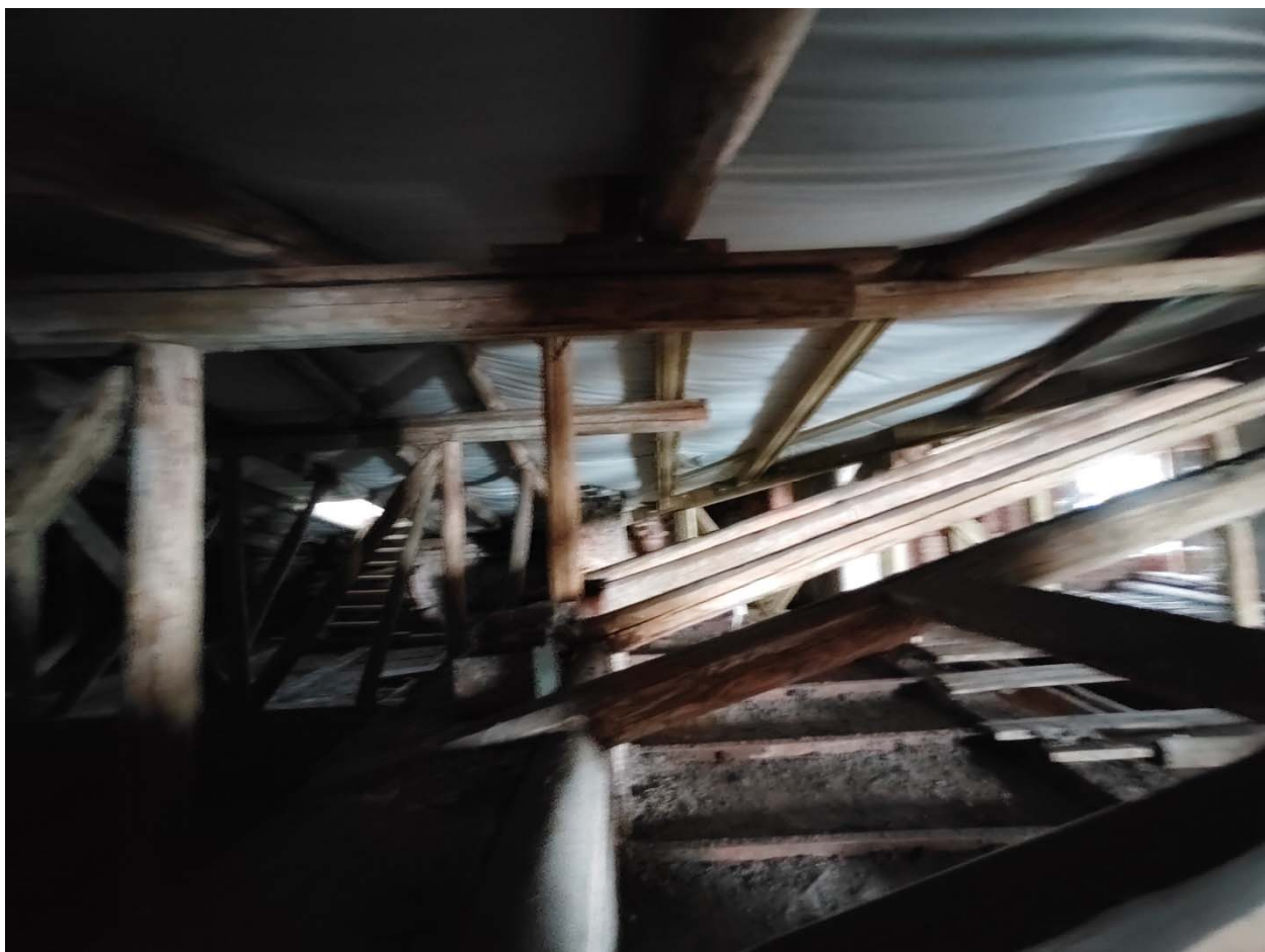
Фото 39. Чердак. Несущие конструкции крыши.
