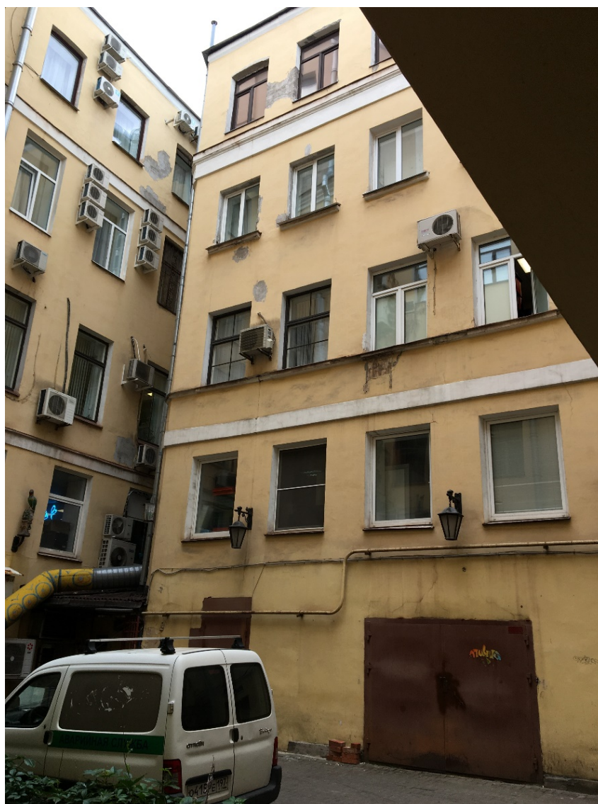
27. Фасад ы восточного двора. Общий вид.
