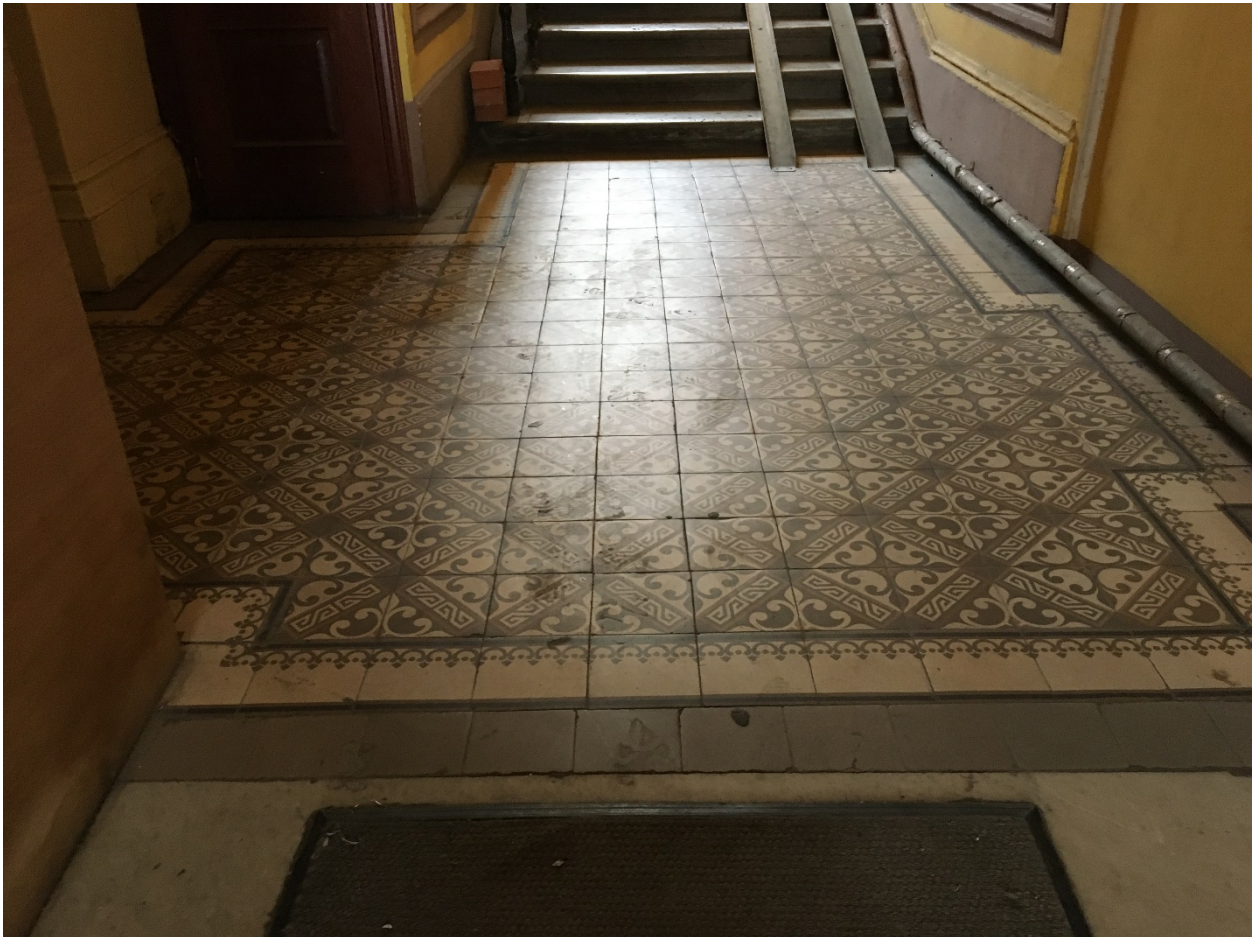
34. Парадная лестница 1ЛК. Оформление пола площадки 1 этажа.
