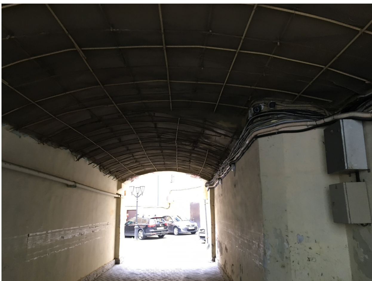
29. Проездная арка с Кирпичного переулка.
