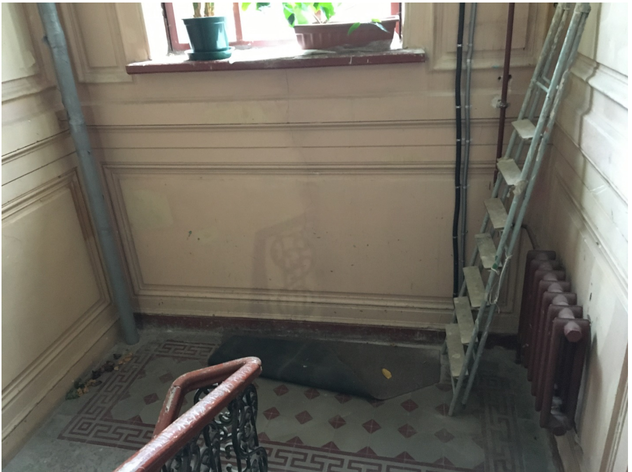
54. Лестница 4ЛК. Оформление площадки между 4 и 5 этажами.
