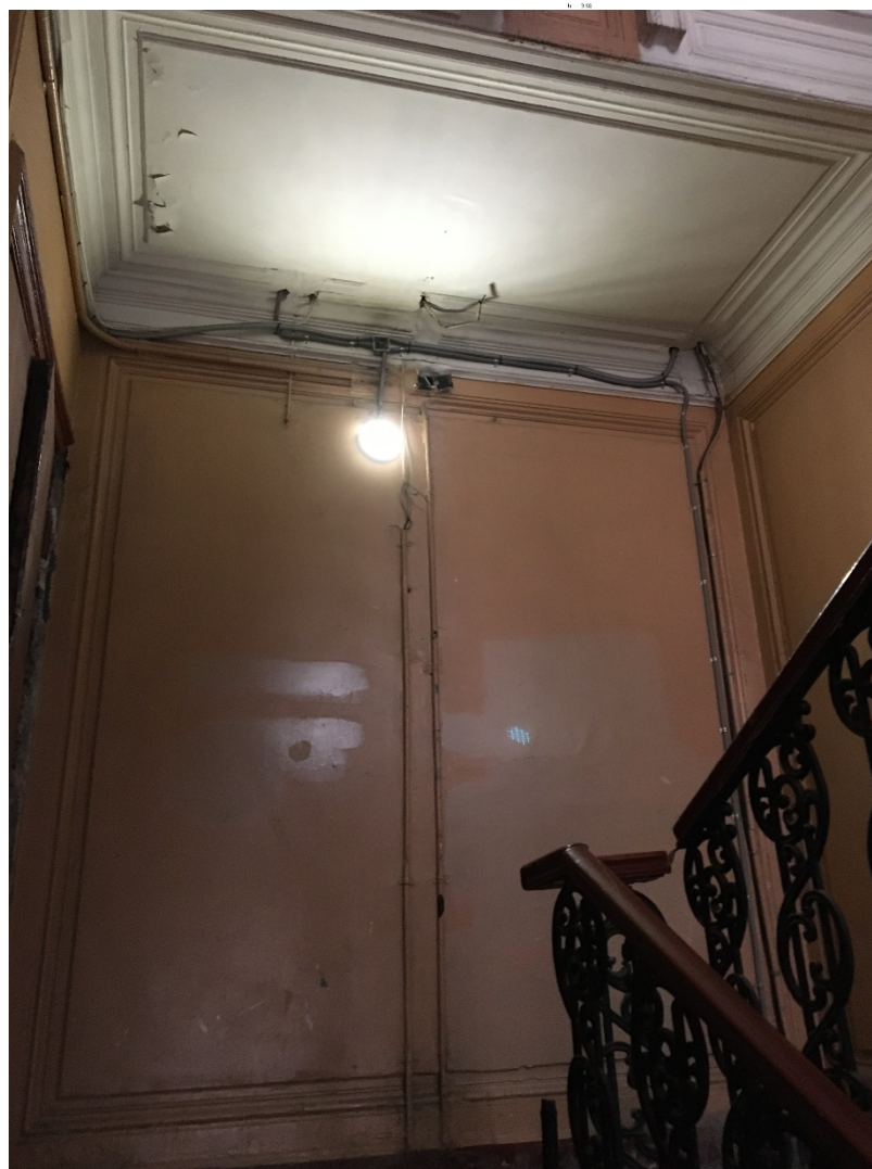
51. Лестница 4ЛК. Площадка 2 этажа.
