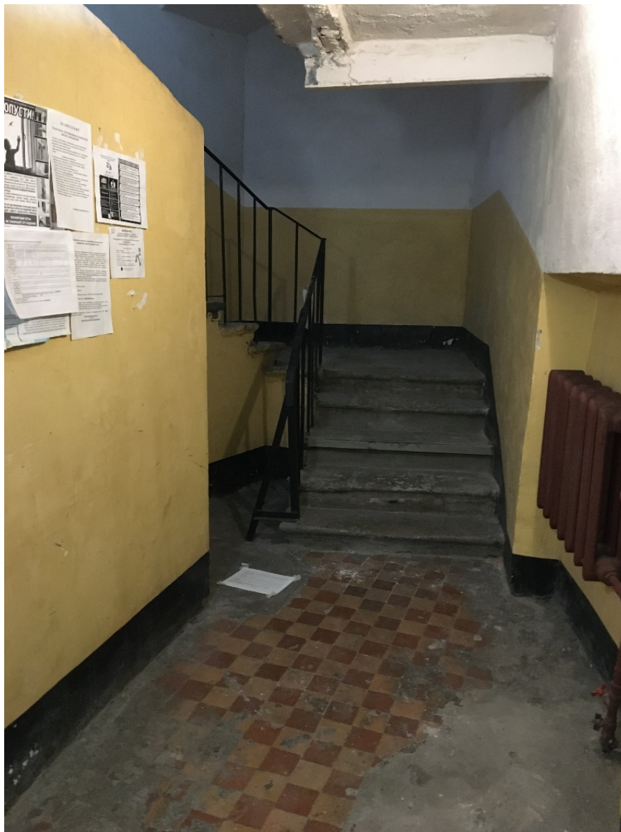
55. Лестница 5ЛК. Общий вид.
