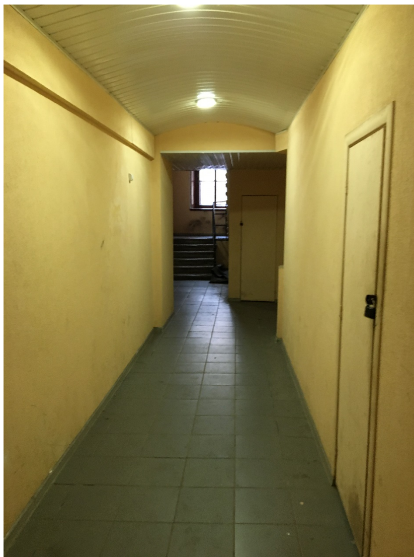
48. Лестница 4ЛК. Вестибюль. Общий вид.
