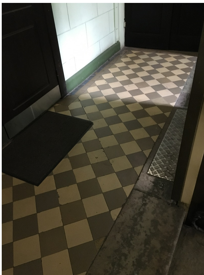
45. Парадная лестница 2ЛК. Площадка 2 этажа.
