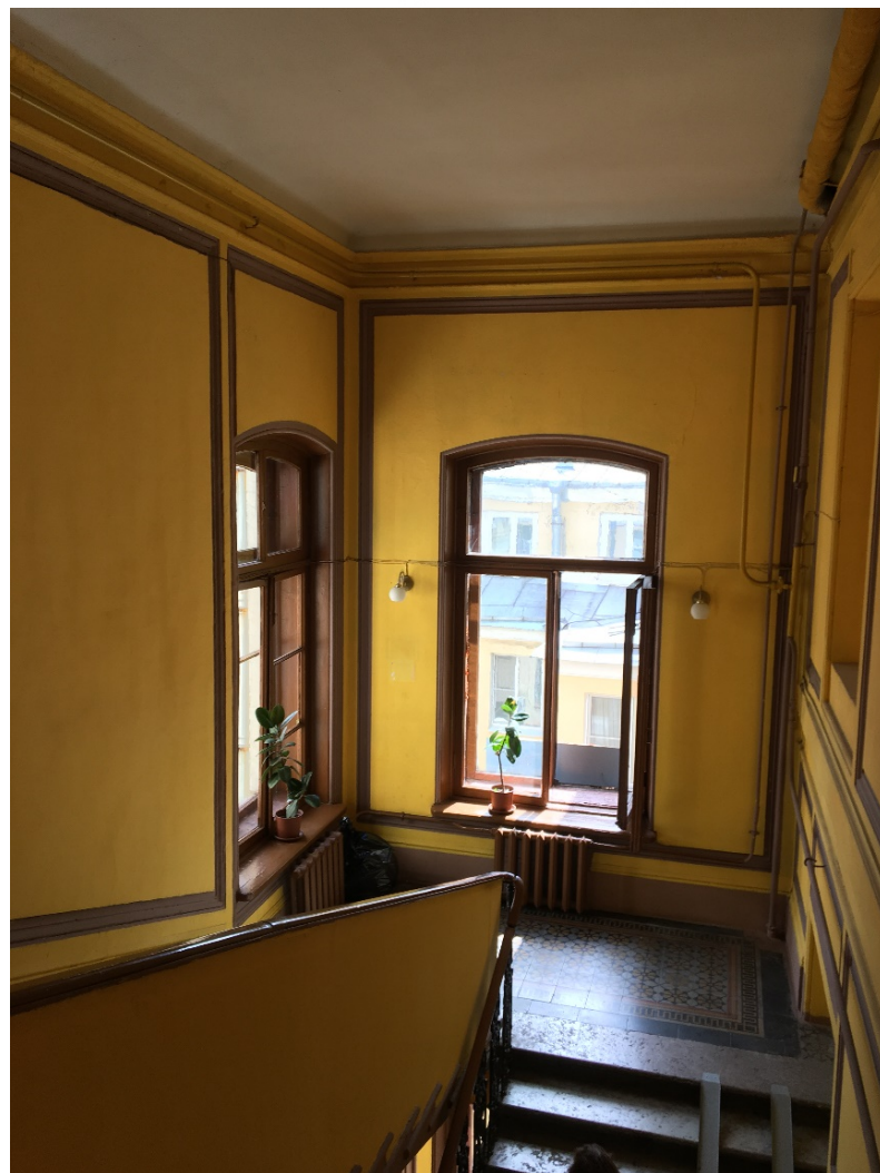
39. Оформление перекрытия лестничного объема.
