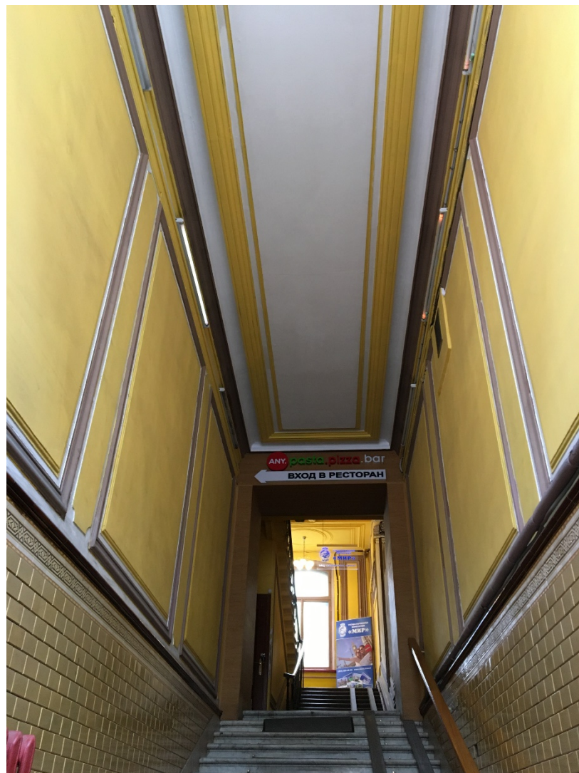
32. Парадная лестница 1ЛК. Парадный вестибюль. Общий вид.
