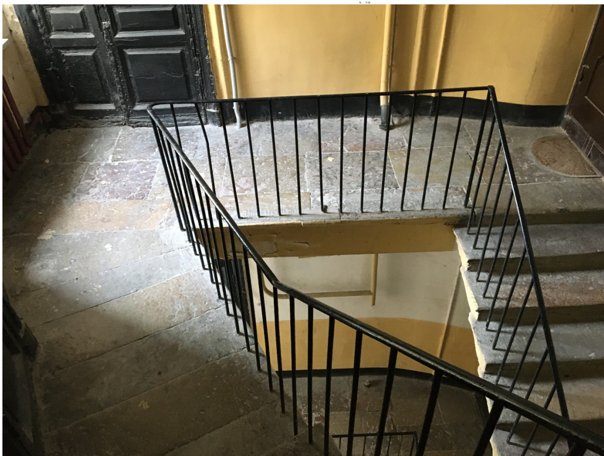
58. Лестница 5ЛК. Площадка 2 этажа.
