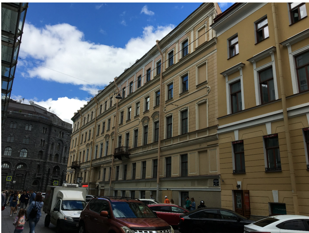
16. Лицевой фасад по Кирпичному переулку выявленного объекта культурного наследия «Дом А.И. Трейберга», расположенного по адресу: г. Санкт-Петербург, Невский пр., 11; Морская Малая ул., 2; Кирпичный пер., 2.
