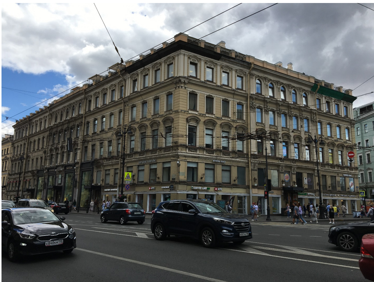
1. Лицевые фасады выявленного объекта культурного наследия «Дом А.И. Трейберга», расположенного по адресу: г. Санкт-Петербург, Невский пр., 11; Морская Малая ул., 2; Кирпичный пер., 2.
