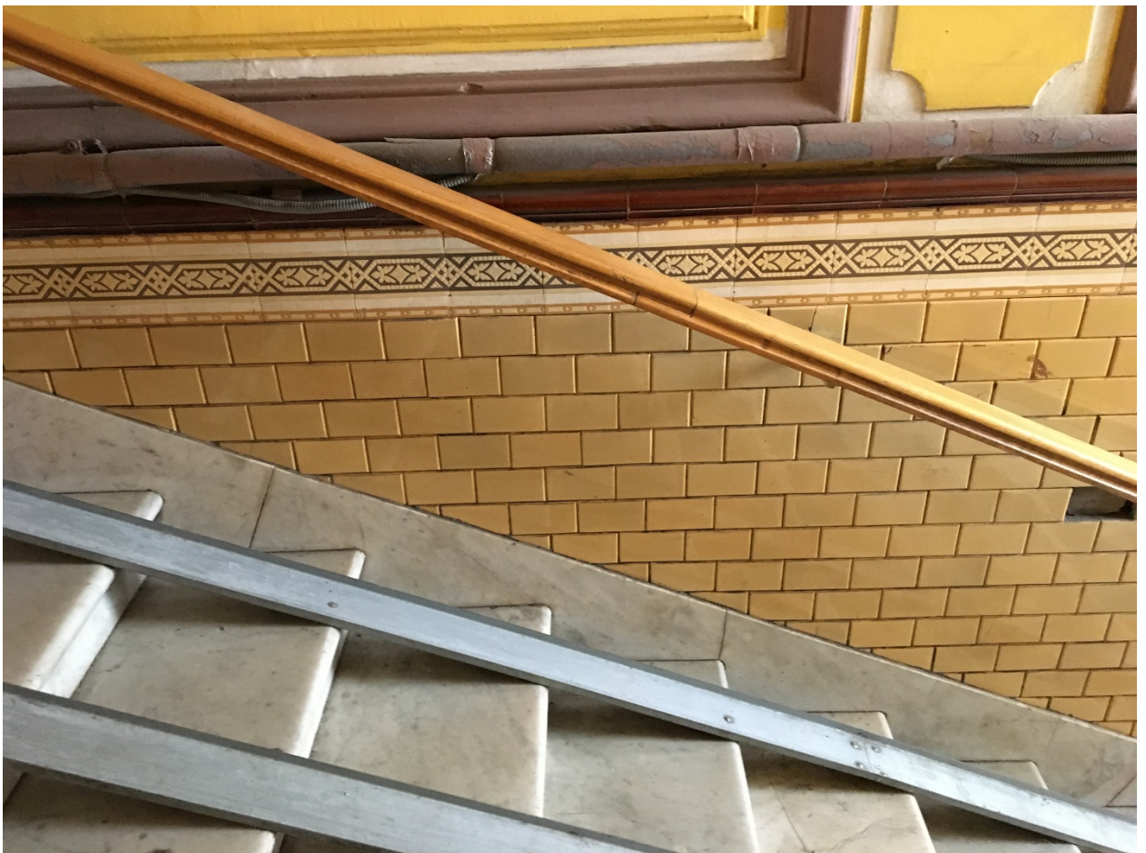
33. Парадная лестница 1ЛК. Оформление стен вестибюля 1 этажа.
