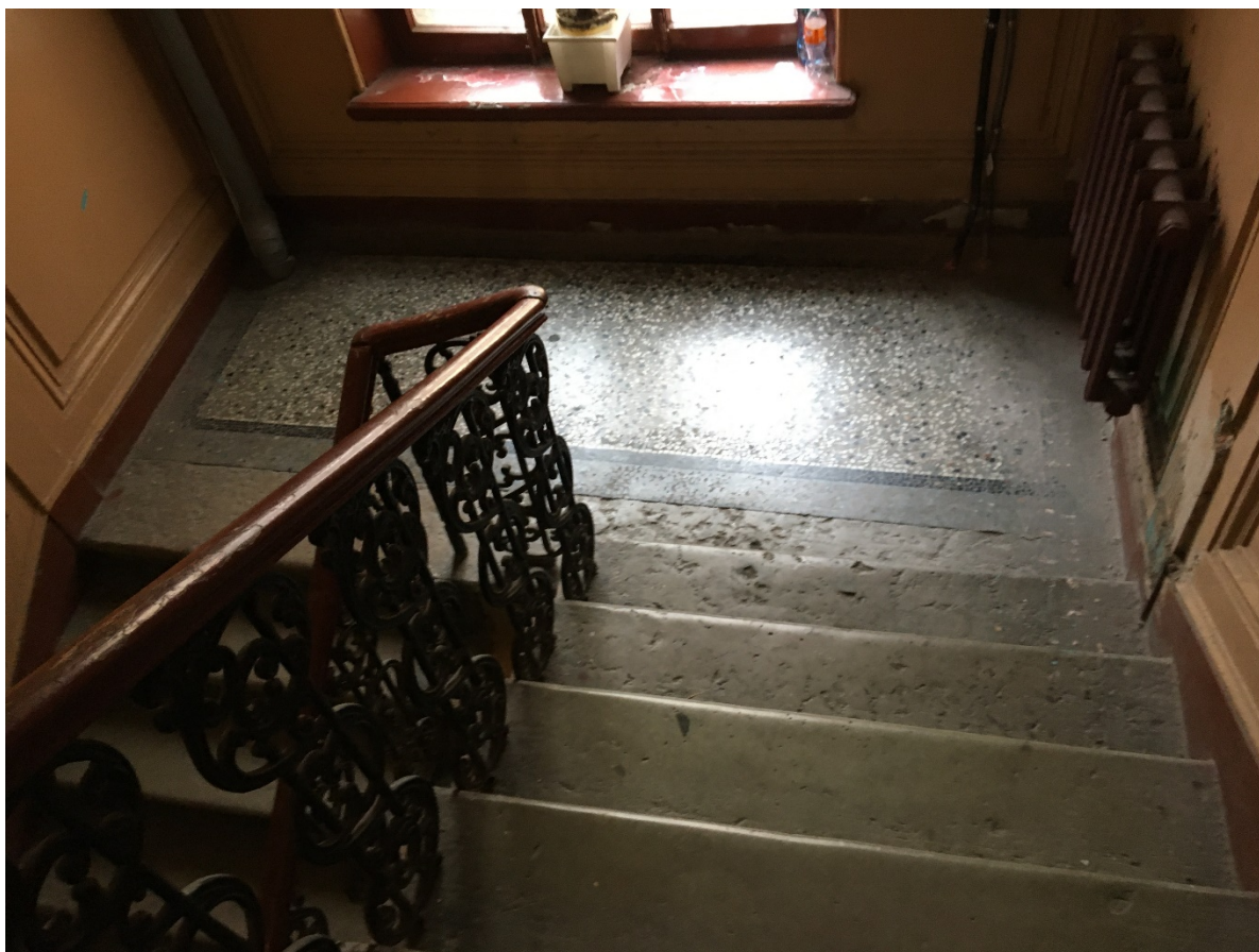
52. Лестница 4ЛК. Площадка между 2 и 3 этажами.
