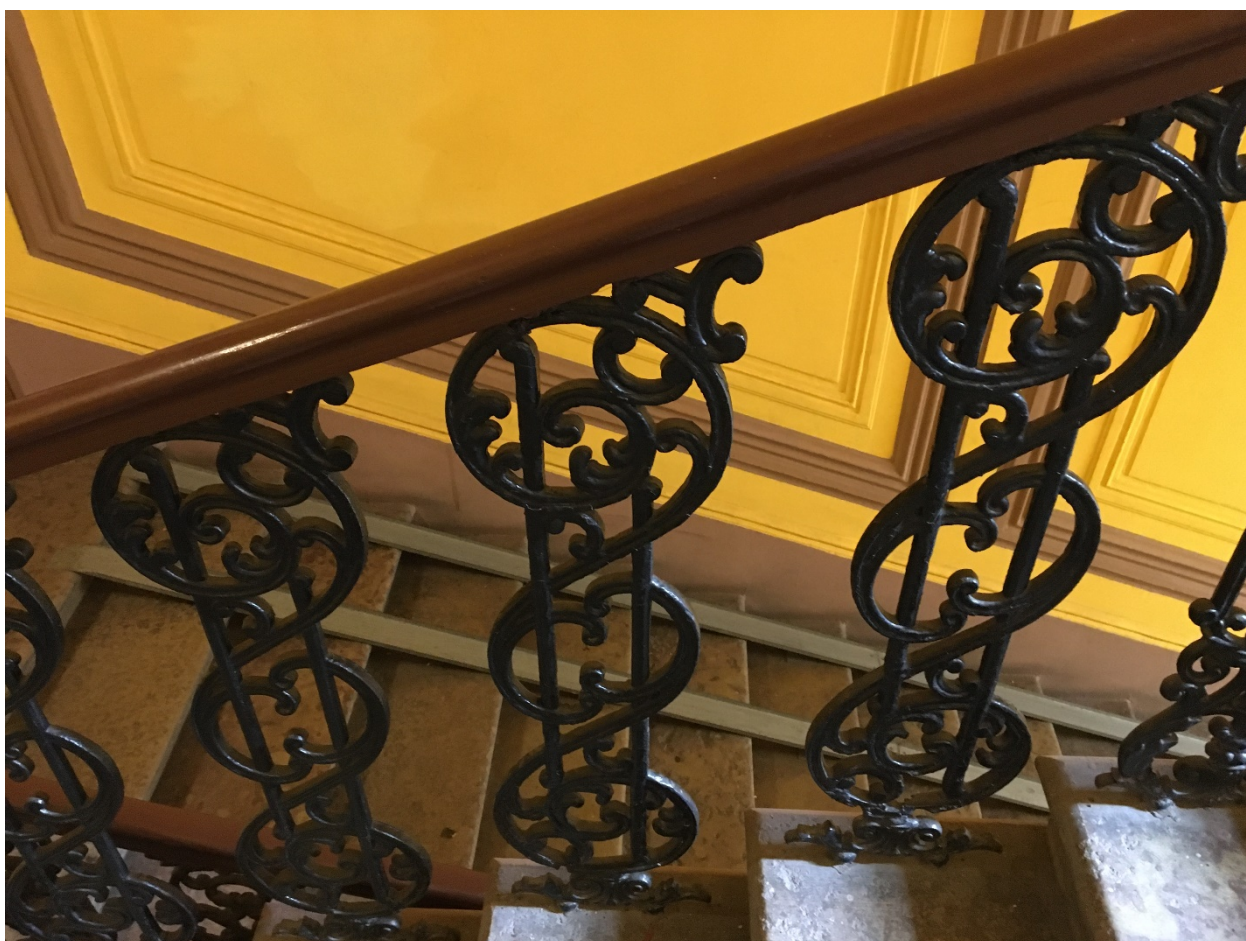
37. Парадная лестница 1ЛК. Ограждения лестницы.
