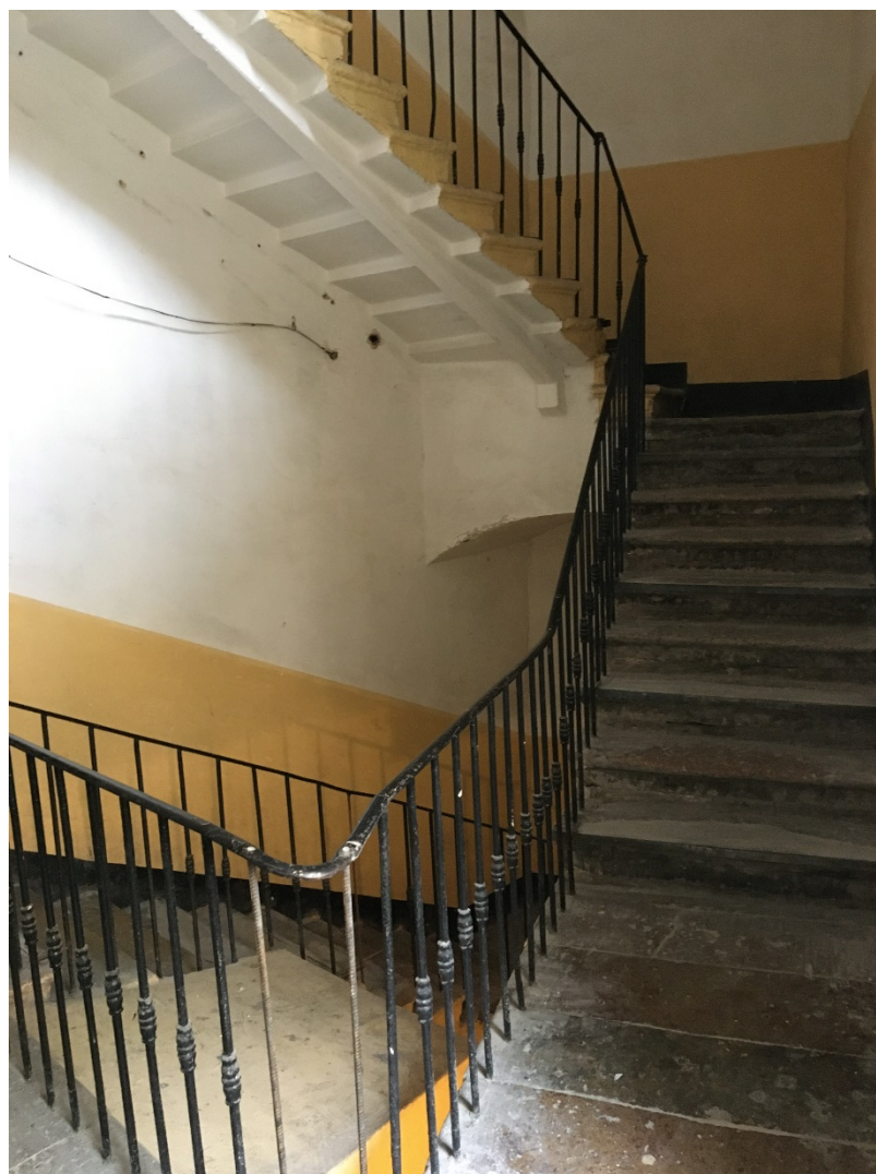
56. Лестница 5ЛК. Общий вид.
