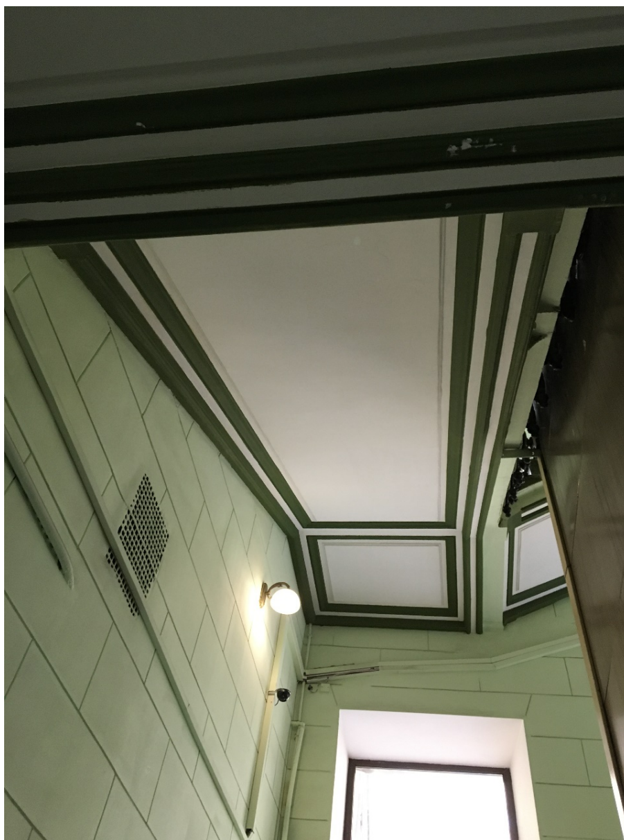
42. Парадная лестница 2ЛК. Общий вид.
