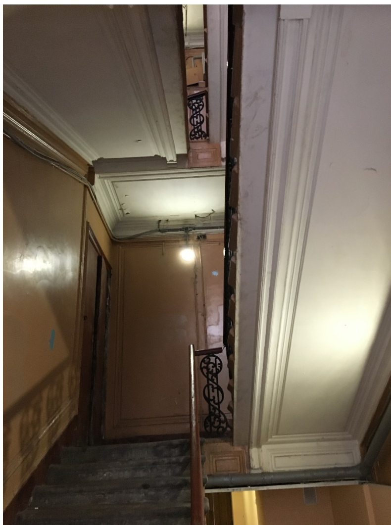
49. Лестница 4ЛК. Общий вид.
