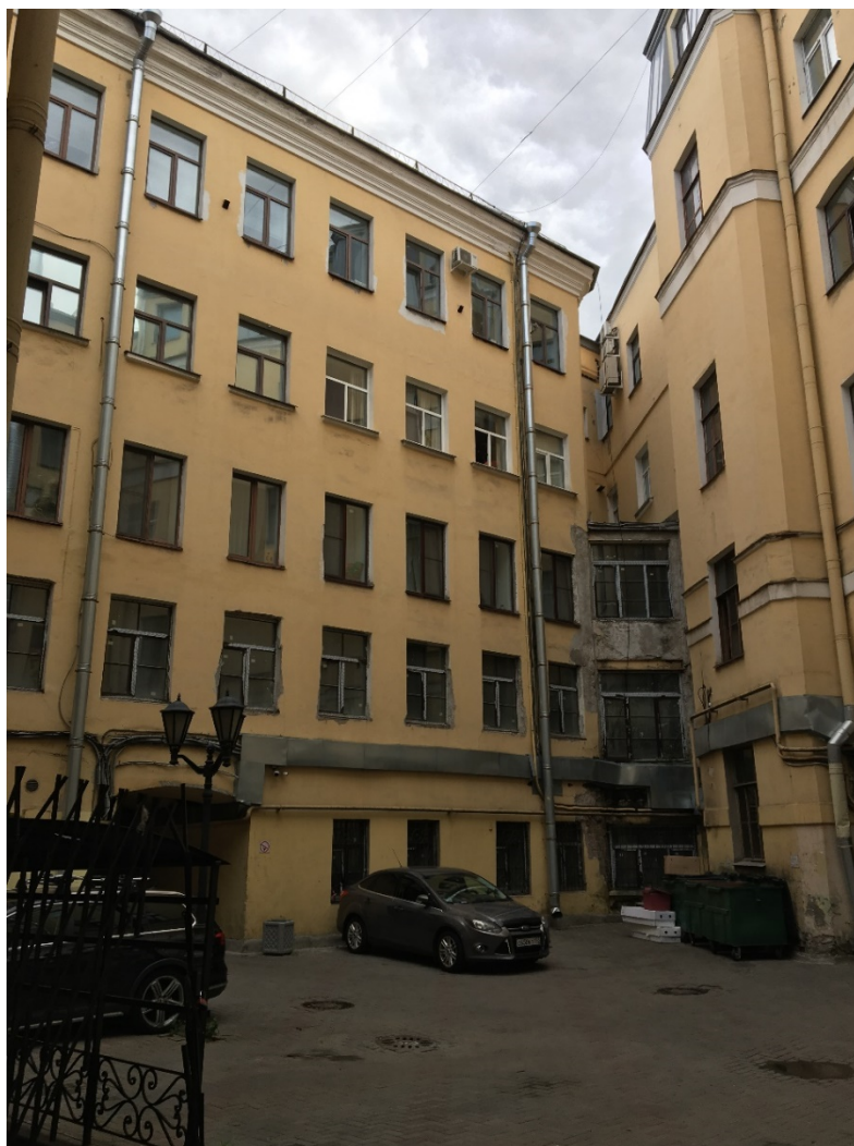
25. Фасады западного двора. Общий вид.
