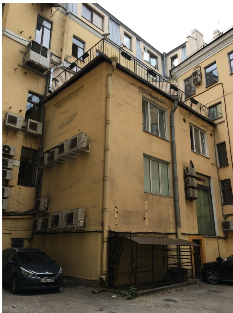
24. Фасад ы западного двора. Общий вид.
