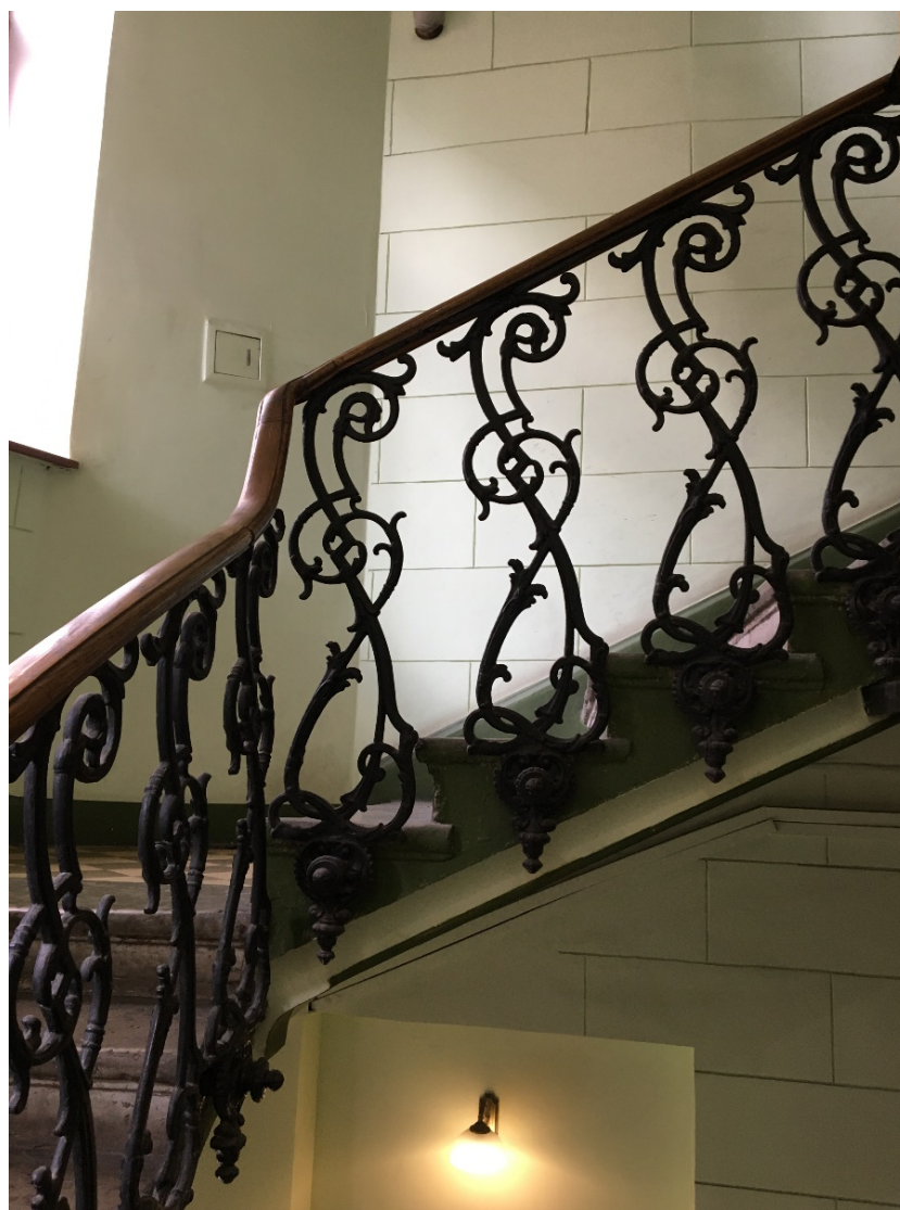
44. Парадная лестница 2ЛК. Ограждения лестницы.
