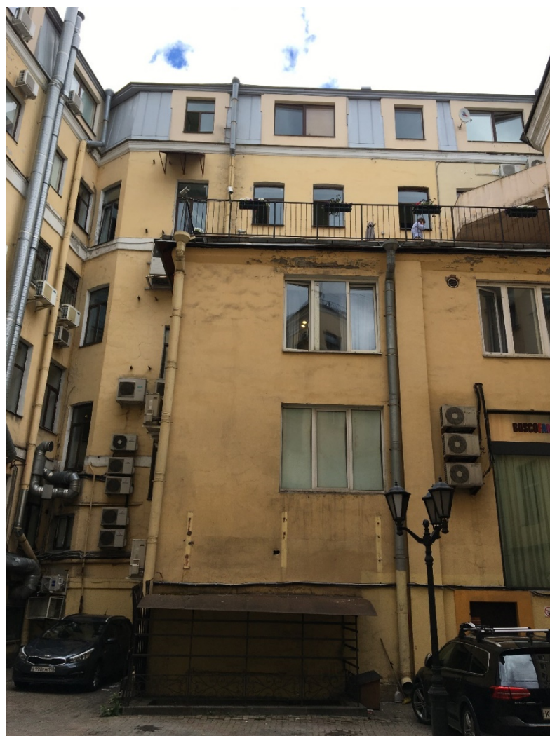
23. Фасад ы западного двора. Общий вид.
