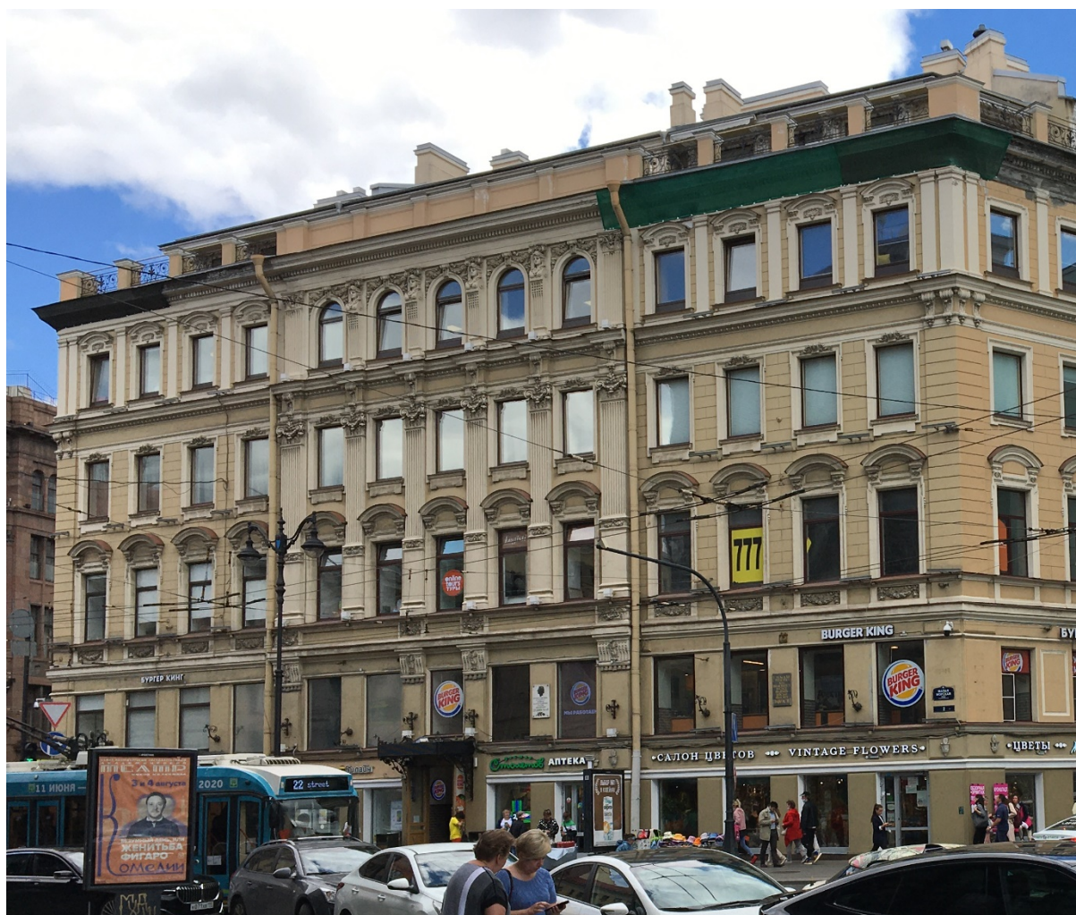
11. Лицевой фасад по Малой Морской улице выявленного объекта культурного наследия «Дом А.И. Трейберга», расположенного по адресу: г. Санкт-Петербург, Невский пр., 11; Морская Малая ул., 2; Кирпичный пер., 2. Общий вид.
