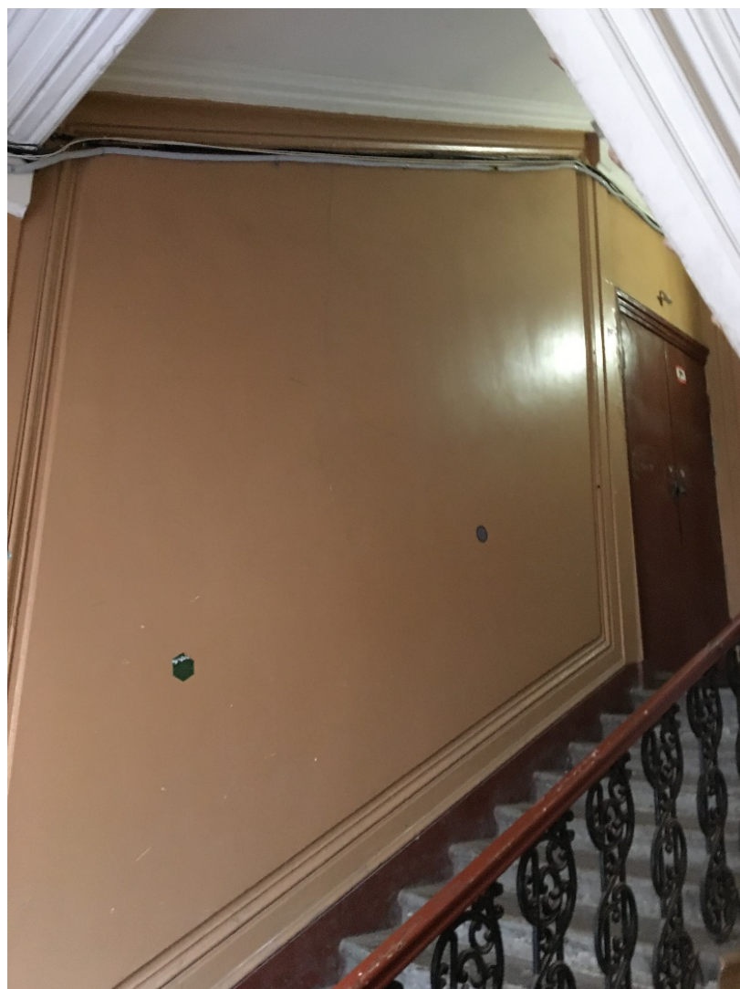
53. Лестница 4ЛК. Оформление стен.
