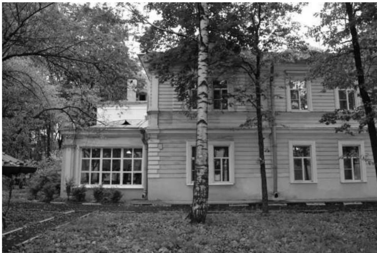
13. Дача Е.И. Исаевой. Фотография (август 2015 г.). Архив КГИОП 1561 Н-14882.
