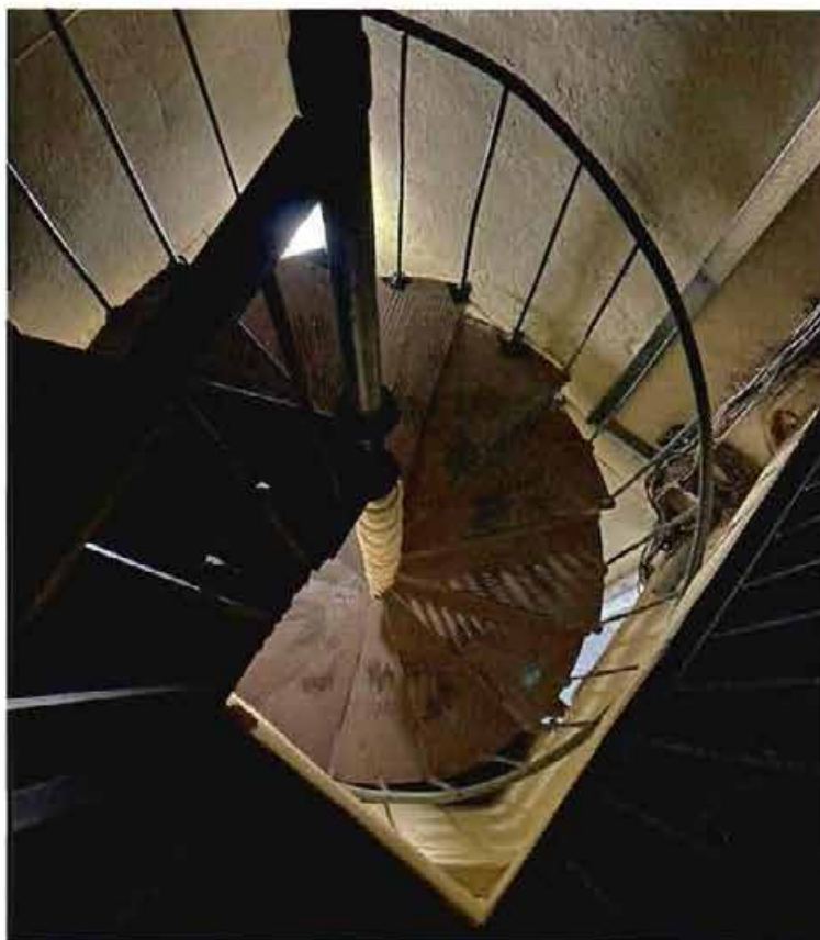
3. Металлическая винтовая лестница. Общий вид.
