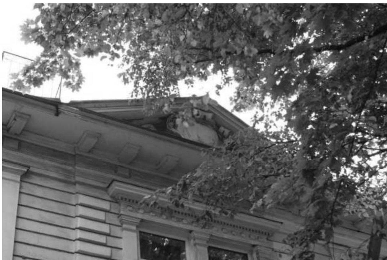
14. Дача Е.И. Исаевой. Фотография (август 2015 г.). Архив КГИОП 1561 Н-14882.
