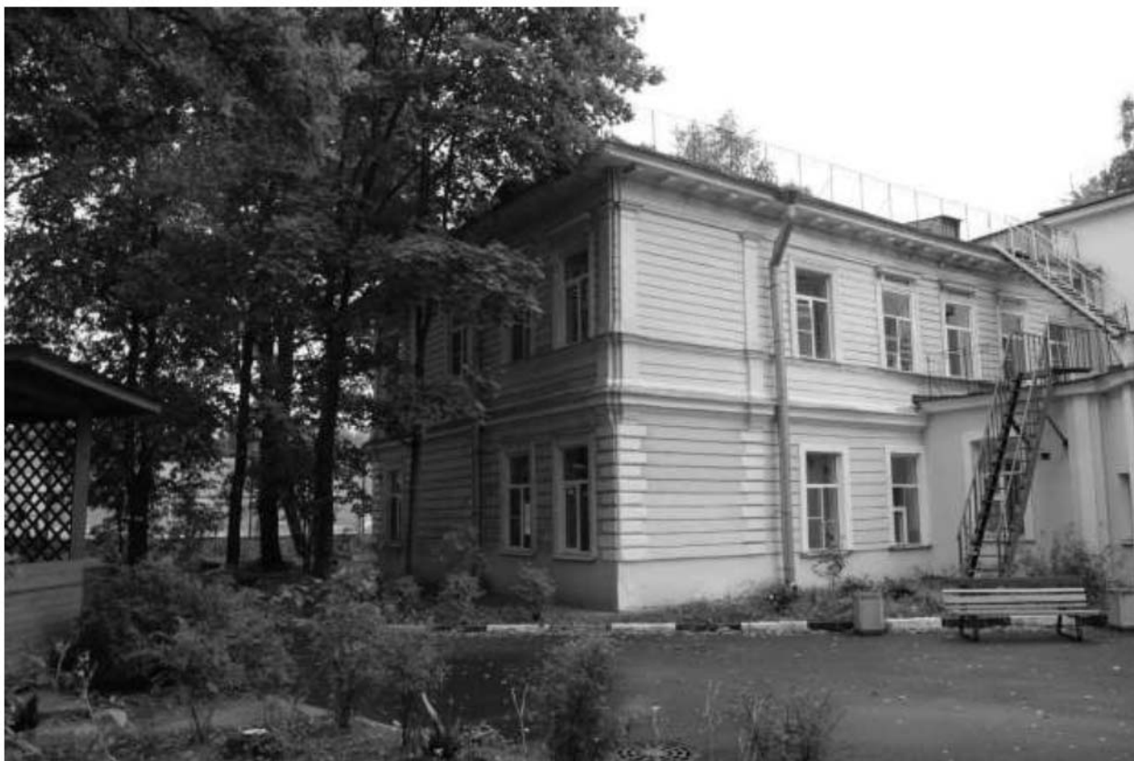
9. Дача Е.И. Исаевой. Фотография (август 2015 г.). Архив КГИОП 1561 Н-14882.
