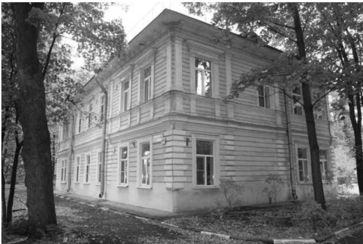
11. Дача Е.И. Исаевой. Фотография (август 2015 г.). Архив КГИОП 1561 Н-14882.
