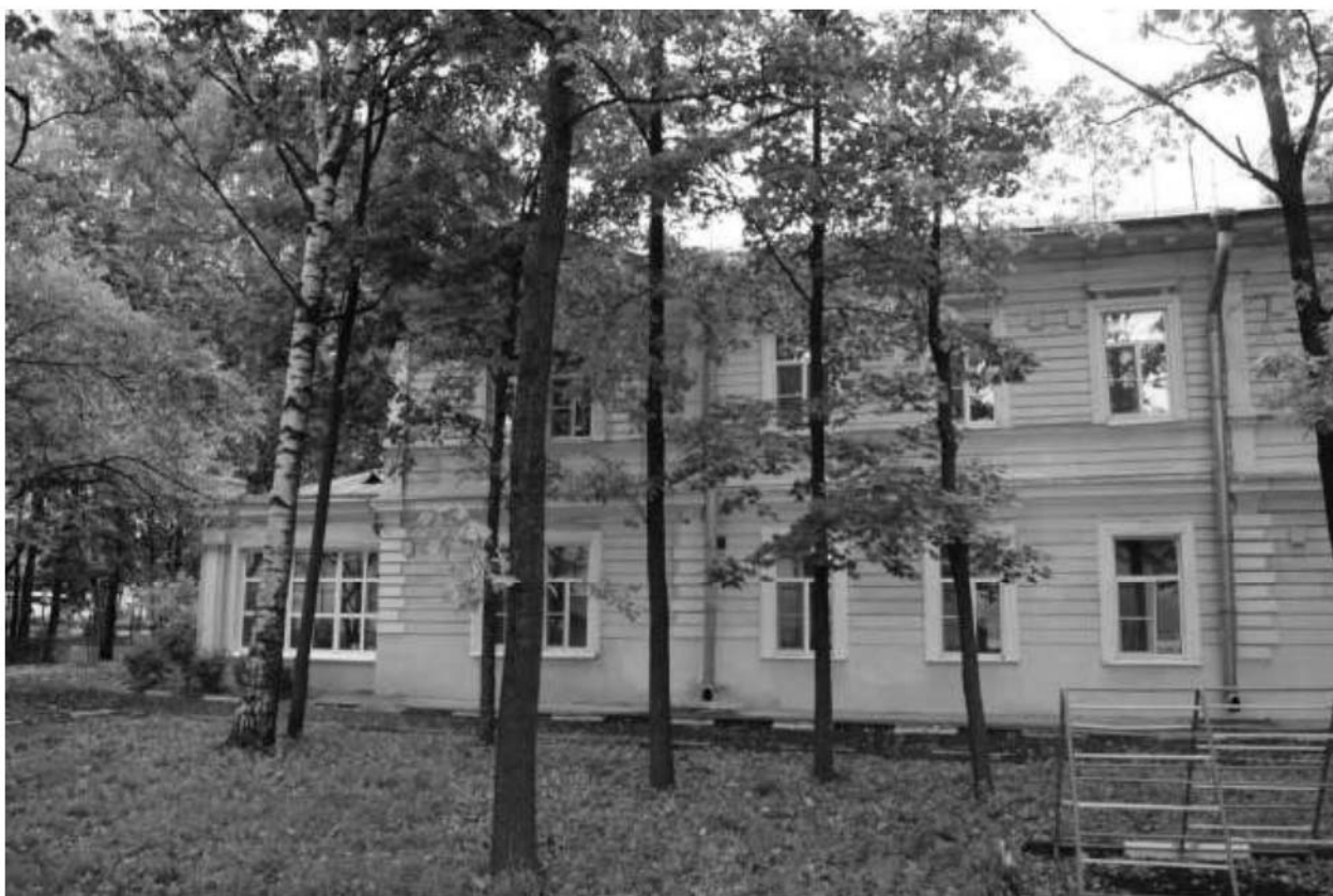
12. Дача Е.И. Исаевой. Фотография (август 2015 г.). Архив КГИОП 1561 Н-14882.
