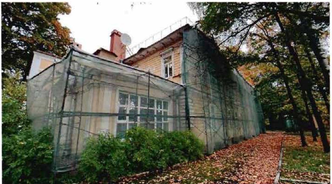
2. Южный фасад. Общий вид.
