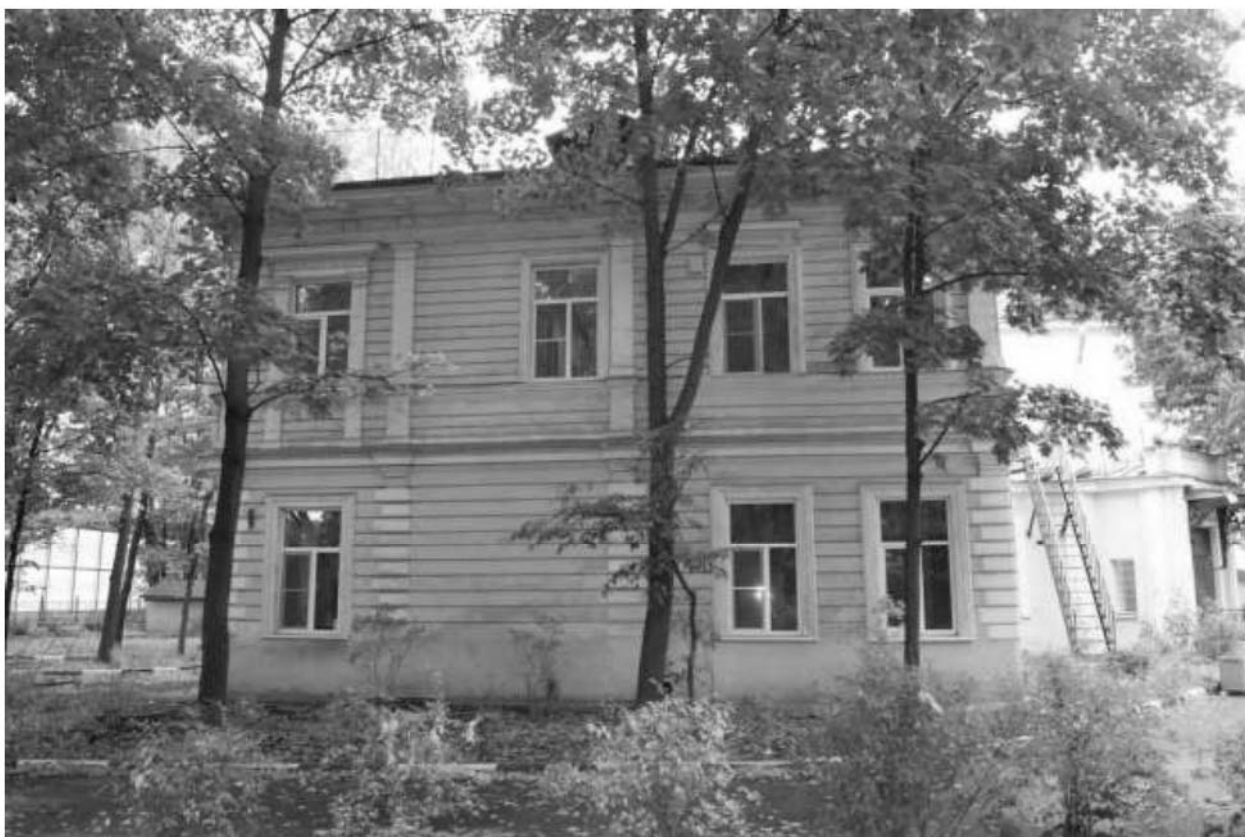
10. Дача Е.И. Исаевой. Фотография (август 2015 г.). Архив КГИОП 1561 Н-14882.
