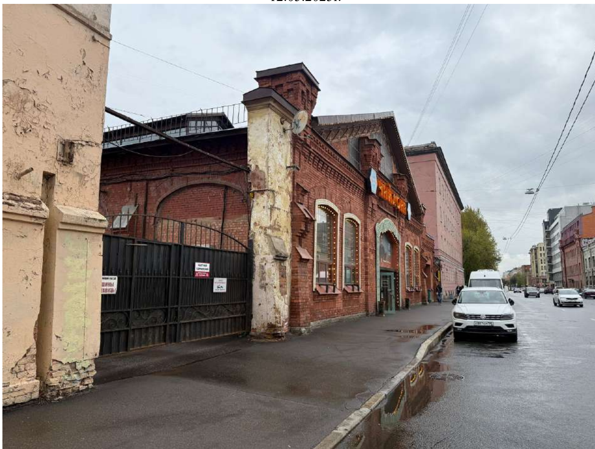
Фото 4. Общий вид со стороны улицы на ОКН «Производственный цех». Дата фотофиксации: 12.05.2025г.
