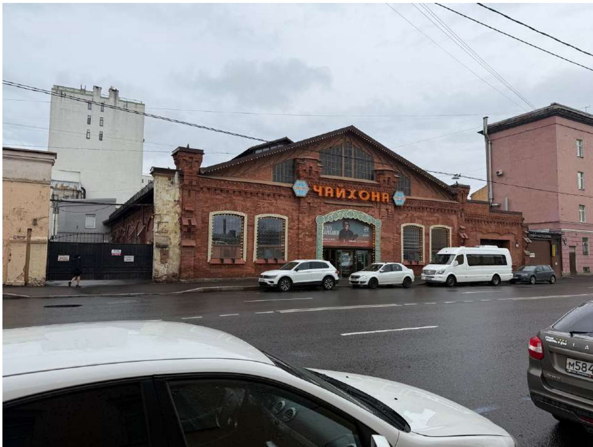
Фото 3. Общий вид со стороны улицы на ОКН «Производственный цех». Дата фотофиксации: 12.05.2025г.
