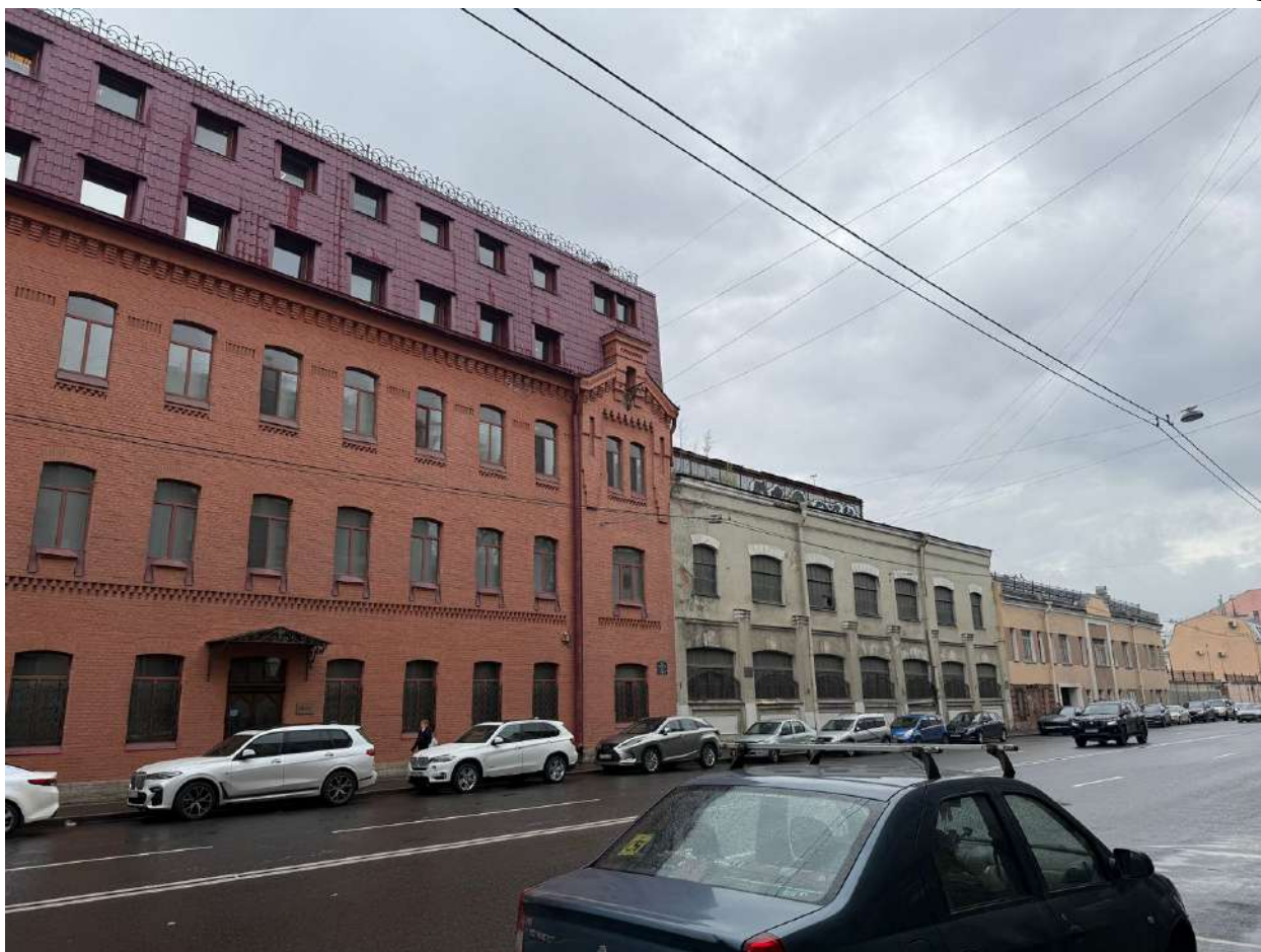
Фото 1. Общий вид со стороны улицы на ОКН «Комплекс построек Подковно-гвоздильного завода Э.Л. Посселя». Дата фотофиксации: 12.05.2025г.
