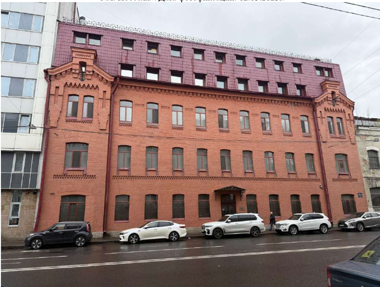
Фото 2. Общий вид со стороны улицы на ОКН «Комплекс построек Подковно-гвоздильного завода Э.Л. Посселя». Дата фотофиксации: 12.05.2025г.
