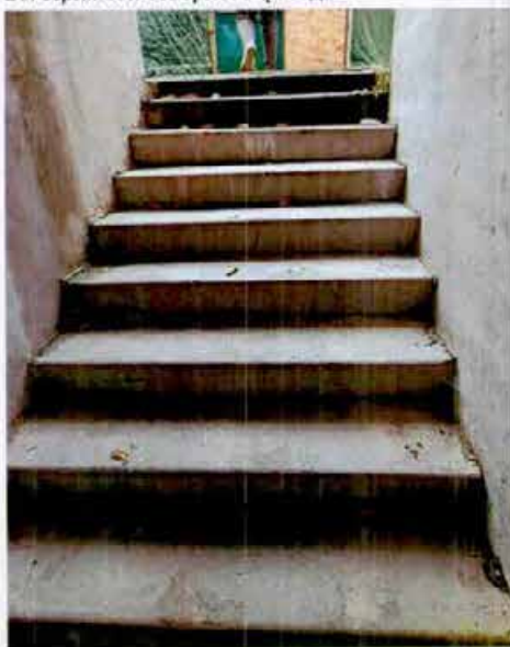
26. Прямо́к северного фасада.
