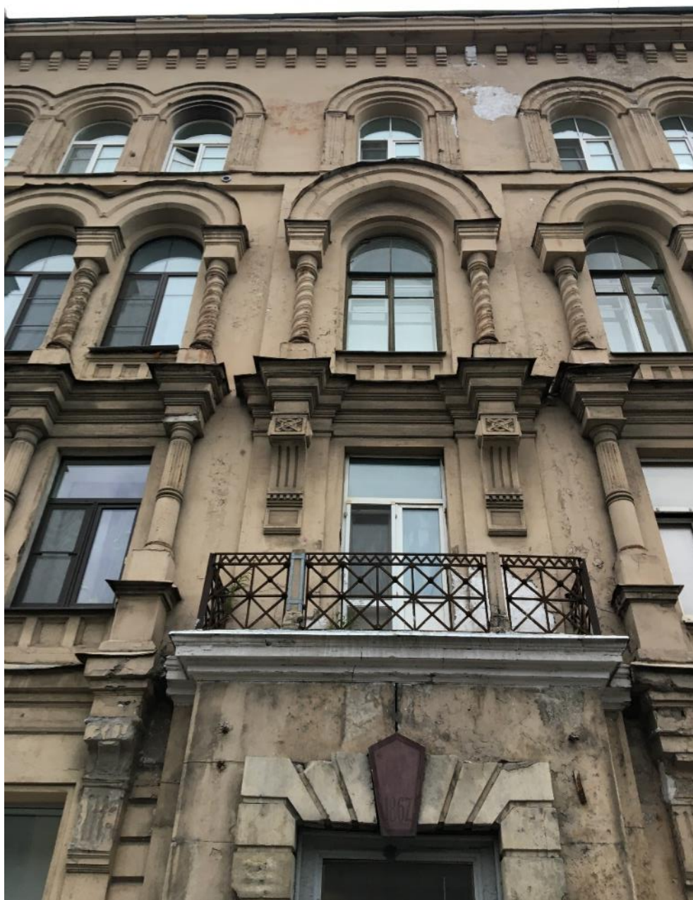
6. Лицевой фасад выявленного объекта культурного наследия «Дом Е.К. Эренберга», расположенного по адресу: г. Санкт-Петербург, Можовая ул., д. 4. Фрагмент.
