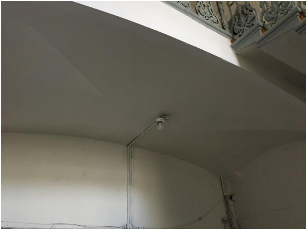
21. Парадная лестница Л-1. Основание площадки 3 этажа.
