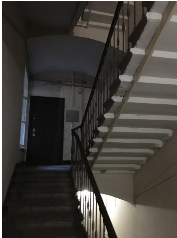
30. Лестница Л-2. Площадка 2 этажа.
