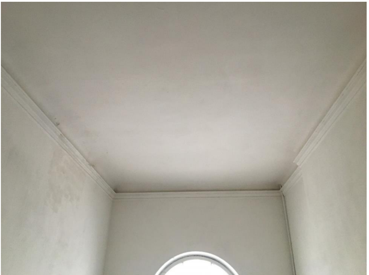
23. Парадная лестница Л-1. Перекрытие объема лестницы.
