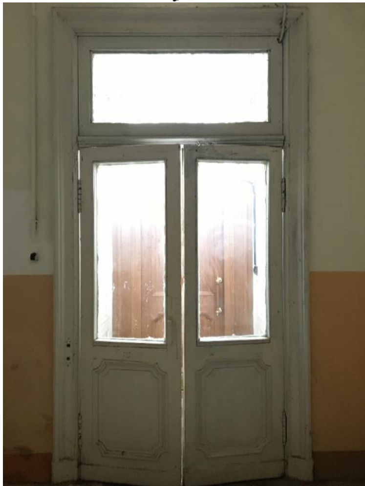
17. Парадная лестница Л-1. Вестибюль. Дверное заполнение тамбура.
