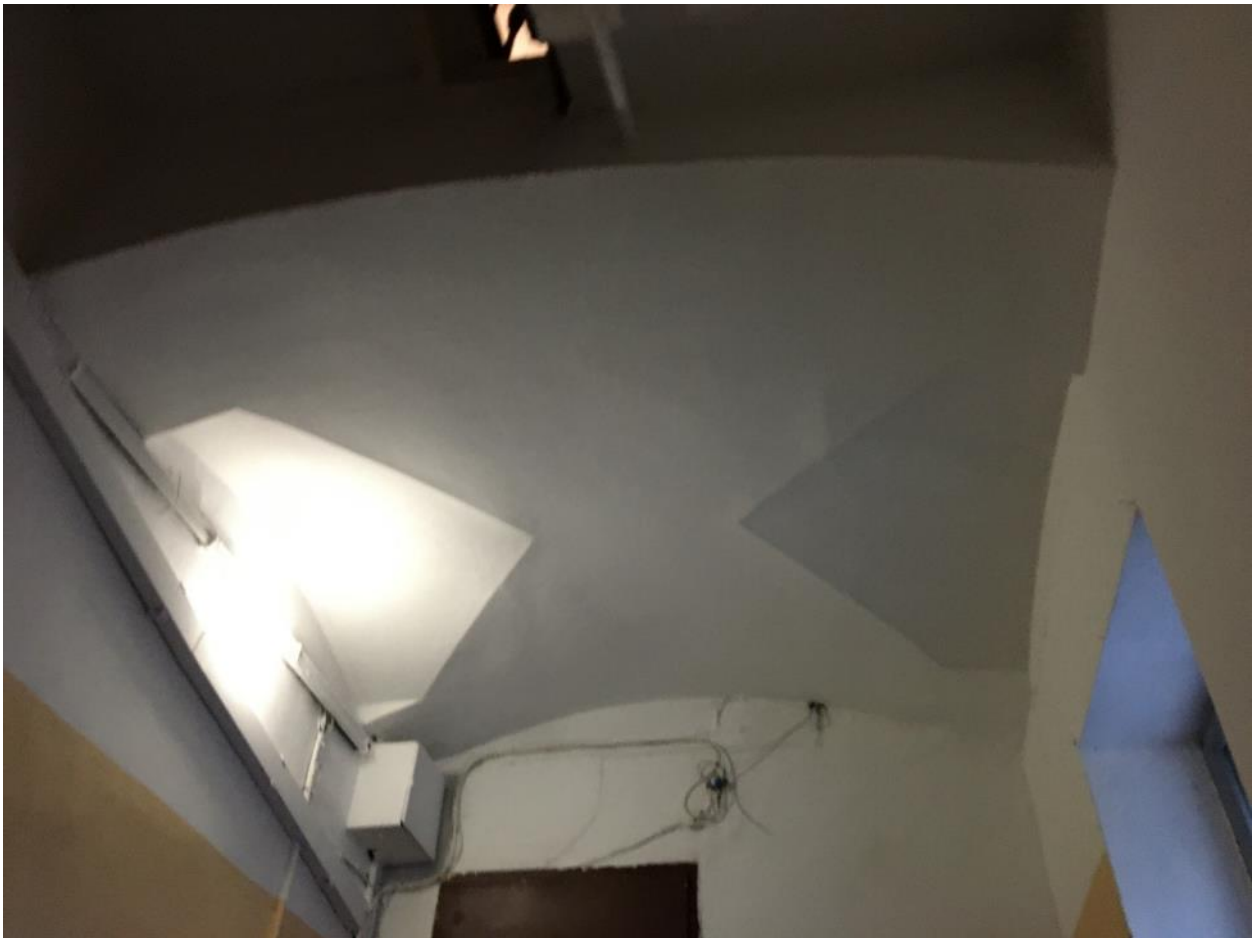
27. Лестница Л-3. Основание площадки 3 этажа.
