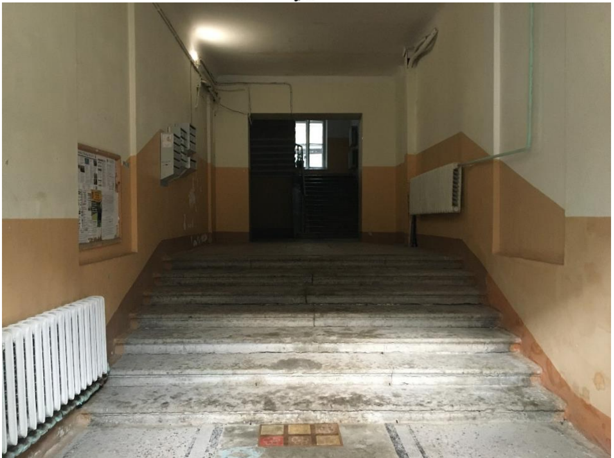
16. Парадная лестница Л-1. Вестибюль.
