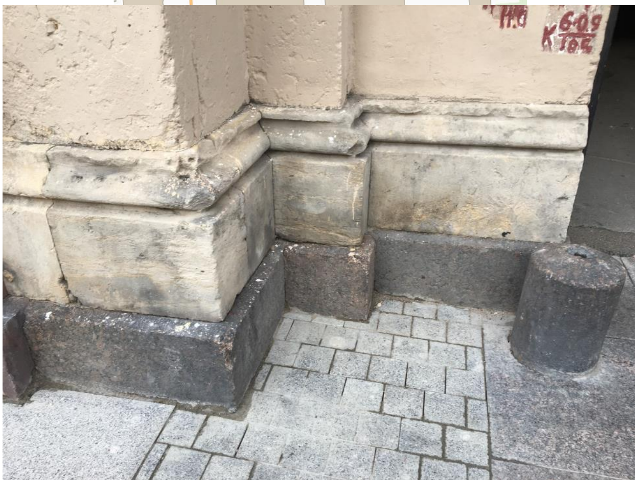
7. Лицевой фасад выявленного объекта культурного наследия «Дом Е.К. Эренберга», расположенного по адресу: г. Санкт-Петербург, Можовая ул., д. 4. Фрагмент
