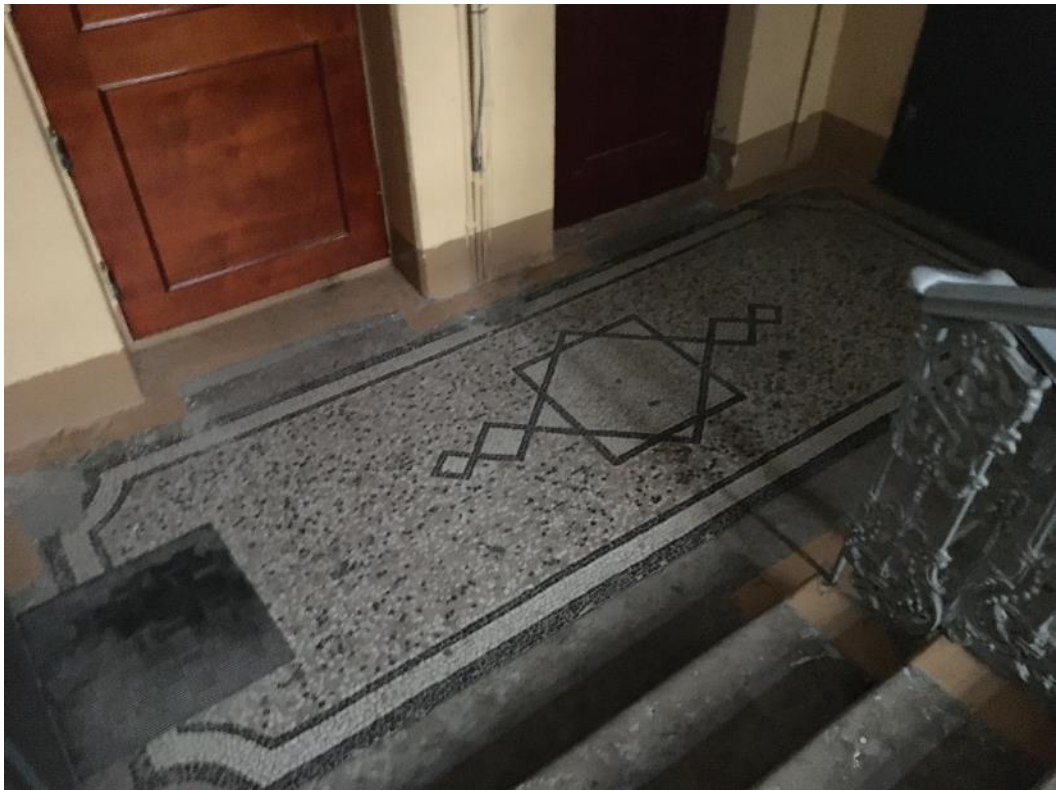
20. Парадная лестница Л-1. Площадка 2 этажа.
