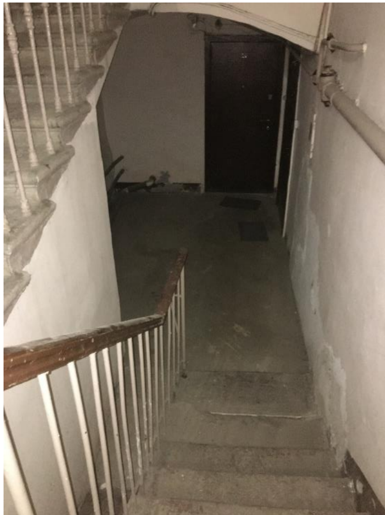
28. Лестница Л-2. Площадка 1 этажа.
