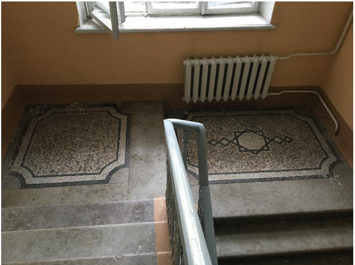
22. Парадная лестница Л-1. Площадка между 3 и 4 этажами.
