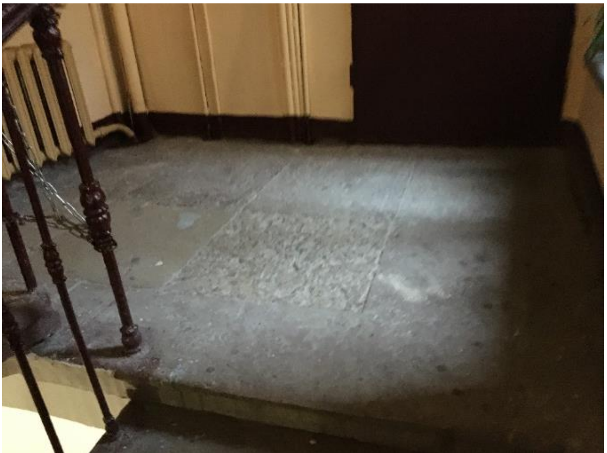
26. Лестница Л-3. Площадка 2 этажа.
