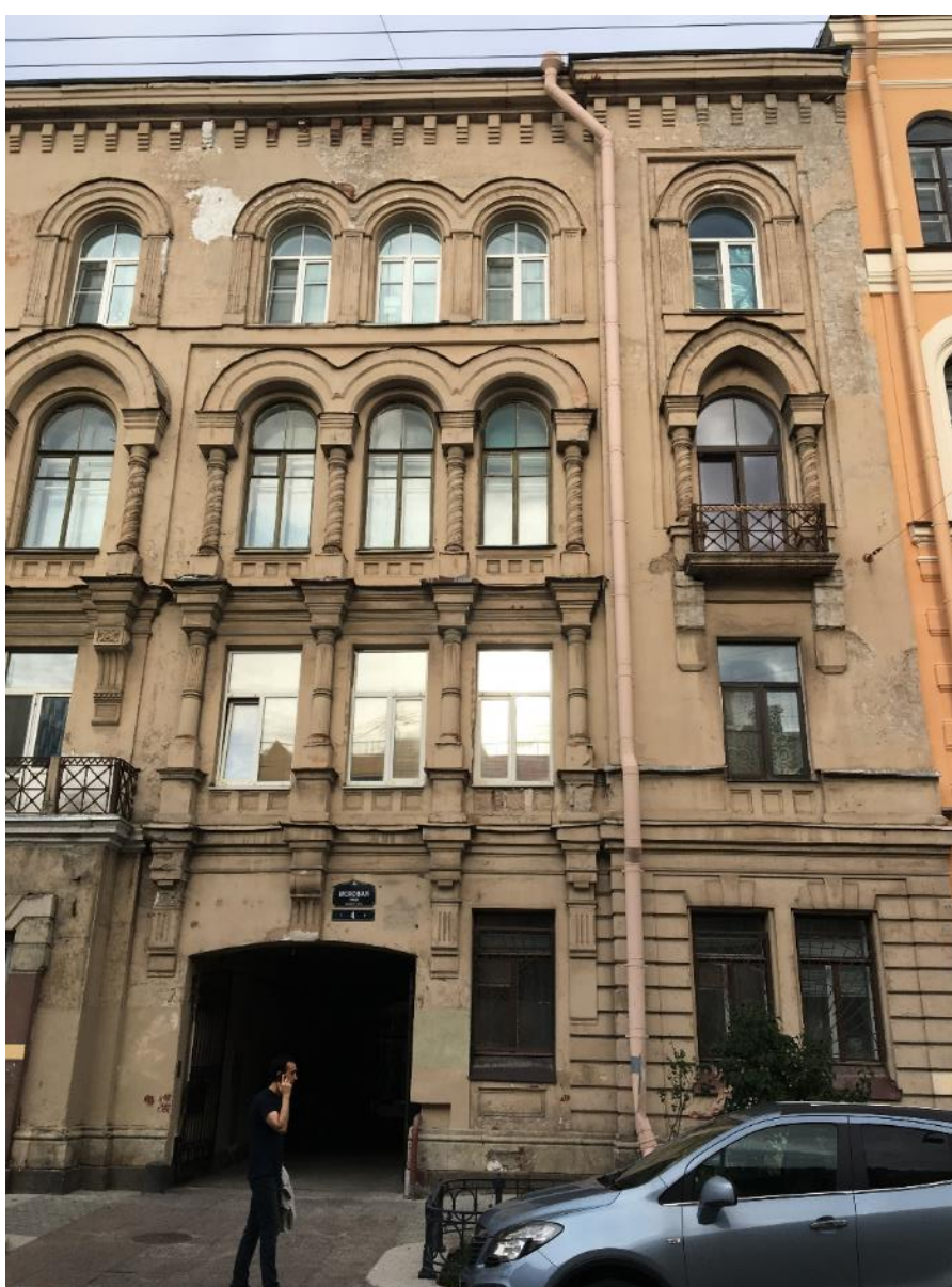
3. Лицевой фасад выявленного объекта культурного наследия «Дом Е.К. Эренберга», расположенного по адресу: г. Санкт-Петербург, Можовая ул., д. 4. Фрагмент.
