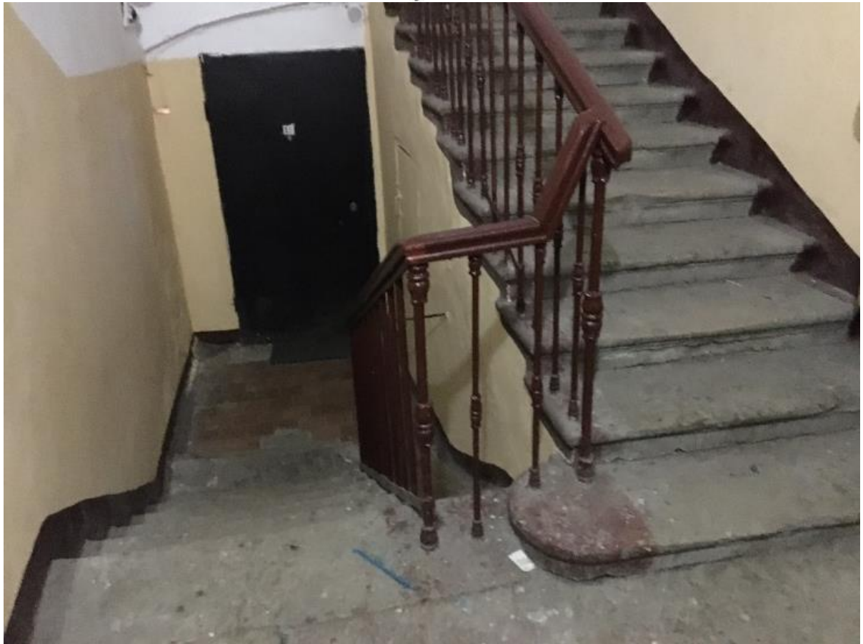
24. Лестница Л-3. Площадка 1 этажа.
