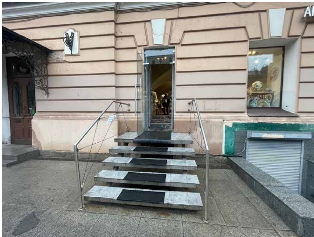
2. Вид на входную дверь в помещение 27-Н;
