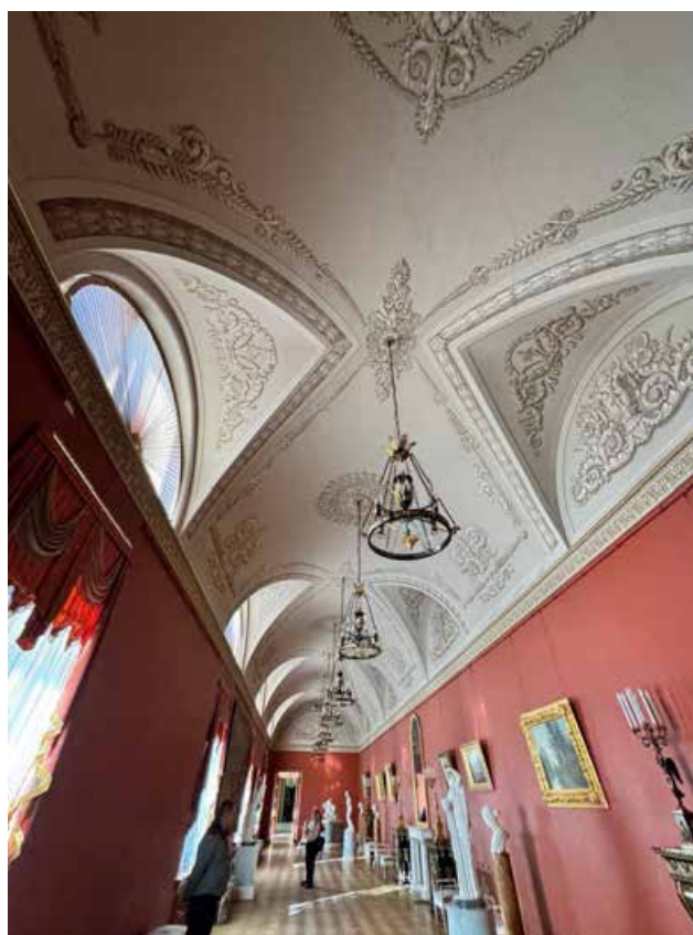
Фото 4. Свод цилиндрический с распалубками. Роспись распалубок в технике гризайль. Лепной карниз вдоль стен галереи. Дата фотофиксации: 17.02.25.
