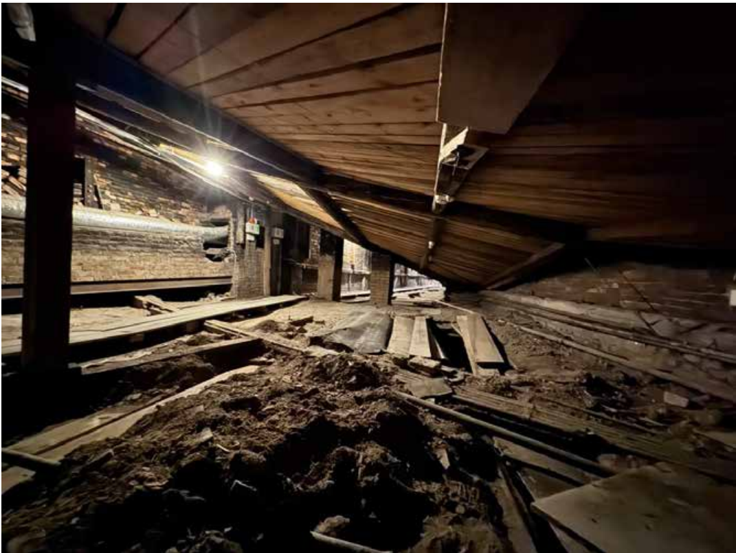
Фото 24. Чердачное помещение над помещением Античной галереи. Общий вид с северной стороны. Дата фотофиксации: 17.02.25.
