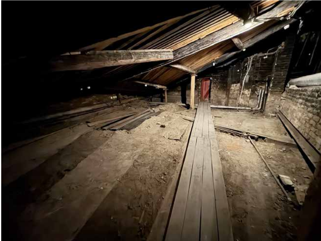
Фото 25. Вход в чердачное пространство над помещением Античной галереи с северной стороны. Дата фотофиксации: 17.02.25.
