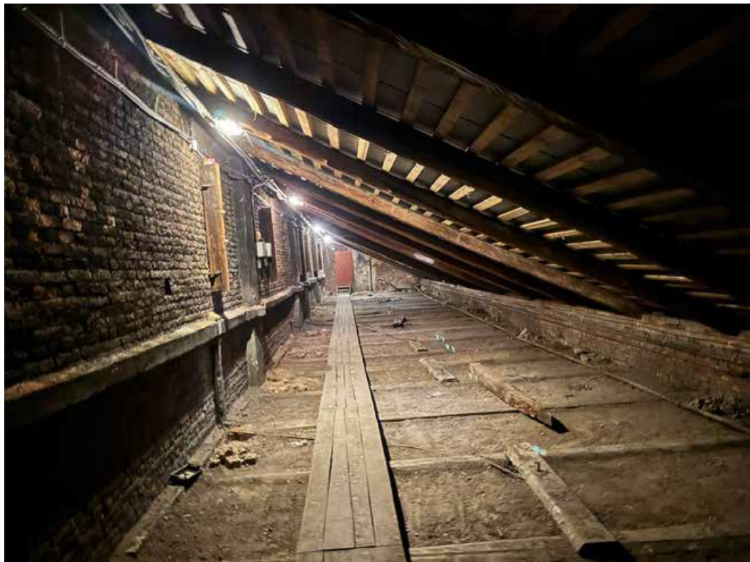
Фото 26. Вход в чердачное пространство над помещением Античной галереи с южной стороны. Дата фотофиксации: 17.02.25.
