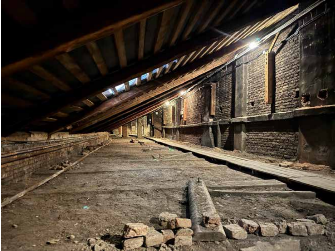
Фото 23. Чердачное помещение над Античной галереей. Общий вид. Дата фотофиксации: 17.02.25.
