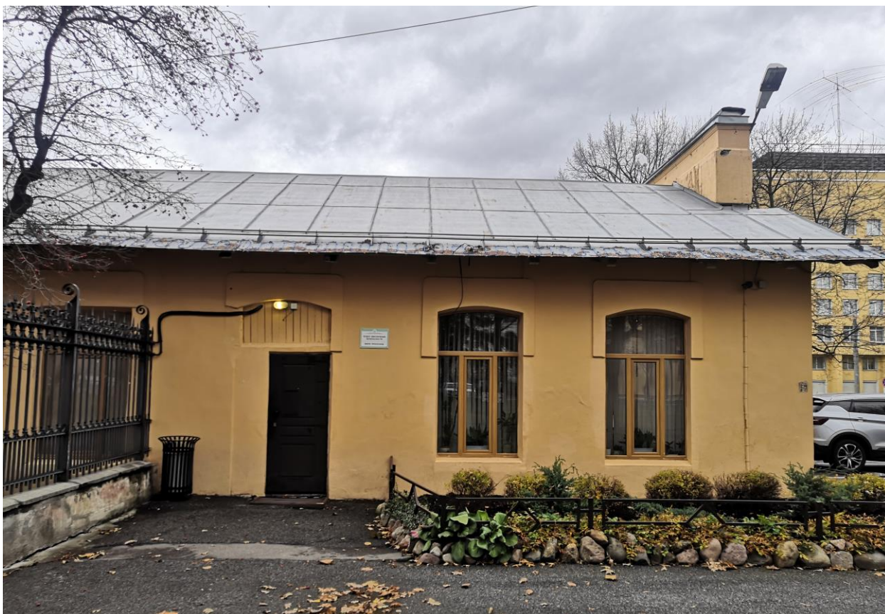
Илл. 3. Вид на фрагмент северного фасада. Адрес: Санкт-Петербург, ул. Гидротехников, д.5, лит. А.
