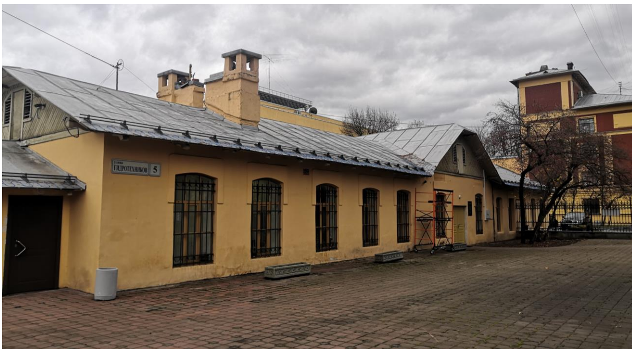
Илл. 15. Общий вид на южный фасад с юго-запада. Адрес: Санкт-Петербург, ул. Гидротехников, д.5, лит. А.
