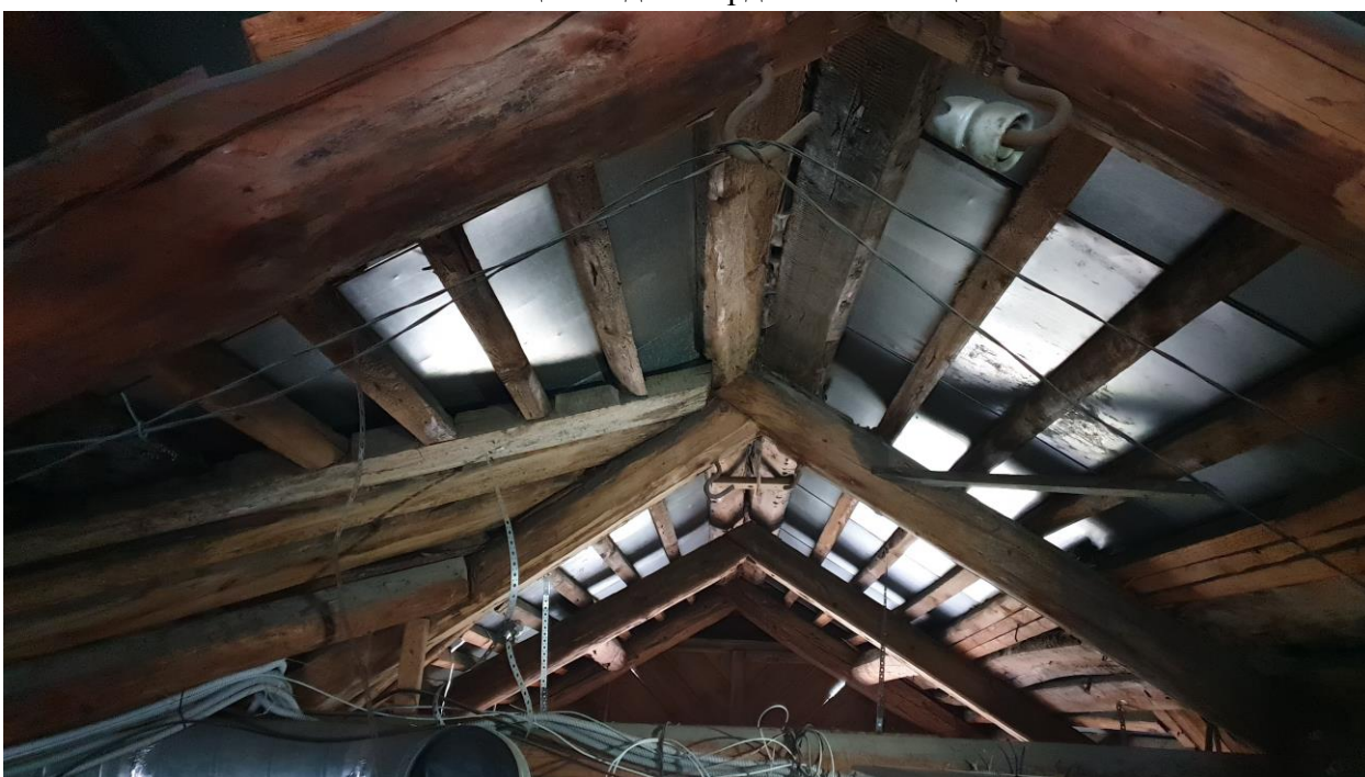
Илл. 20. Общий вид на чердачное помещение.
