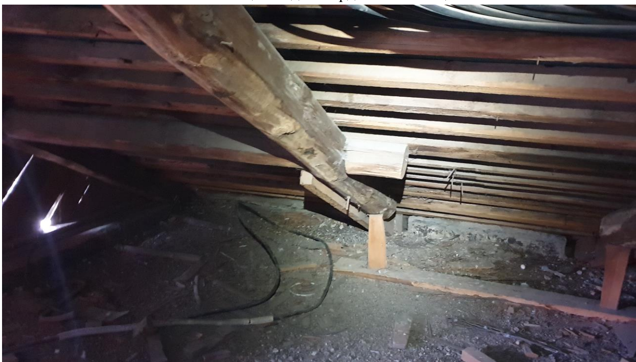
Илл. 18. Общий вид на чердачное помещение. Стропильная система.
