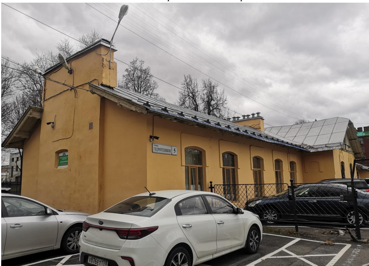
Илл. 6. Общий вид на здание с востока. Адрес: Санкт-Петербург, ул. Гидротехников, д.5, лит. А.
