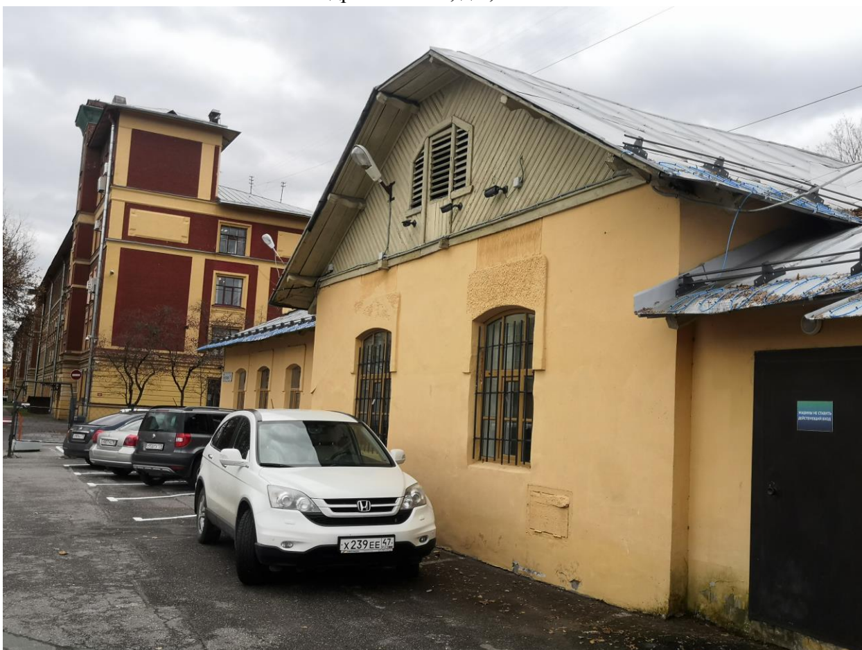
Илл. 8. Вид на фрагмент северного фасада. Адрес: Санкт-Петербург, ул. Гидротехников, д.5, лит. А.
