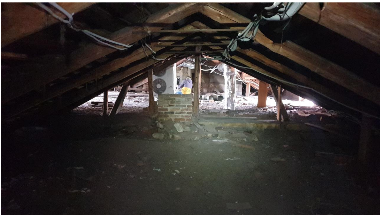
Илл. 19. Общий вид на чердачное помещение.
