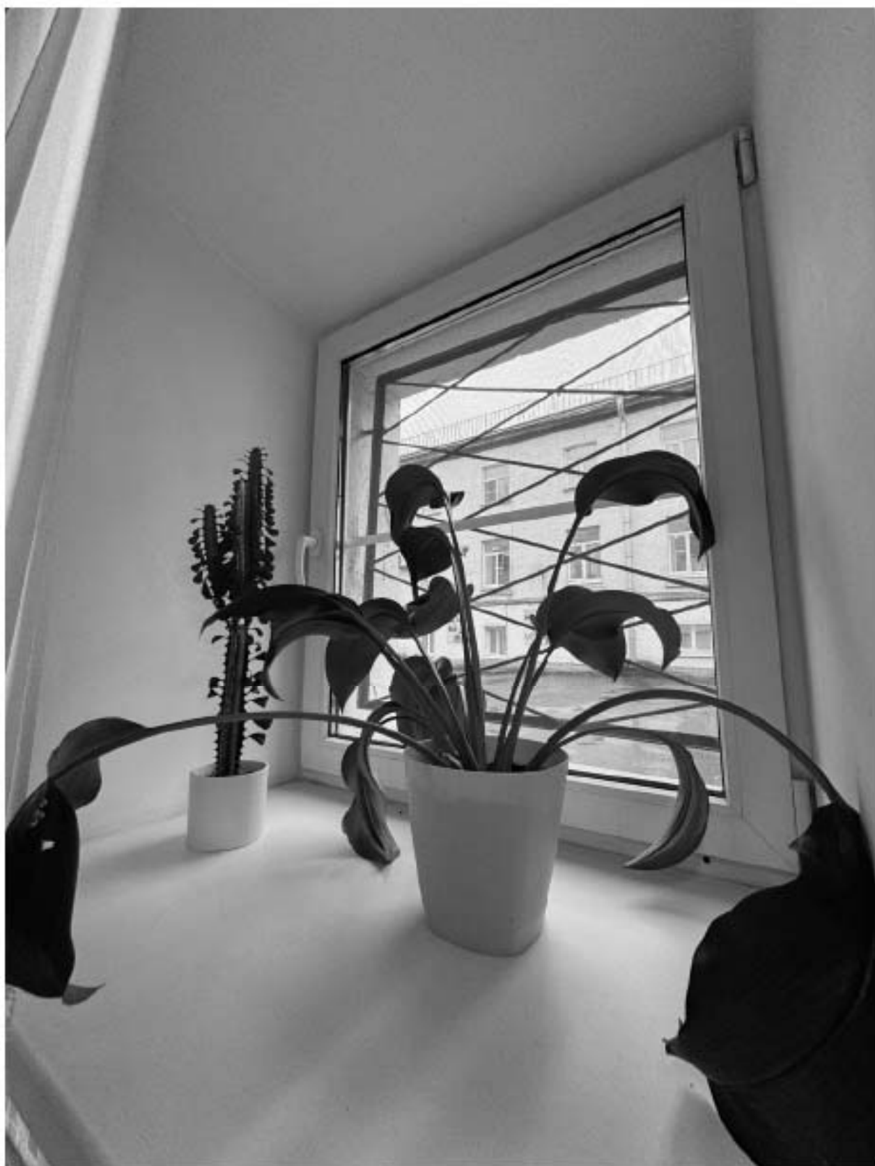
Фото 40. Вид на оконное заполнение помещения 41-Н объекта культурного наследия.
