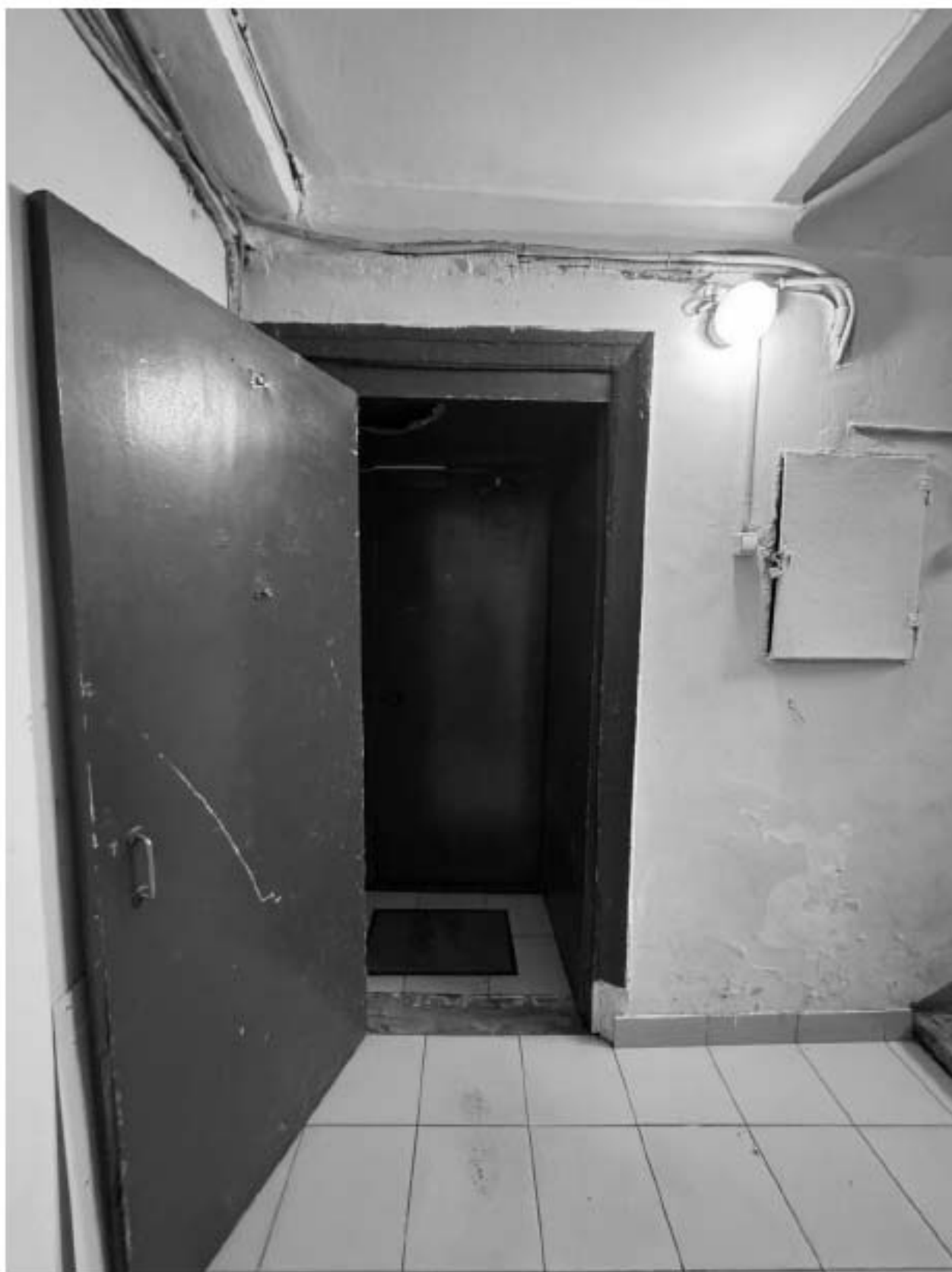
Фото 12. Вид на дверное заполнение тамбура парадной, ведущей к помещению 41-Н, объекта культурного наследия.
