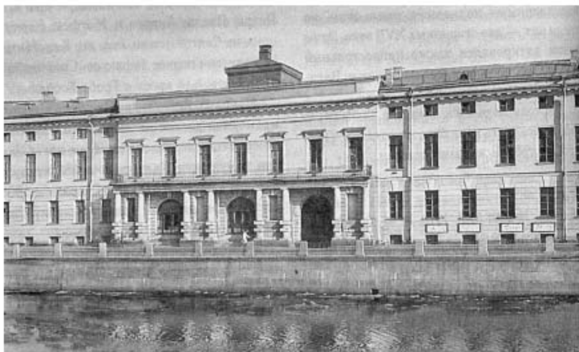
31. Здание б. казарм Фельдегерского корпуса на Фонтанке, 90, 1981-1985 гг. [Электронный ресурс] URL: https://pastvu.com/p/137327
