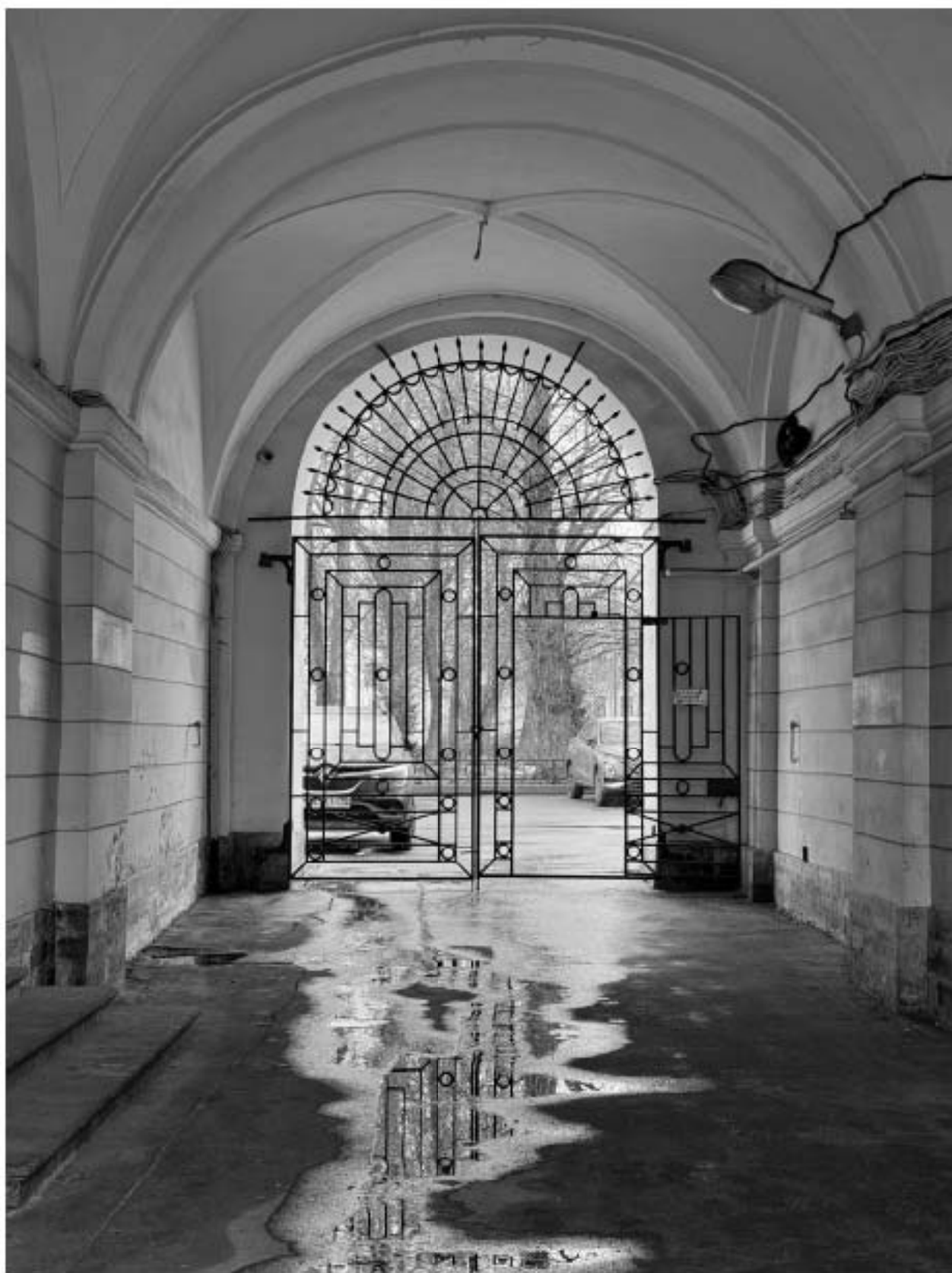
Фото 5. Арка проезда объекта культурного наследия с набережной реки Фонтанки во двор.
