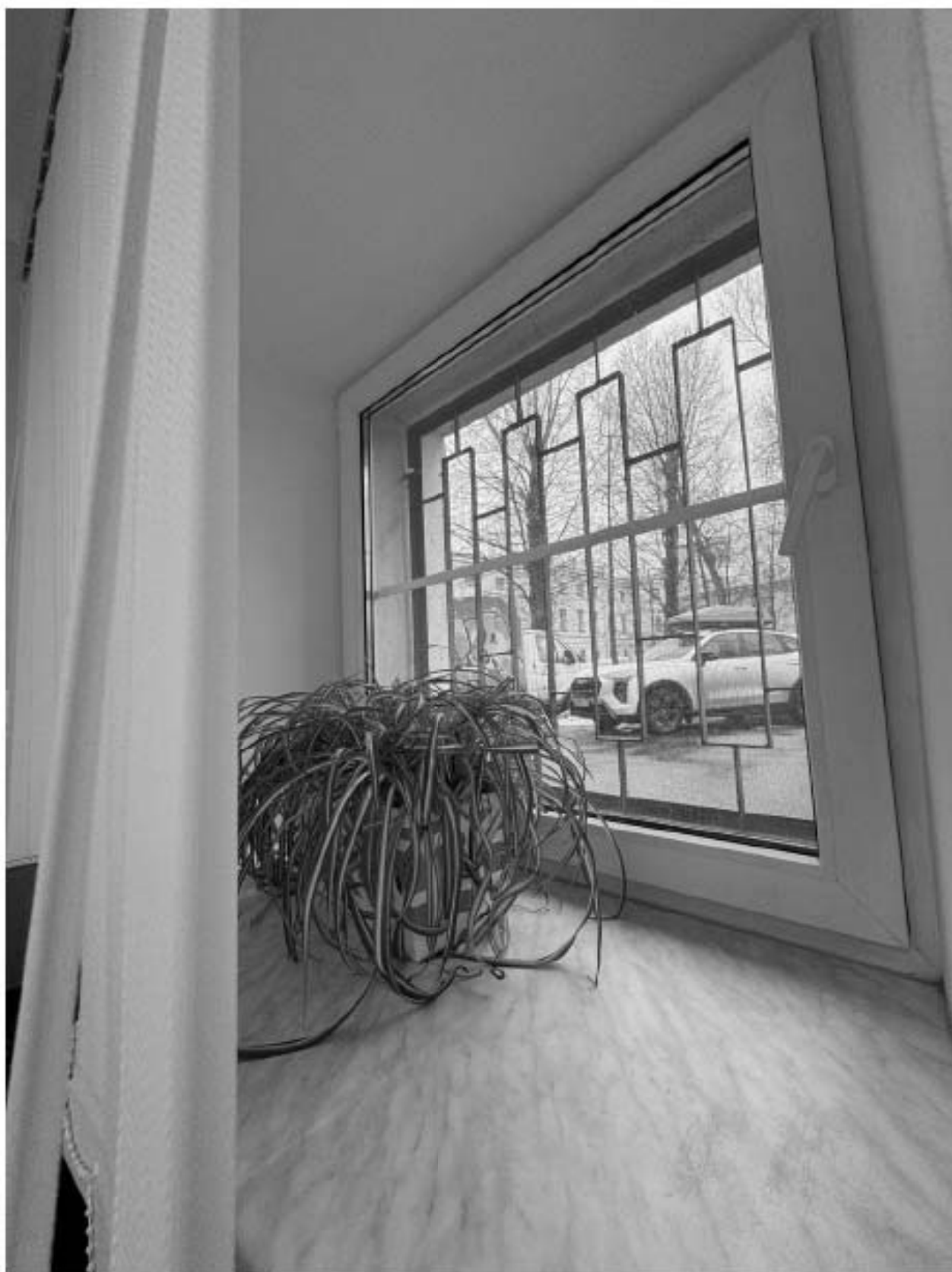
Фото 26. Вид на оконное заполнение помещения 41-Н объекта культурного наследия.
