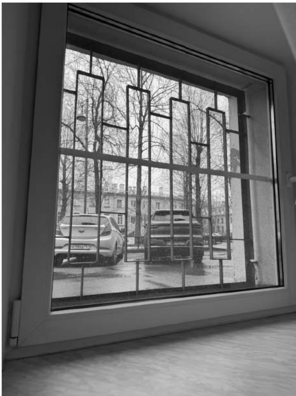
Фото 23. Вид на оконное заполнение помещения 41-Н объекта культурного наследия.
