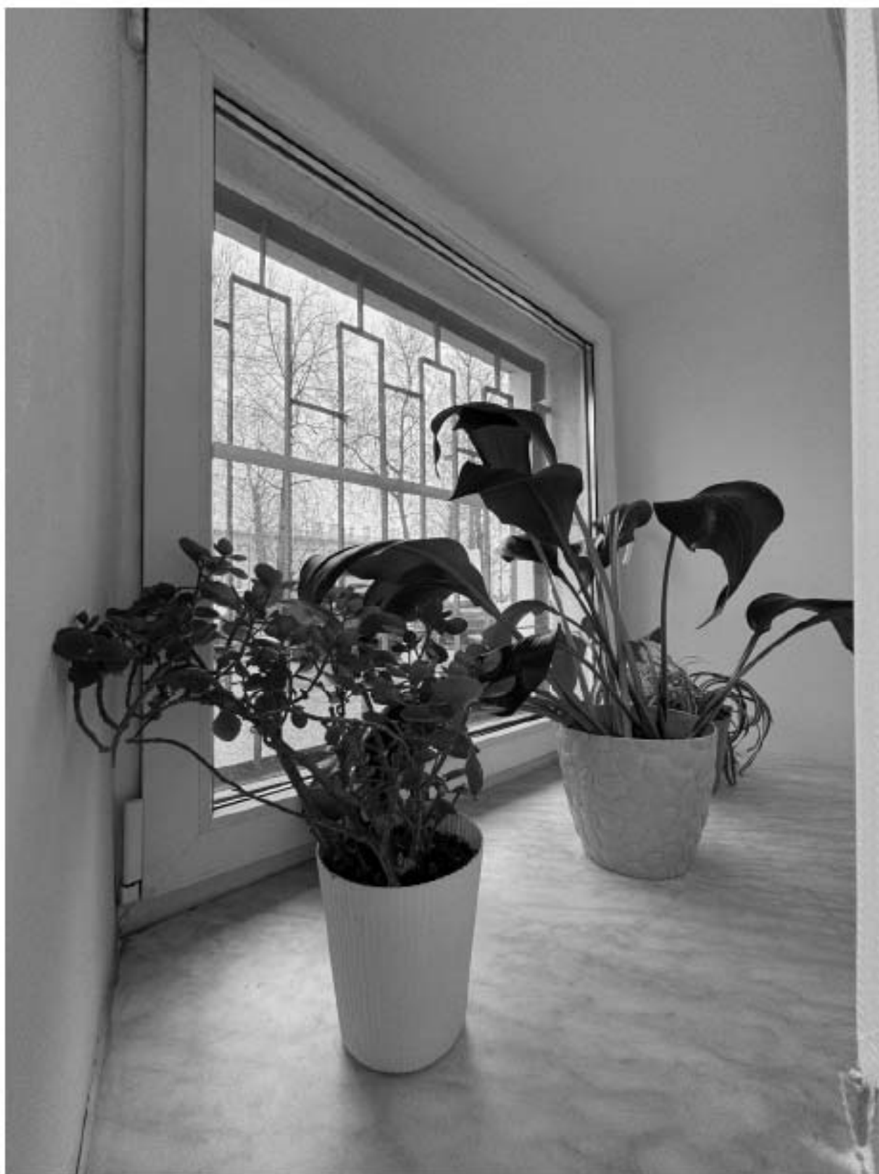
Фото 29. Вид на оконное заполнение помещения 41-Н объекта культурного наследия.
