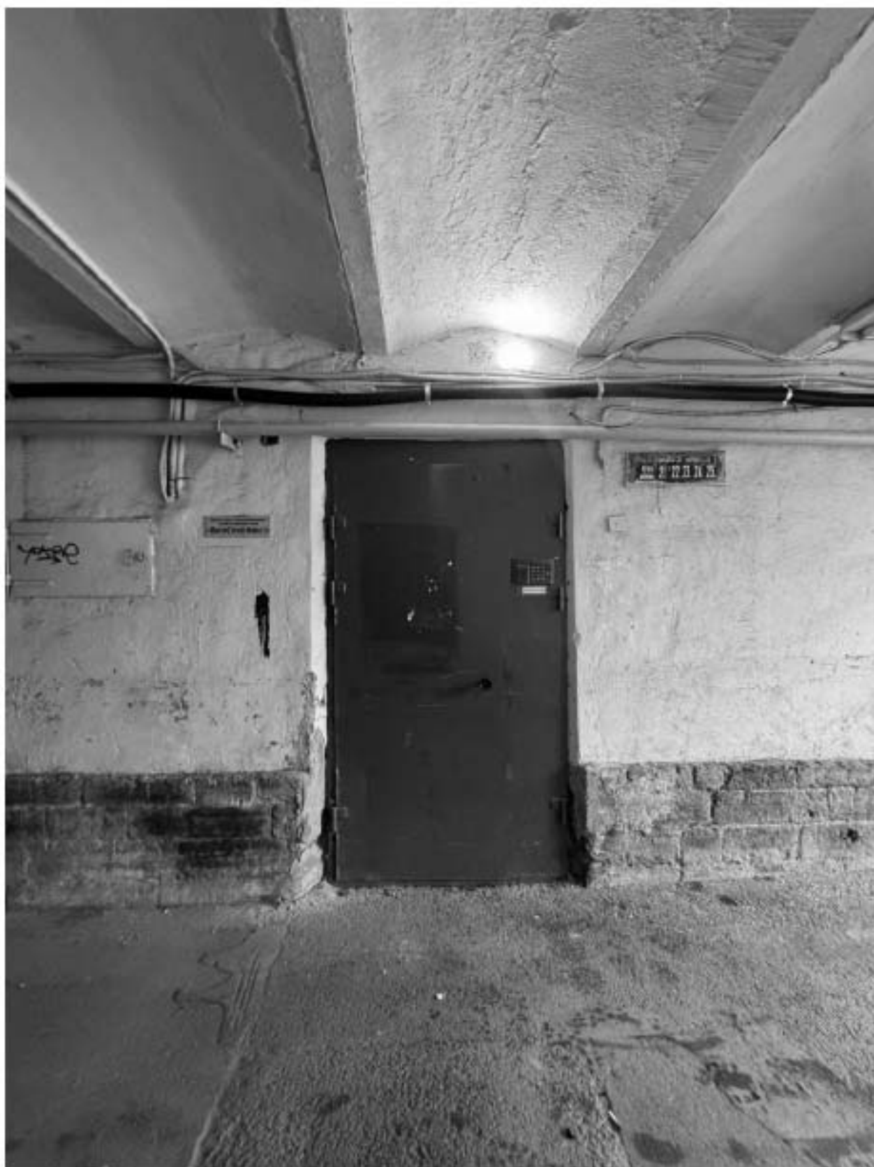
Фото 11. Фрагмент дворового фасада с дверным заполнением, ведущим к помещению 41-Н, объекта культурного наследия.
