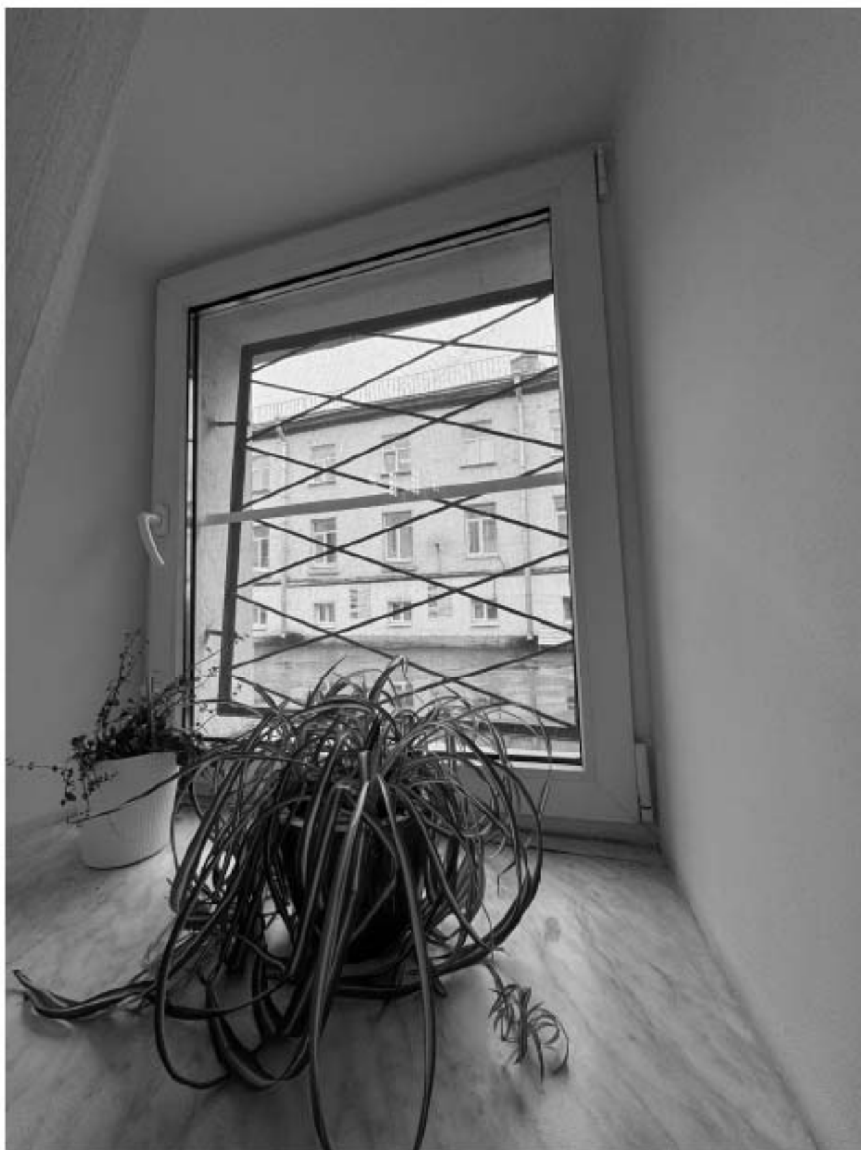
Фото 36. Вид на оконное заполнение помещения 41-Н объекта культурного наследия.
