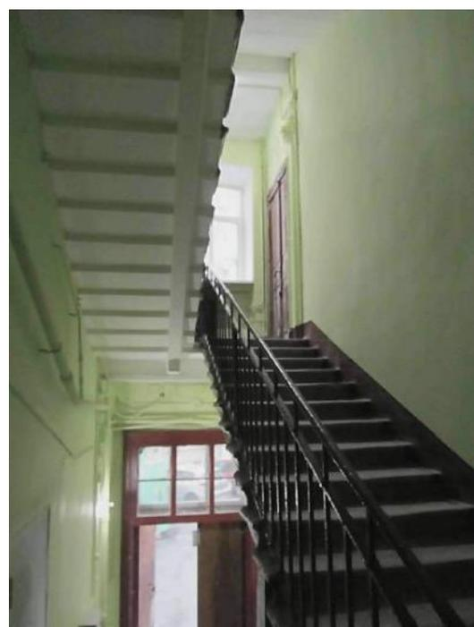
боковая (восточная) лестница корпуса по наб. кан. Грибоедова – местоположение, габариты, конфигурация, тип (многомаршевая), конструкция (на косоурах), материал ступеней («путиловская» плита), ограждение – материал (металл), техника исполнения (литье), рисунок; поручень – материал (дерево), профиль;
