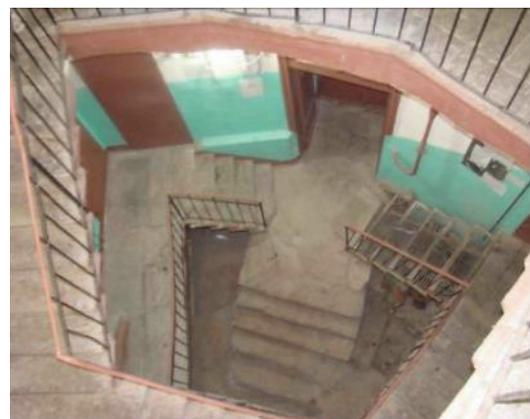
две черные лестницы корпусов по Столярному пер. и по Казначейской ул. – местоположение, габариты, конфигурация, тип (многомаршевая), конструкция (на косоурах), материал ступеней («путиловская» плита), ограждение – материал (металл), техника исполнения (ковка), рисунок (вертикальные стойки);
