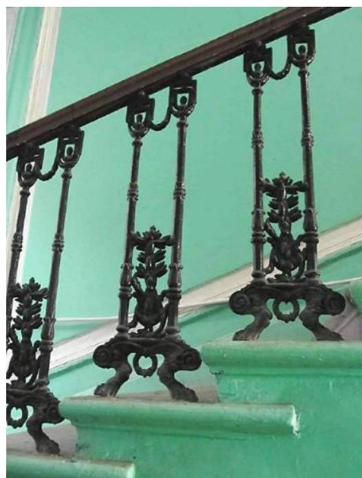
лестница корпуса по Казначейской ул. (по 6-7-й осям) – местоположение, габариты, конфигурация, тип (многомаршевая), конструкция (на косоурах), материал ступеней («путиловская» плита), ограждение – материал (металл), техника исполнения (литье), рисунок; поручень – материал (дерево), профиль;
