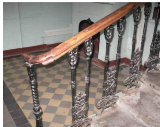
лестница корпуса по Столярному пер. (по 13 оси) – местоположение, габариты, конфигурация, тип (многомаршевая), конструкция (на косоурах), материал ступеней («путиловская» плита), ограждение – материал (металл), техника исполнения (литье), рисунок; поручень – материал (дерево), профиль.
