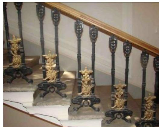
парадная лестница корпуса по наб. кан. Грибоедова (в осях 7-9) – местоположение, габариты, конфигурация, тип (распашная), конструкция (на косоурах), материал ступеней («путиловская» плита), ограждение – материал (металл), техника исполнения (литье), рисунок; поручень – материал (дерево), профиль;
