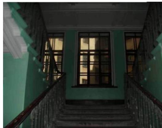
боковая (западная) лестница корпуса по наб. кан. Грибоедова (в осях 2-3) – местоположение, габариты, конфигурация, тип (многомаршевая), конструкция (на косоурах), материал ступеней («путиловская» плита), ограждение – материал (металл), техника исполнения (литье), рисунок; поручень – материал (дерево), профиль;
