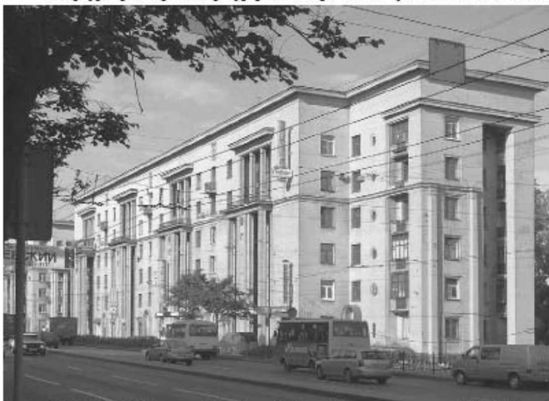
22. Дом 13. 2000 - 2006 г. г. — Жилой дом // Citywalls.ru – архитектурный сайт Петербурга [Электронный ресурс]. URL: https://www.citywalls.ru/house19198.html .
