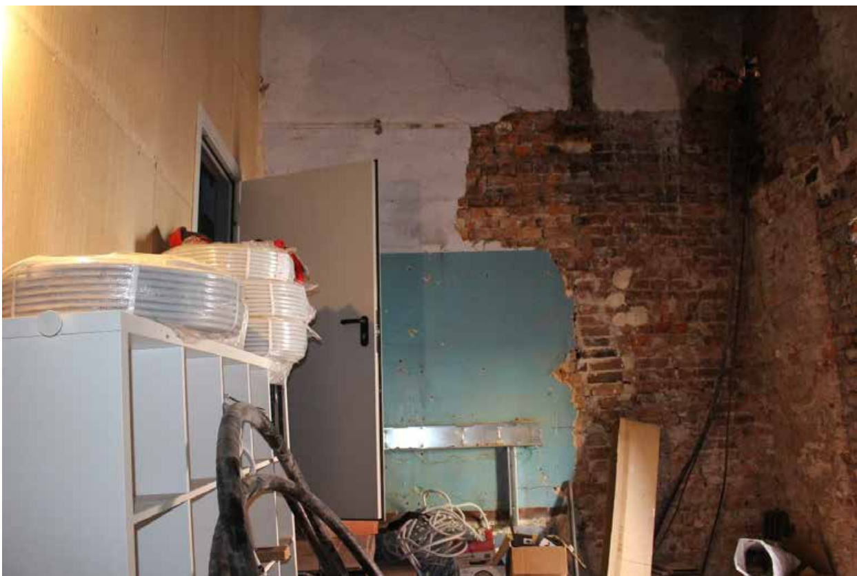
Фото 16. Внутренние помещения объекта культурного наследия регионального значения «Служебный корпус».
