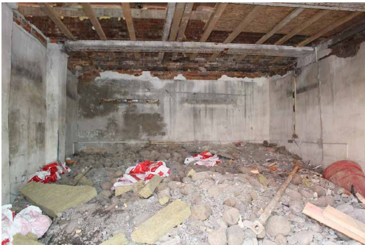
Фото 18. Внутренние помещения объекта культурного наследия регионального значения «Служебный корпус».
