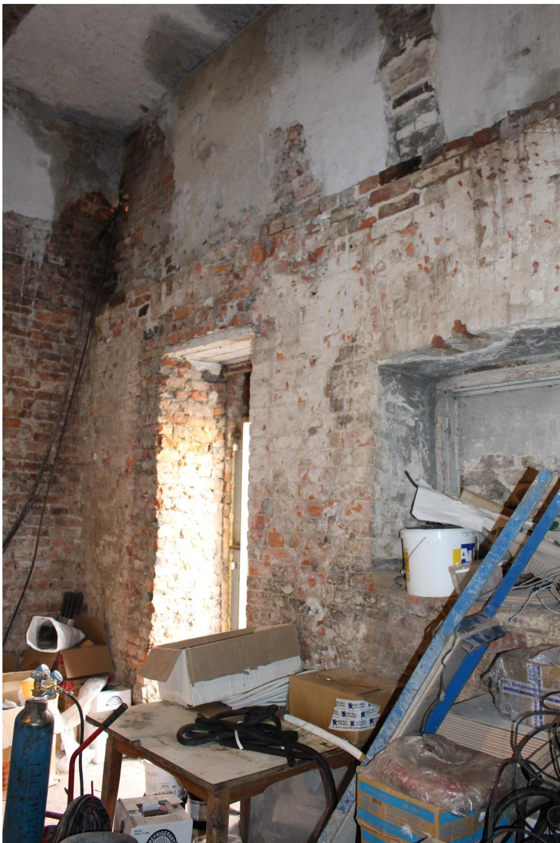
Фото 15. Внутренние помещения объекта культурного наследия регионального значения «Служебный корпус».
