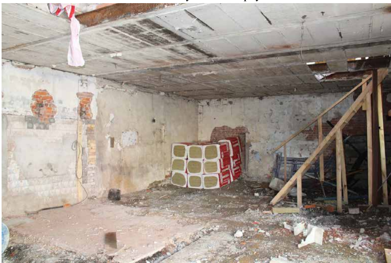
Фото 19. Внутренние помещения объекта культурного наследия регионального значения «Служебный корпус».
