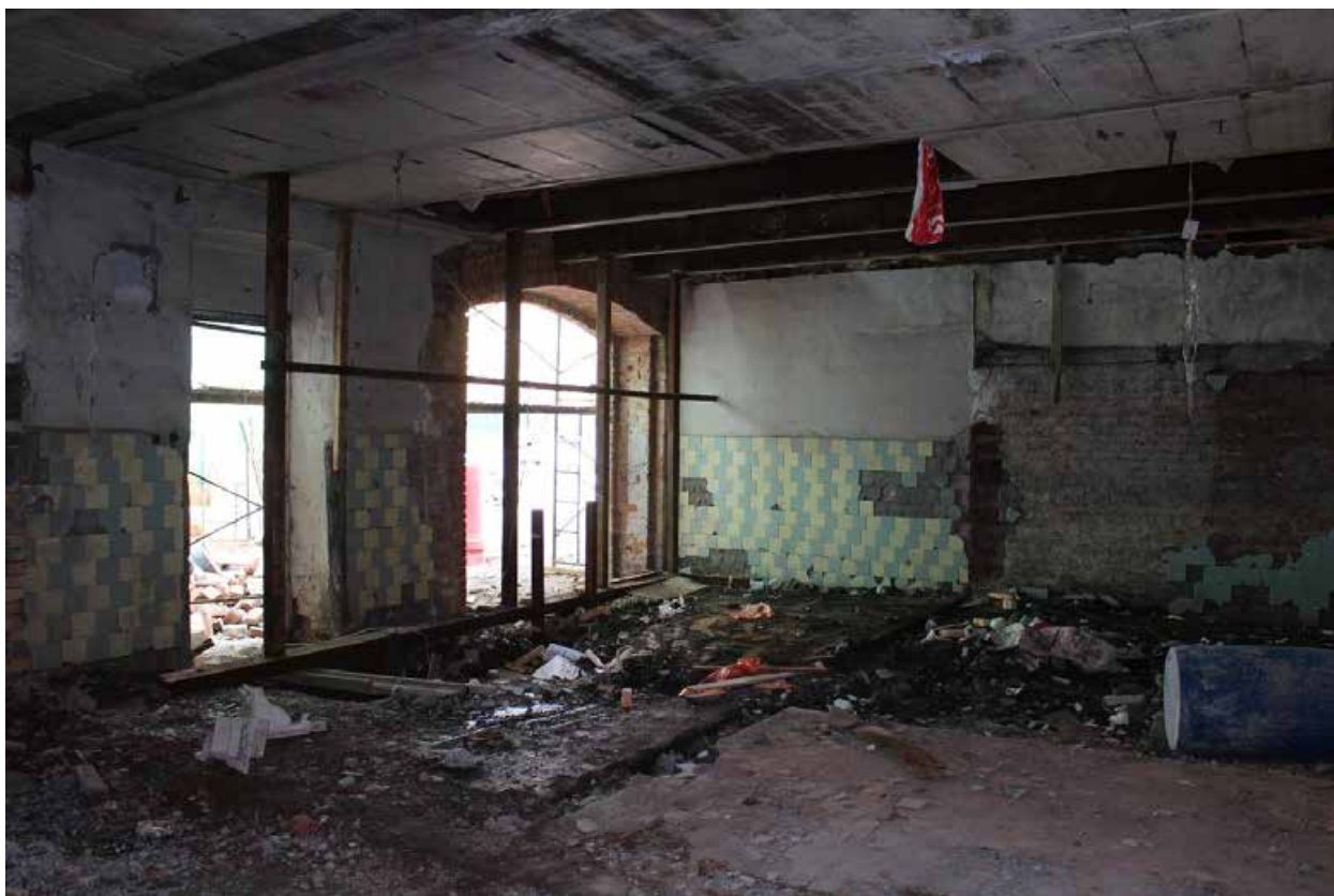
Фото 20. Внутренние помещения объекта культурного наследия регионального значения «Служебный корпус».
