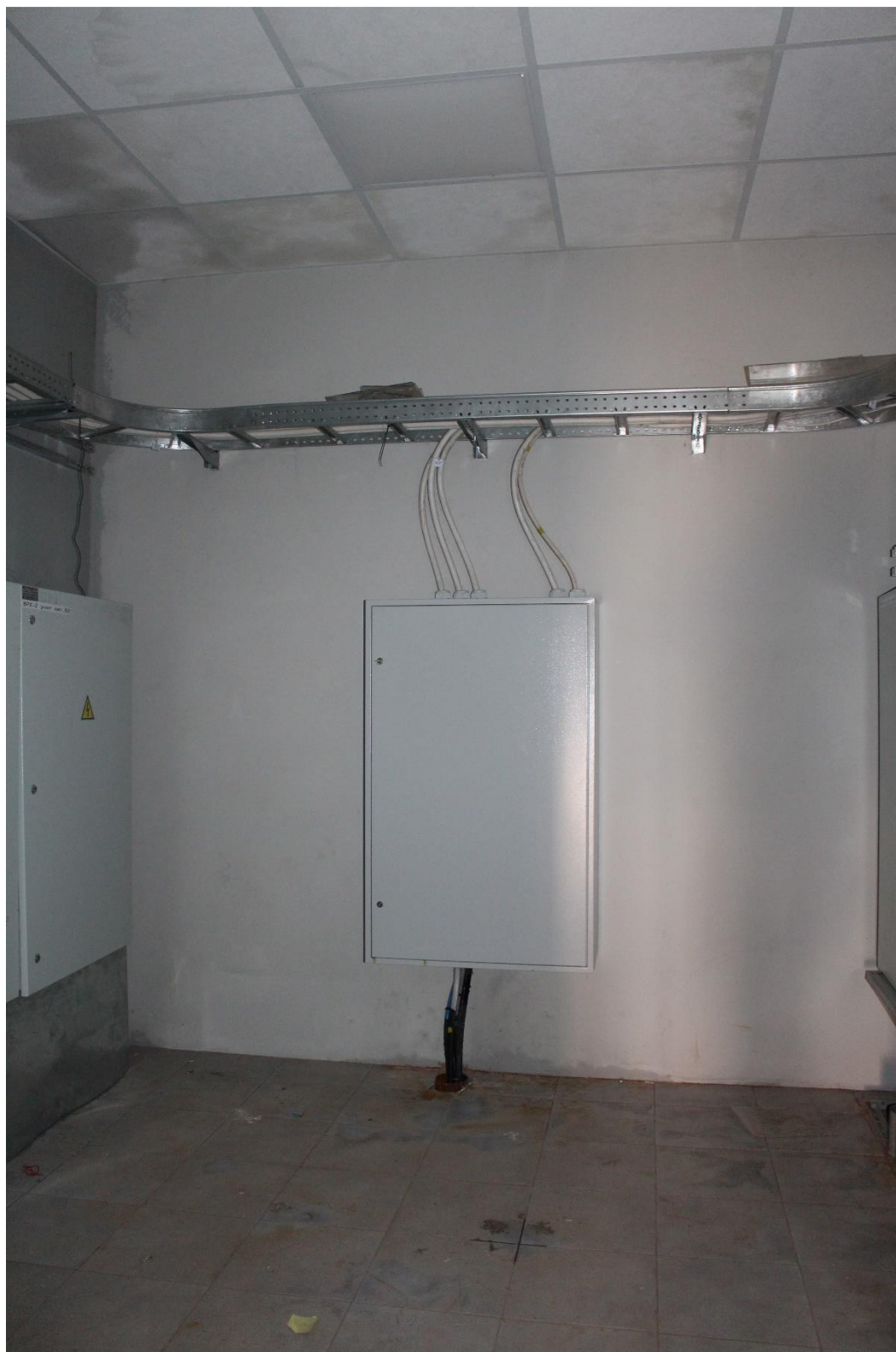
Фото 13. Внутренние помещения объекта культурного наследия регионального значения «Служебный корпус».
