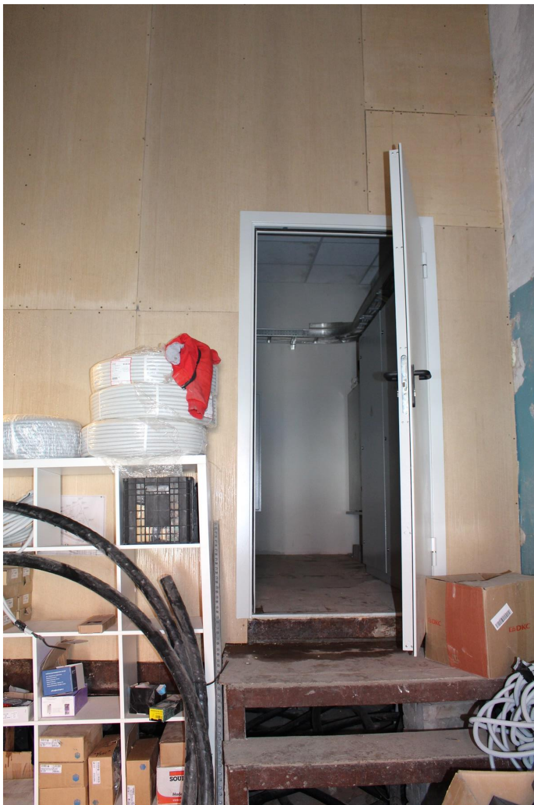
Фото 12. Внутренние помещения объекта культурного наследия регионального значения «Служебный корпус».
