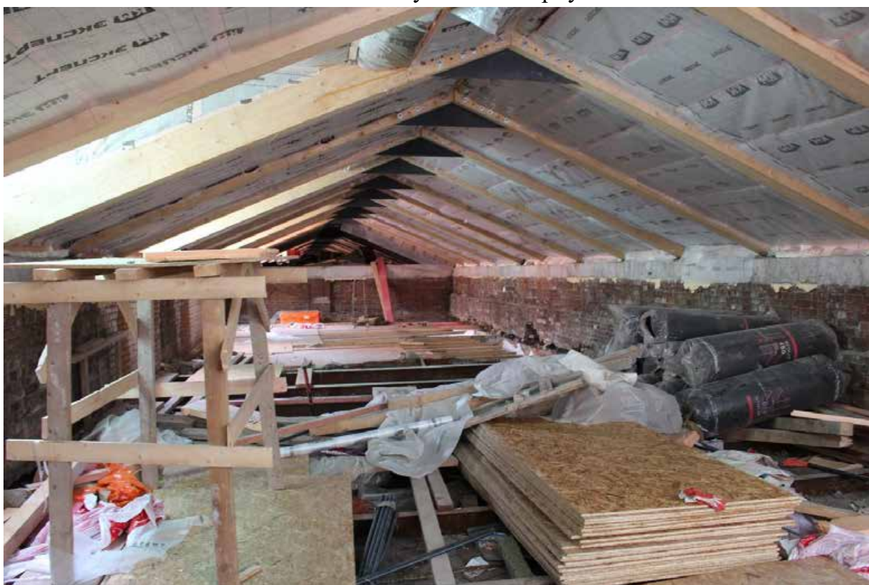
Фото 21. Вид на чердак объекта культурного наследия регионального значения «Служебный корпус».
