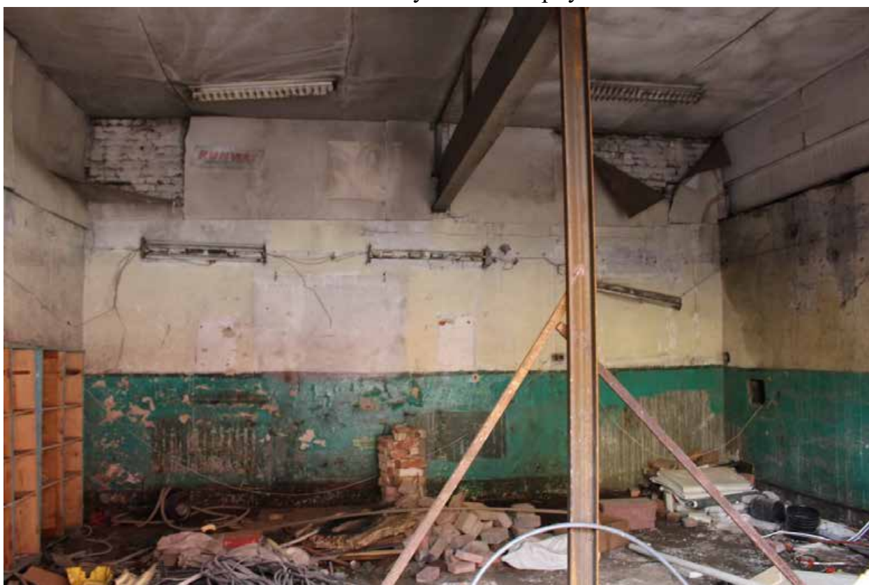
Фото 10. Внутренние помещения объекта культурного наследия регионального значения «Служебный корпус».
