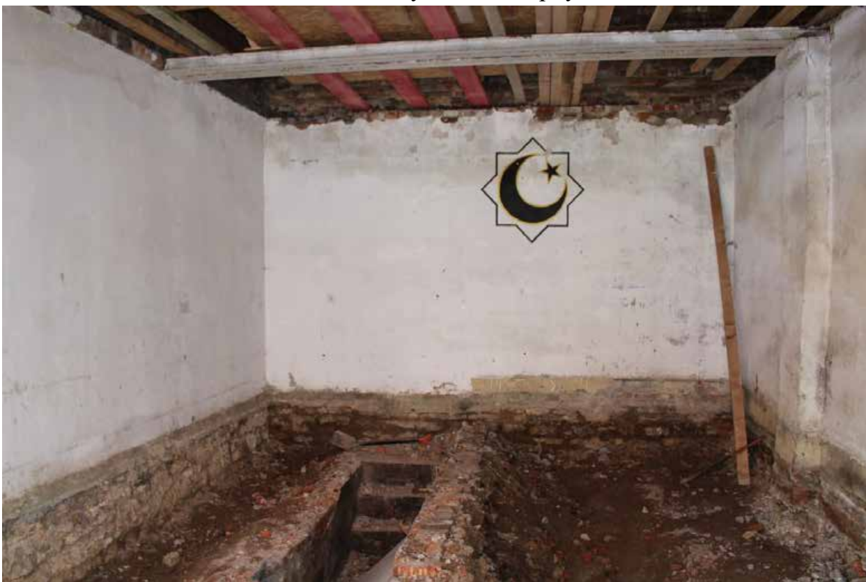
Фото 17. Внутренние помещения объекта культурного наследия регионального значения «Служебный корпус».
