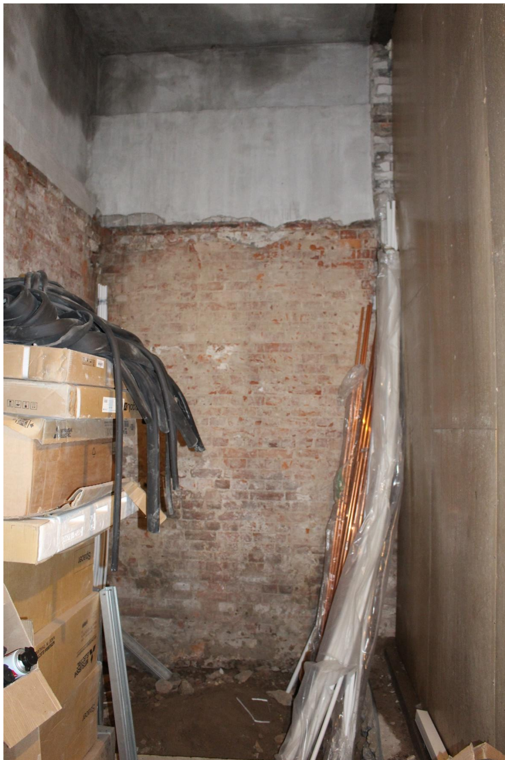
Фото 14. Внутренние помещения объекта культурного наследия регионального значения «Служебный корпус».
