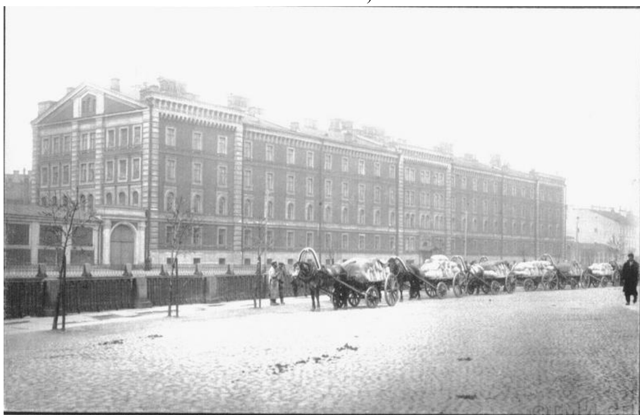
Илл. 40. Вид на казарму Гвардейского экипажа. 1903 г. (источник: госкаталог.рф № 25841676).
