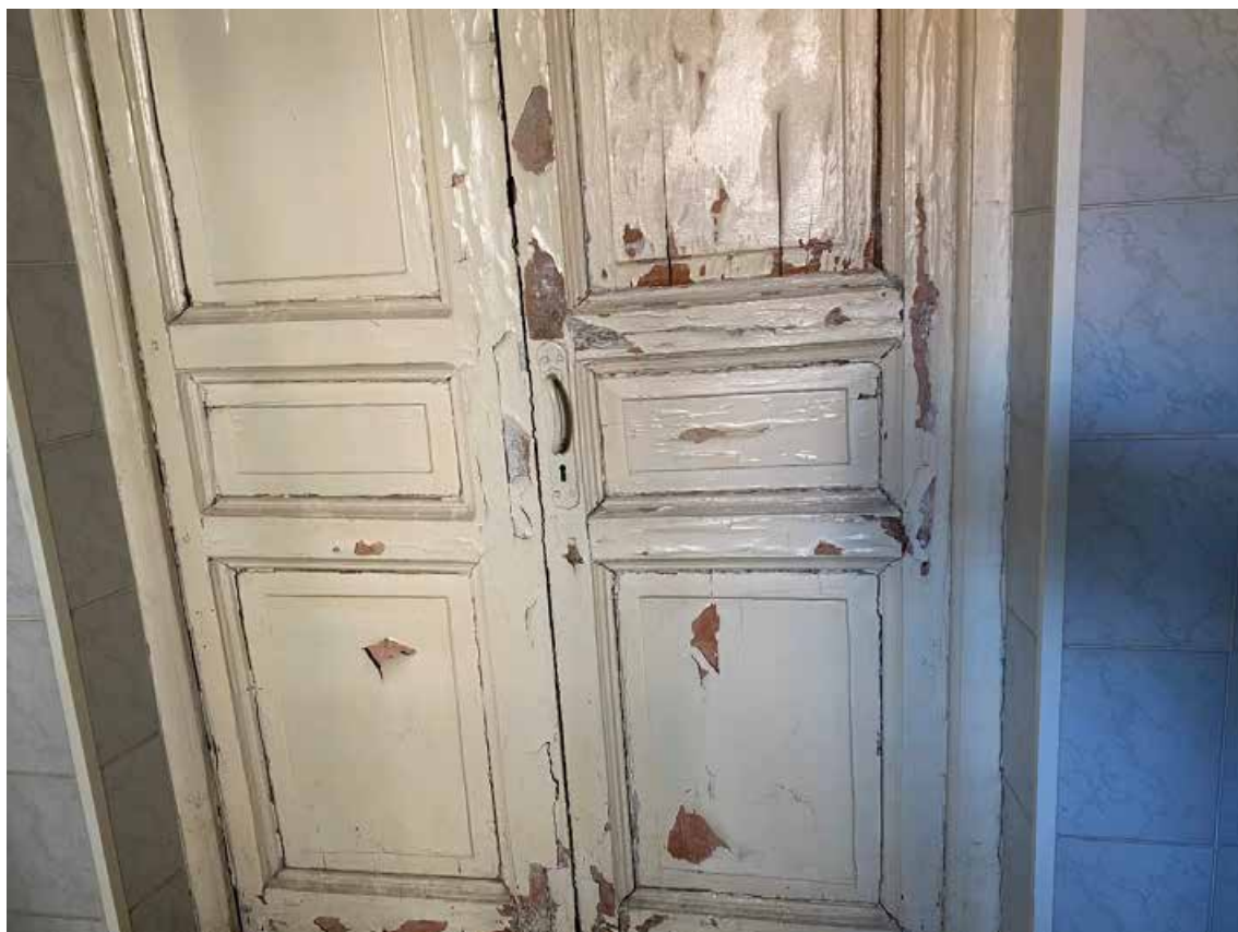
67. Фрагмент интерьера цокольного этажа. Историческая дверь.
