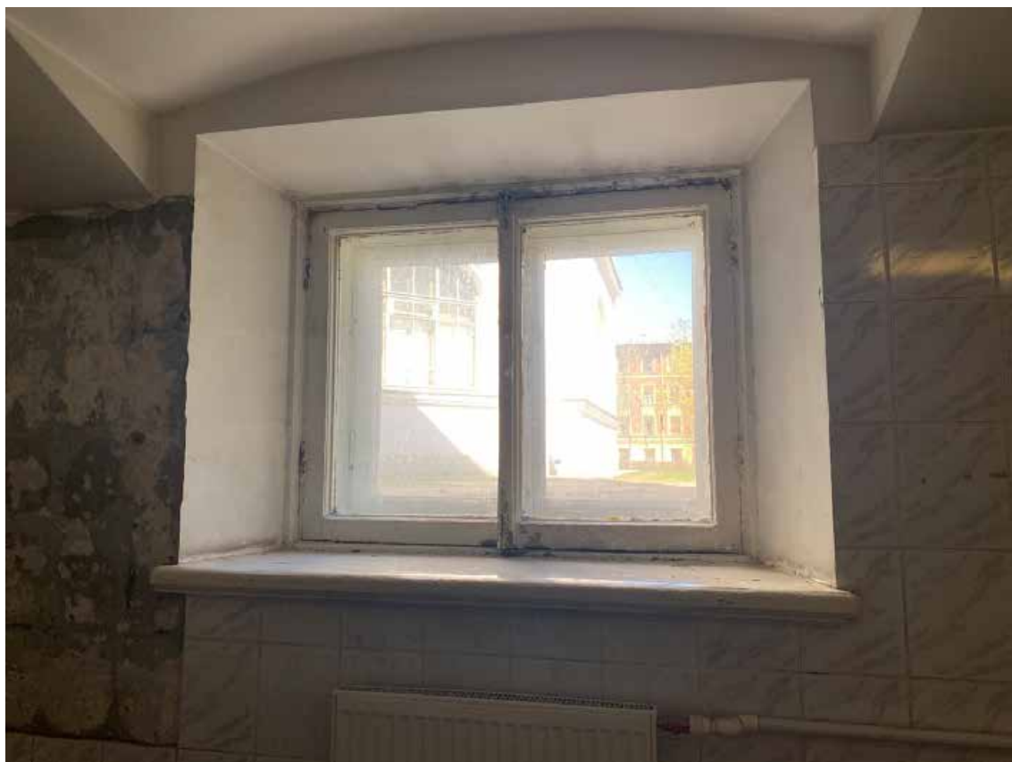
48. Фрагмент интерьера цокольного этажа. Историческое окно.
