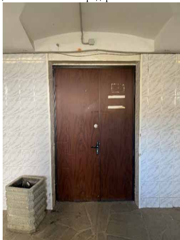
47. Фрагмент интерьера цокольного этажа. Дверной проем.
