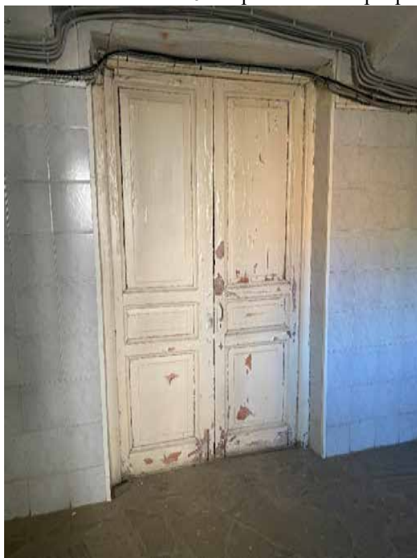
65. Фрагмент интерьера цокольного этажа. Историческая дверь.
