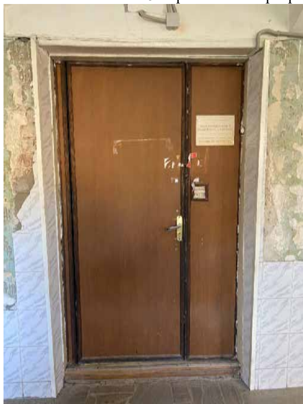
46. Фрагмент интерьера цокольного этажа. Дверной проем.
