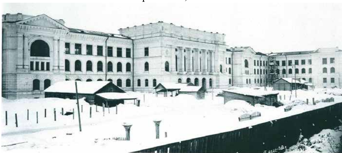
Илл. 17. Общий вид главного корпуса Политехнического института в процессе строительства. 15.02.1902 г. // https://pastvu.com/p/723800
