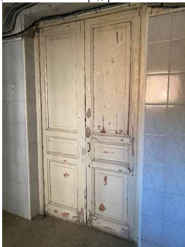
66. Фрагмент интерьера цокольного этажа. Историческая дверь.
