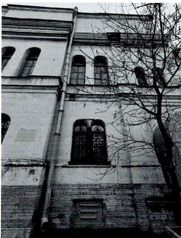
Фрагмент лицевого фасада.
