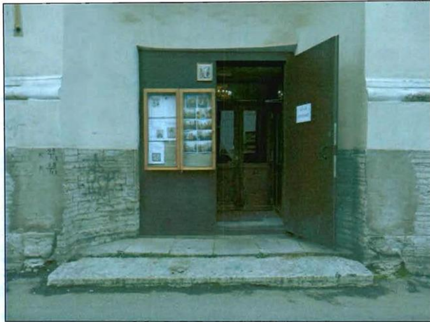
4. Северный фасад. Крыльцо.
