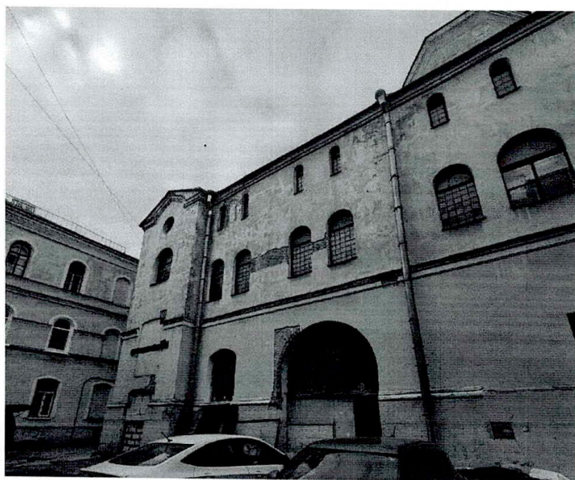
фрагмент дворового фасада.
