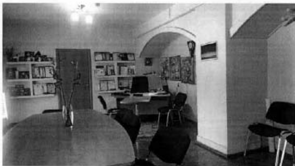
Фото 24, 25, 26. Общее состояние помещений объекта культурного наследия
