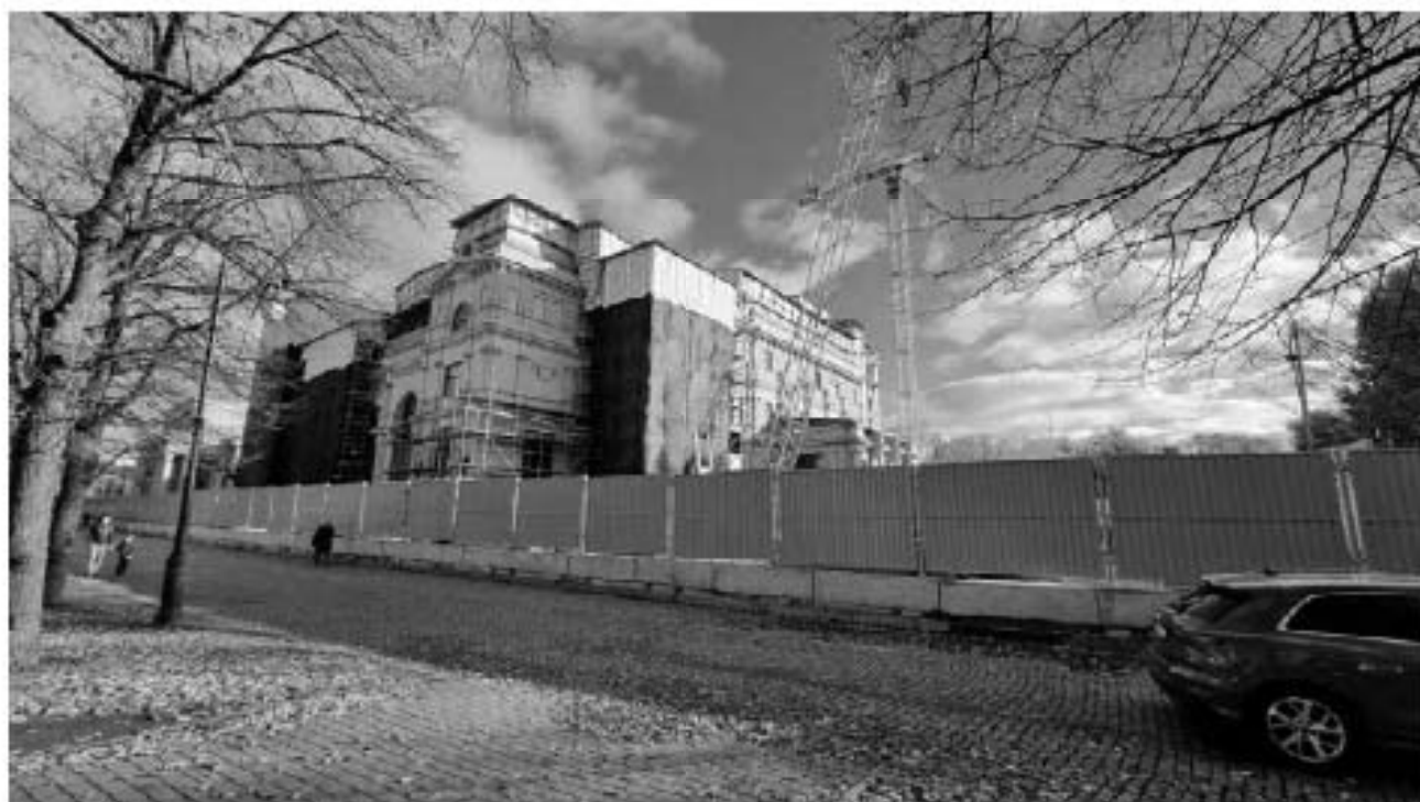
Фото 12. Вид со стороны Александровского парка на северо-западную часть здания - объекта культурного наследия федерального значения «Народный дом, где в мае 1917 г. состоялся 1-й Всероссийский съезд крестьянских депутатов. Здесь в Оперном зале выступали певцы Собинов Л. В., Шаляпин Ф. И.». Фото от 10.10.2024 г.
