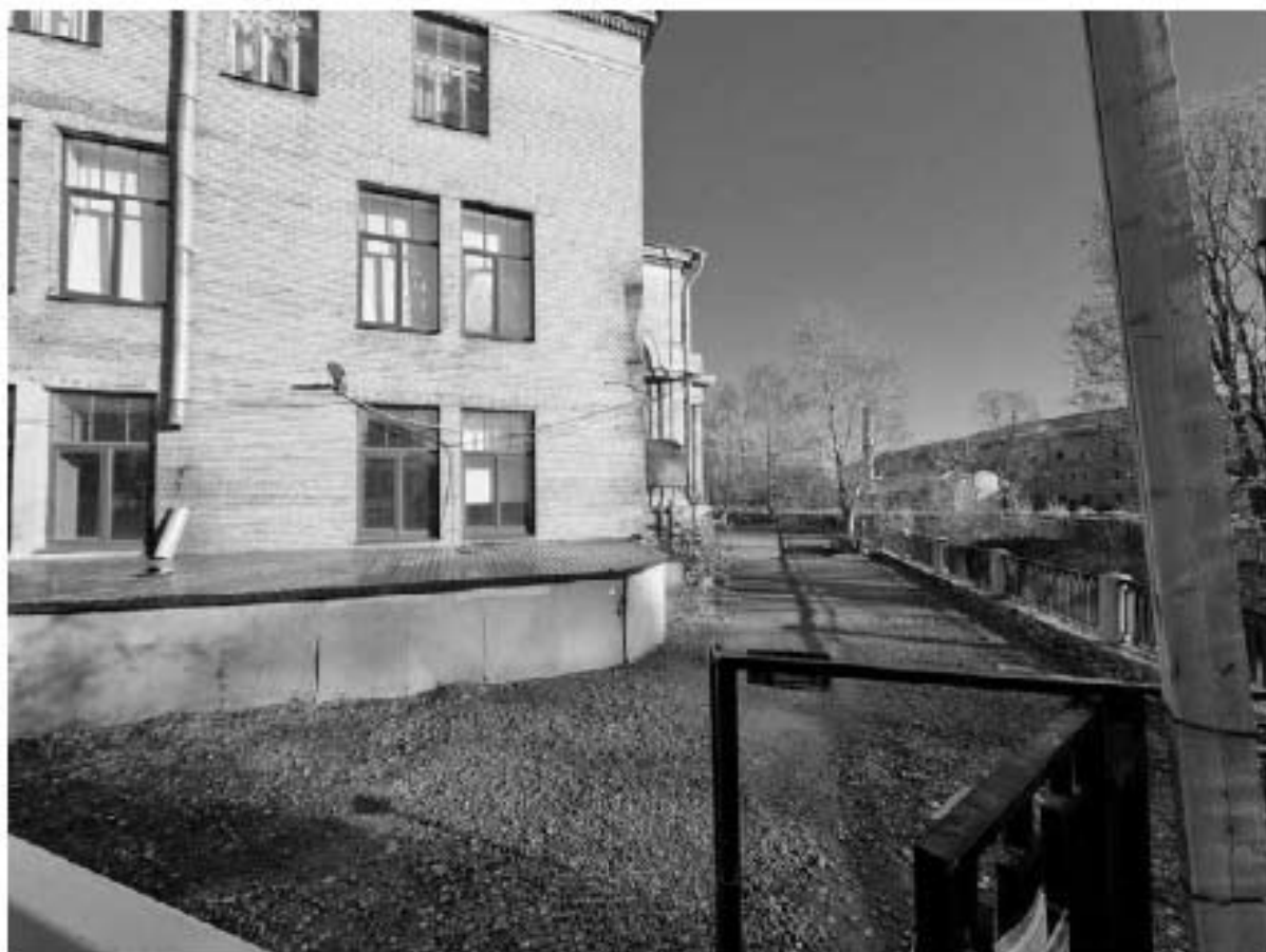
Фото 22. Вид на юго-западную часть здания - объекта культурного наследия регионального значения «Корпус со столовой и кухней» (слева) вдоль Кронверкского канала (справа). Фото от 10.10.2024 г.
