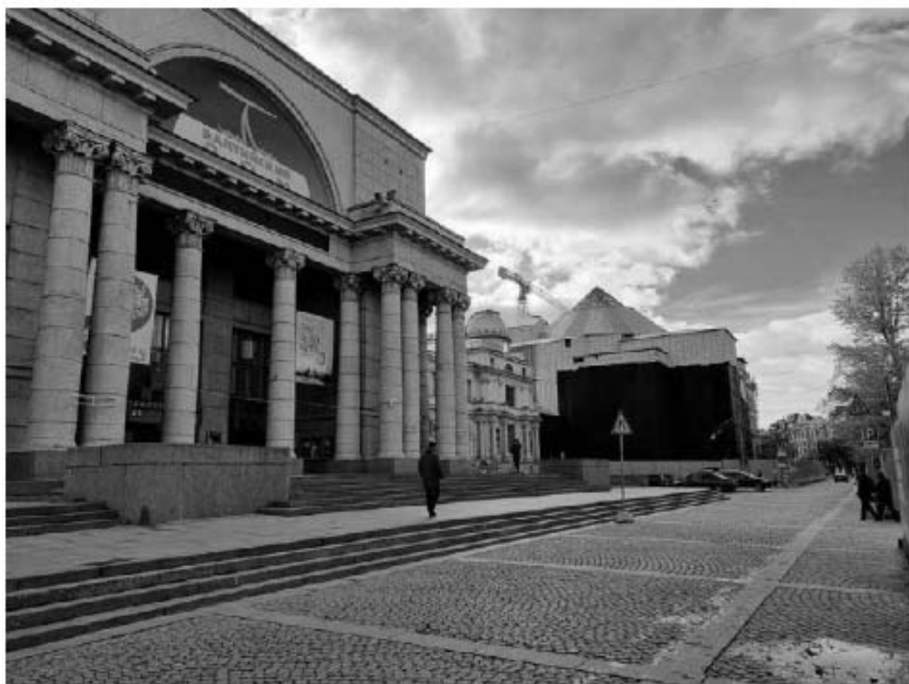
Фото 5. Вид со стороны Александровского парка на северный фасад здания – объекта культурного наследия регионального значения «Здание Театра им. Ленинского комсомола» (на переднем плане), на северный фасад здания – объекта культурного наследия регионального значения «Корпус с залом для увеселений и чтений ("Железный зал")» (на среднем плане), на северо-восточную часть здания – объекта культурного наследия федерального значения «Народный дом, где в мае 1917 г. состоялся 1-й Всероссийский съезд крестьянских депутатов. Здесь в Оперном зале выступали певцы Собинов Л. В., Шаляпин Ф. И.» (на заднем плане).
