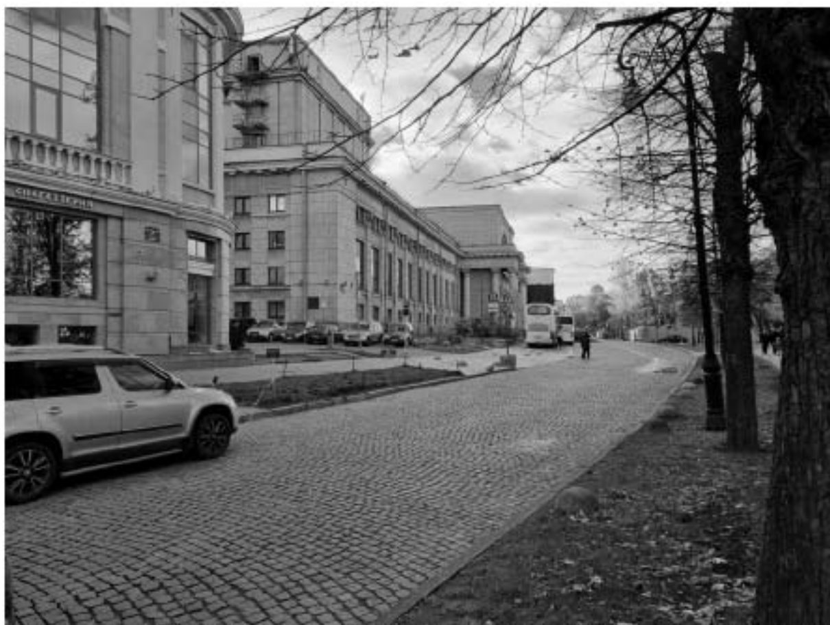
Фото 2. Вид со стороны Александровского парка на северный фасад здания – объекта культурного наследия регионального значения «Здание Театра им. Ленинского комсомола». Фото от 10.10.2024 г.
