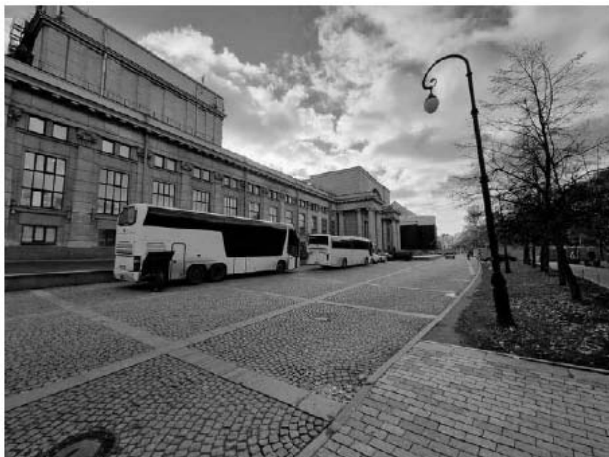
Фото 4. Вид со стороны Александровского парка на северный фасад здания – объекта культурного наследия регионального значения «Здание Театра им. Ленинского комсомола». Фото от 10.10.2024 г.
