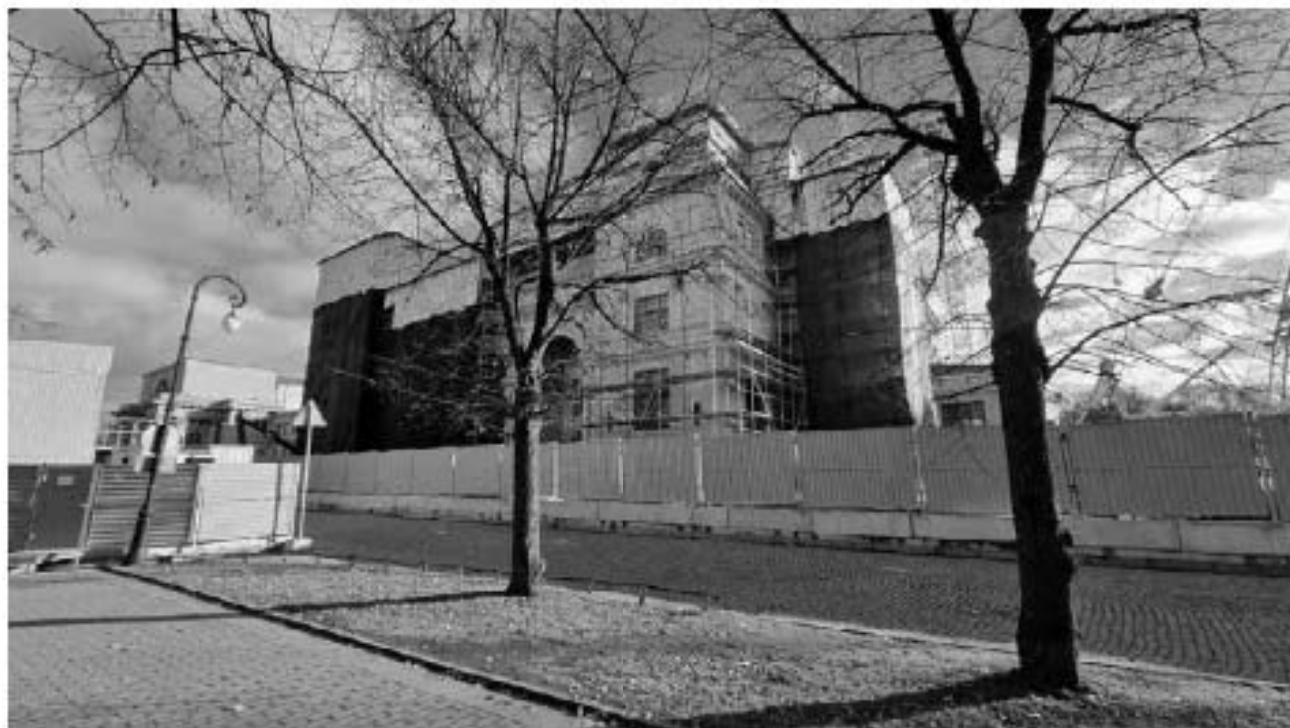
Фото 11. Вид со стороны Александровского парка на северо-западную часть здания - объекта культурного наследия федерального значения «Народный дом, где в мае 1917 г. состоялся 1-й Всероссийский съезд крестьянских депутатов. Здесь в Оперном зале выступали певцы Собинов Л. В., Шаляпин Ф. И.». Фото от 10.10.2024 г.
