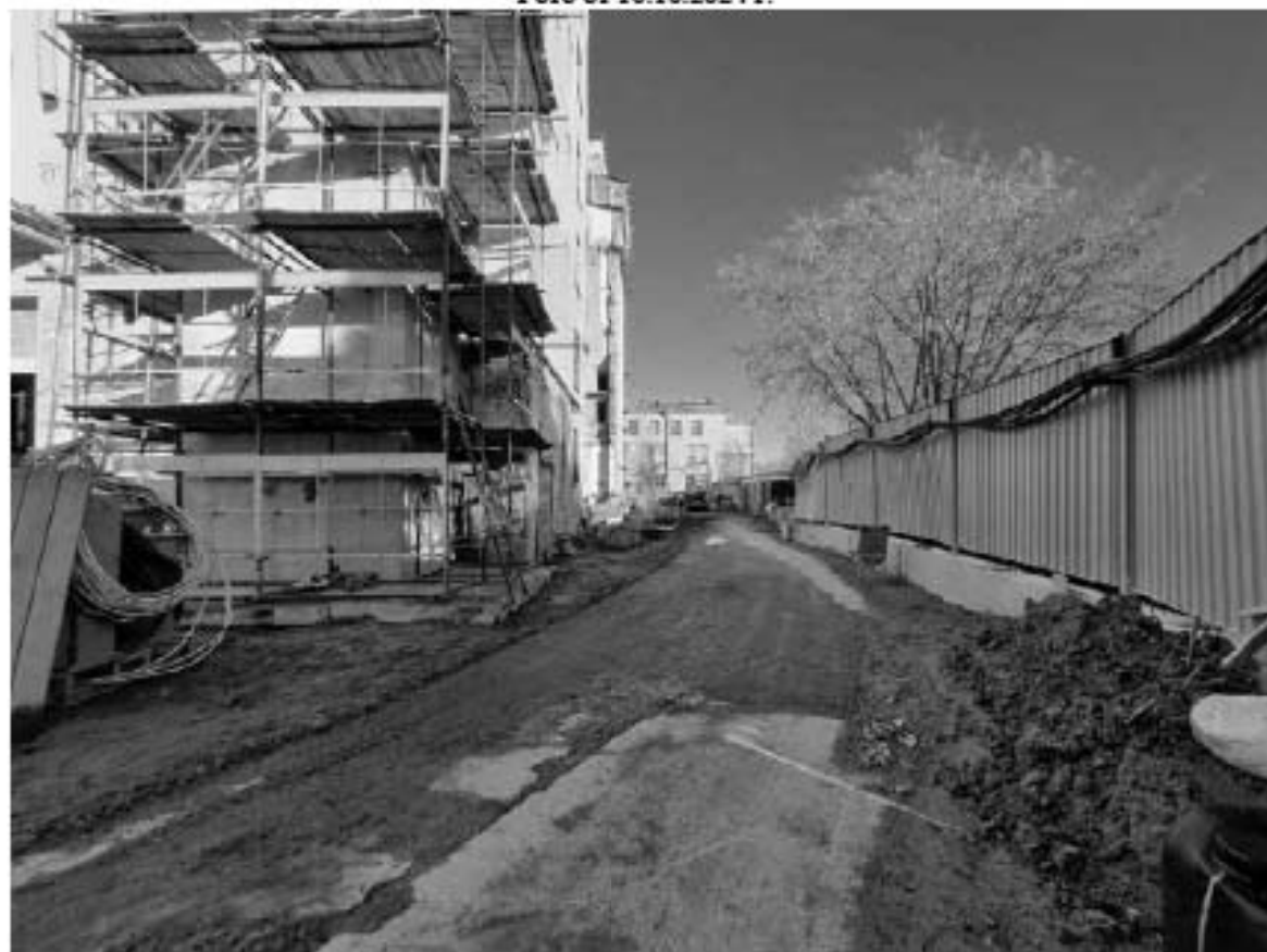
Фото 20. Вид на южный фасад здания - объекта культурного наследия федерального значения «Народный дом, где в мае 1917 г. состоялся 1-й Всероссийский съезд крестьянских депутатов. Здесь в Оперном зале выступали певцы Собинов Л. В., Шаляпин Ф. И.» (на переднем плане), на юго-западную часть здания - объекта культурного наследия регионального значения «Корпус со столовой и кухней» (на заднем плане), расположенные вдоль Кронверкского канала. Фото от 10.10.2024 г.
