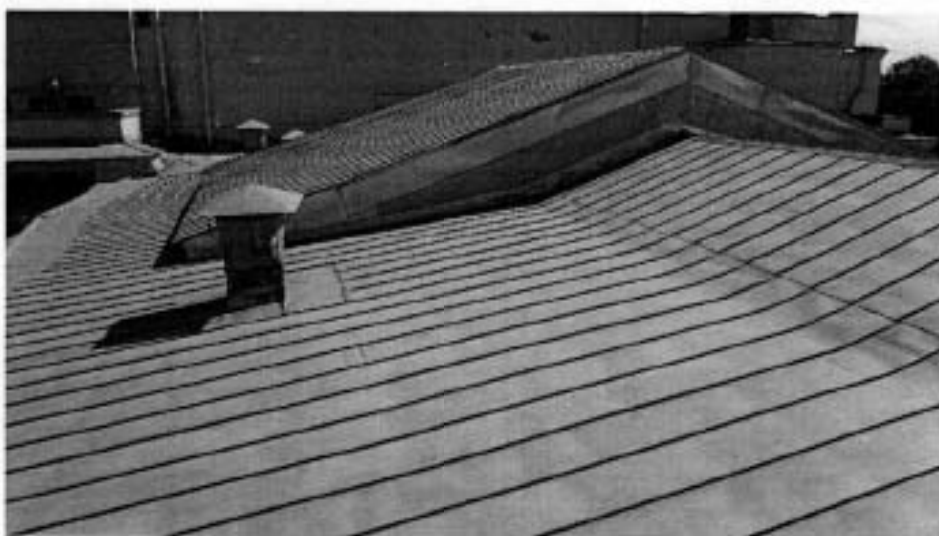
Фото 8. Крыша объекта культурного наследия
