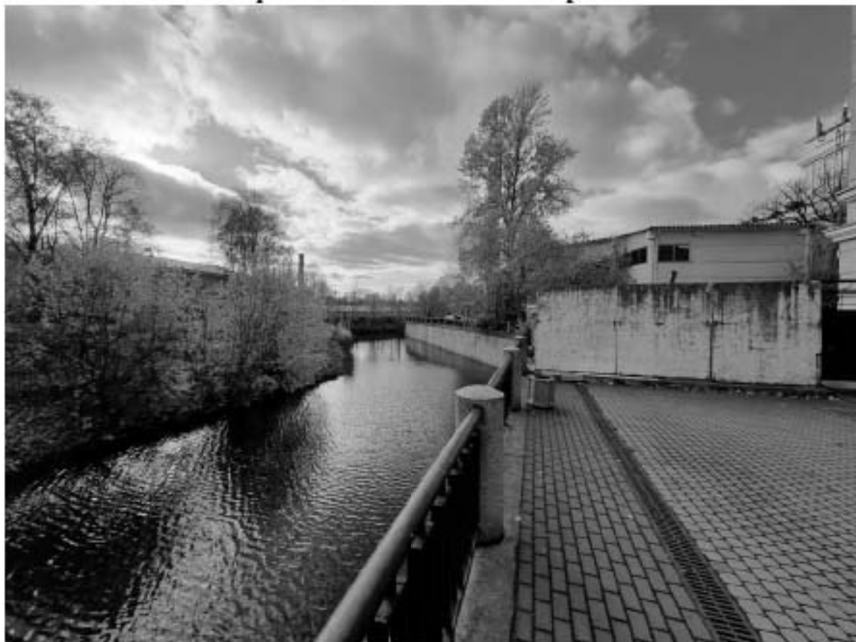
Фото 1. Вид со стороны Кронверкского канала на южный фасад здания – объекта культурного наследия регионального значения «Здание Театра им. Ленинского комсомола». Фото от 10.10.2024 г.
