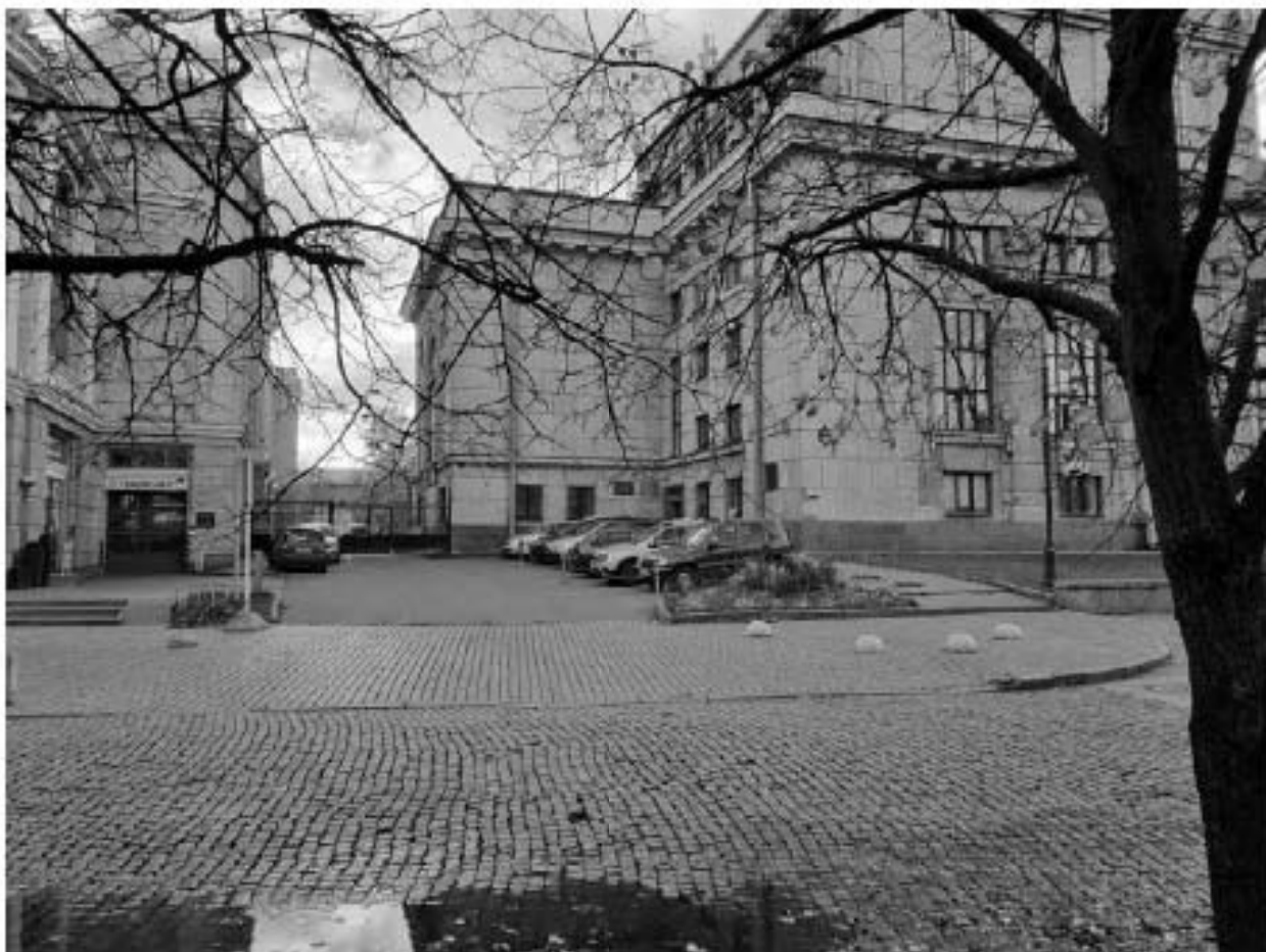
Фото 3. Вид со стороны Александровского парка на северный фасад здания – объекта культурного наследия регионального значения «Здание Театра им. Ленинского комсомола». Фото от 10.10.2024 г.
