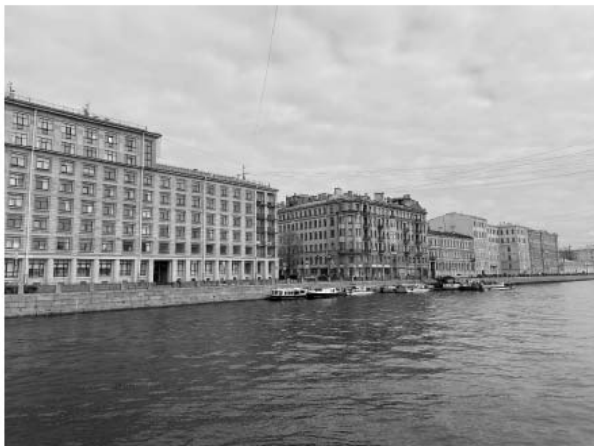
Фото 2. Вид на причал с противоположной стороны набережной реки Фонтанки.
