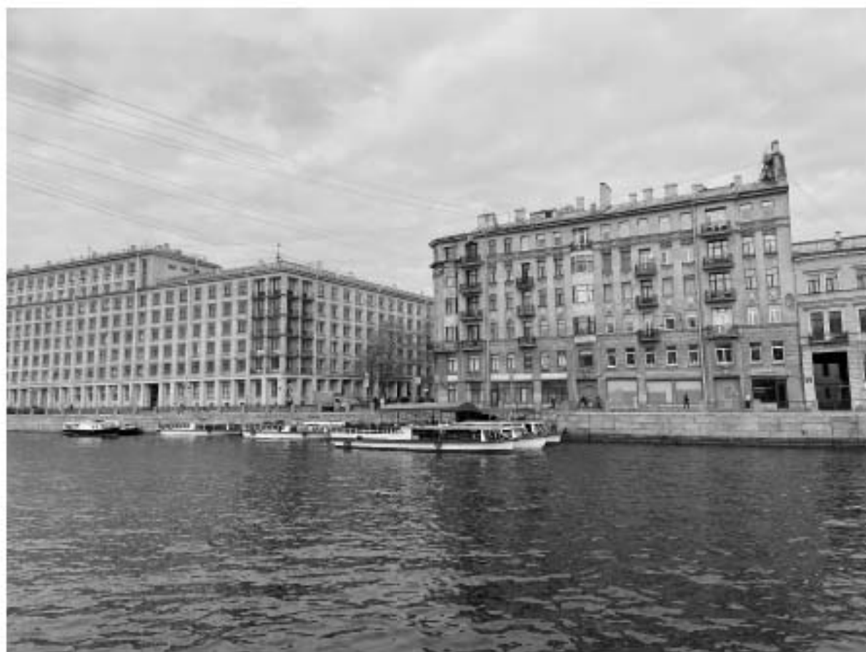
Фото 1. Вид на причал с противоположной стороны набережной реки Фонтанки.
