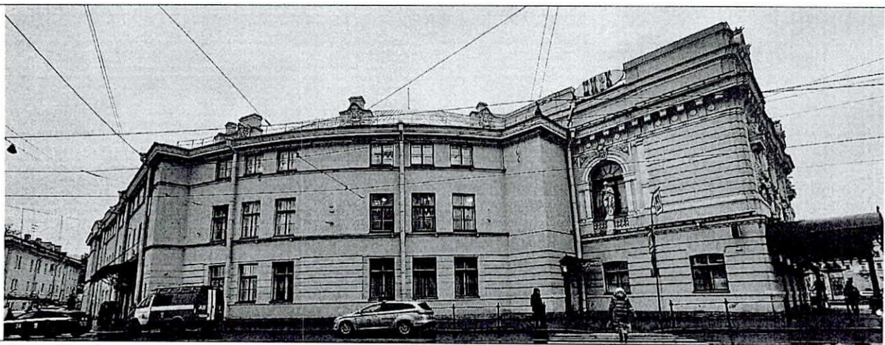
Фото 3. Фрагмент лицевого фасада
