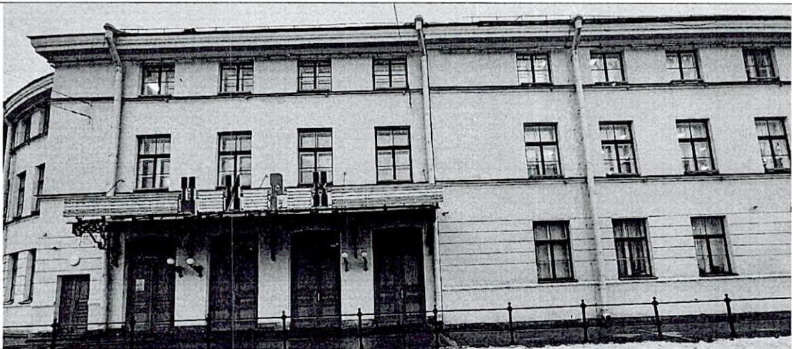
Фото 2. Фрагмент лицевого фасада
