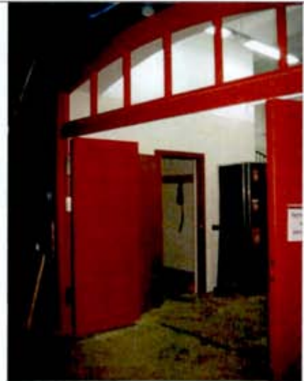
22. Помещения 1-го этажа. Дверные проемы в помещении форганга.
