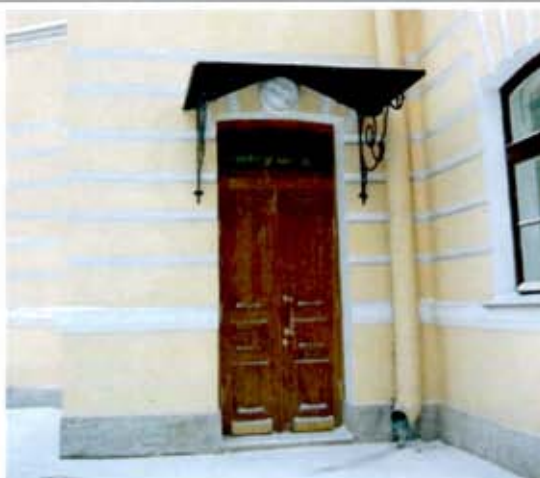
11. Юго-западный фасад полуциркульного объема. Дверной проем.
