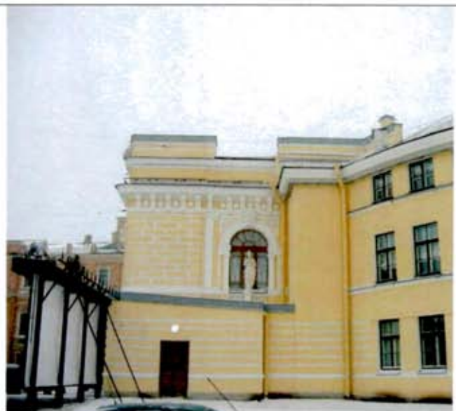
8. Юго-восточный фасад центрального ризалита. Общий вид
