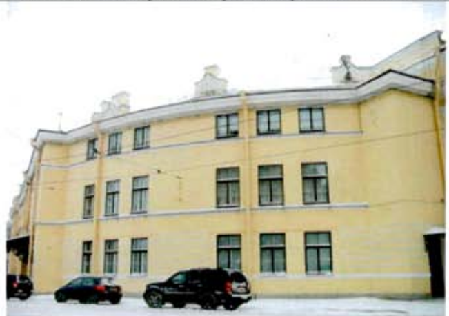
10. Юго-западный фасад полуциркульного объема. Общий вид.
