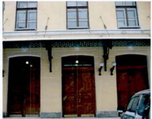
14. Западный фасад. Дверные проемы, металлический козырек
