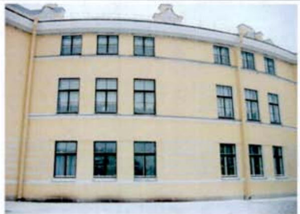
16. Юго-восточный фасад полуциркульного объема. Общий вид
