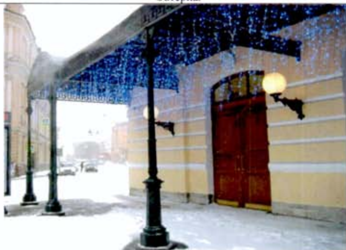
5. Лицевой фасад. Металлические опорные колонки, «зонтик» над главным входом в здание.
