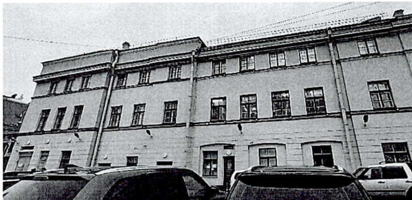
Фото 3. Фрагмент лицевого фасада
