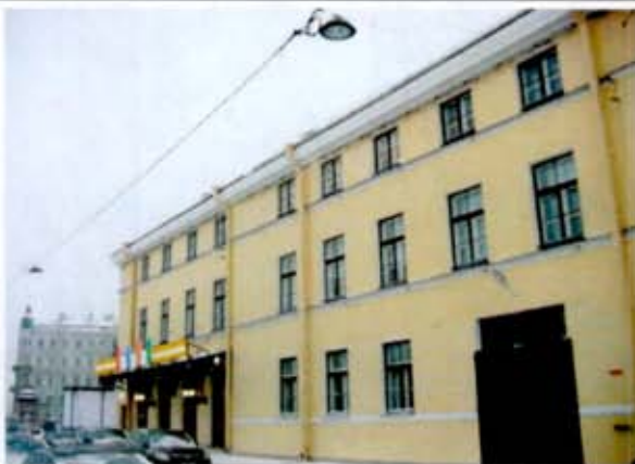
17. Фрагмент восточного фасада.
