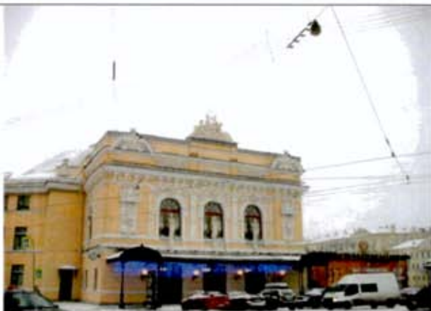
1. Лицевой фасад. Общий вид.
