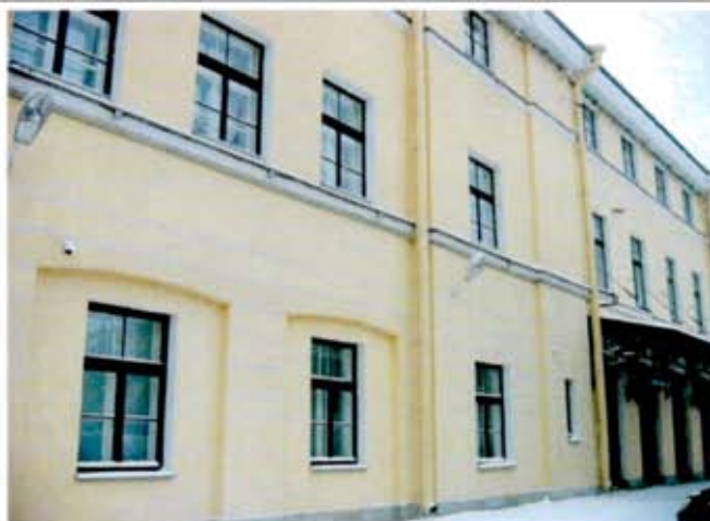
12. Фрагмент западного фасада.
