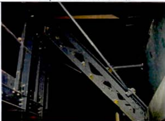
31. Фрагмент конструкции купола.
