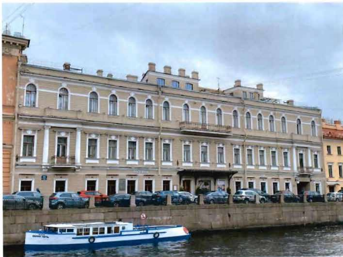
1. Общий вид на объект культурного наследия.
