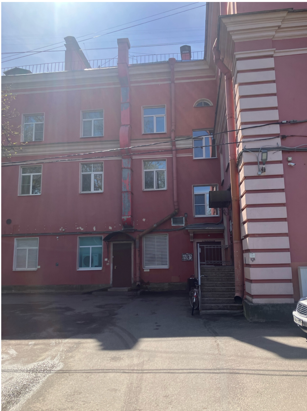
2. Фрагмент дворового фасада.
