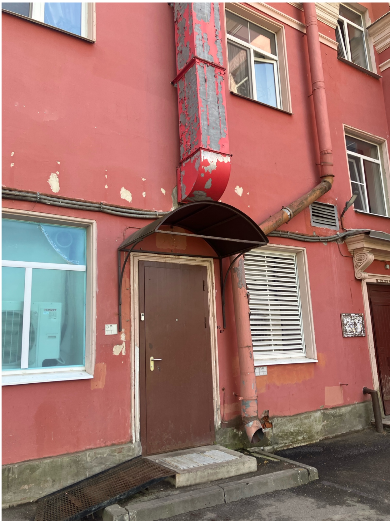
3. Фрагмент дворового фасада. Вход в помещение 1-Н.
