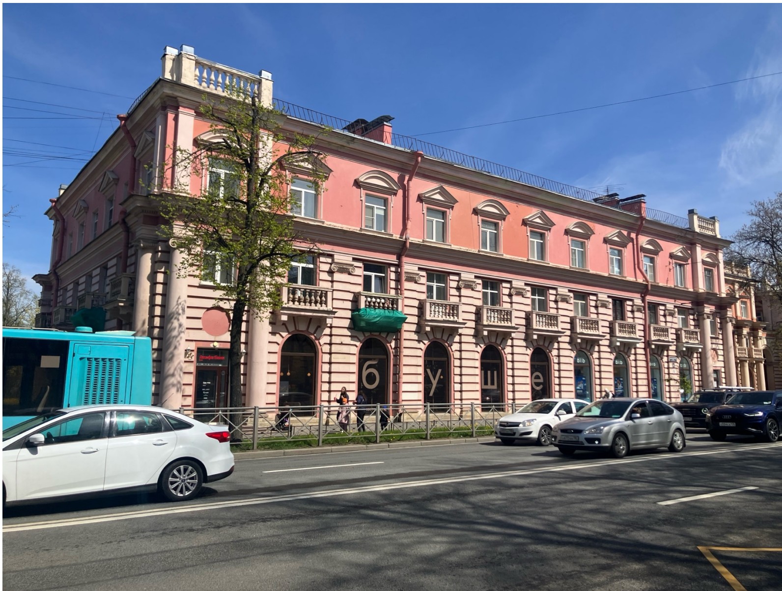
1. Общий вид лицевого фасада.
