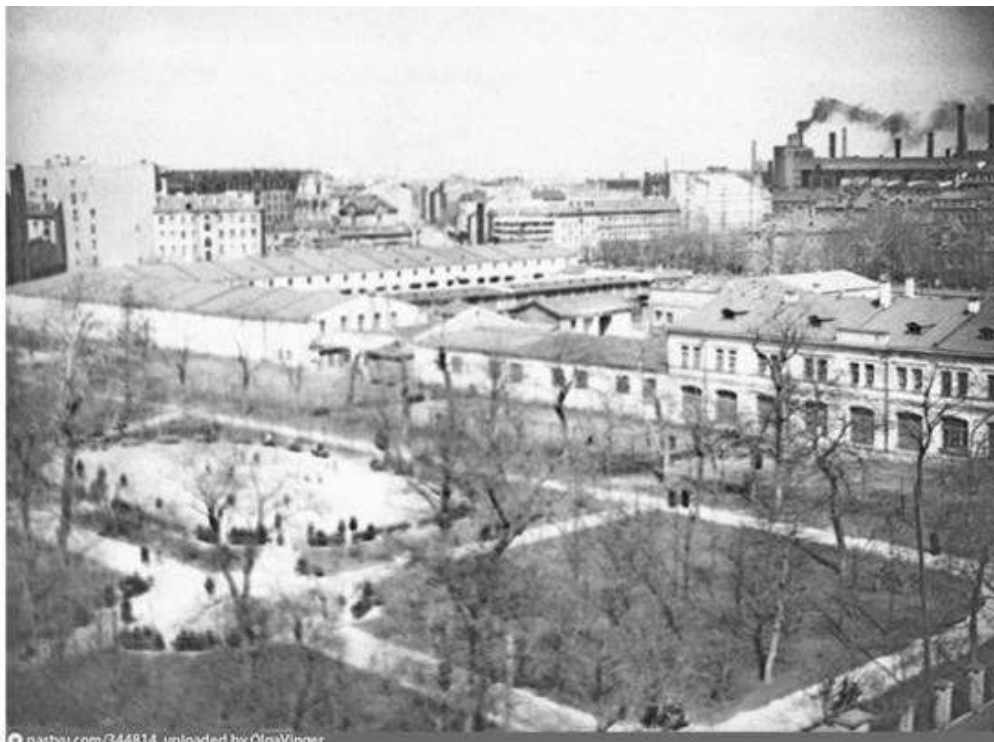
Илл. 23. Вид на сквер им. Н. Г. Чернышевского (Овсянниковский сквер) и корпуса Мытного двора с крыши дома № 1 по Херсонской ул. Справа виден фрагмент фасада исследуемого корпуса Мытного двора.
