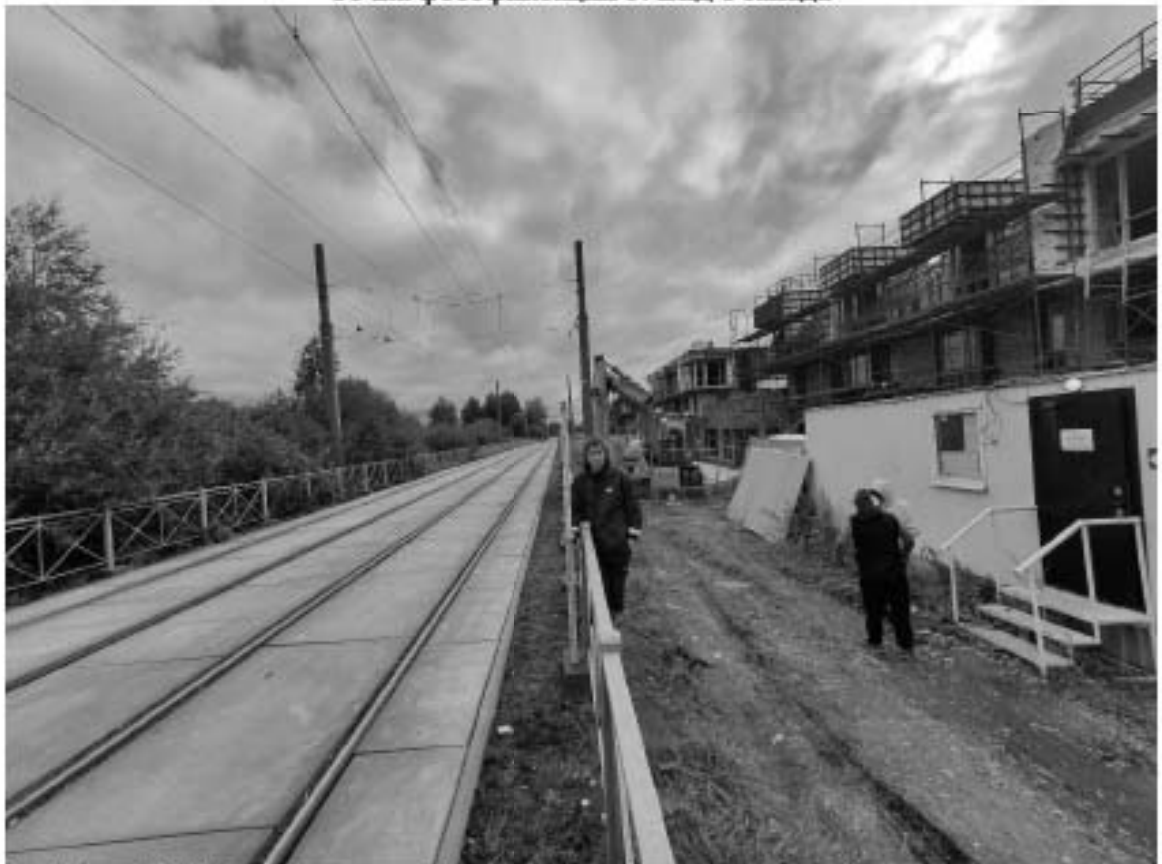
Рис. 15. СПб – 2021. Петродворцовый район, пос. Стрельна. Общий вид участка обследования. Точка фотофиксации 6. Вид с запада
