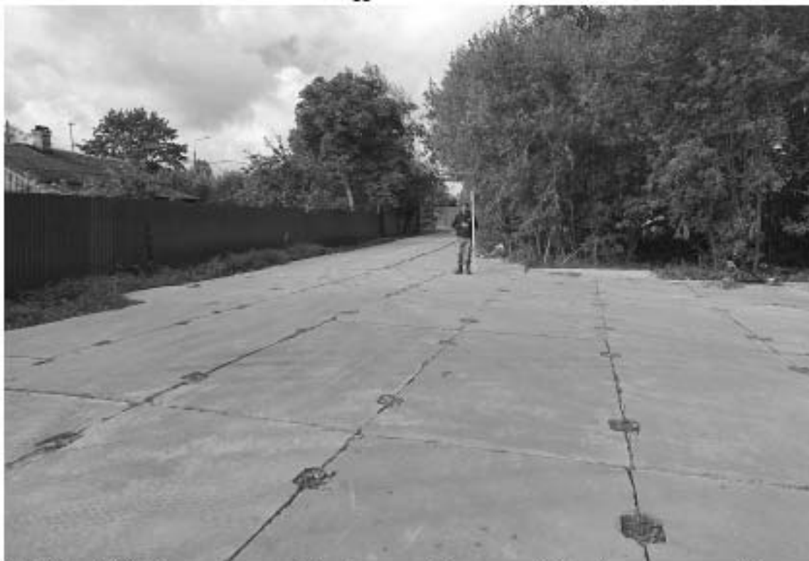
Рис. 12. СПб – 2021. Петродворцовый район, пос. Стрельна. Общий вид участка обследования. Точка фотофиксации 3. Вид с востока
