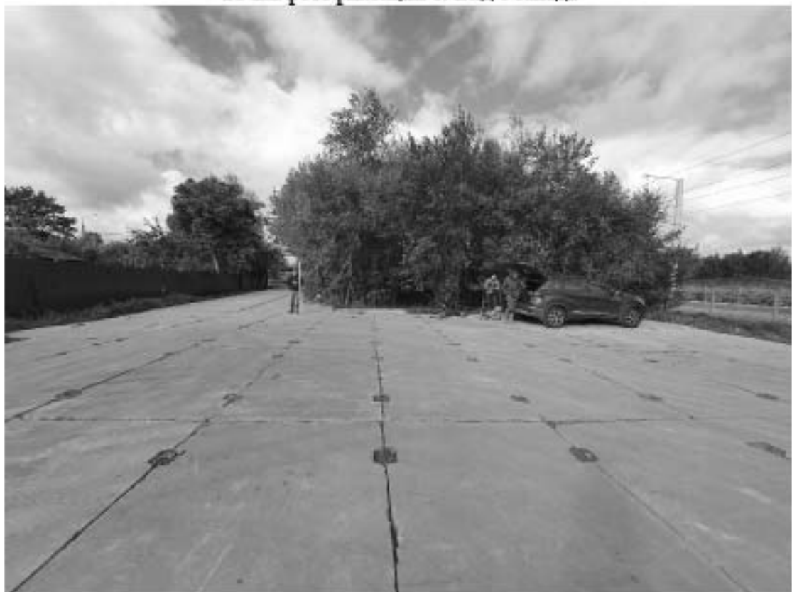
Рис. 11. СПб – 2021. Петродворцовый район, пос. Стрельна. Общий вид участка обследования. Точка фотофиксации 2. Вид с востока
