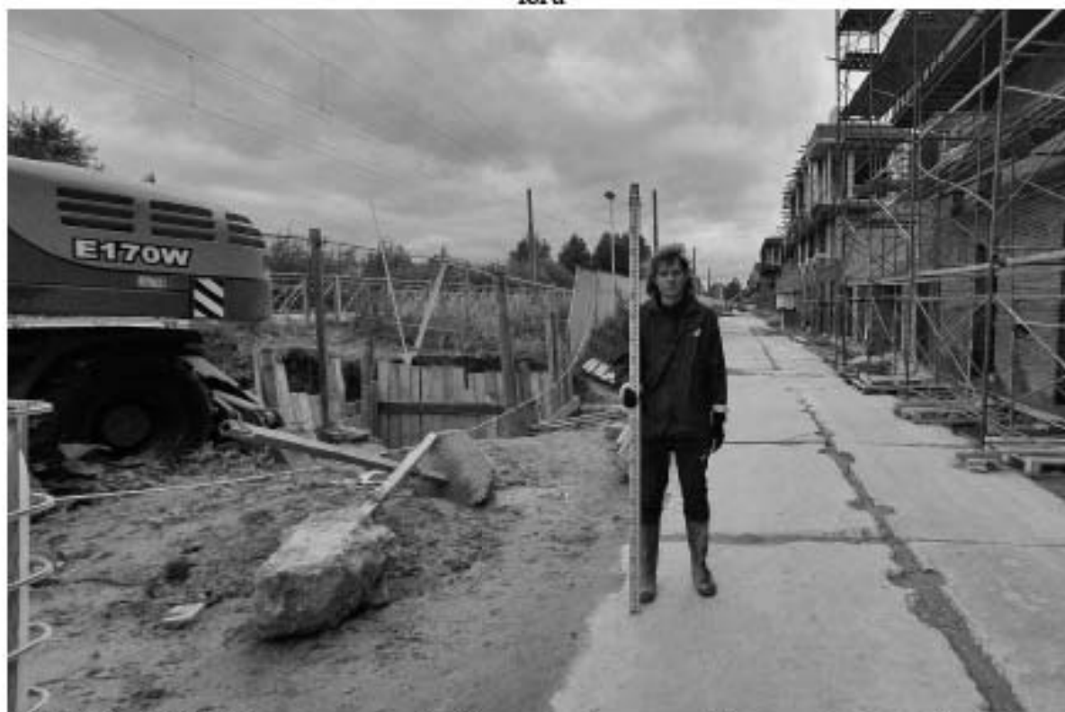
Рис. 21. СПб – 2021. Петродворцовый район, пос. Стрельна. Зачистка 1. Общий вид до начала работ. Вид с запада
