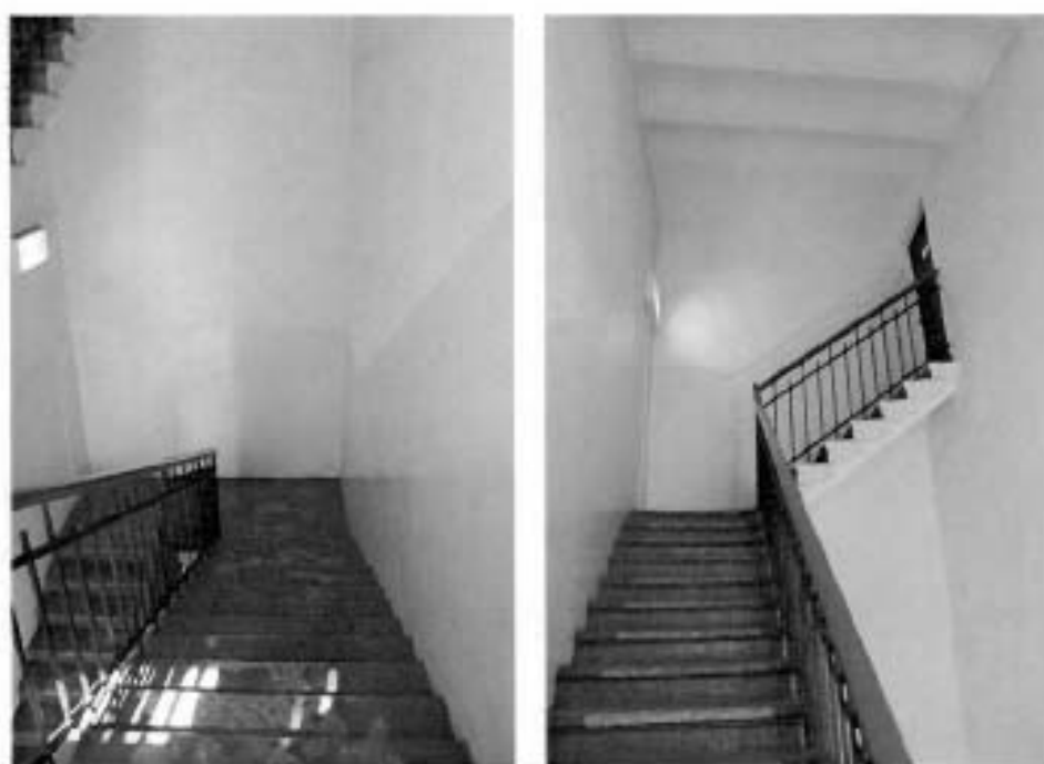
Фото №21, 22. Черная лестница.
