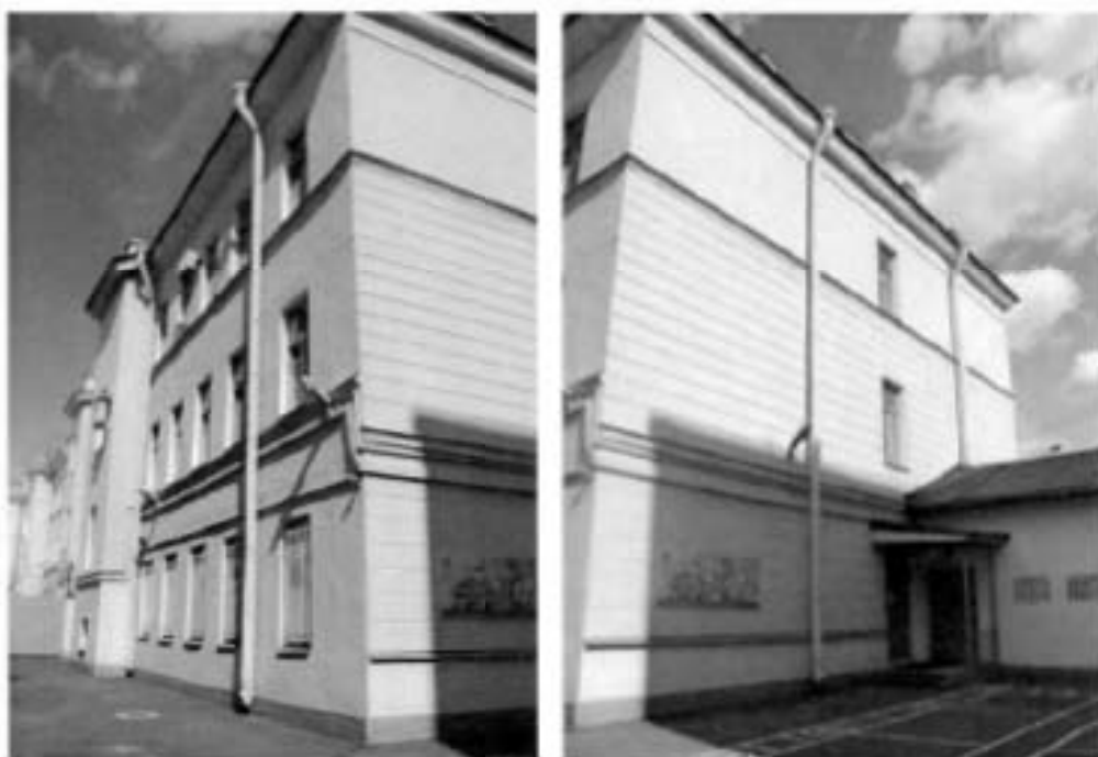
Фото №17, 18. Дворовые фасады.
