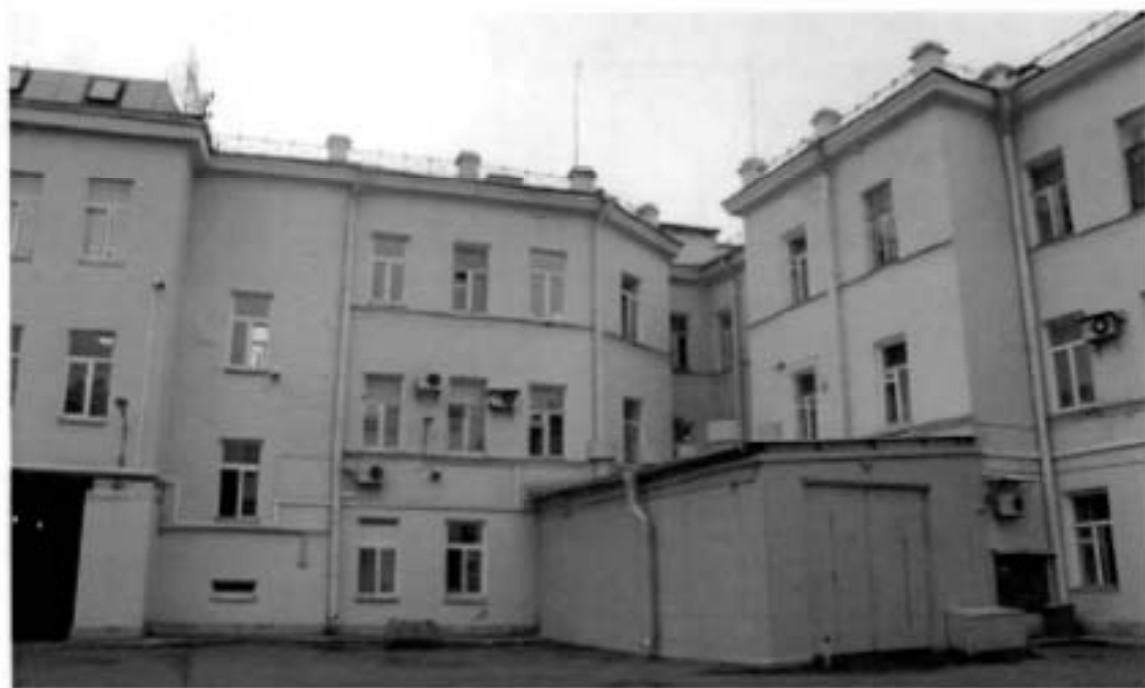
Фото №4. Дворовые фасады.
