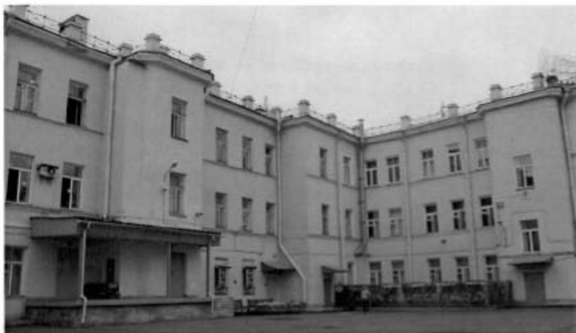
Фото №3. Дворовые фасады.
