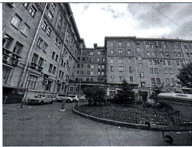
Фото 8. Фрагмент северного и восточного дворовых фасадов объекта культурного наследия.
