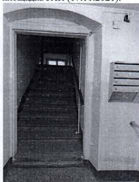
72. Промежуточная площадка 3ЛК (17.11.2021).
