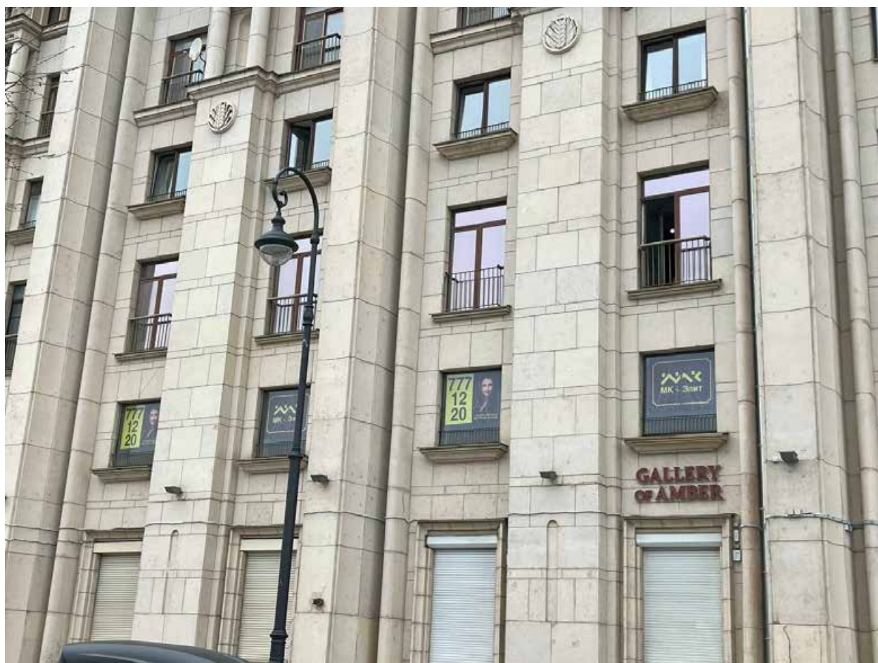
Фото №2. Лицевой фасад, обращенный на набережную, оконные заполнения квартиры №74 в уровне третьего этажа.
