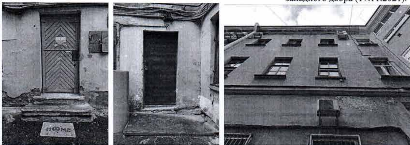
45. Фрагмент фасада западного двора (17.11.2021).
