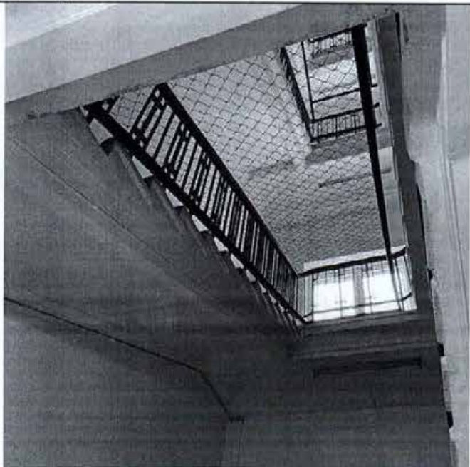
Фото 35. Лестница объекта культурного наследия.
