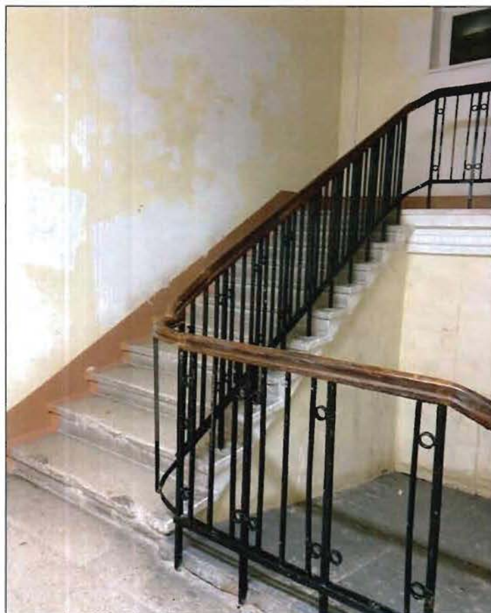
12. Лестница объекта культурного наследия.
