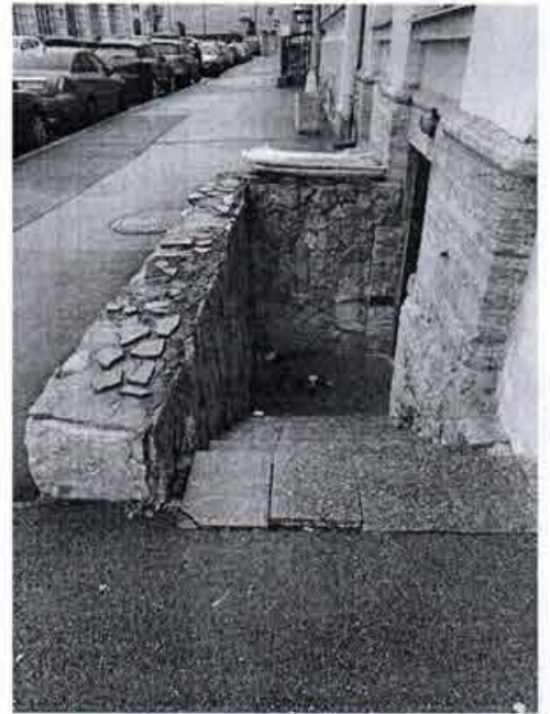
11. Прямок по западному лицевому фасаду (17.11.2021).
