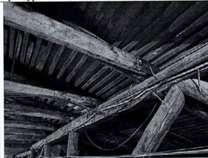
Фото 22. Фрагмент стропильной системы объекта культурного наследия.
