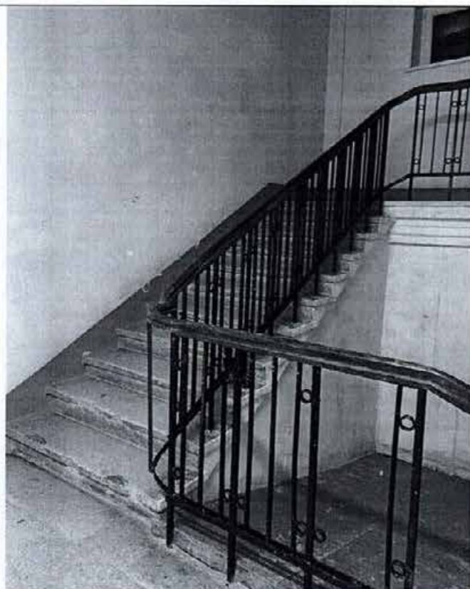
Фото 33. Лестница объекта культурного наследия.
