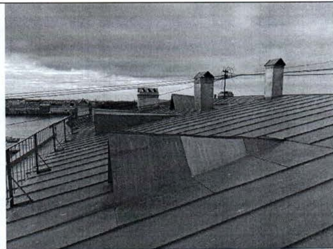
Фото 10. Фрагмент кровельного покрытия объекта культурного наследия.
