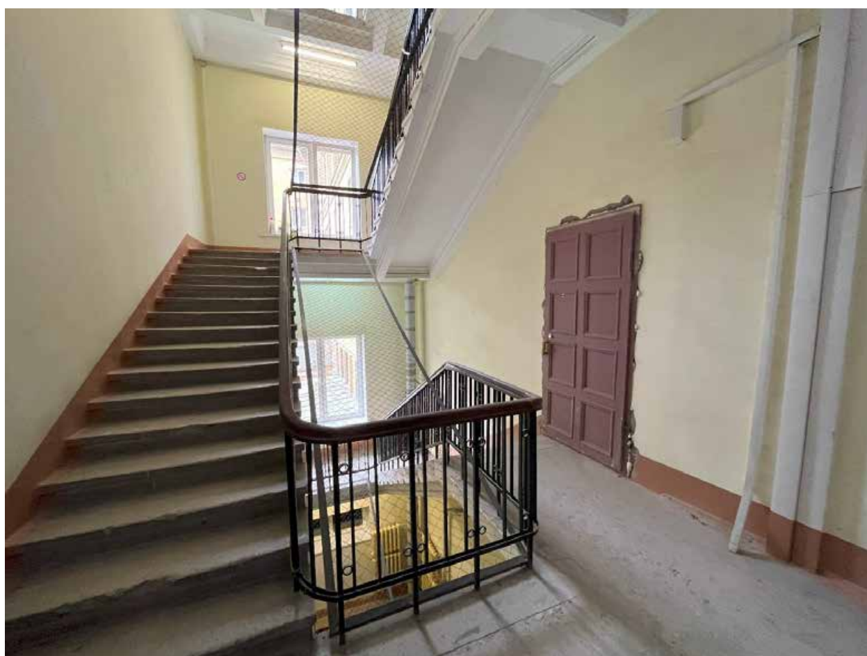
Фото №5. Лестничная площадка третьего этажа, вход в квартиру №74.
