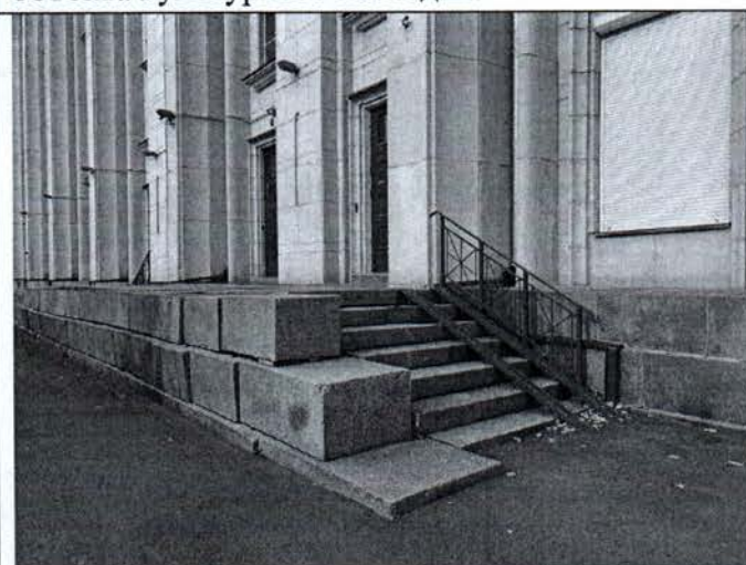
Фото 11. Крыльцо лицевого фасада (по Петровской набережной) объекта культурного наследия.
