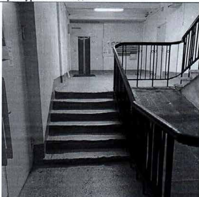
Фото 36. Лестница объекта культурного наследия.
