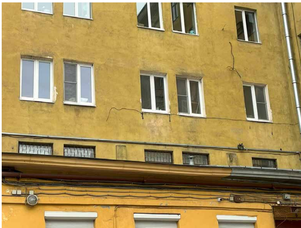
Фото №4. Дворовый фасад, окна квартиры №74 в уровне третьего этажа.
