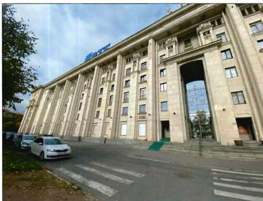
2. Западная часть лицевого фасада объекта культурного наследия по Петровской набережной.
