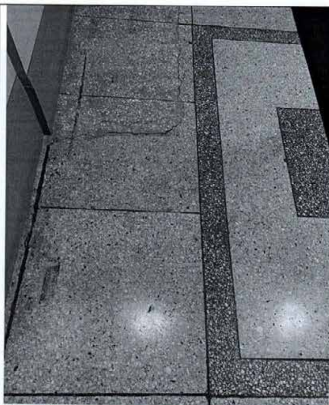
Фото 26. Напольное покрытие (терраццо) лестничного пролета объекта культурного наследия.
