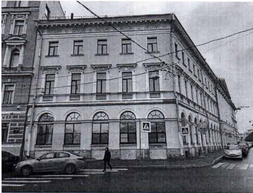
10. Западный лицевой фасад по Аптекарскому переулку (17.11.2021).
