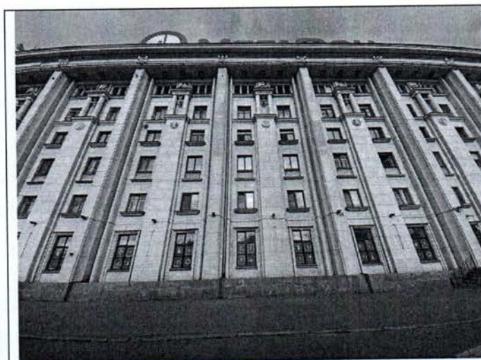
Фото 1. Центральная часть лицевого фасада объекта культурного наследия по Петровской набережной.
