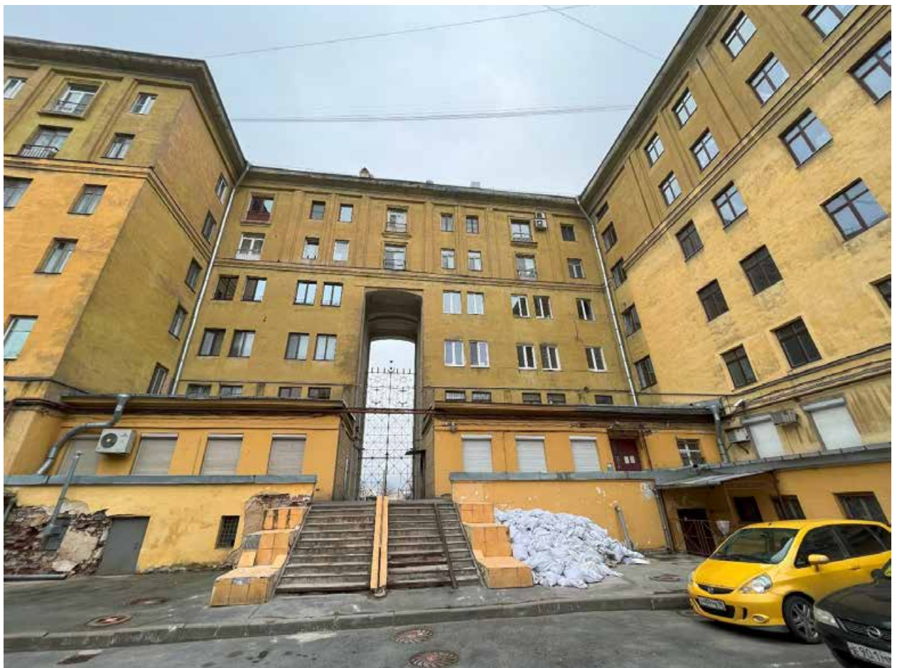
Фото №3. Дворовый фасад.
