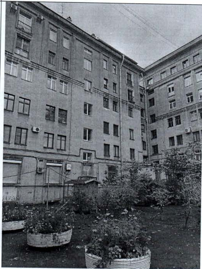
Фото 6. Фрагмент западной части северного и южной части западного фасадов объекта культурного наследия.
