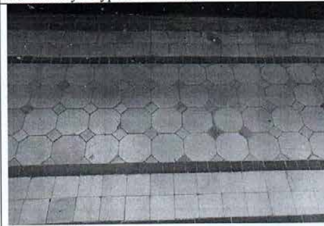
Фото 24. Метлахская плитка лестничного пролета объекта культурного наследия.
