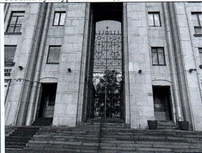
Фото 12. Крыльцо и арочный проем в центральной части лицевого фасада (по Петровской набережной) объекта культурного наследия.
