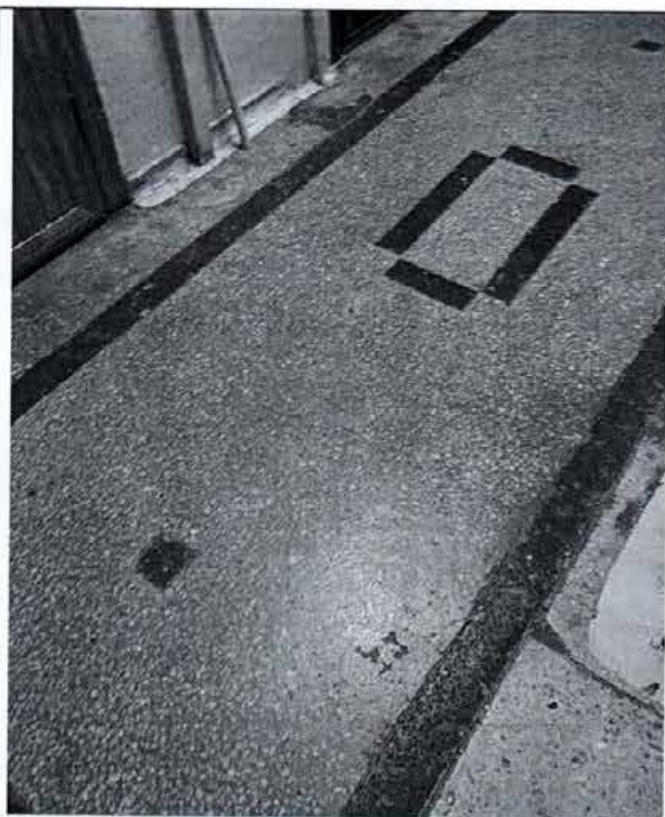
Фото 25. Напольное покрытие (терраццо) лестничного пролета объекта культурного наследия.
