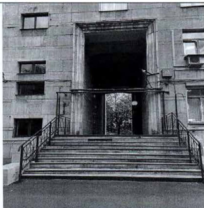
Фото 20. Крыльцо и прямоугольный проем северного дворового фасада объекта культурного наследия.
