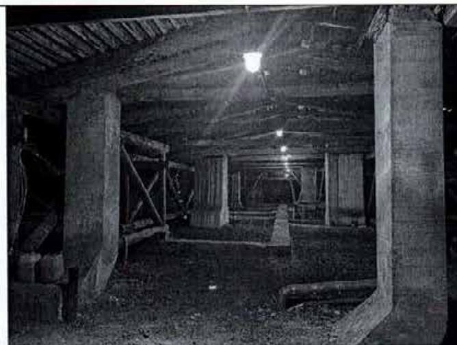
Фото 21. Стропильная система объекта культурного наследия.
