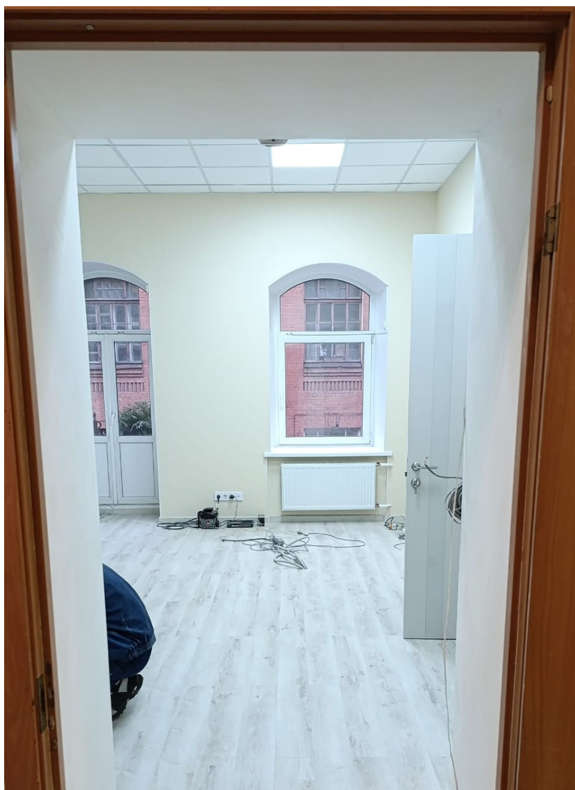
Фото №5. Помещение 15-Н (17).
