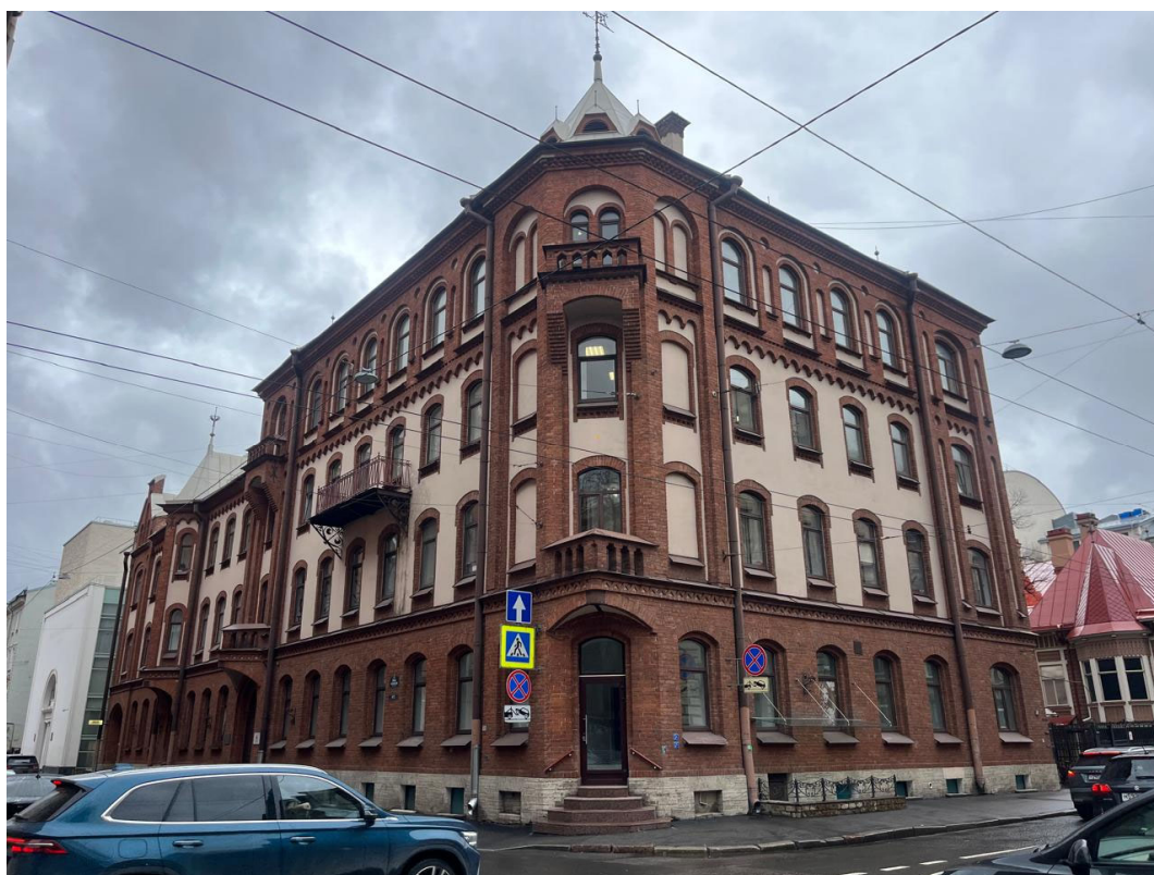
Фото №11. Южный угол здания, пересечение Большой Пушкарской улицы и улицы Лизы Чайкиной.
