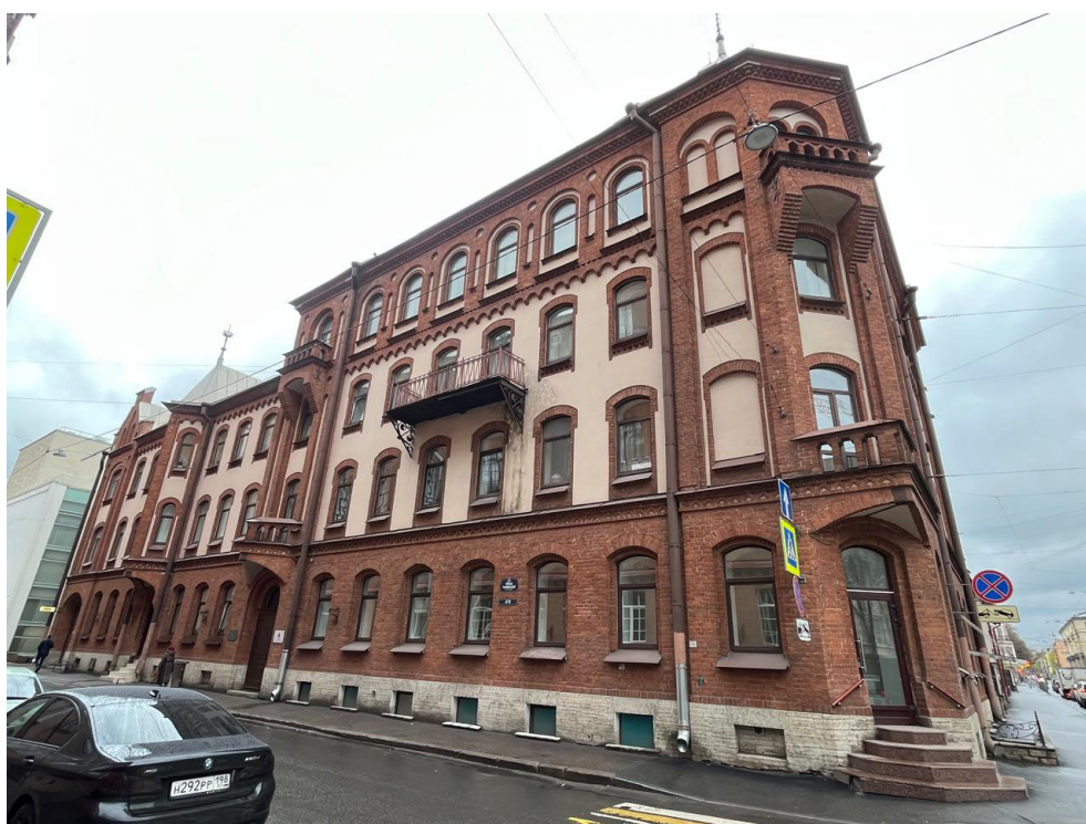
Фото №12. Юго-западный лицевой фасад по улице Лизы Чайкиной.
