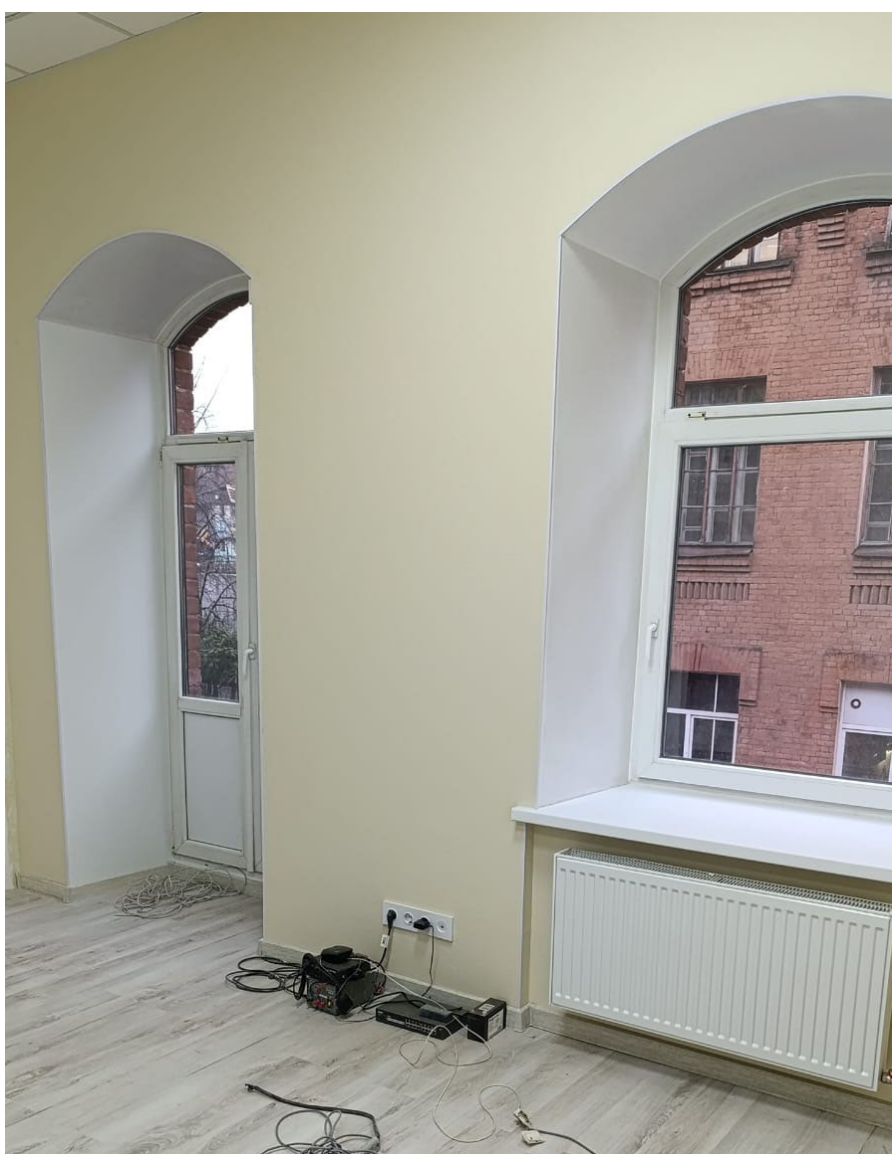
Фото №6. Помещение 15-Н (17).
