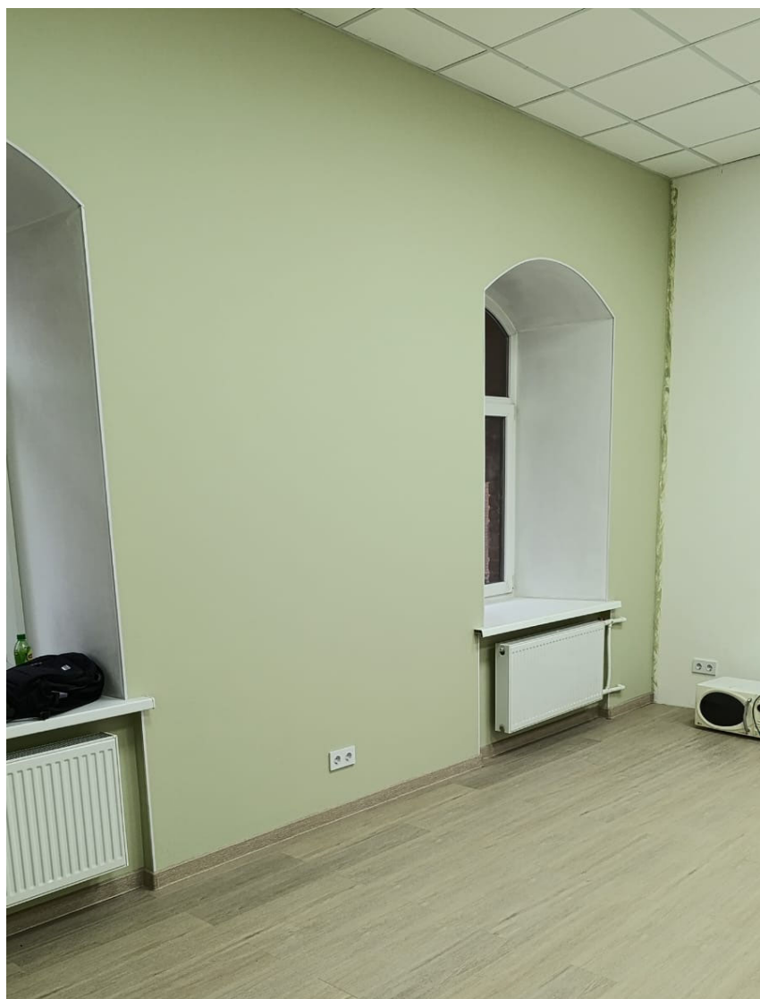
Фото №1. Помещение 15-Н (18).
