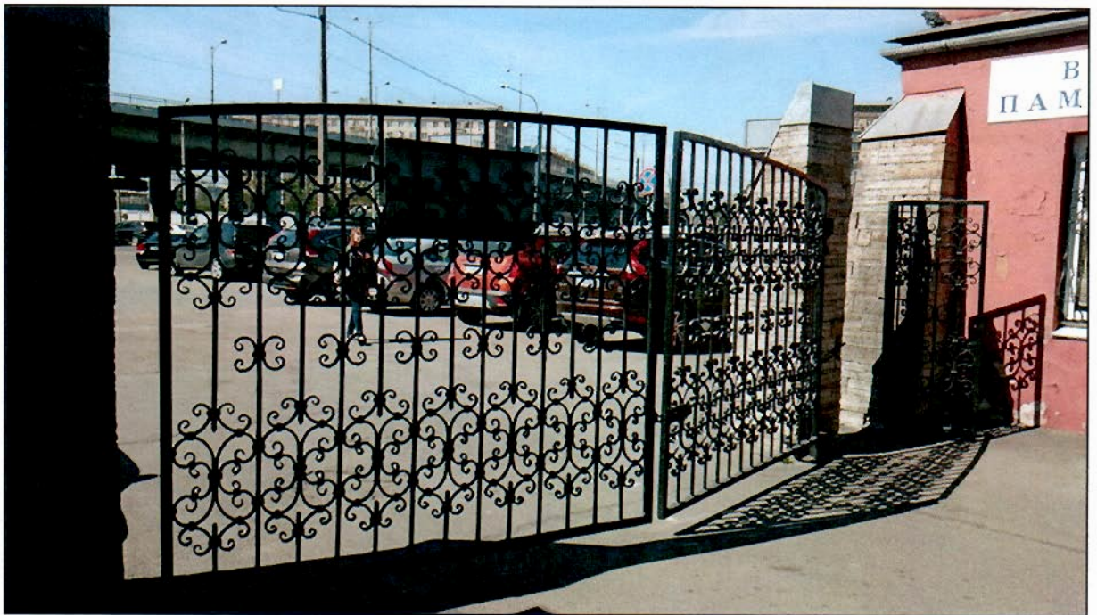
Фото 10. Пилоны ворот с восточной стороны.
