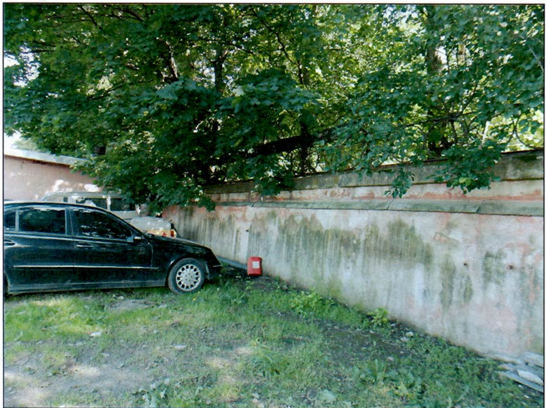
Фото 11. Каменная ограда (северная часть Красенького кладбища).
