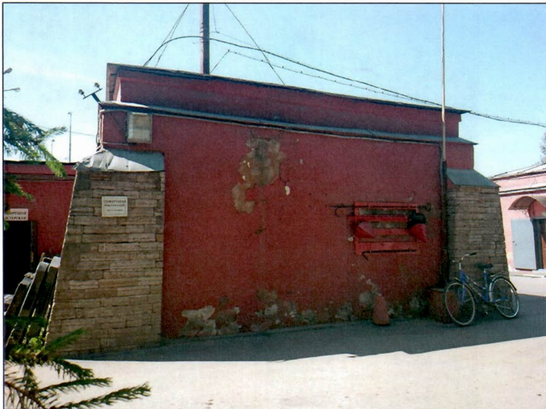
Фото 7. Юго-восточный фасад южного павильона (проспект Стачек, д. 98, лит. Б).
