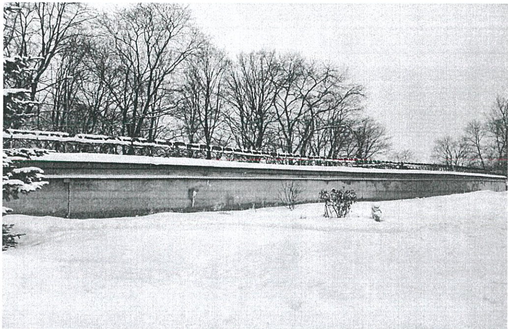
7. Общий вид ограды со стороны пр. Стачек.
