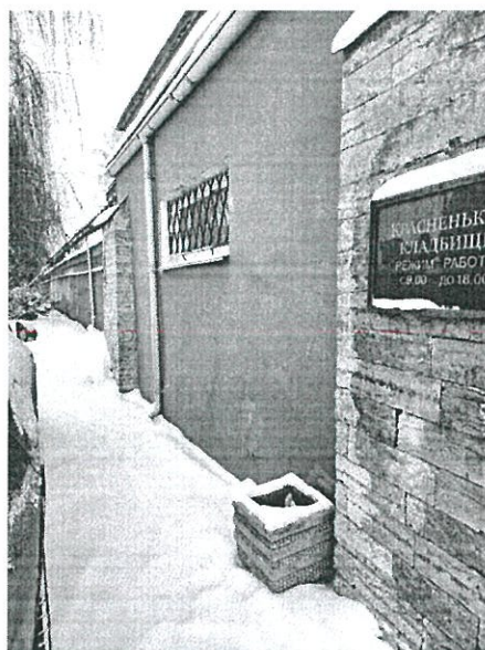
4. Общий вид фасада павильона со стороны кладбища.
