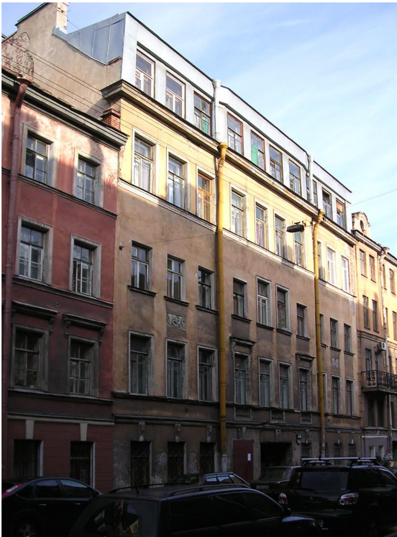
Илл. 30. Фото 2008 г. Интернет-ресурс https://www.citywalls.ru/house2111.html . Лицевой фасад, позднее архитектурно-художественное решение мансардного этажа.
