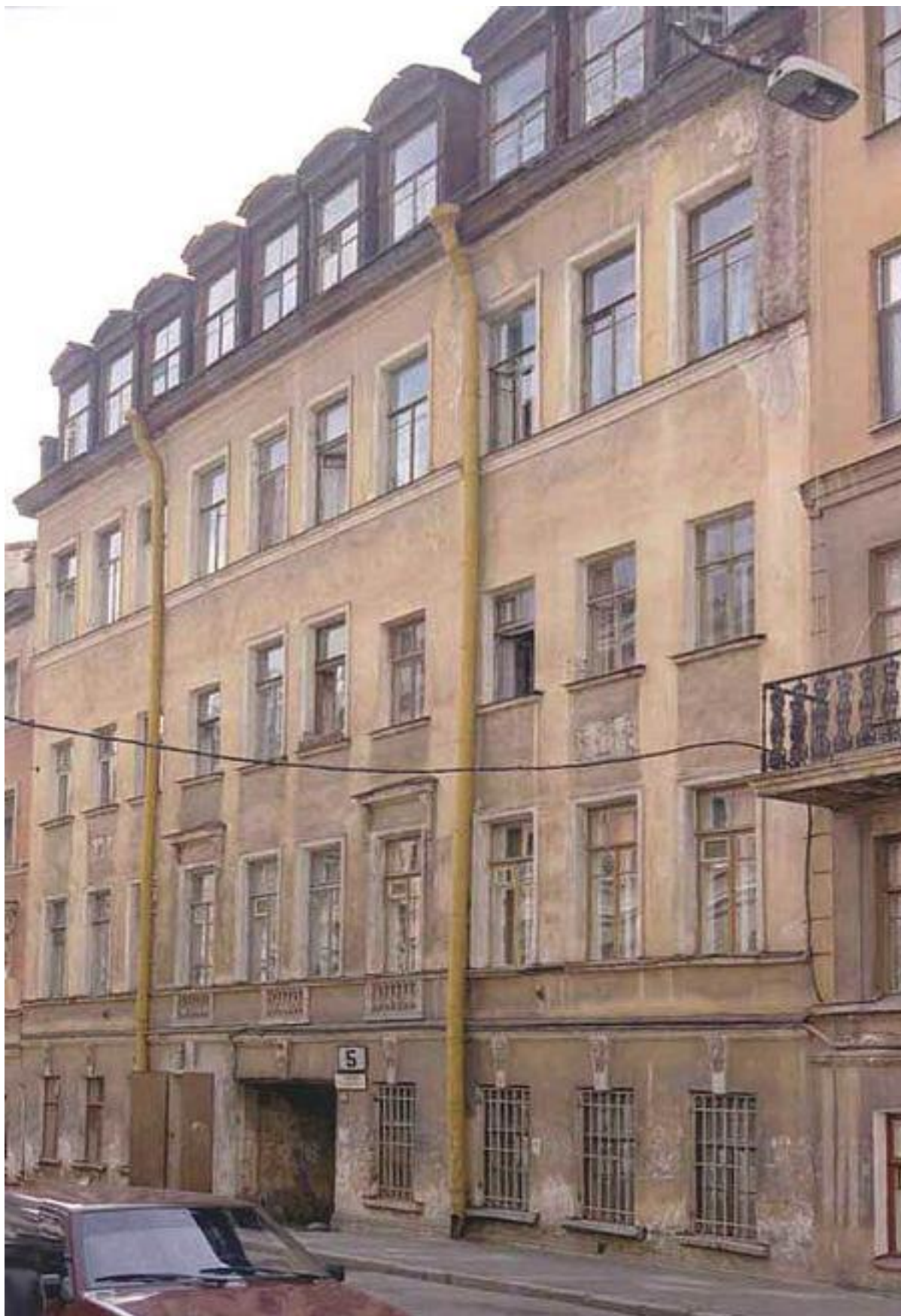
Илл. 29. Фото 1999-2001 гг. Интернет-ресурс https://www.citywalls.ru/house2111.html . Лицевой фасад, историческое архитектурно-художественное решение мансардного этажа, в целом, соответствующее фиксационным чертежам 1913-го г.
