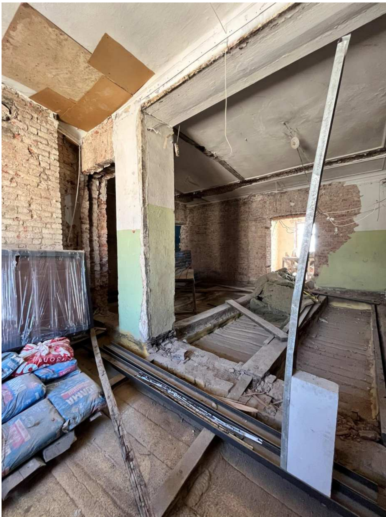
Фото 15. Вид на помещение квартиры № 81 объекта культурного наследия.
