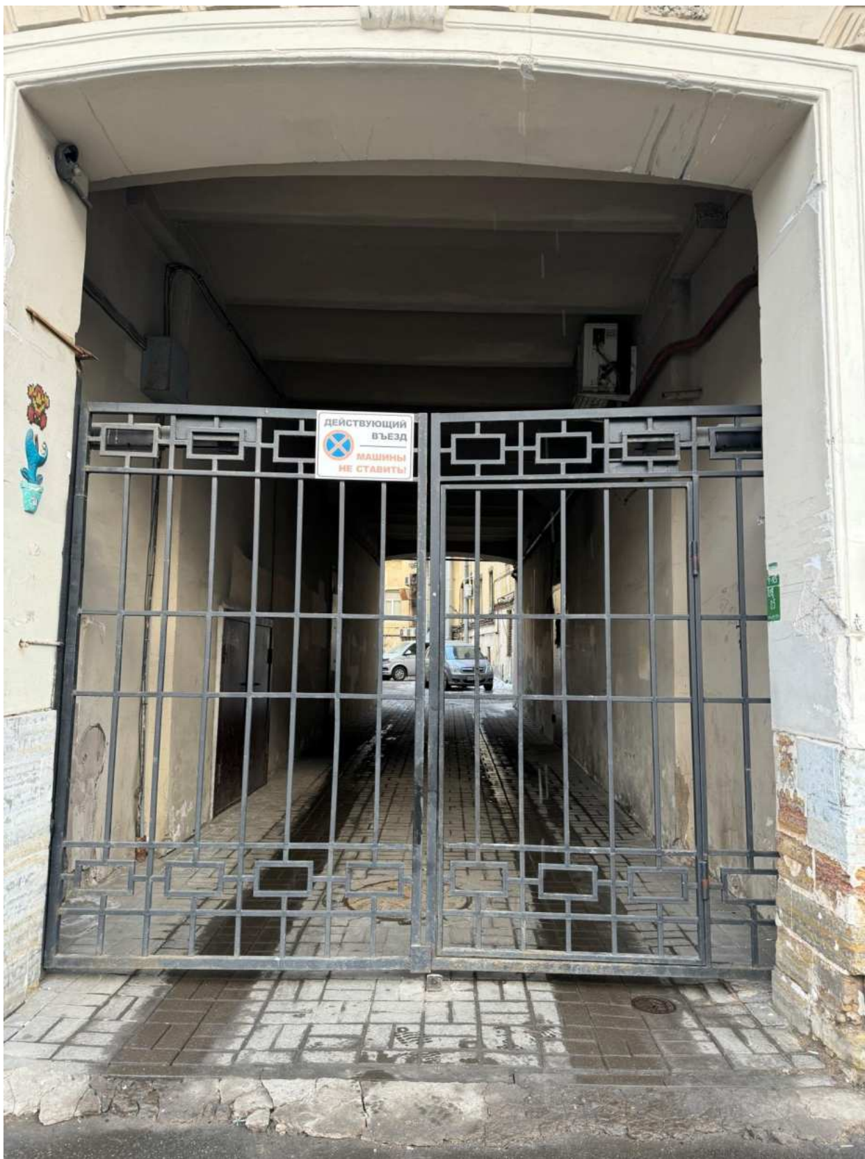
Фото 6. Вид на воротное заполнение и арочный проезд объекта культурного наследия с набережной Крюкова канала.
