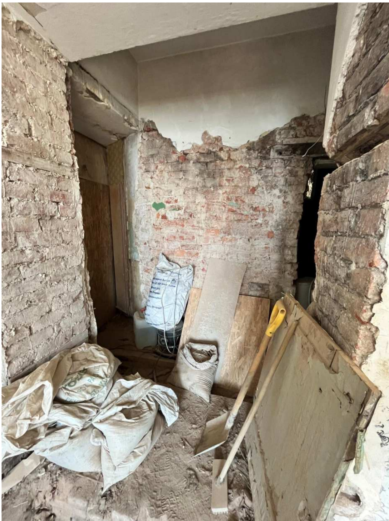
Фото 27. Вид на помещение квартиры № 81 объекта культурного наследия.
