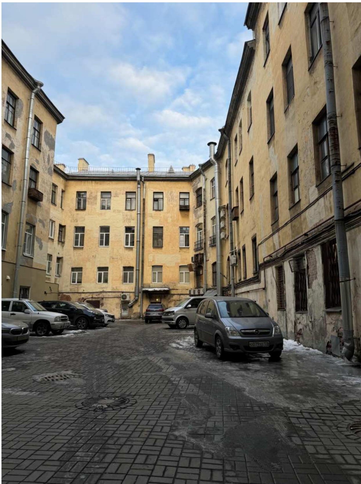
Фото 7. Общий вид дворовых фасадов объекта культурного наследия.
