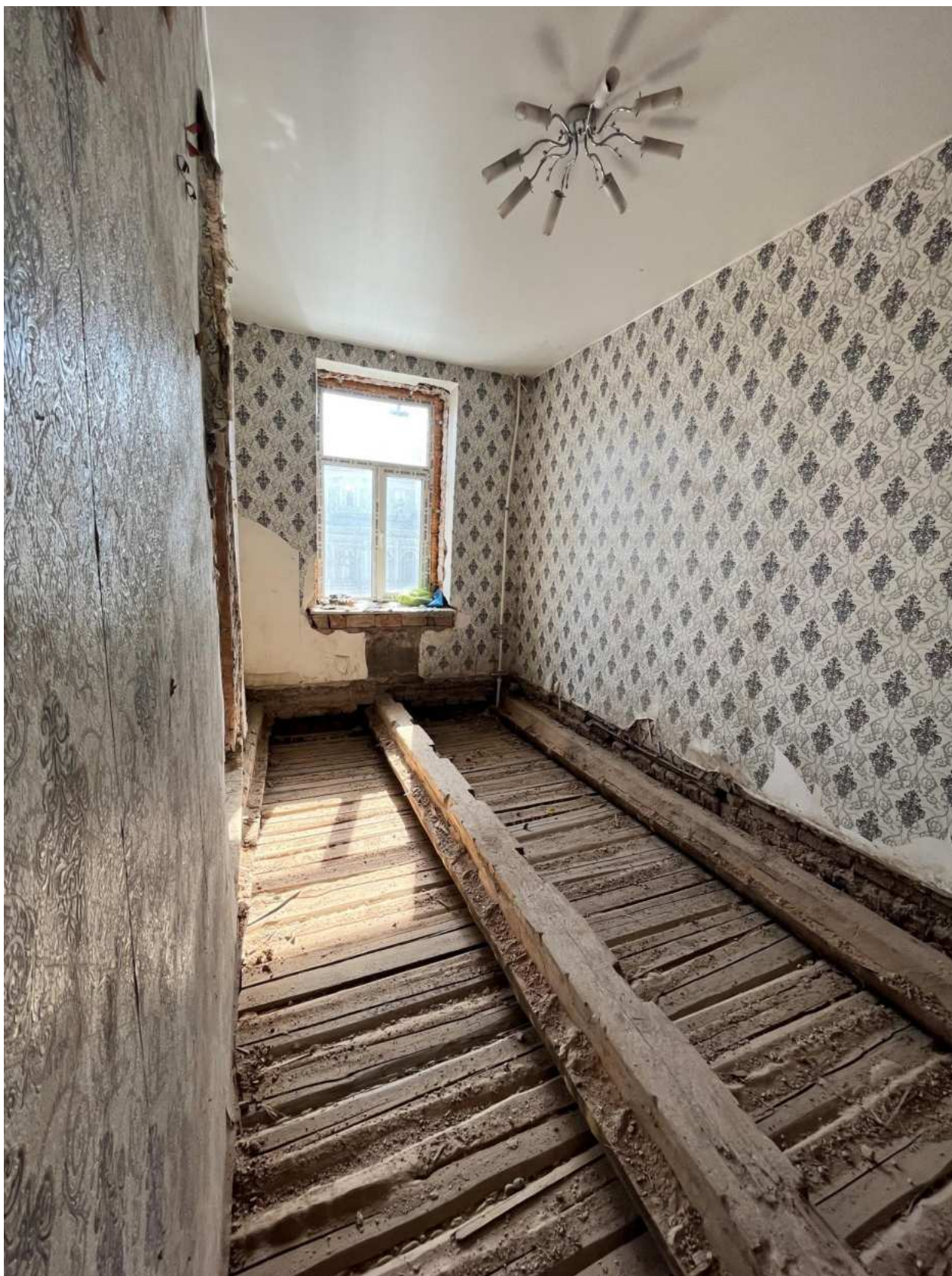
Фото 26. Вид на помещение квартиры № 81 объекта культурного наследия.
