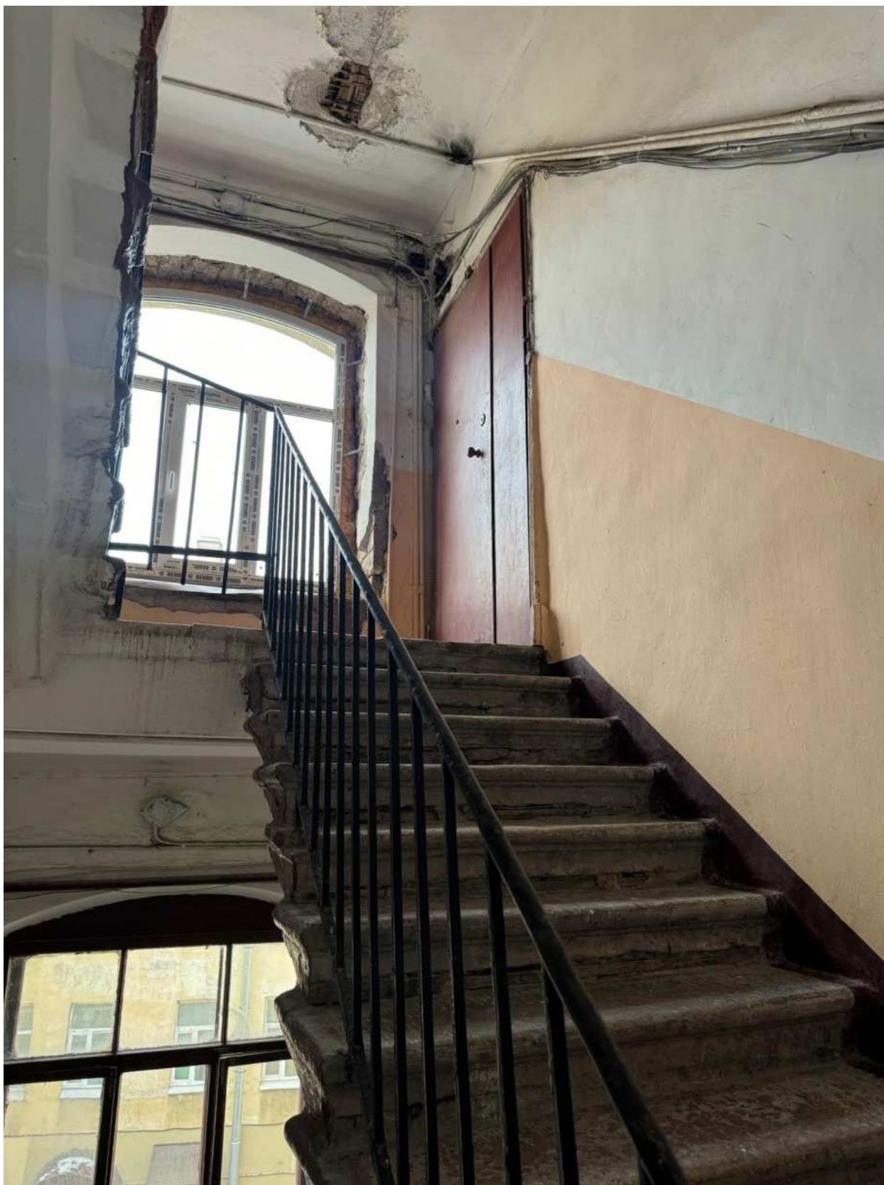
Фото 10. Лестница, ведущая в квартиру № 81, объекта культурного наследия.
