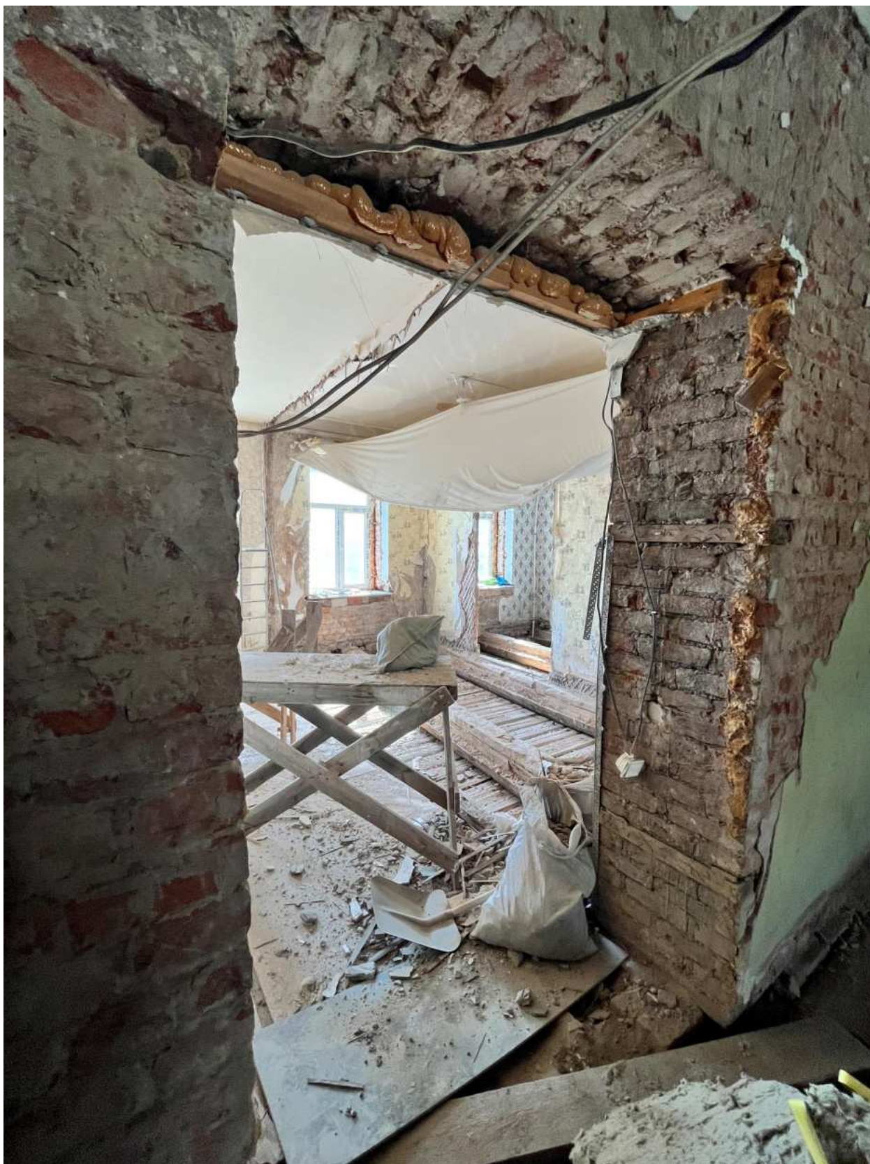
Фото 20. Вид на помещение квартиры № 81 объекта культурного наследия.
