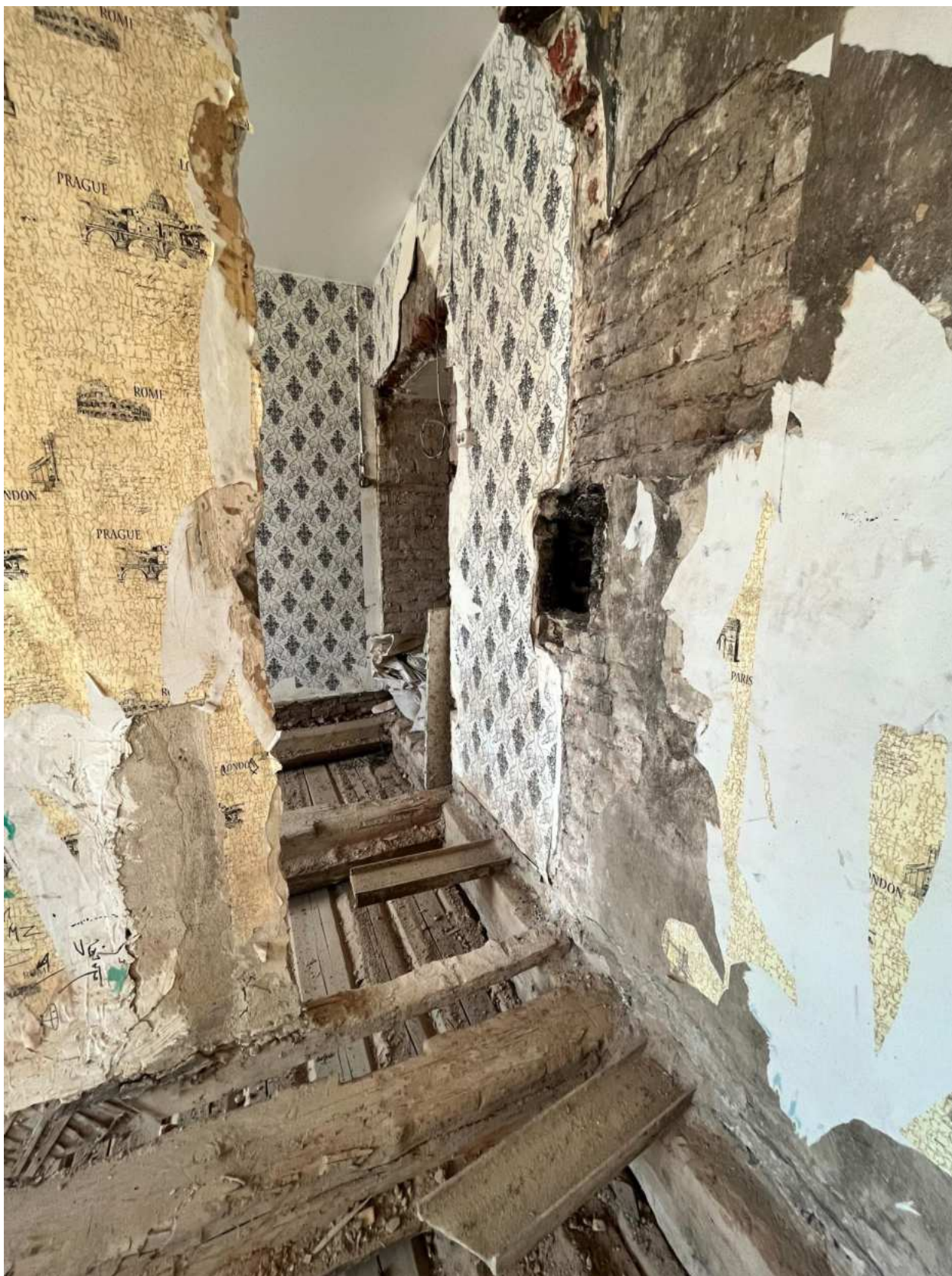
Фото 25. Вид на помещение квартиры № 81 объекта культурного наследия.
