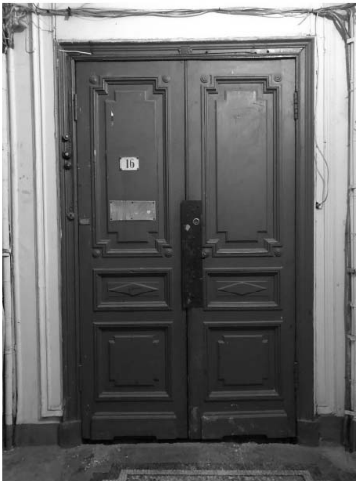
4. Входная дверь в квартиры №16 со стороны лестничной клетки 2ЛК.
