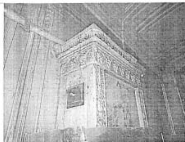
Фото 18. Фрагмент вестибюля -нечь
