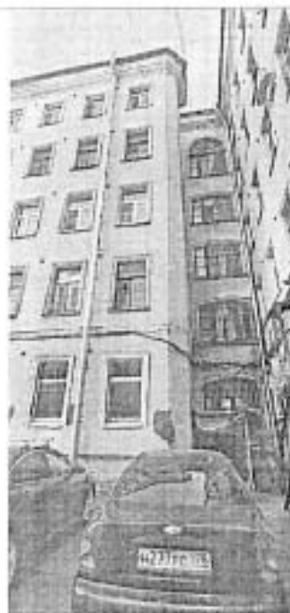
Фото 6. Фрагмент дворового фасада
