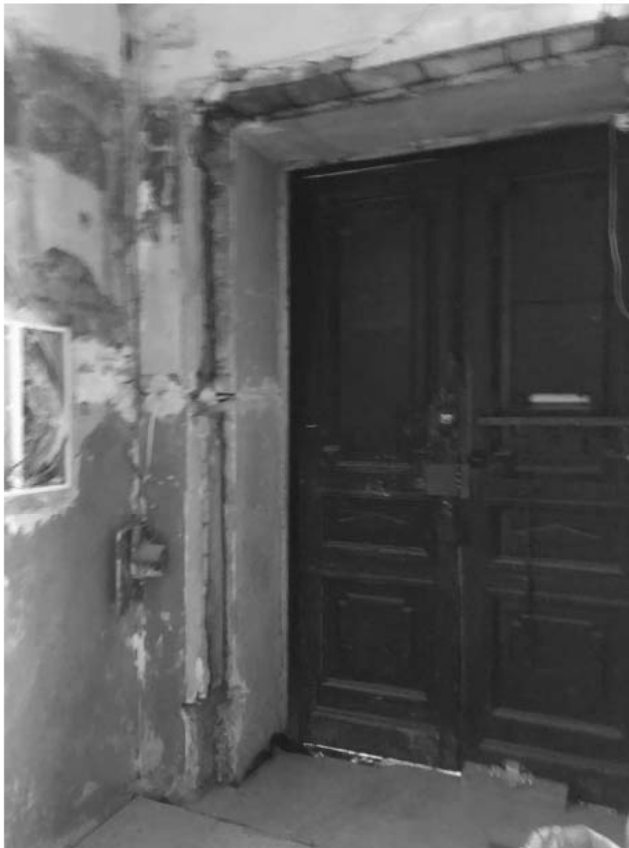
6. Вид на входную дверь изнутри в квартиру №16 со стороны 2ЛК.
