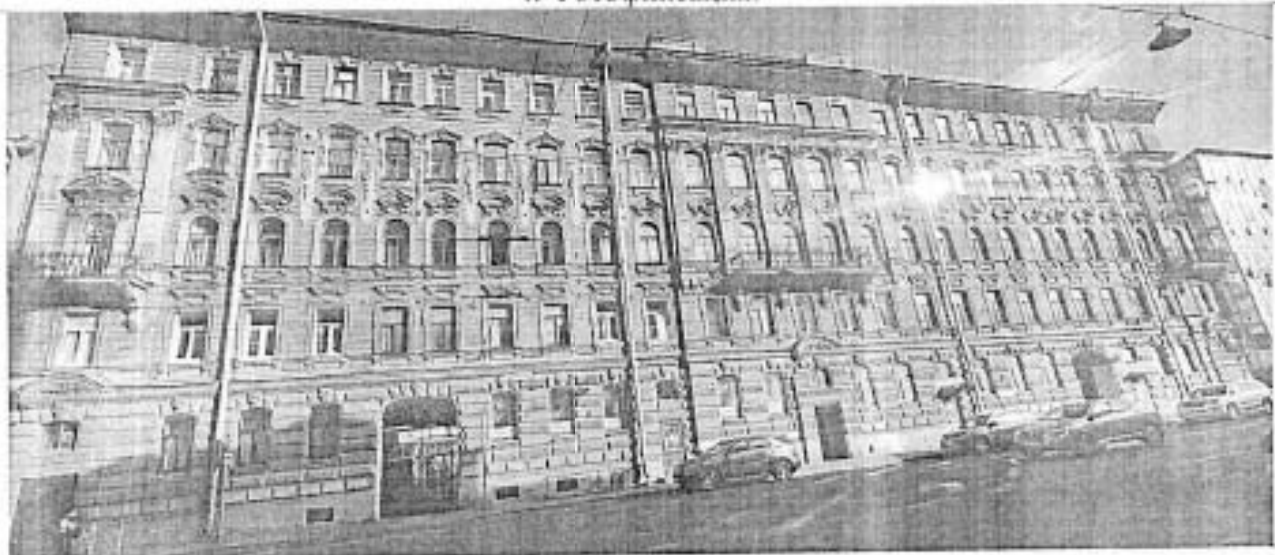
Фото 1. Лицевой фасад по улице Марата
