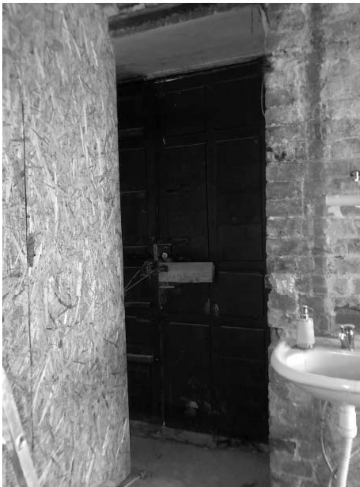
5. Вид на входную дверь изнутри в квартиру №16 со стороны 7ЛК.
