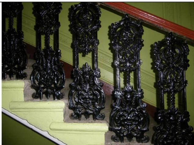
5-ЛК – двухмаршевую, на косяках, с известняковыми ступенями, с металлическим ограждением из ажурных чугунных литых стоек, декорированных листом аканта, в поворотных частях стойки-балясины, с профилированным деревянным поручнем;
