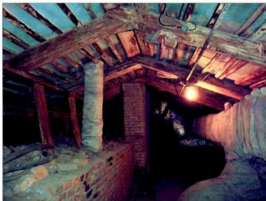
10. Чердак. Стропильная система.
