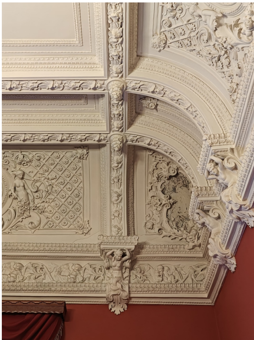
Фото №18. Пом. 40 ч.п. 1-Н (кабинет Пази В.Б.). Направление съемки: Северо-западный угол.
