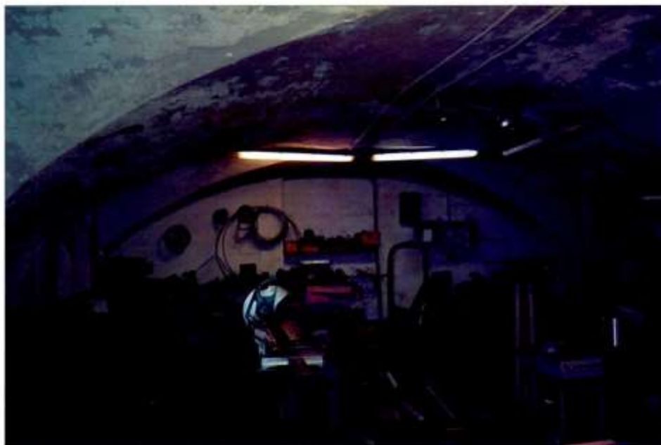
8. Коробовые с распалубками своды в уровне цокольного-первого этажа.
