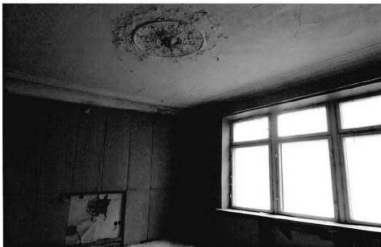
5. Помещение 2-го этажа.
