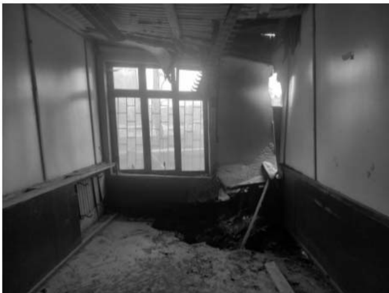
Фото 18. Внутренние помещения. 1 этаж.
