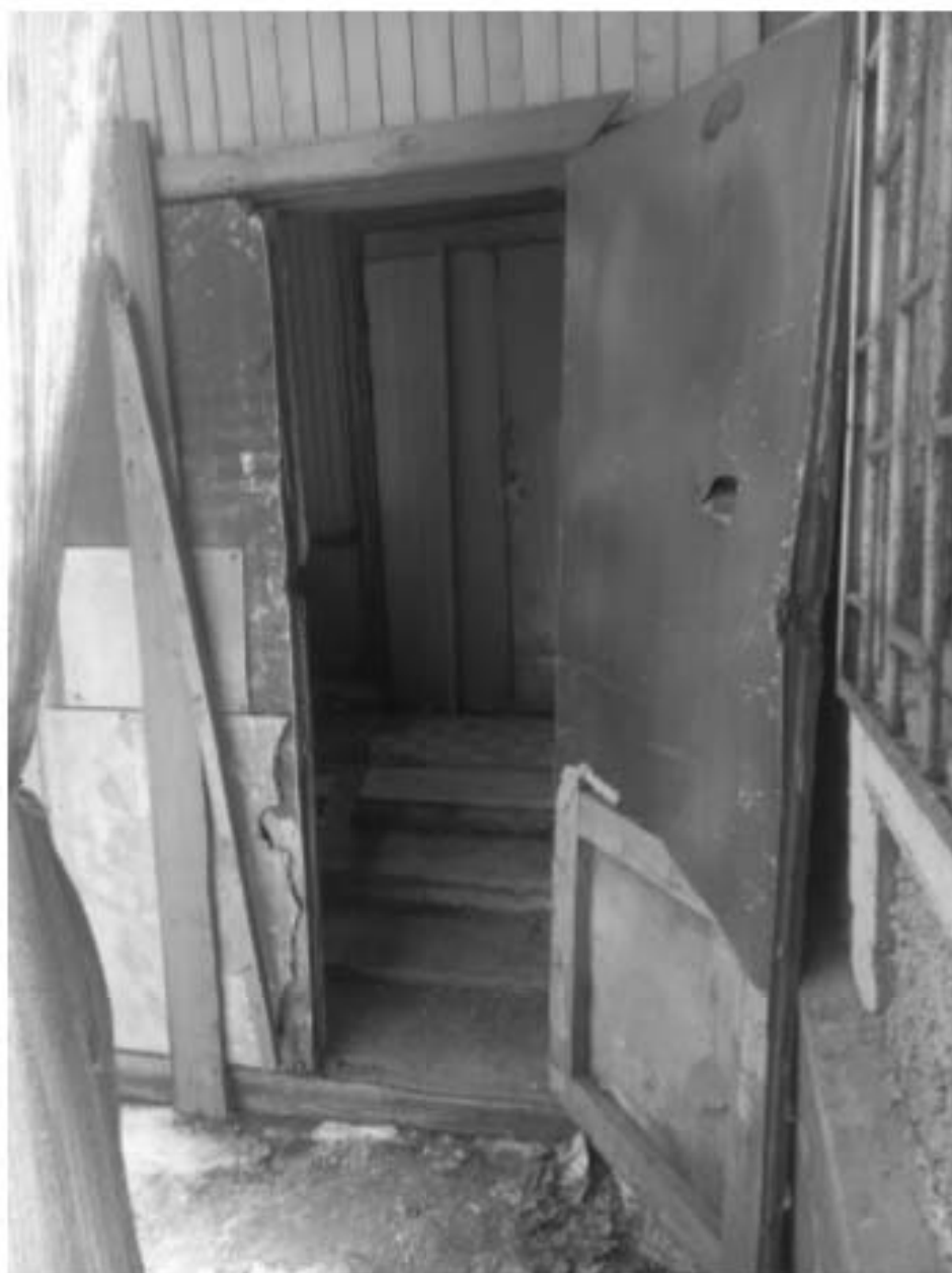
Фото 5. Главный вход в здание.
