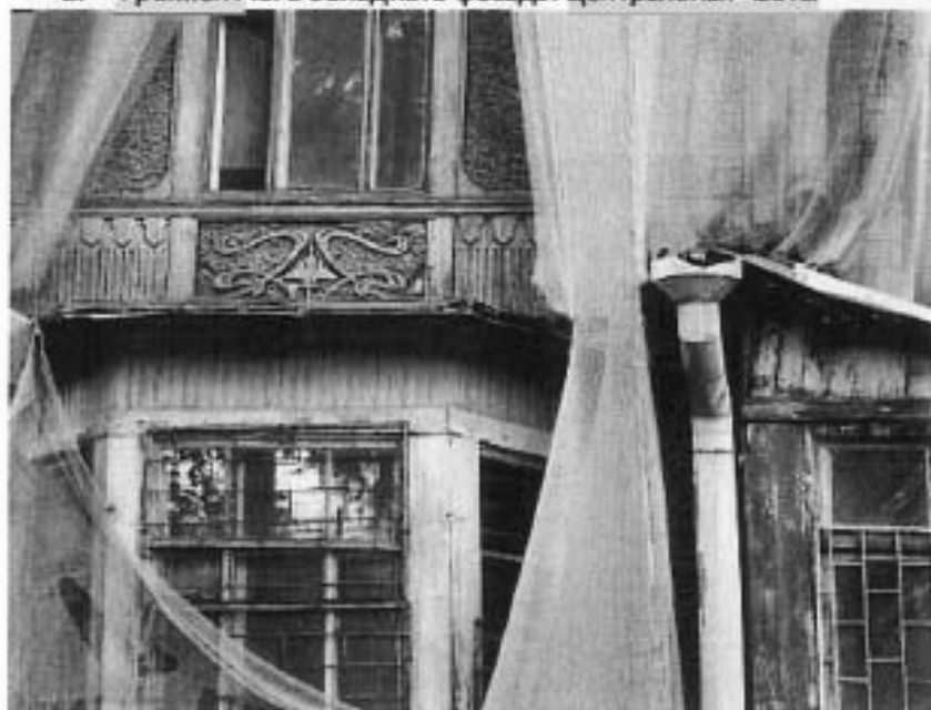
3. Фрагмент юго-восточного фасада.
