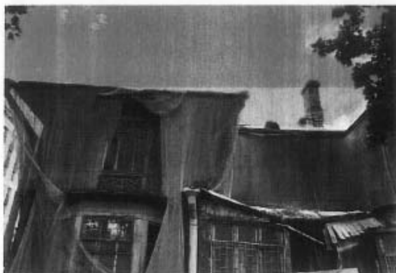
4. Фрагмент юго-восточного фасада.
