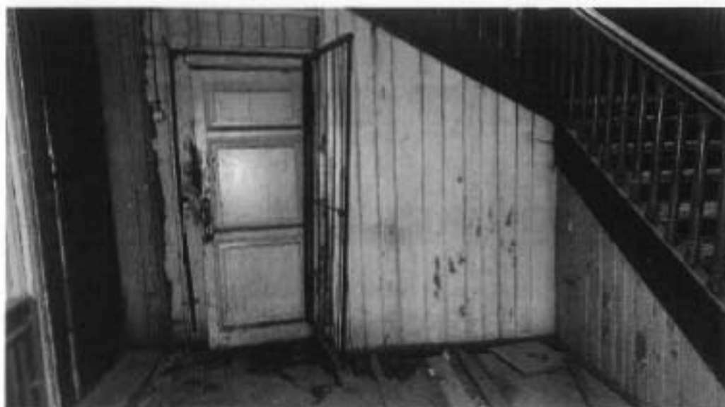
9. Помещение 1-го этажа
