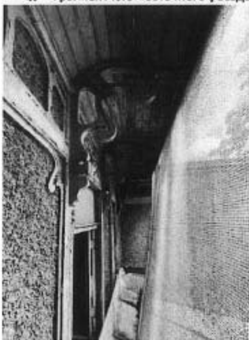
5. Декоративные элементы юго-восточного фасада.
