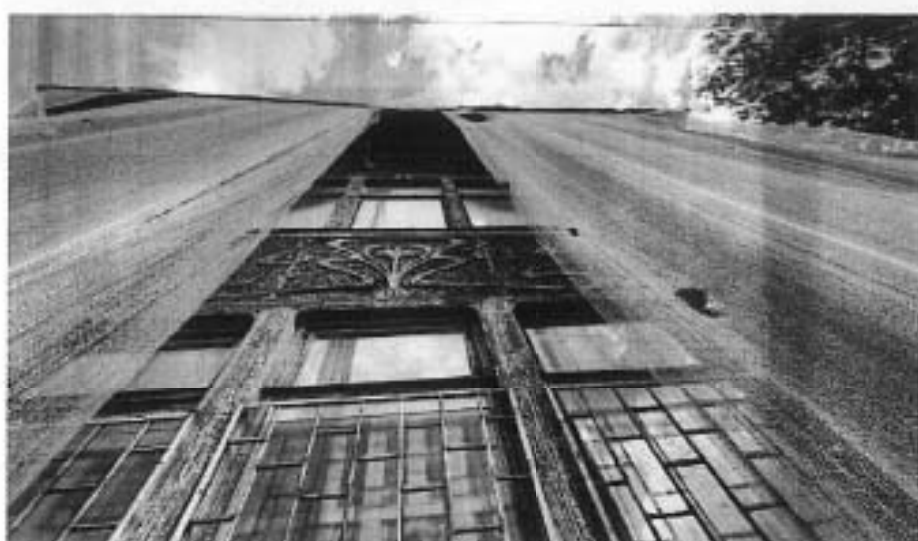
2. Фрагмент юго-западного фасада. Центральная часть
