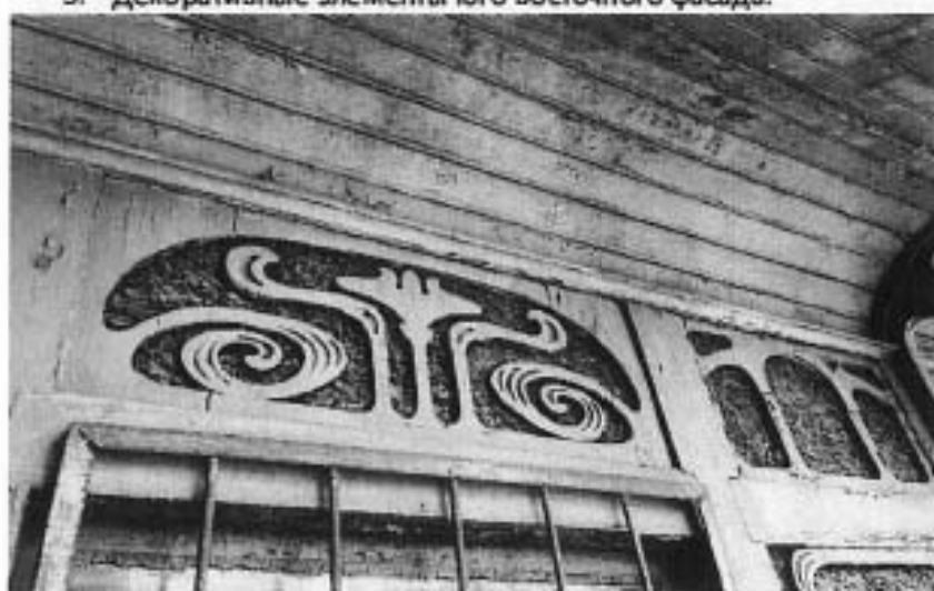
6. Декоративные элементы юго-восточного фасада.
