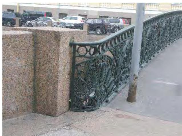
тротуары выполнены из блоков розового овоидального гранита рапакиви, рисунок укладки плит;
