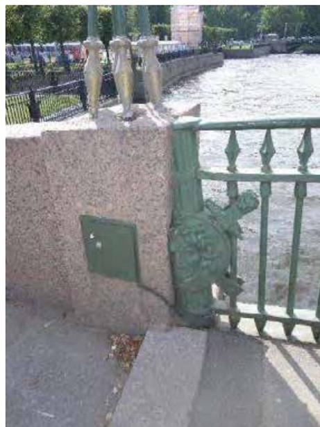
покрытие полотна моста (пешеходная зона) и тротуар примыкающей набережной – из тротуарных блоков (розовый овоидальный гранит рапакиви), рисунок укладки плит;
