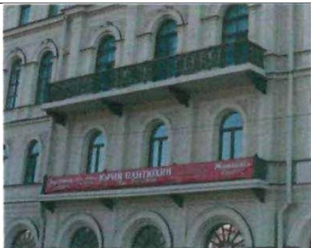
балконы в одну ось на скошенных углах в уровне второго этажа на волнитообразных кронштейнах с металлическим литым ограждением, с рисунком в виде чешуи и меандра; балконы в одну ось на скошенных углах в уровне третьего этажа на волнитообразных кронштейнах с металлическим литым ограждением в виде ажурной решетки;
