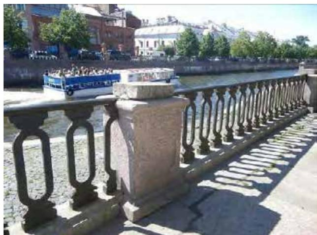
на участке от пересечения с р. Мойкой и до Адмиралтейского канала – вертикальные тумбы простой формы с профилированным плинтом и завершением в виде усеченной трапеции;
