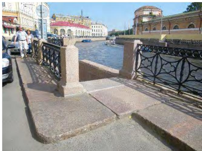
каменный настил и ступени нижней площадки, каменный настил тротуара в обход спуска; тетива лестницы из гранитных блоков, профилированных в верхней части; тетива лестницы скрыта парапетной глухой стенкой набережной из гранитных блоков розового гранита (рапакиви);
