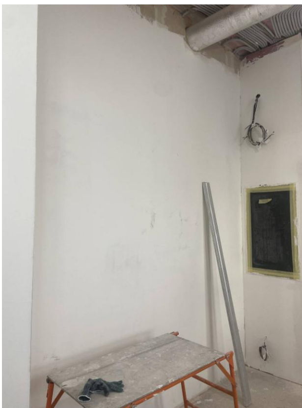
Фото 16. Интерьер квартиры № 87 выявленного объекта культурного наследия «Дом С.Д.Шереметева»
