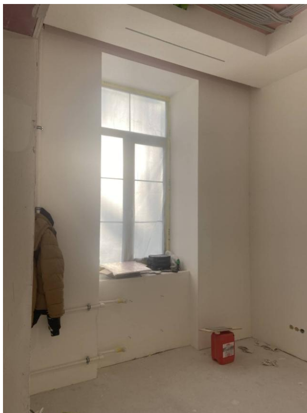
Фото 13. Интерьер квартиры № 87 выявленного объекта культурного наследия «Дом С.Д.Шереметева»
