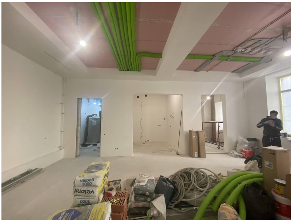
Фото 21. Интерьер квартиры № 87 выявленного объекта культурного наследия «Дом С.Д.Шереметева»
