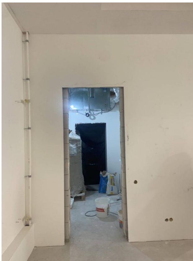
Фото 20. Интерьер квартиры № 87 выявленного объекта культурного наследия «Дом С.Д.Шереметева»
