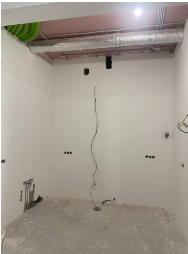
Фото 15. Интерьер квартиры № 87 выявленного объекта культурного наследия «Дом С.Д.Шереметева»
