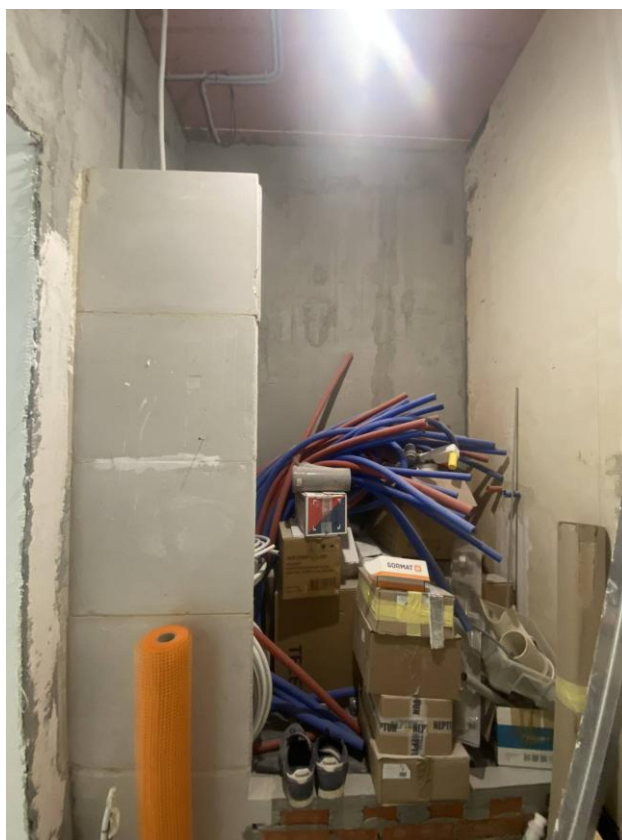
Фото 18. Интерьер квартиры № 87 выявленного объекта культурного наследия «Дом С.Д.Шереметева»
