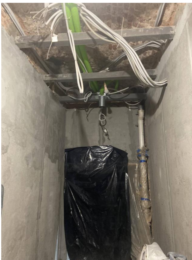
Фото 12. Интерьер квартиры № 87 выявленного объекта культурного наследия «Дом С.Д.Шереметева»
